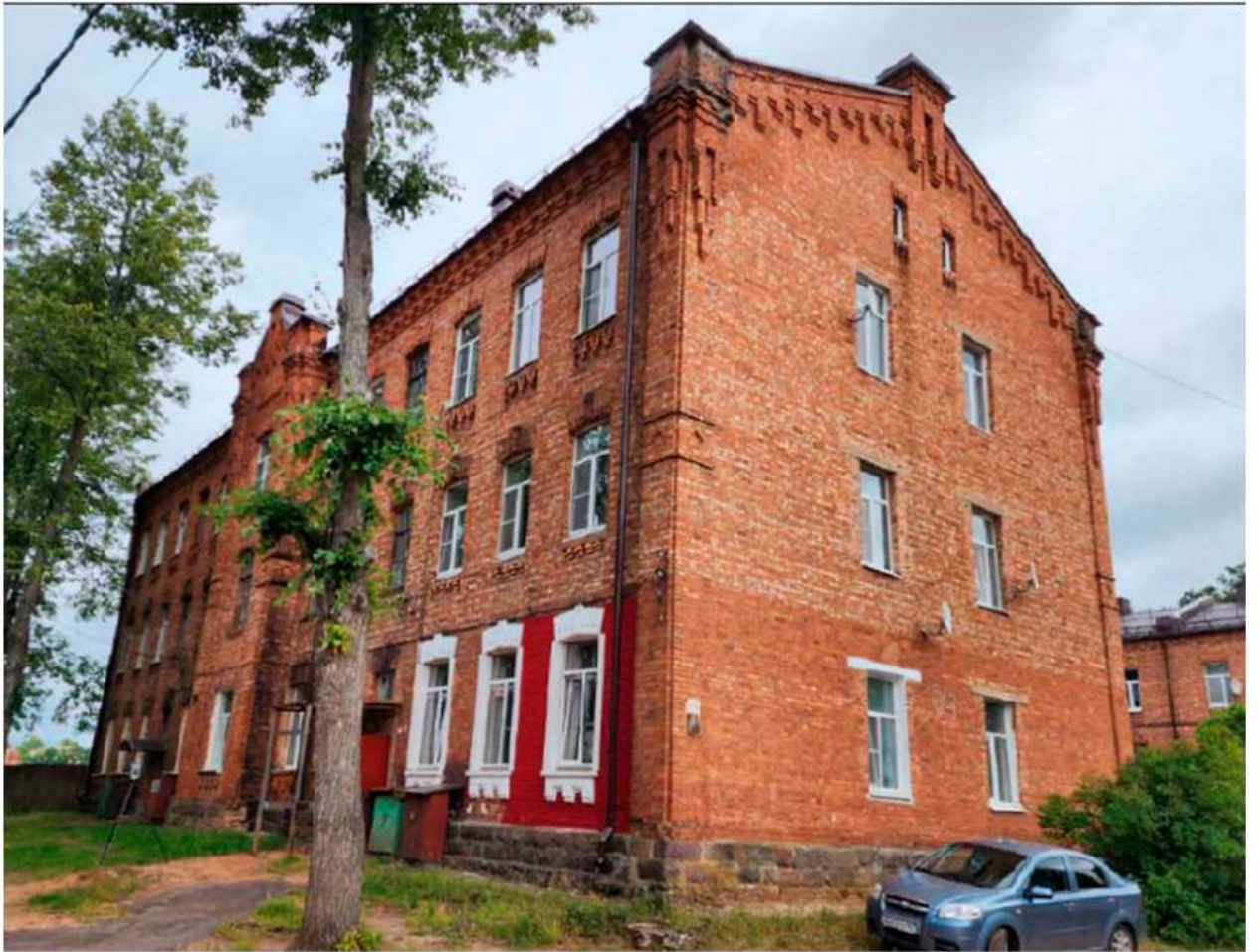
1. Общий вид объекта с юга. Южный торцевой и западный продольный фасады.
