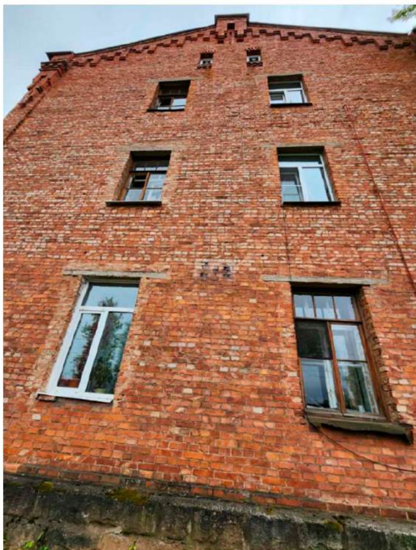
5. Северный торцевой фасад. Общий вид.
