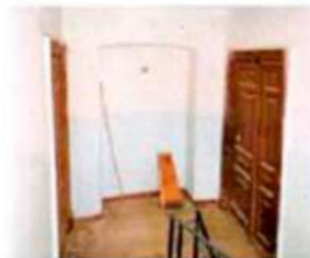
Арочный проем. ЛК-3. 3-ий этаж
