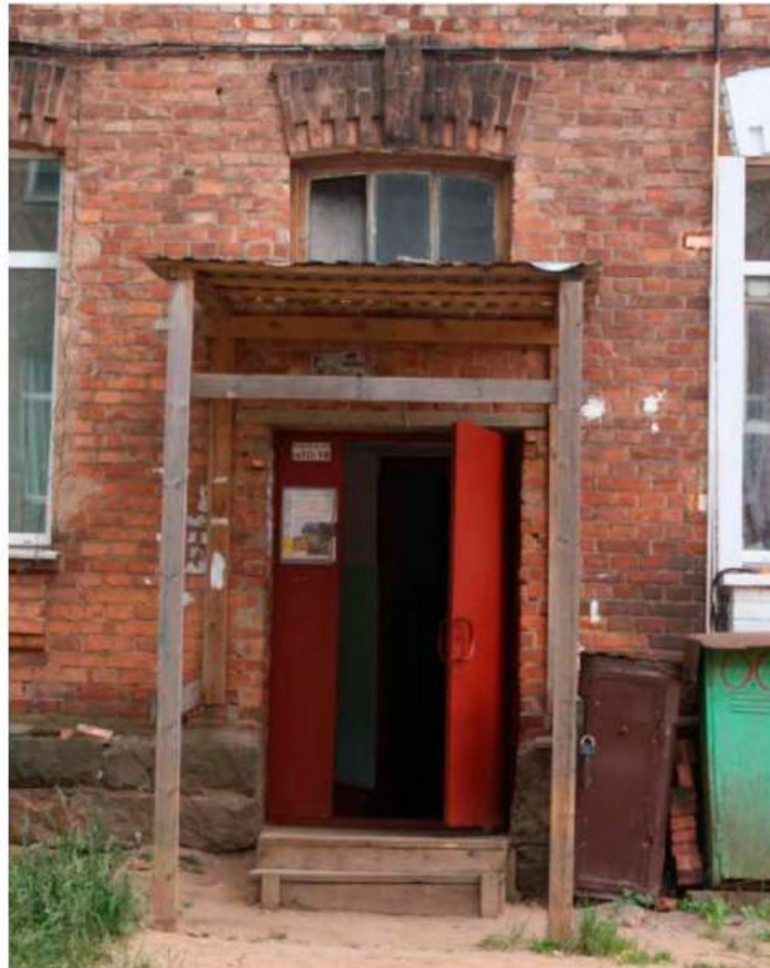
2. Деталь западного продольного фасада. Вид входного проема.
