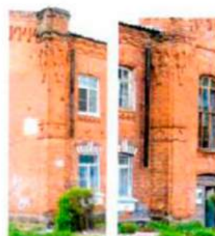
Лопатки, углы фасадов и ризалиты
