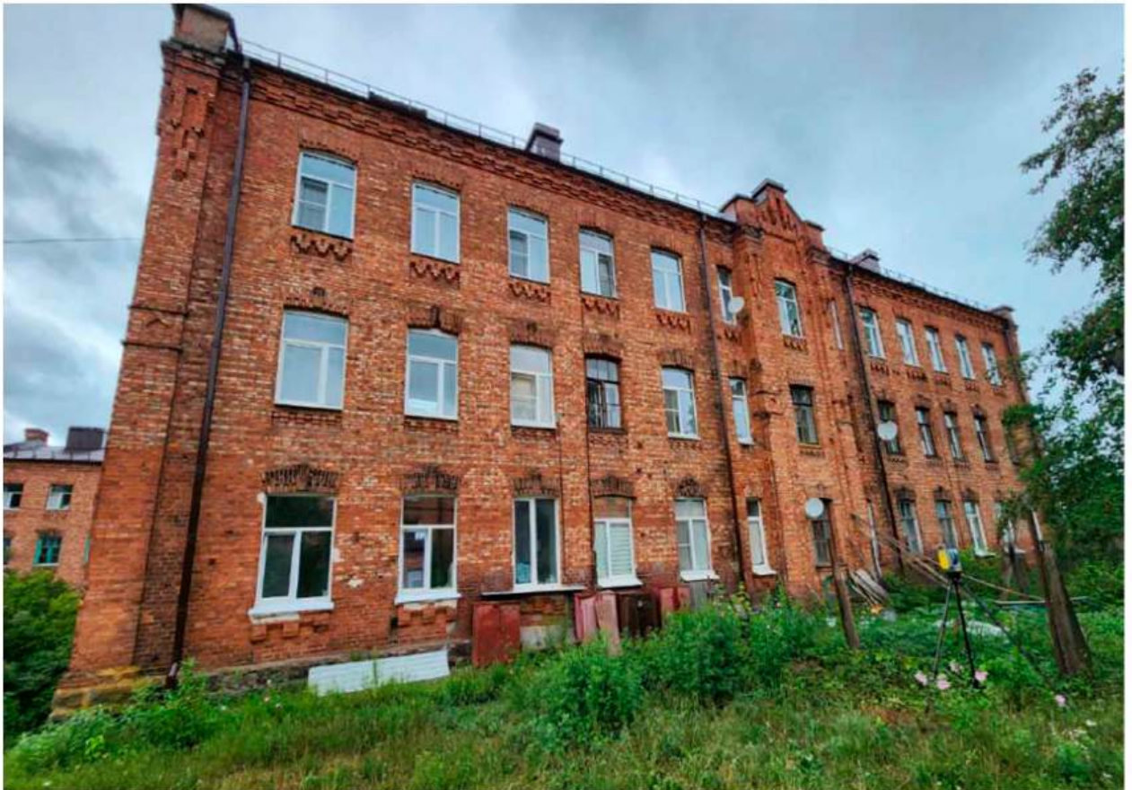
4. Восточный продольный фасад. Общий вид.
