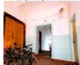
Арочный и дверной проемы. ЛК-2
