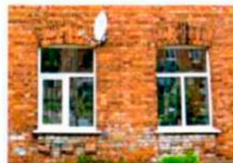
Оформление оконных проемов, 1-ый этаж (квартиры)
