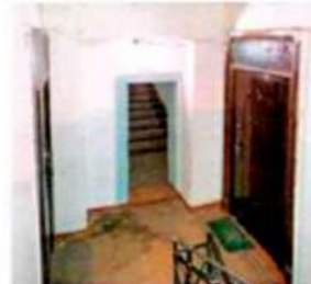
Арочный проем. ЛК-3. 2-ой этаж
