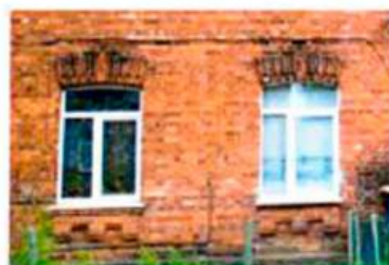
Оформление оконных проемов, 1-ый этаж (квартиры)
