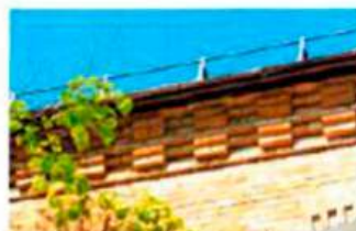
Венчающий карниз (восточный и западный фасады)
