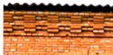
Венчающий карниз (восточный и западный фасады)
