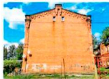
Южный торцевой фасад
