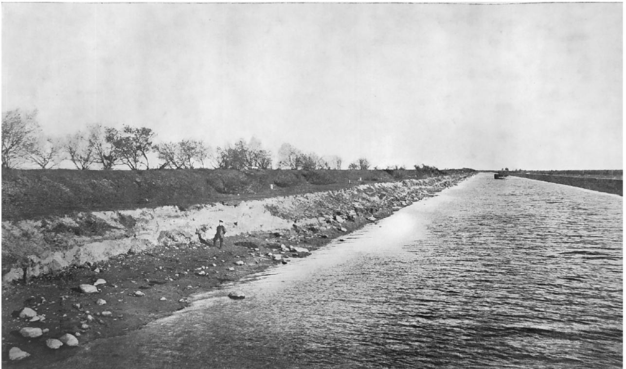
Илл. 50. Разрушение берегов [Новолодожского] канала пароходной волной. (Разрушение не только откоса, но и всей нижней бермы озерной дамбы.) 1908-1911 гг.
