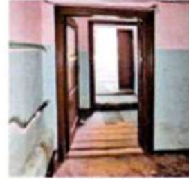
Дверной проем. ЛК-1
