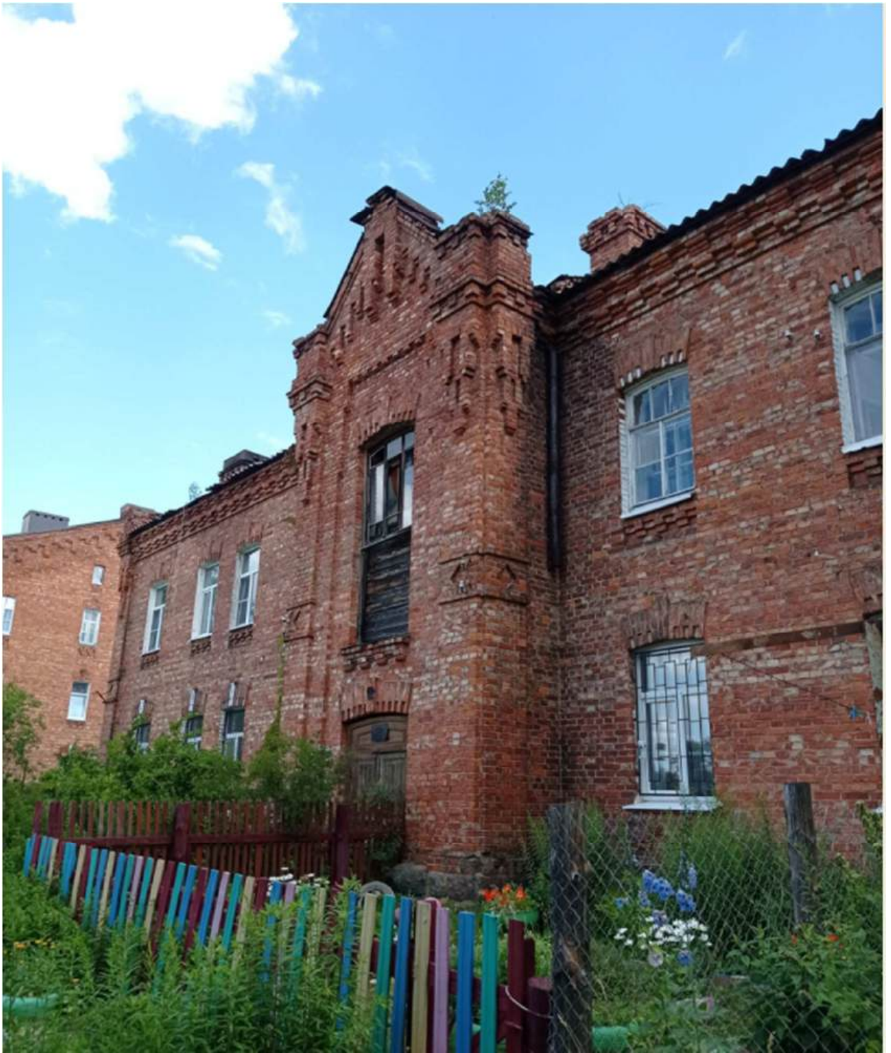
4. Западный фасад. Общий вид.
