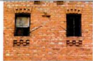
Оформление проемов (торцевые фасады)
