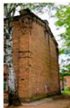
Северный торцевой фасад
