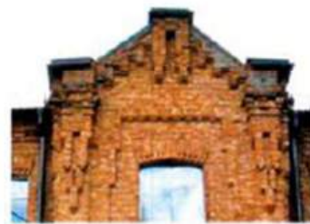
Щипец (ризалит, восточный фасад)
