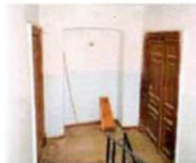
Арочный проем. ЛК-3. 3-ий этаж
