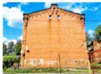
Южный торцевой фасад
