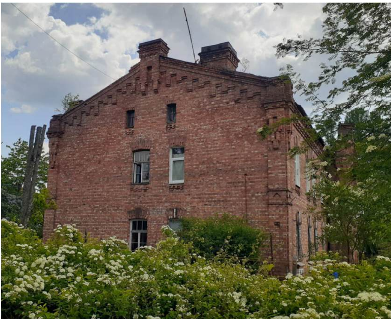
5. Северный торцевой фасад. Общий вид.
