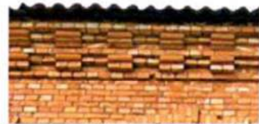
Венчающий карниз (восточный и западный фасады)
