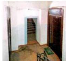
Арочный проем. ЛК-3. 2-ой этаж
