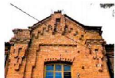
Щипец (ризалит, восточный фасад)
