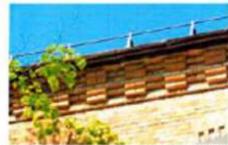
Венчающий карниз (восточный и западный фасады)
