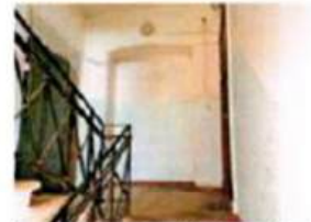
Арочный проем. ЛК-3. 1-ый этаж
