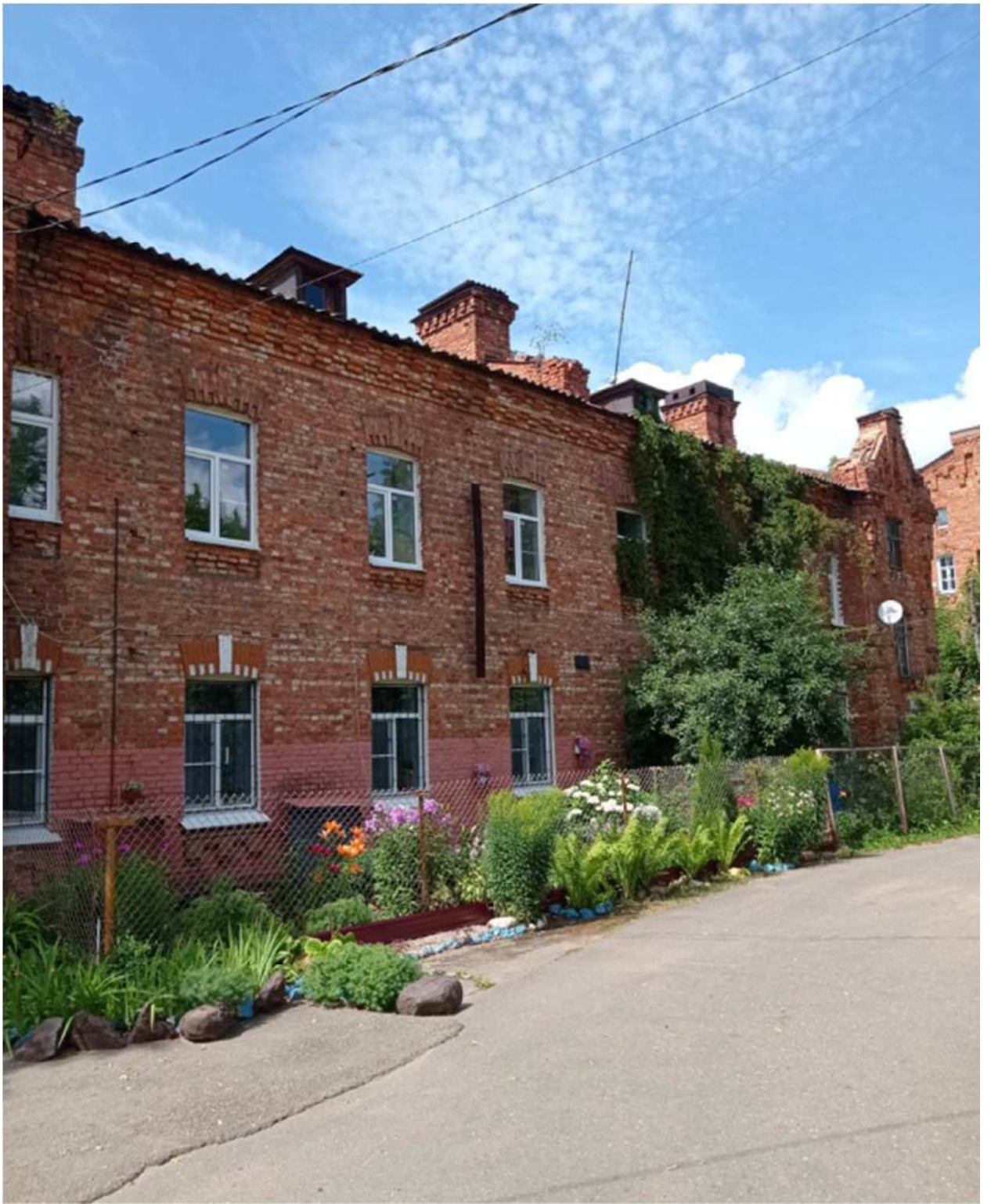
2. Восточный фасад. Общий вид.
