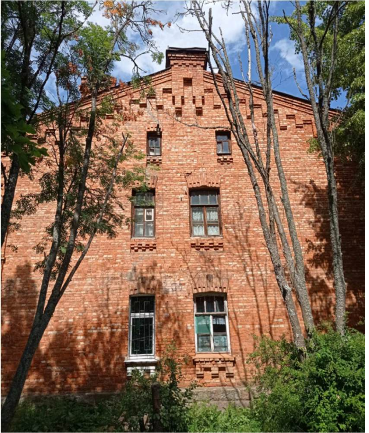
3. Южный торцевой фасад. Общий вид.
