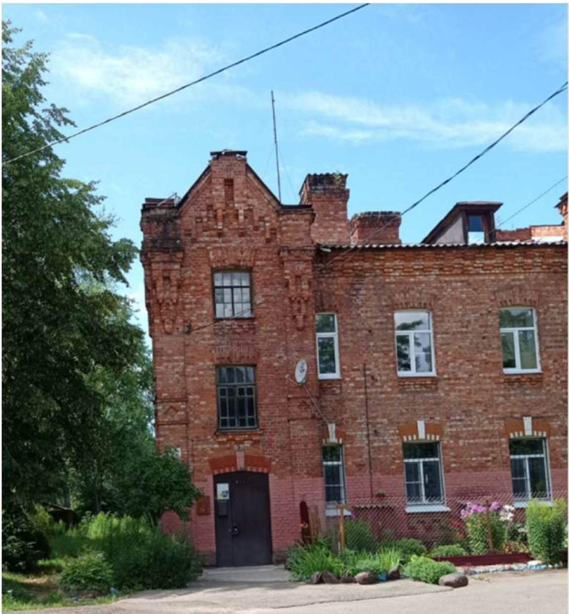
1. Восточный фасад. Фрагмент
