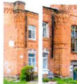
Лопатки, углы фасадов и ризалиты
