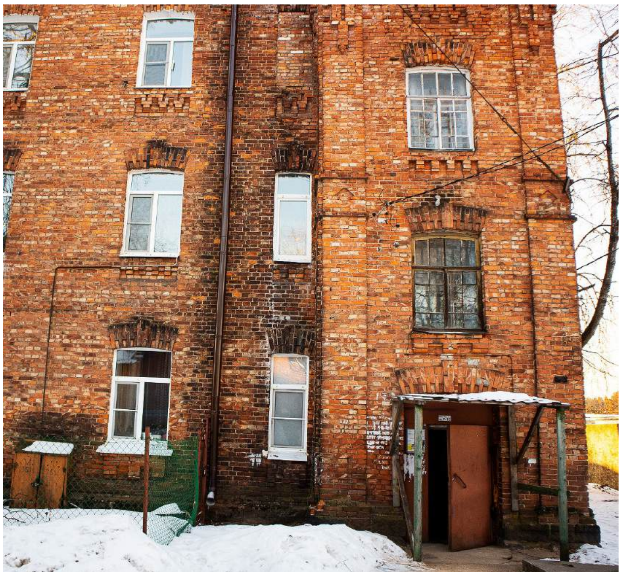
Фото 4. Лицевой фасад. Правый ризалит.
