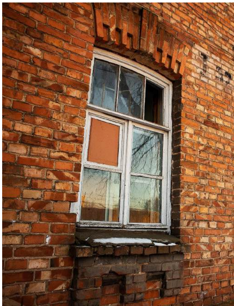
Фото 7. Торцевой фасад. Оконный проем и заполнение в уровне 1 -го этажа.
