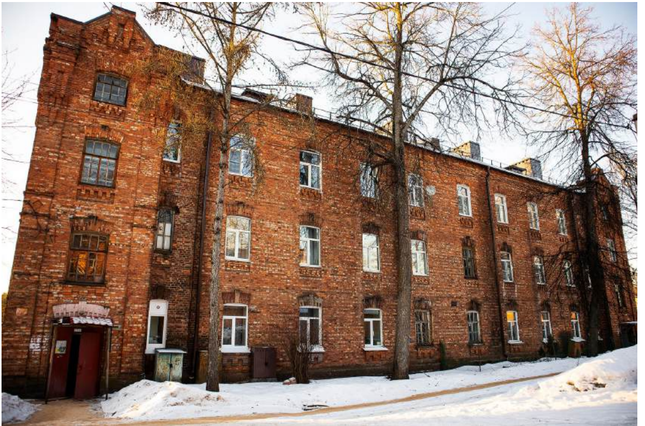
Фото 1. Лицевой фасад со входами в подьезды.
