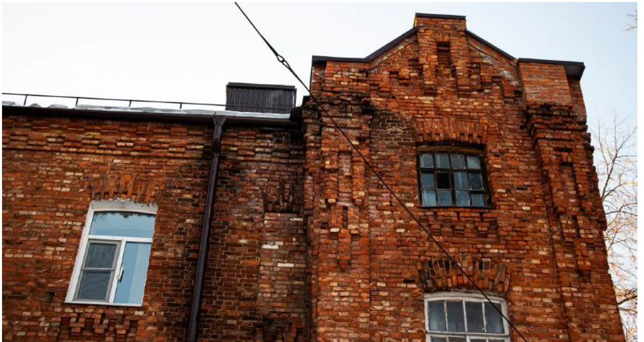
Фото 3. Лицевой фасад. Правый ризалит . Окно 3 -го этажа.
