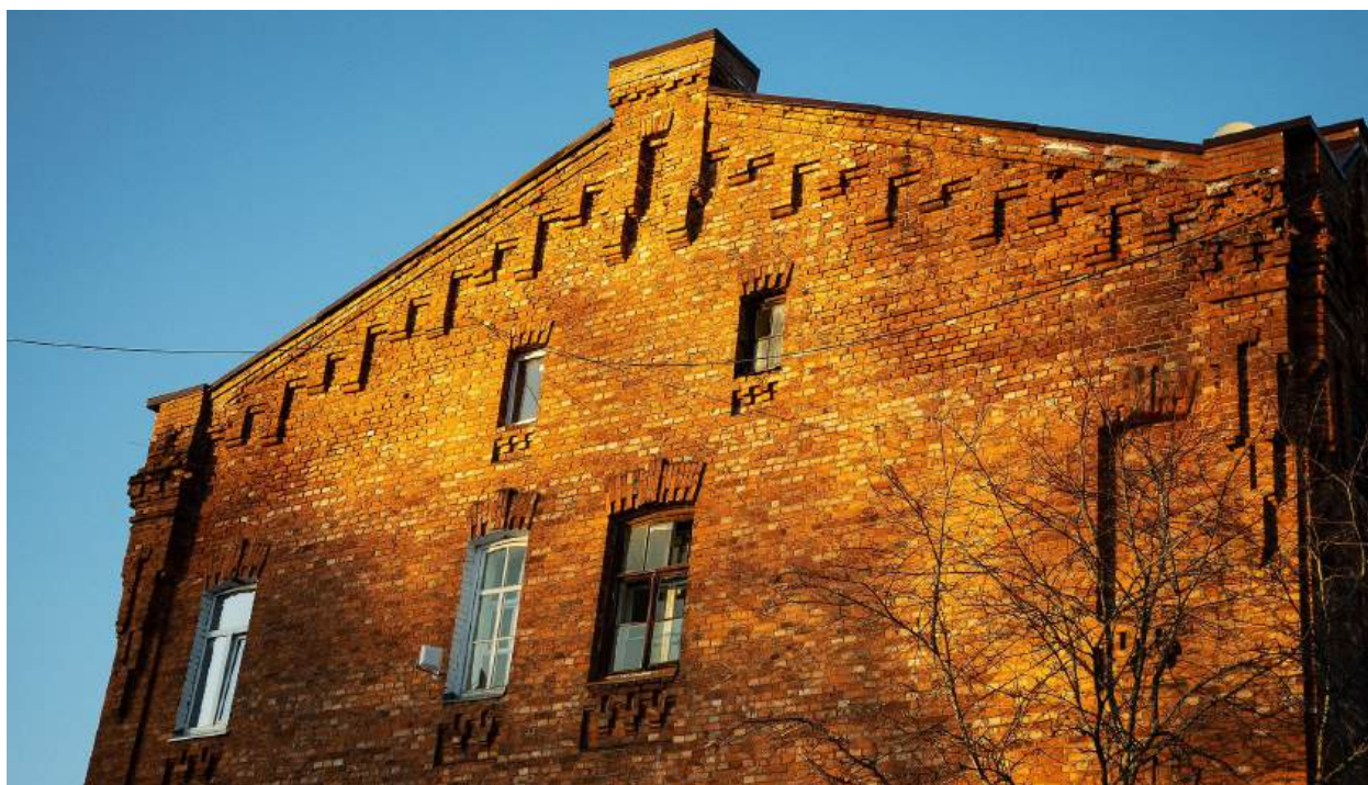
Фото 13. Торцевой фасад. Окна в уровне 3 -го этажа и чердака.
