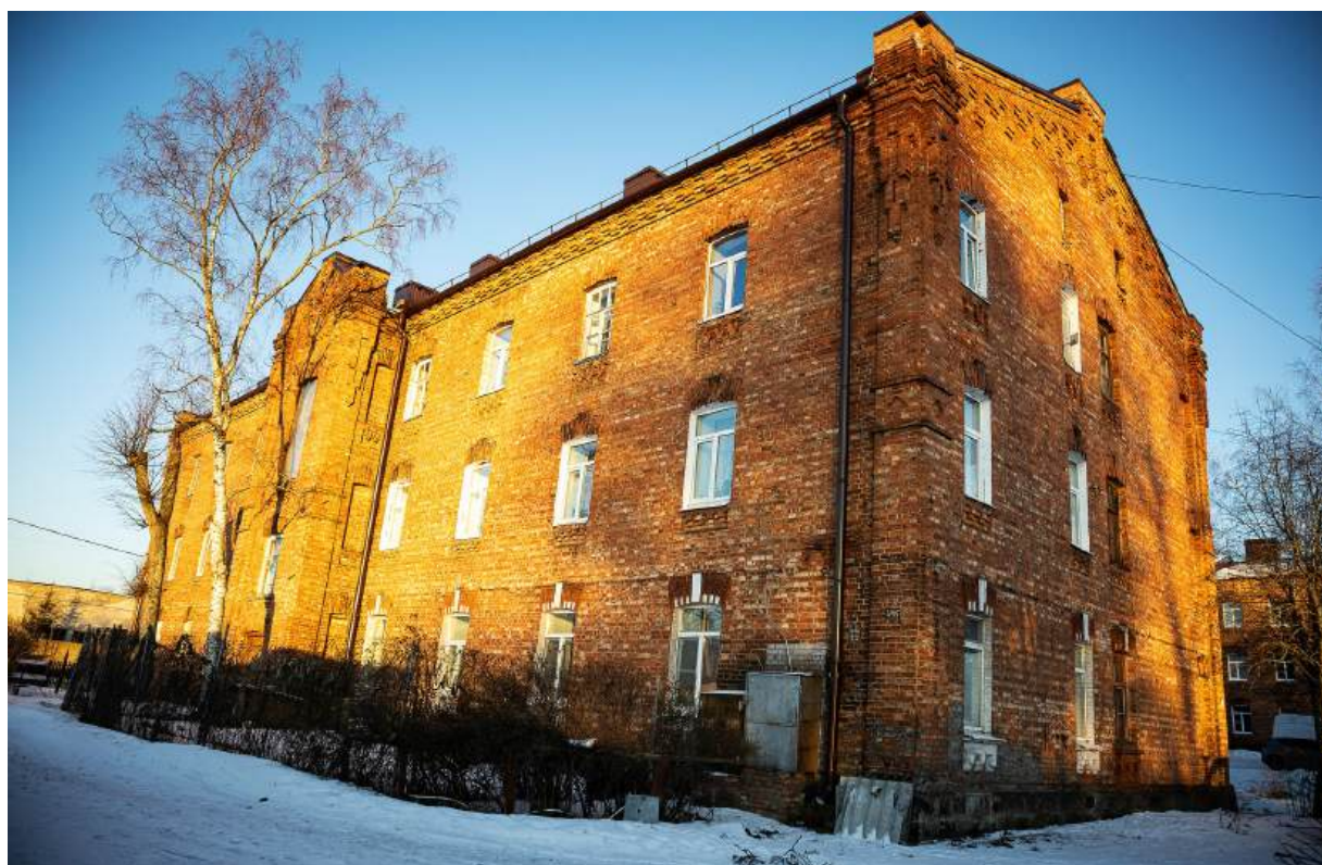
Фото 8. Лицевой фасад. Торцевой фасад.
