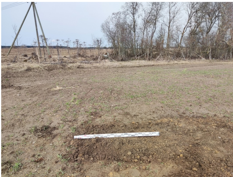
Илл. 23. Ленинградская область, Гатчинский район. 2024 г. «Межпоселковый газопровод до д. Эду – д. Ижора Гатчинского района». Шурф №1. Рекультивация. Вид с Ю.
