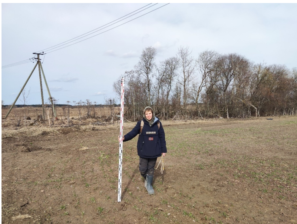
Илл. 18. Ленинградская область, Гатчинский район. 2024 г. «Межпоселковый газопровод до д. Эду – д. Ижора Гатчинского района». Шурф №1. Местоположение. Вид с Ю.
