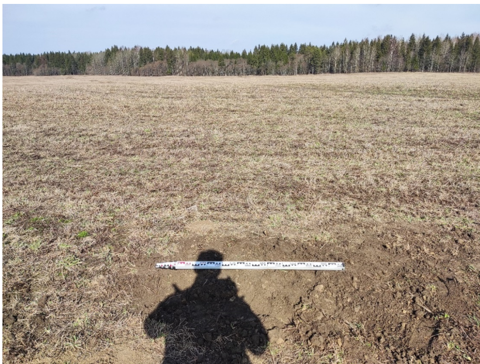
Илл. 77. Ленинградская область, Гатчинский район. 2024 г. «Межпоселковый газопровод до д. Эду – д. Ижора Гатчинского района». Шурф №4. Рекультивация. Вид с Ю.
