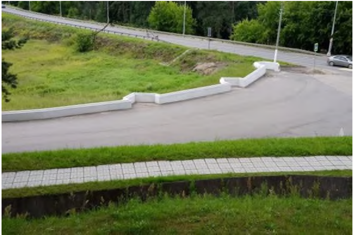
Рис. 28. Ленинградская область. Лужский муниципальный район, Лужское городское поселение, г. Луга, пр. Володарского, соор. 41/1п, 56/2п, 56/1п. "Мемориальный комплекс на рубеже обороны 1941 г." Общий вид на южную границу ОКН со стороны ДОТа. Вид с севера.
