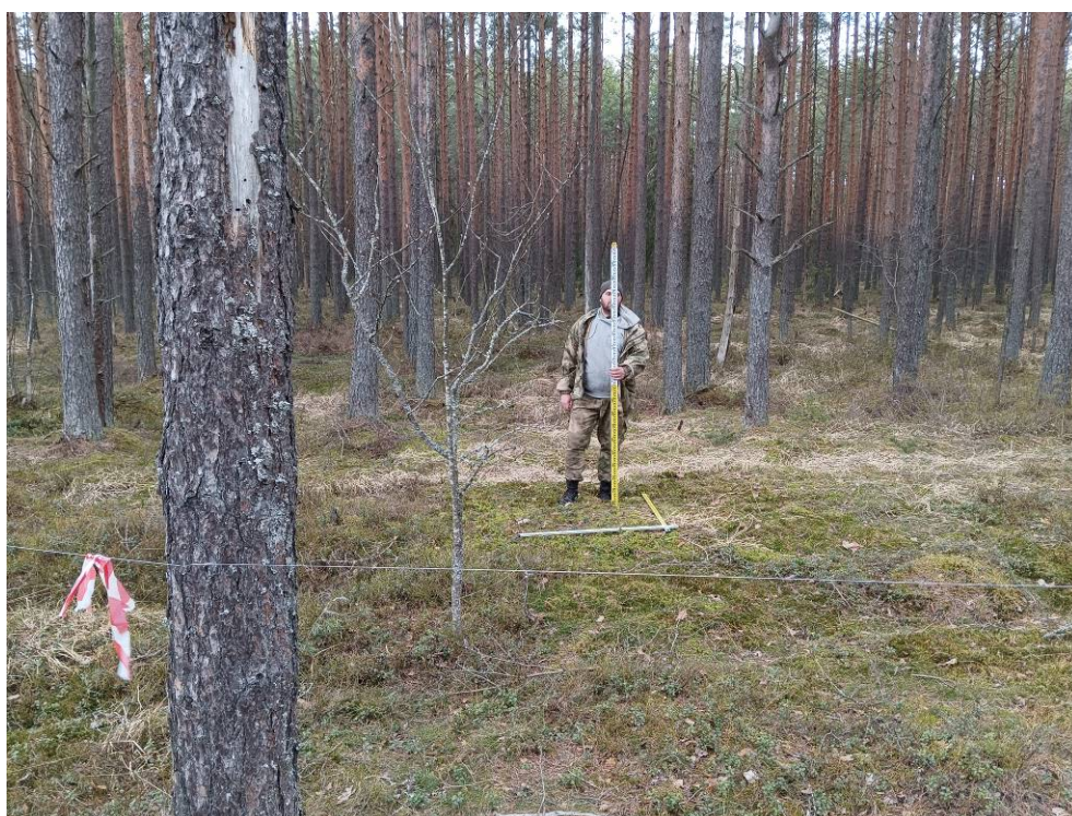
Илл. 14. Ленинградская область, Волховский район. 2024 г. «Межпоселковый газопровод до д. Медвежья Кара Волховского района». Шурф №1. Местоположение относительно оси газопровода. Вид с Ю.
