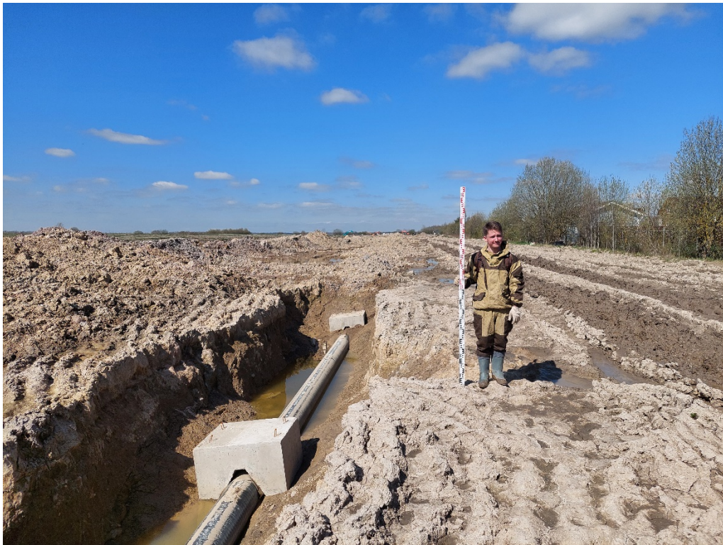
Илл. 43. Ленинградская область, Гатчинский район, Пудомягское сельское поселение – 2024 г. Точка фотофиксации №6. Вид с Ю.
