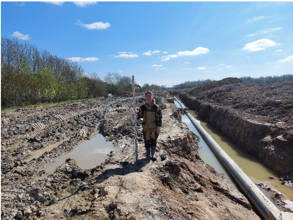
Илл. 42. Ленинградская область, Гатчинский район, Пудомягское сельское поселение – 2024 г. Точка фотофиксации №6. Вид с С.
