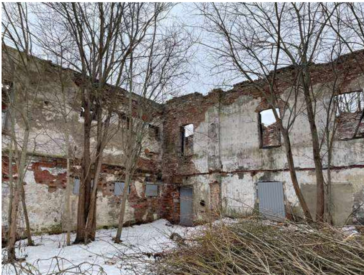
9. Фрагмент дворового фасада
