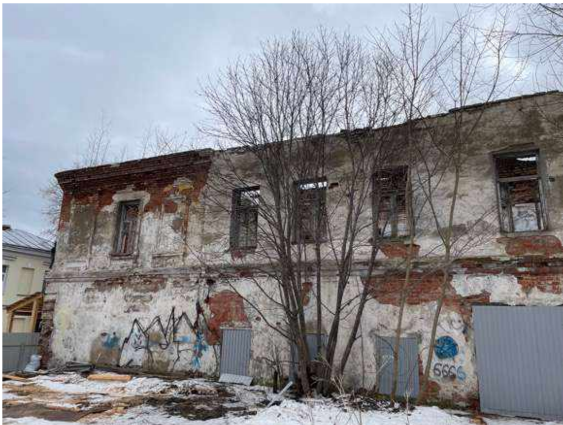
7. Фрагмент дворового фасада
