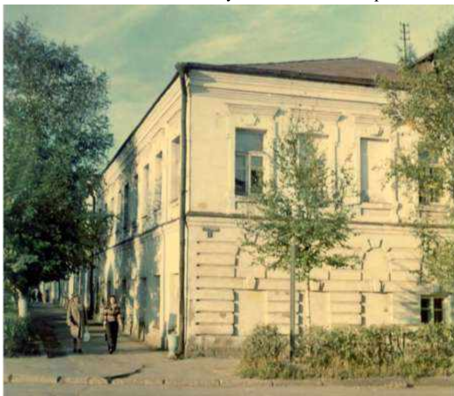
25. Здание по проспекту К.Маркса, 34 в Новой Ладге. 1975 г. Новолодожский филиал Государственного бюджетного учреждения культуры Ленинградской области "Музейное агентство" - Новолодожский историко-краеведческий музей. Номер в Госкаталоге: 10457808. Номер по КП (ГИК): НЛМ КП-316. Инвентарный номер: Ф-128
