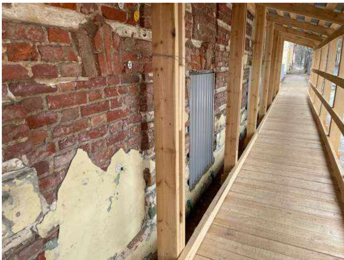
25. Фрагмент фасада первого этажа
