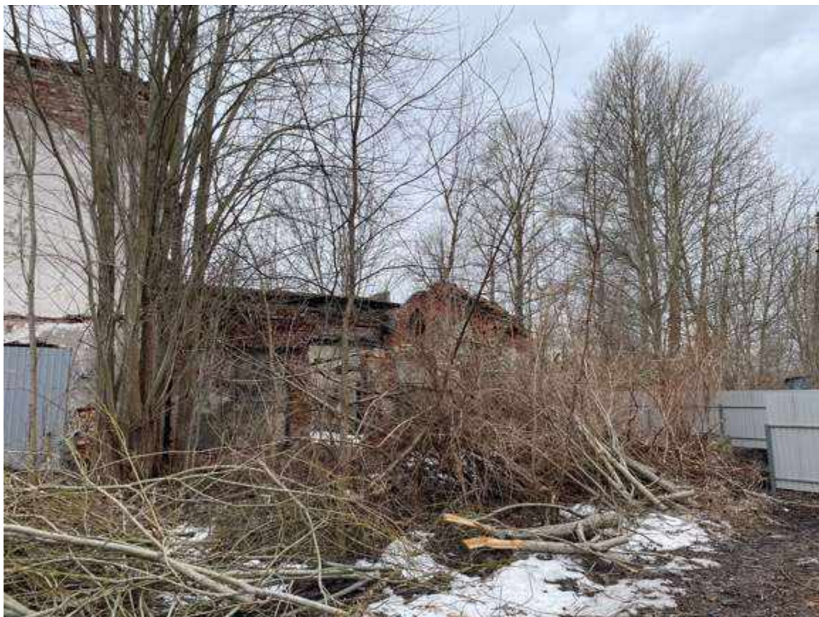
11. Фрагмент дворового фасада
