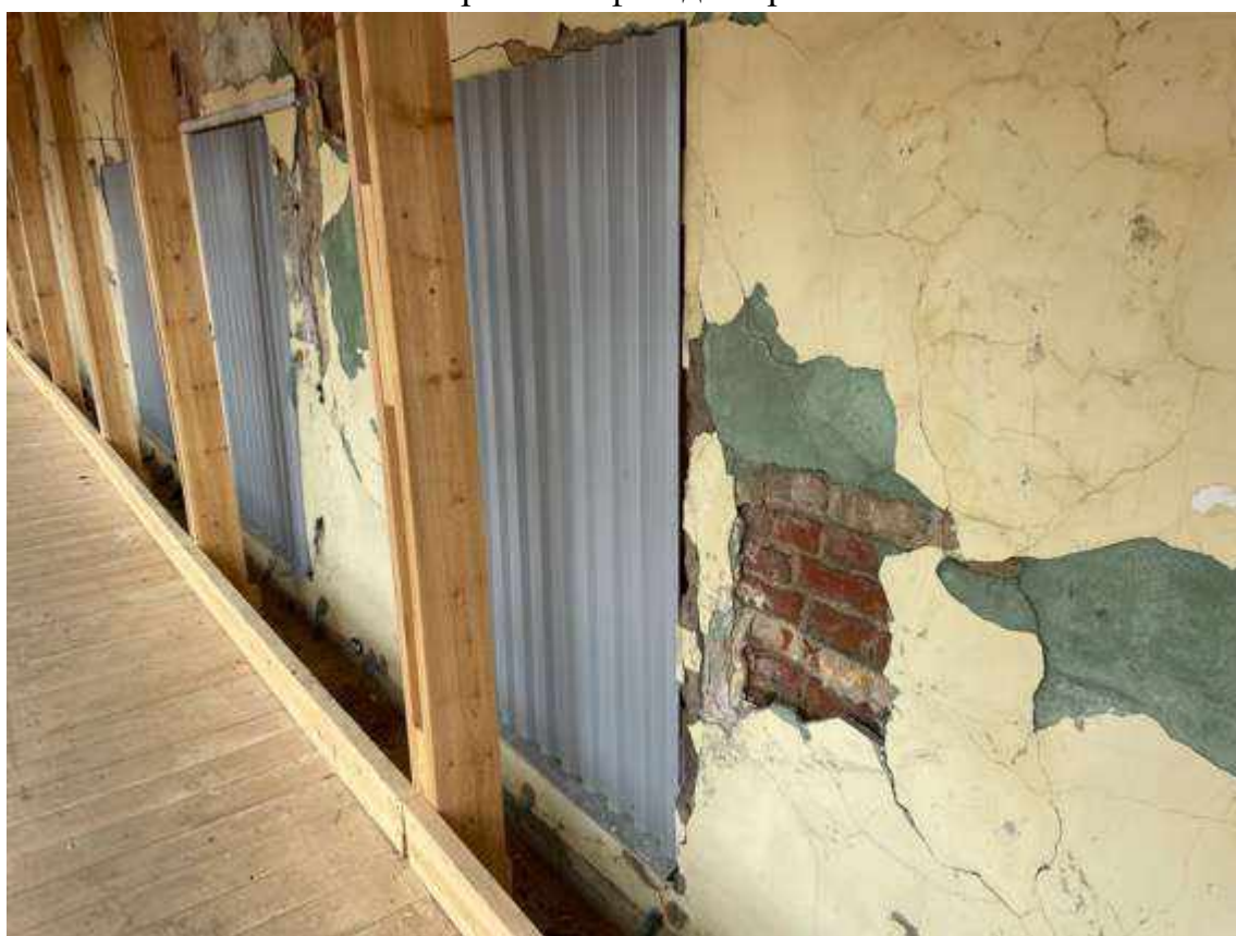
26. Фрагмент фасада первого этажа
