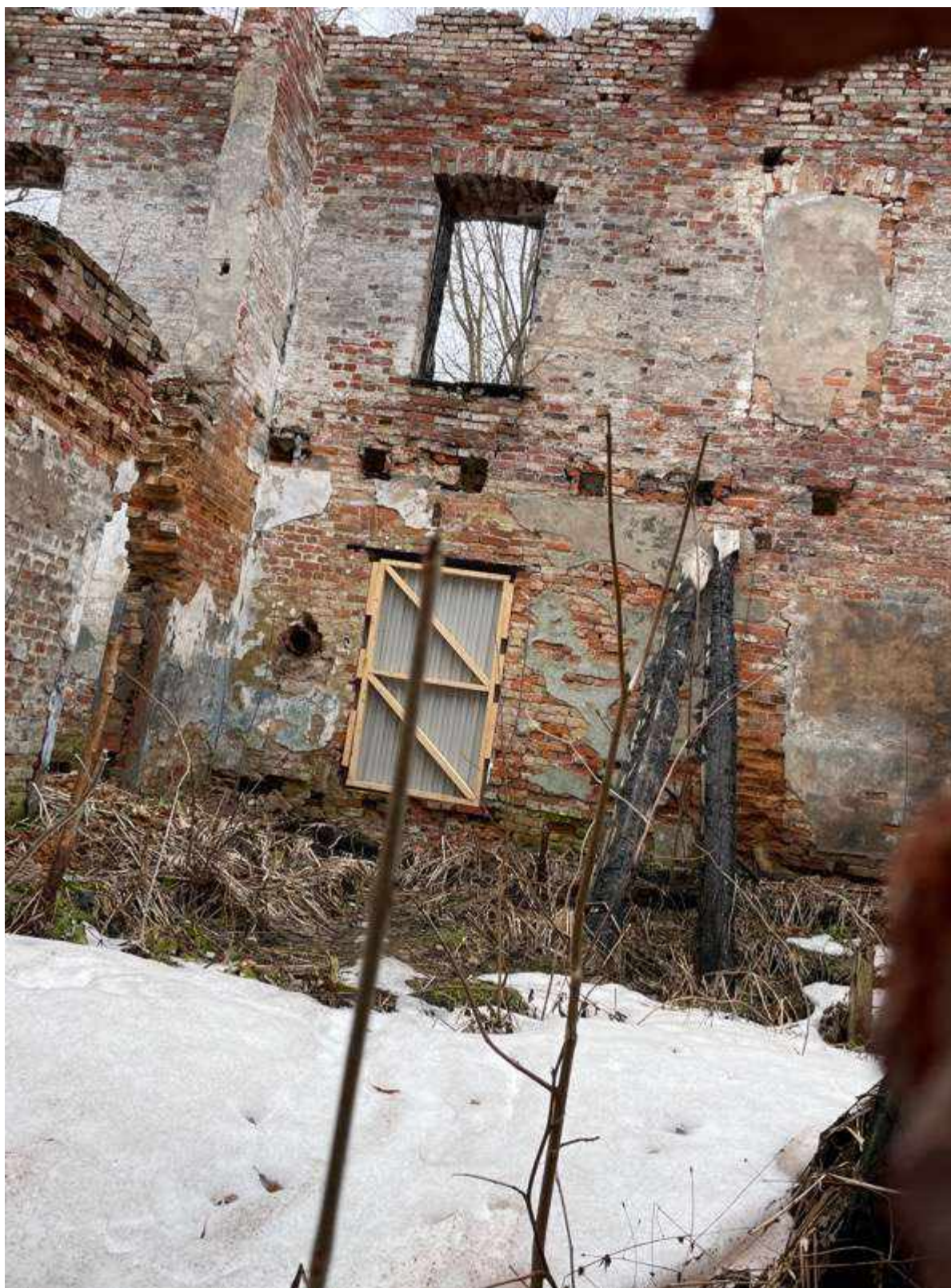
17. Внутренний вид здания
