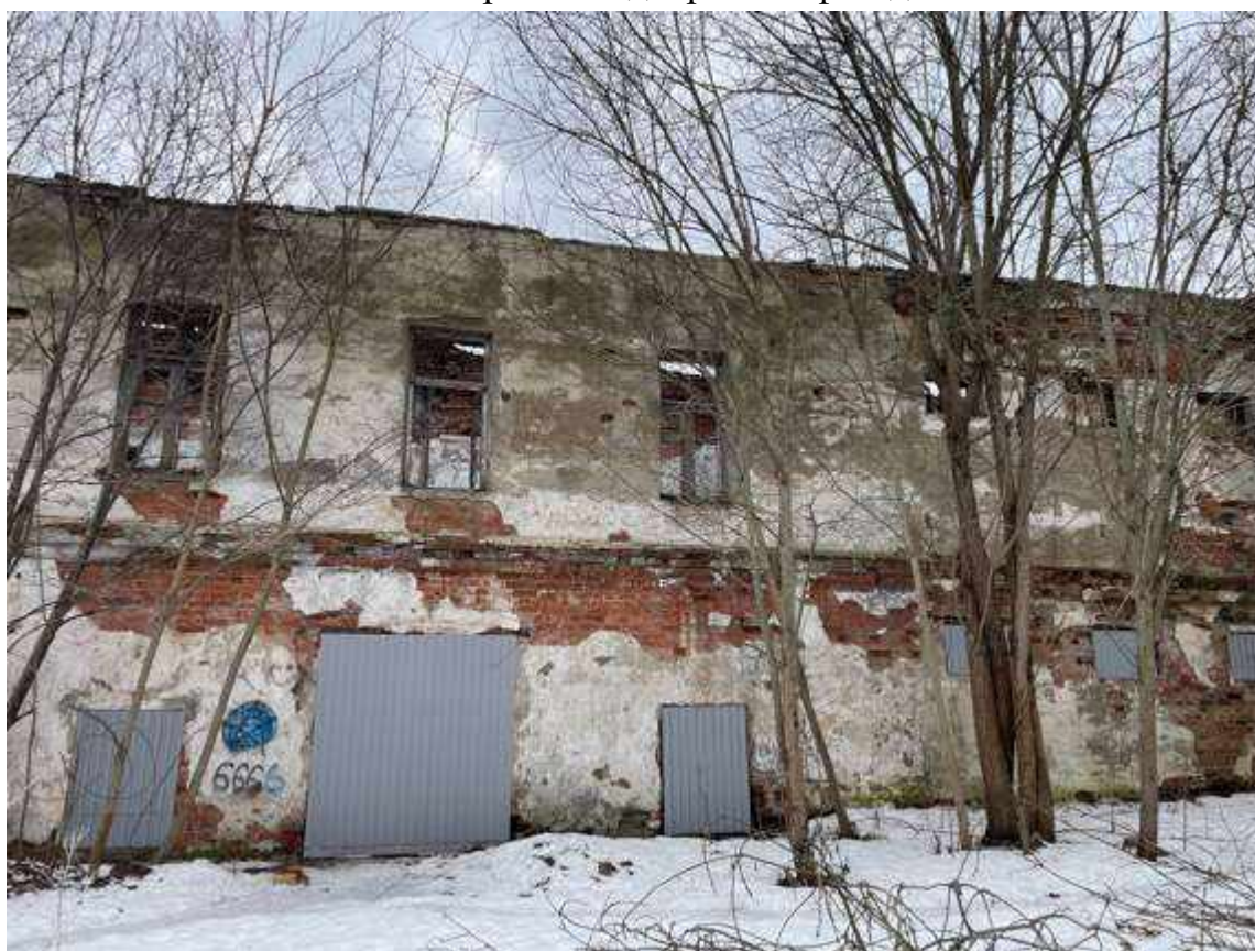
8. Фрагмент дворового фасада
