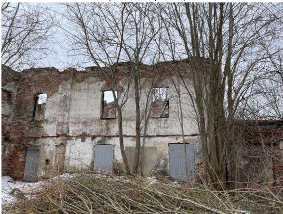
10. Фрагмент дворового фасада
