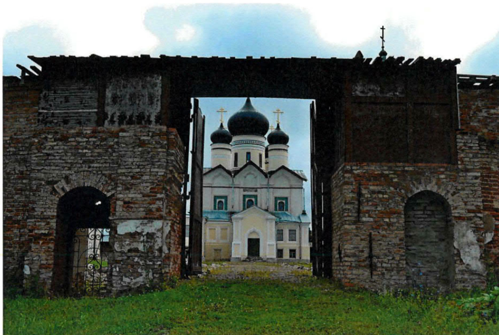
Фото 1. Ленинградская область, Волховский район, пос.Зеленец д.27а. Западные ворота. Общий вид с запада.
