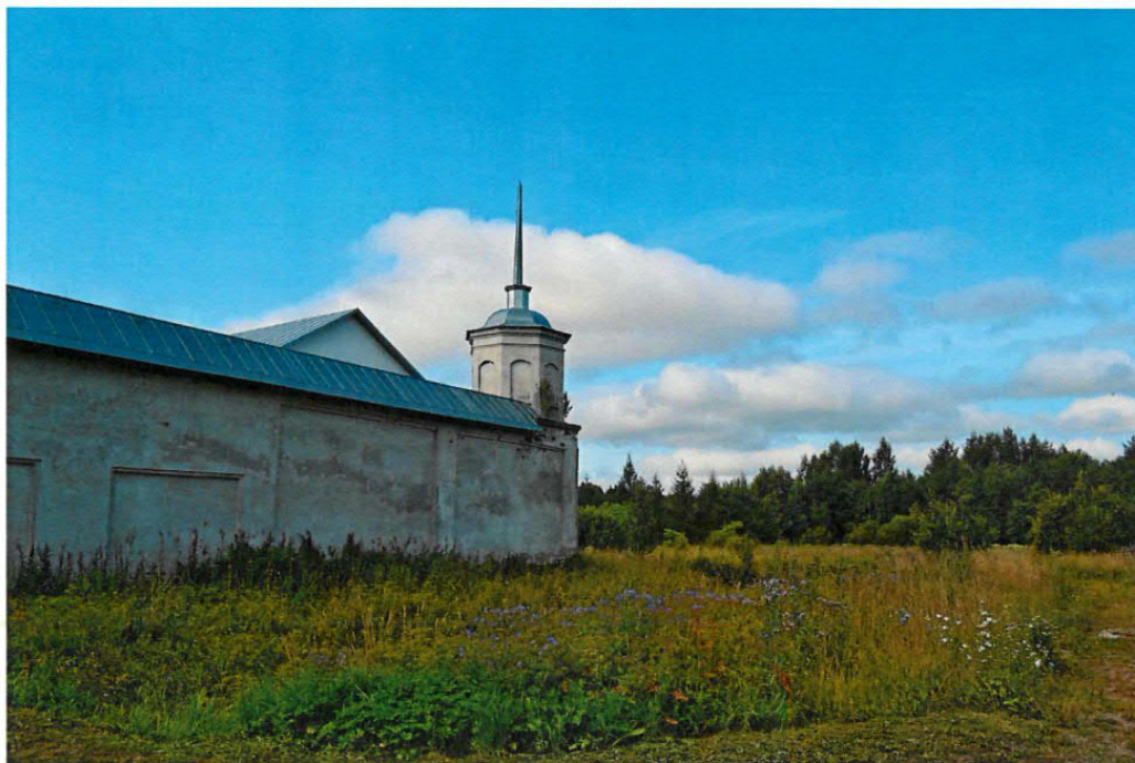
Фото 3. Ленинградская область, Волховский район, пос.Зеленец д.27а. северо-западная башня ограды. Общий вид с северо-востока.
