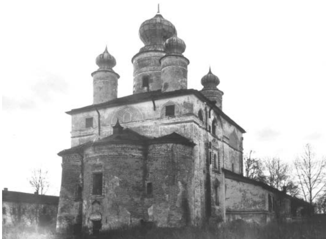
Илл.11. Общий вид Троицкого собора монастыря. Иллюстрация из паспорта объекта культурного наследия 1985 года.
