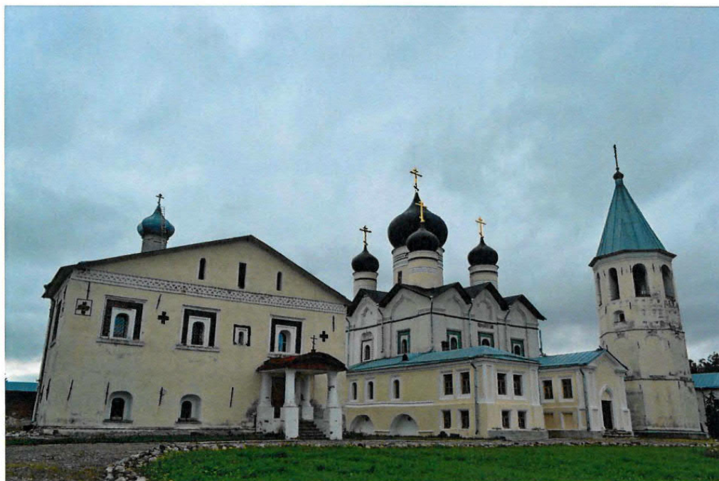
Фото 6. Ленинградская область, Волховский район, пос.Зеленец д.27а. Центральные постройки монастыря – Благовещенская трапезная церковь, Троицкий собор, Колокольня . Общий вид с северо-запада.
