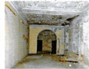
Арочный проем между пом. 2.12 и 2.13
