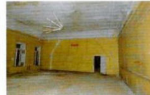
Арочный проем между пом. 2.4 и 2.5 с декором
