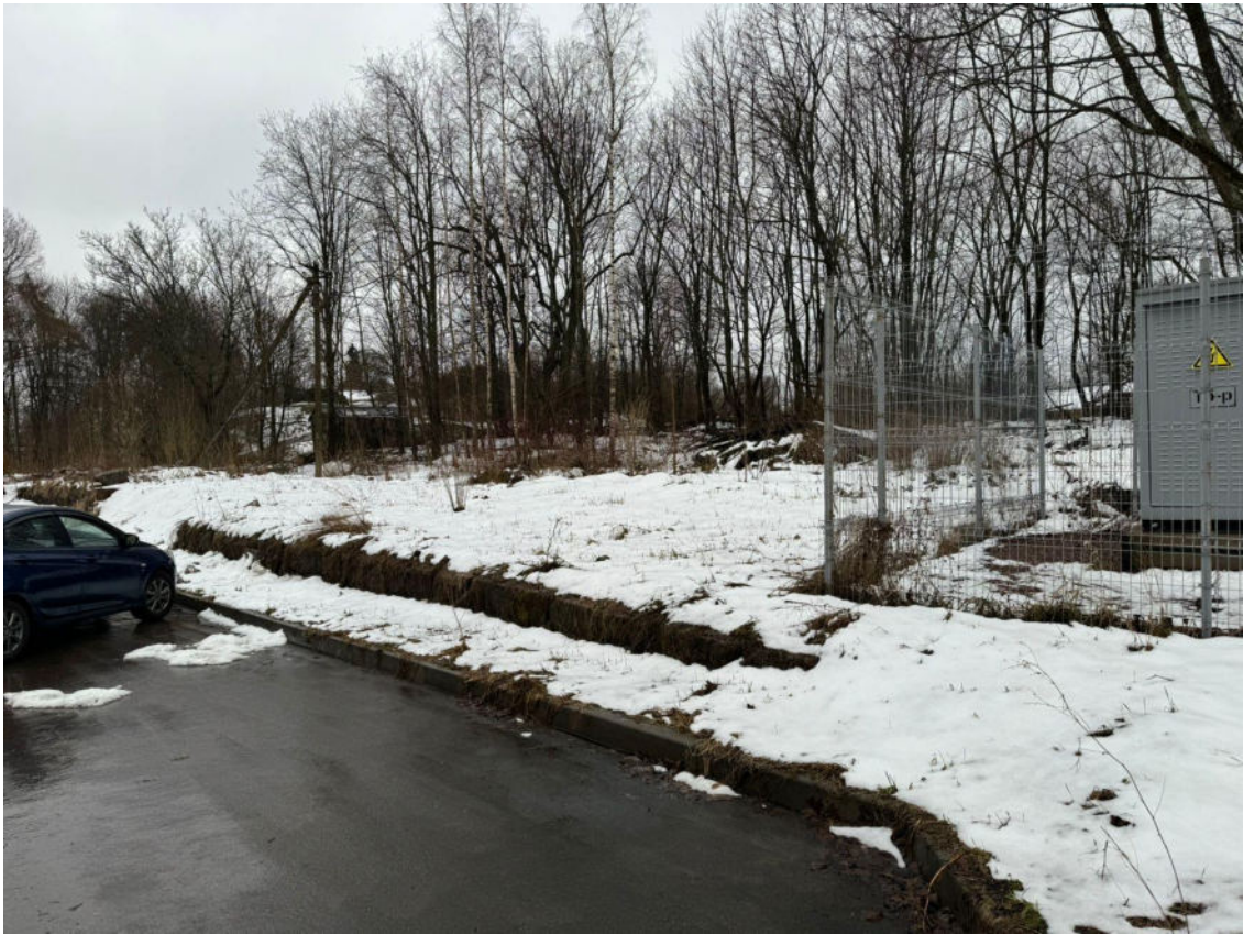
Фото 11. Фрагмент сохранившихся фундаментов дворового строения «Службы», входящего в имущественный состав комплекса "Дома жилые офицерские. Комплекс», 19 в. по данным госоргана охраны ОКН как «Службы», расположенного позади здания по ул. Островной, 6. Фото с севера. Дата съемки: 25.04.2024 г. Автор съемки: Куваева Ю.П.
