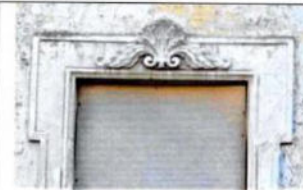
Верхняя часть обрамления проемов 1-го этажа. С-В и Ю-В боковой фасады
