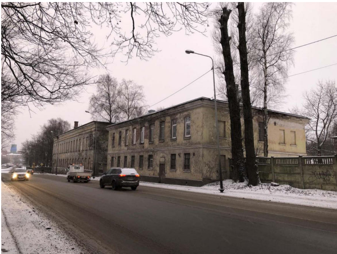
Фото 4. Общий вид зданий по ул. Островной, 2 и 4. Фото с севера. Дата съемки: 25.04.2024 г. Автор съемки: Куваева Ю.П.
