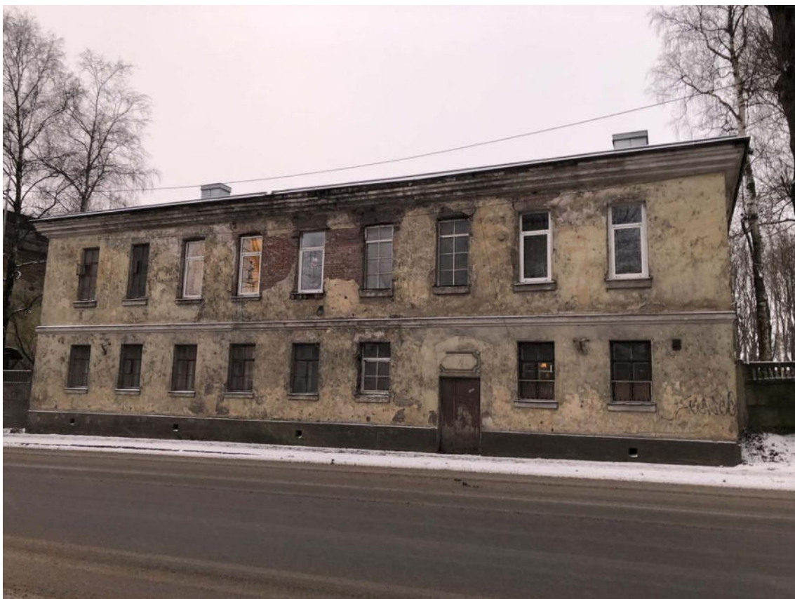
Фото 5. Лицевой фасад исторического здания «Дом жилой обер-офицерский», 1808 г., по ул. Островной, 4, входящего в имущественный состав исторического комплекса «Дома жилые офицерские. Комплекс», 19 в. Фото с северо-востока. Дата съемки: 25.04.2024 г. Автор съемки: Куваева Ю.П.
