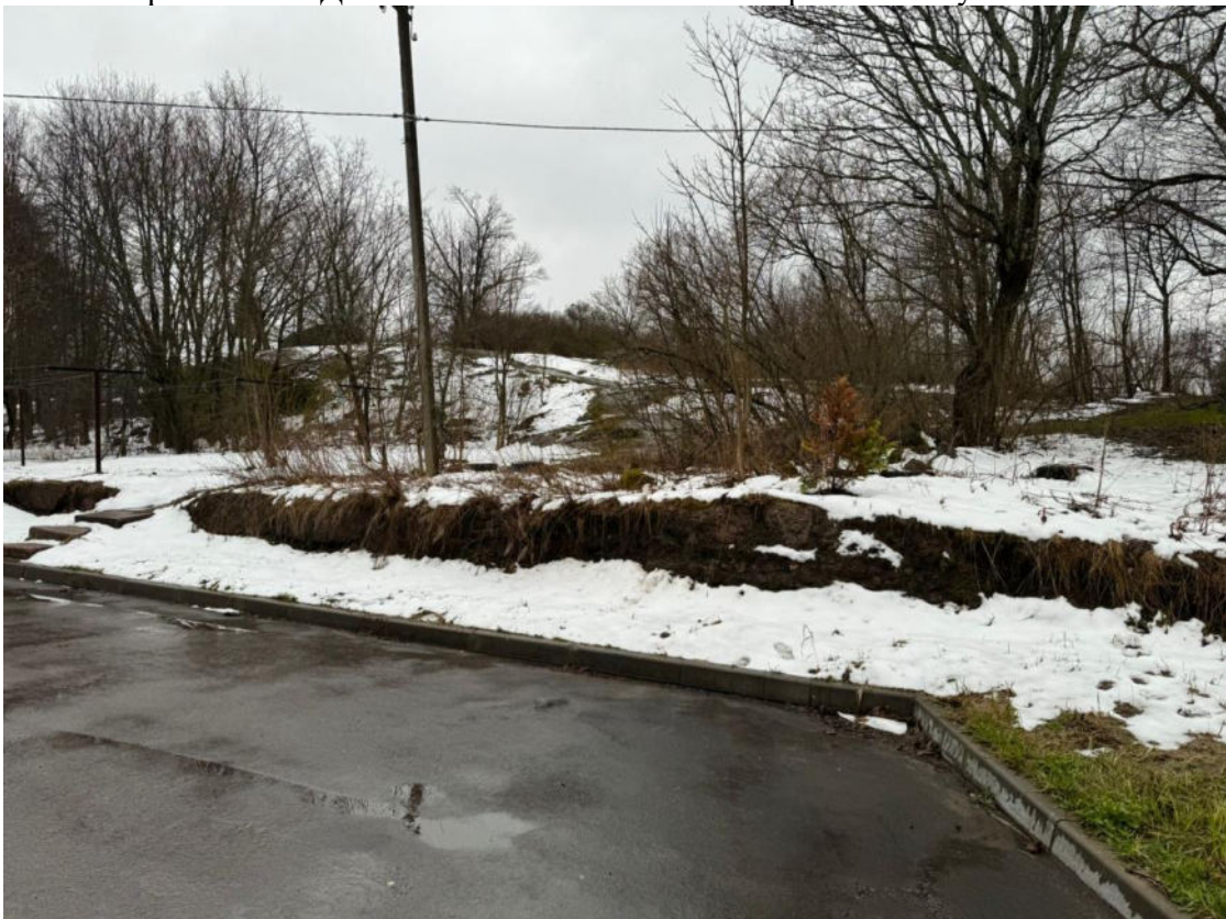
Фото 9. Фрагмент сохранившихся фундаментов дворового строения «Ледник», входящего в имущественный состав комплекса "Дома жилые офицерские. Комплекс", 19 в. по данным госоргана охраны ОКН как «Службы», расположенного позади здания по ул. Островной, 4. Фото с северо-востока. Дата съемки: 25.04.2024 г. Автор съемки: Куваева Ю.П.
