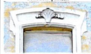
Сандрики проемов 2-го этажа (С-В и Ю-В боковой фасады)
