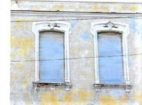
Обрамление оконных проемов 2-го этажа. С-В лицевой и Ю-В боковой фасады
