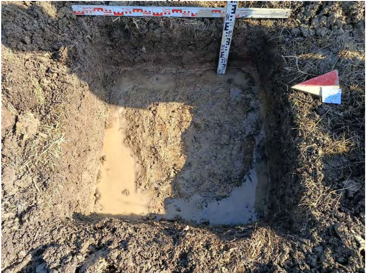
Рис. 404. ЛО-2023. Кудрово, Новосергиевка. КН: 47:07:1044001:243; 25851; 28050; 63950; 74931; 74952. Шурф 44, фиксация по уровню окончания работ, вид на восток.
