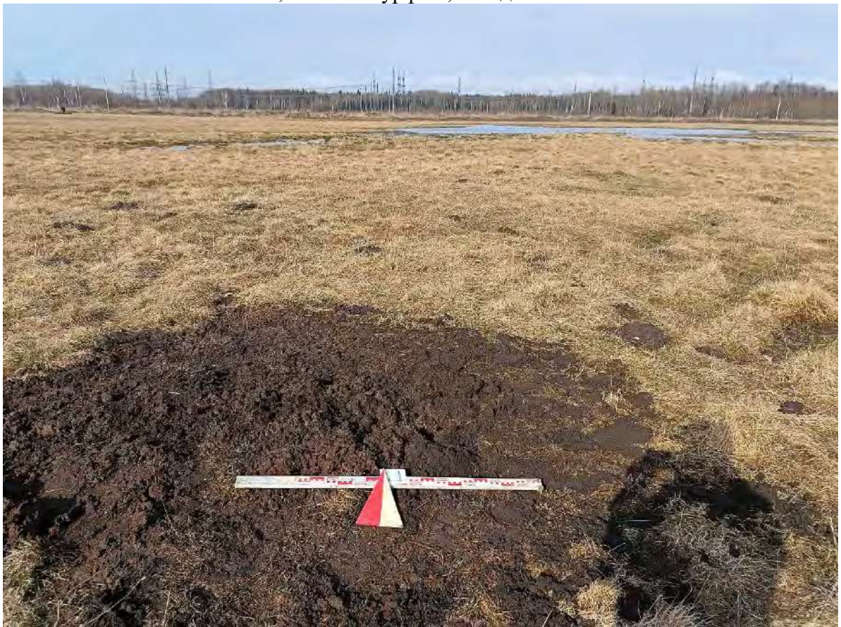
Рис. 226. ЛО-2023. Кудрово, Новосергиевка. КН: 47:07:1044001:243; 25851; 28050; 63950; 74931; 74952. Шурф 21 после рекультивации, вид на север.
