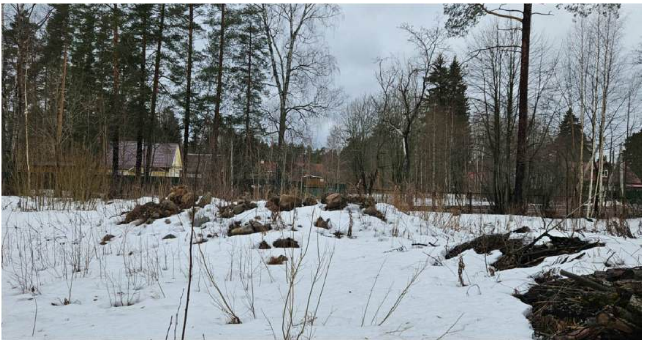
4. Западная часть территории участка. Местоположение выявленного объекта культурного наследия «Дача купца Бумагина». Фрагменты фундамента.
