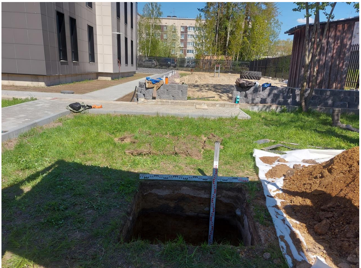
Рис. 27. Шурф №1. Северная стенка. Контрольное прокапывание материка. Общий вид.
