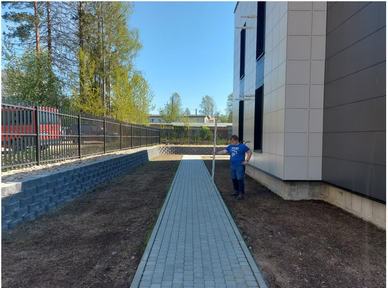
Рис. 17. Точка фотофиксации территории проектирования №4. Вид на восток.
