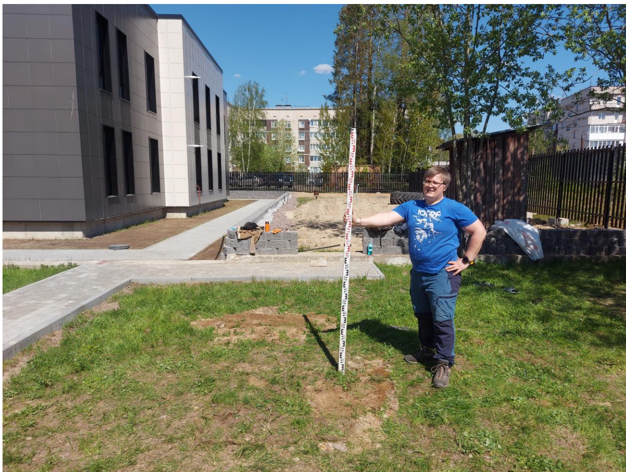
Рис. 28. Шурф №1. Рекультивация шурфа. Вид на север.
