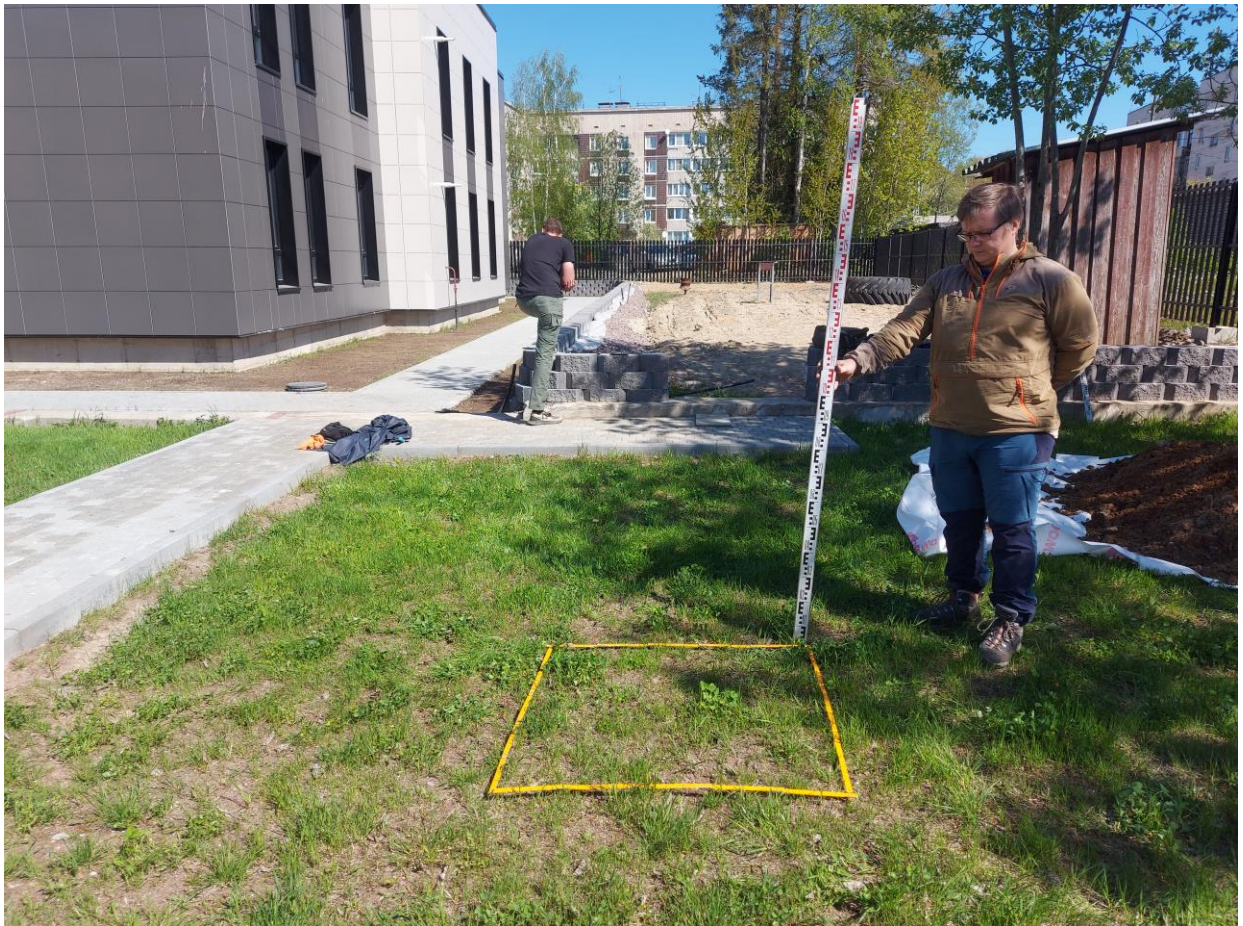
Рис. 24. Шурф №1. Место закладки шурфа до начала работ. Вид на север.
