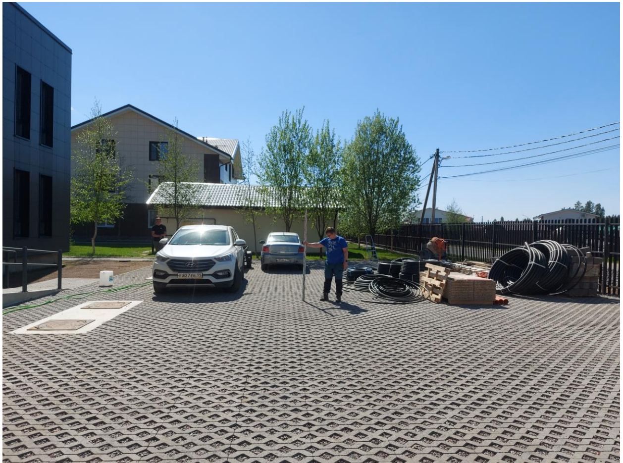
Рис. 19. Точка фотофиксации территории проектирования №6. Вид на юг.
