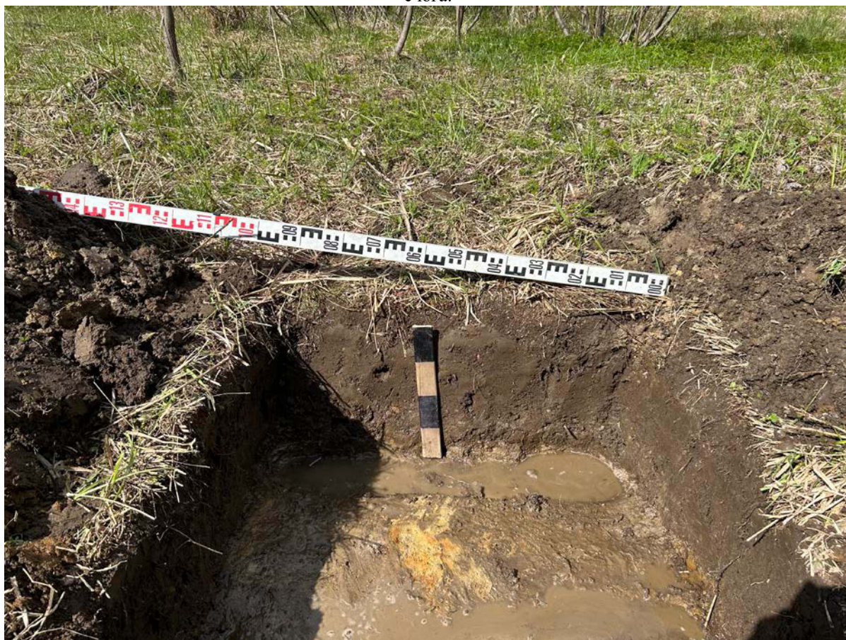
Рис. 120. Земельный участок с кадастровым номером 47:07:0957004:6270. Северная стенка шурфа № 14 после прокопки, вид с юга.
