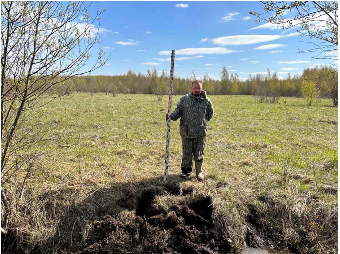
Рис. 135. Земельный участок с кадастровым номером 47:07:0957004:6262. Зачистка № 17 после рекультивации, вид с юга.
