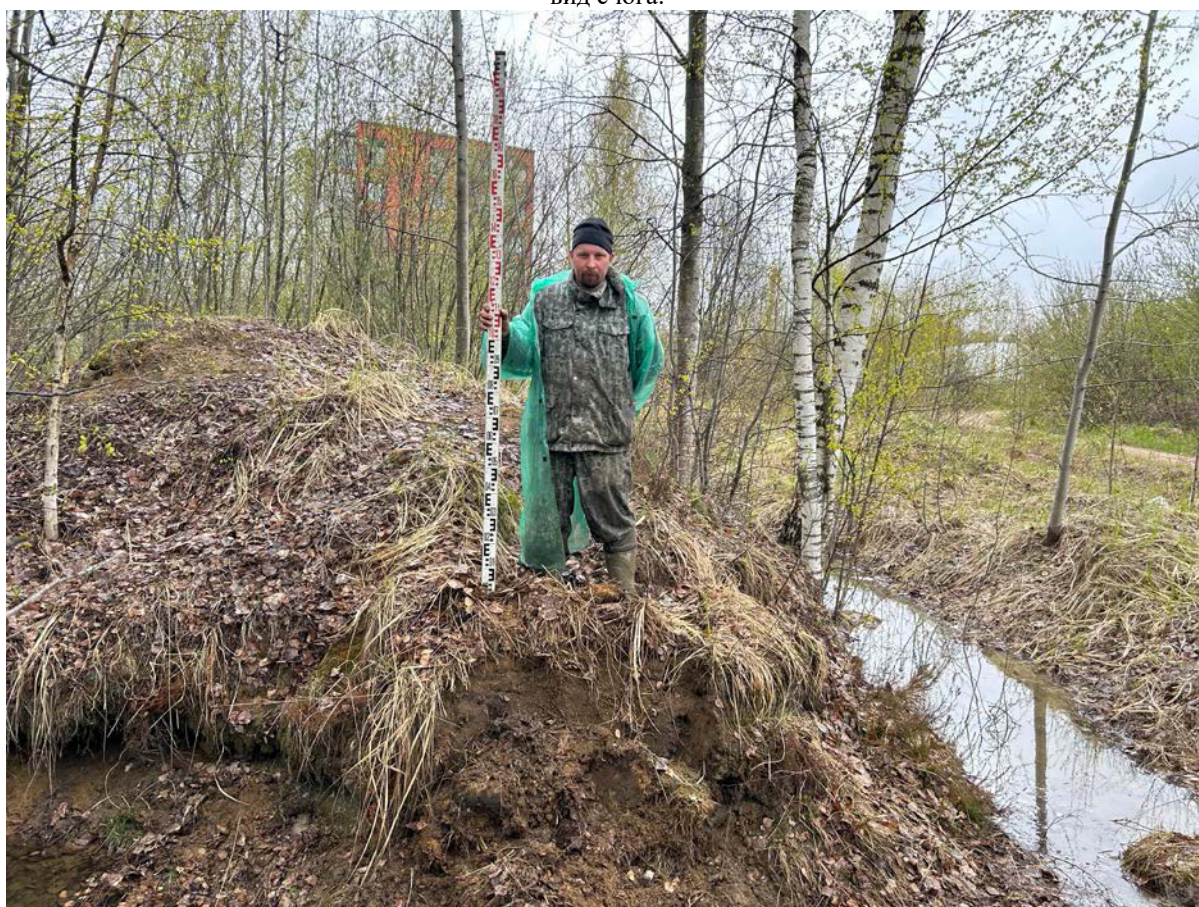
Рис. 216. Земельный участок с кадастровым номером 47:07:0957004:6268. Зачистка № 35 после рекультивации, вид с юга.
