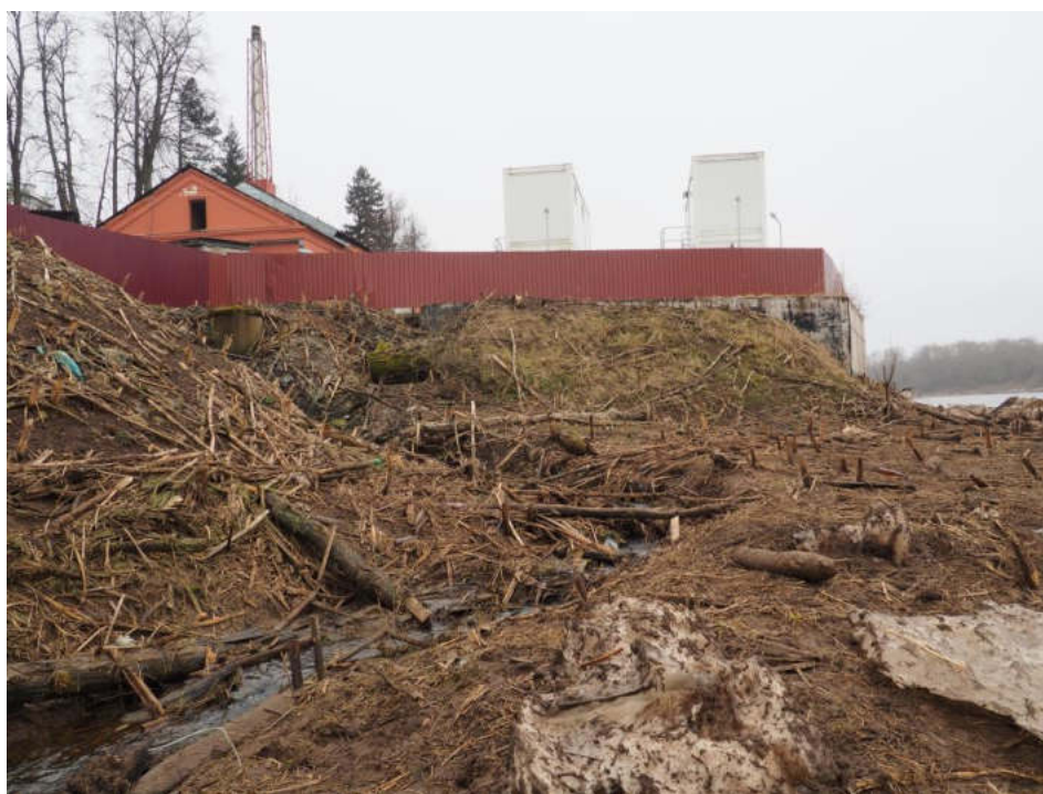
Илл. 43. Точка фотофиксации 20. Общий вид на зону ЗОЛ северо-восточнее существующих очистных сооружений. Вид с северо-востока. 06.05.2024 г.
