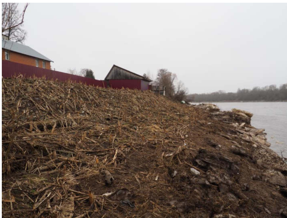
Илл. 35. Точка фотофиксации 16. Общий вид на зоны ЗОЛ и ЗРЗ и место размещения станции водозабора. Вид с северо-востока. 06.05.2024 г.
