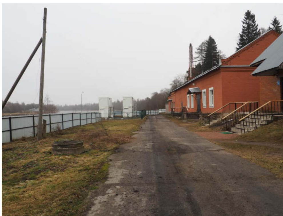
Илл. 26. Точка фотофиксации 12. Общий вид на зону ЗРЗ и место размещения станции водоочистки. Вид с юго-запада. 06.05.2024 г.
