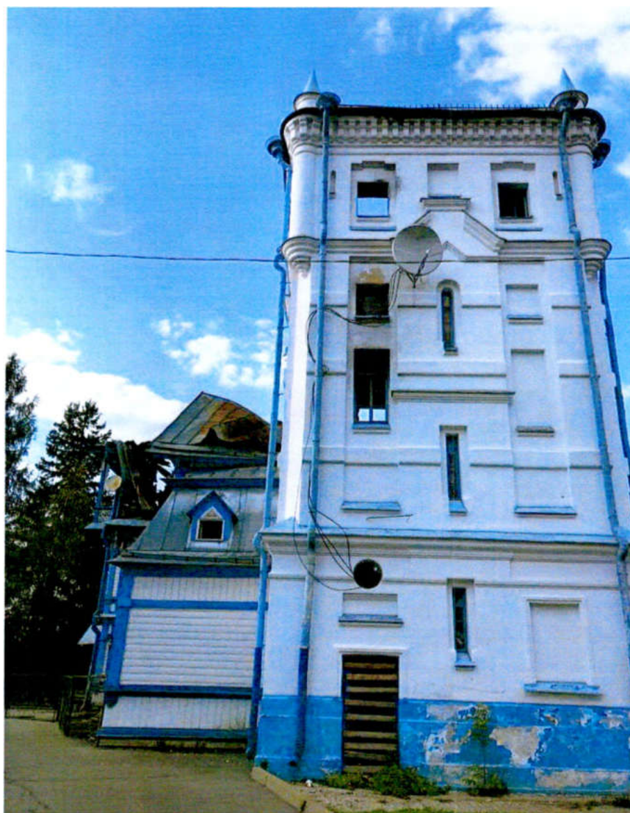
Фото 1. «Главный дом» Кирпичная пристройка с восточной стороны.
