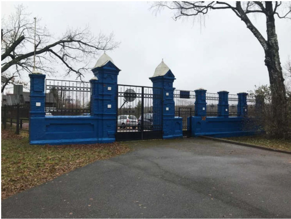
Фото 3. Ограда с воротами. Вид с востока.
