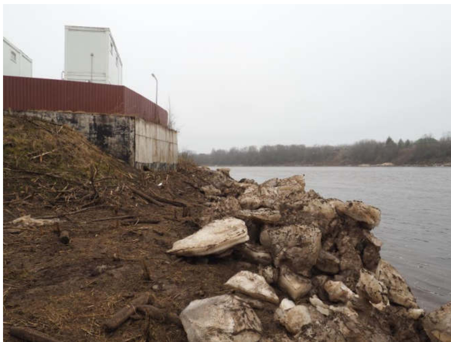
Илл. 44. Точка фотофиксации 20. Общий вид на зону ЗОЛ северо-восточнее существующих очистных сооружений. Вид с востока-северо-востока. 06.05.2024 г.
