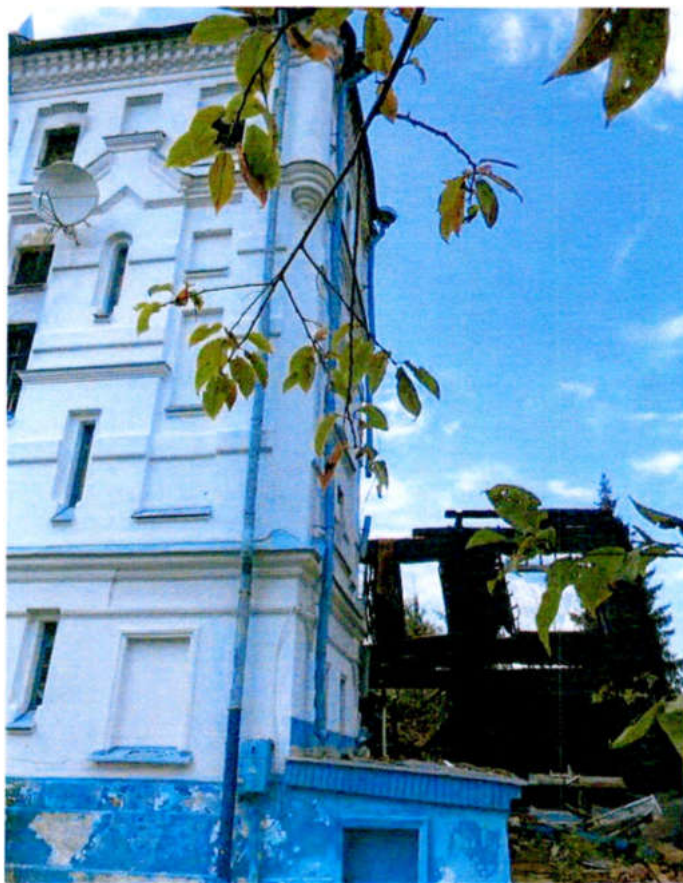
Фото 2. «Главный дом» Кирпичная пристройка с восточной стороны.
