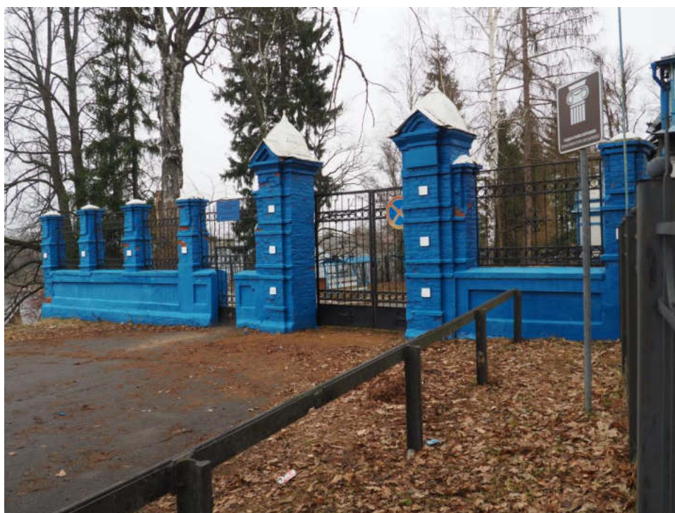
Илл. 3. Точка фотофиксации 1. ОКН регионального значения «Усадьба Мещерских (уточнено: Пименовых-Шараповых)». ОКН «Ограда с воротами». Вид с юго-запада. 06.05.2024 г.
