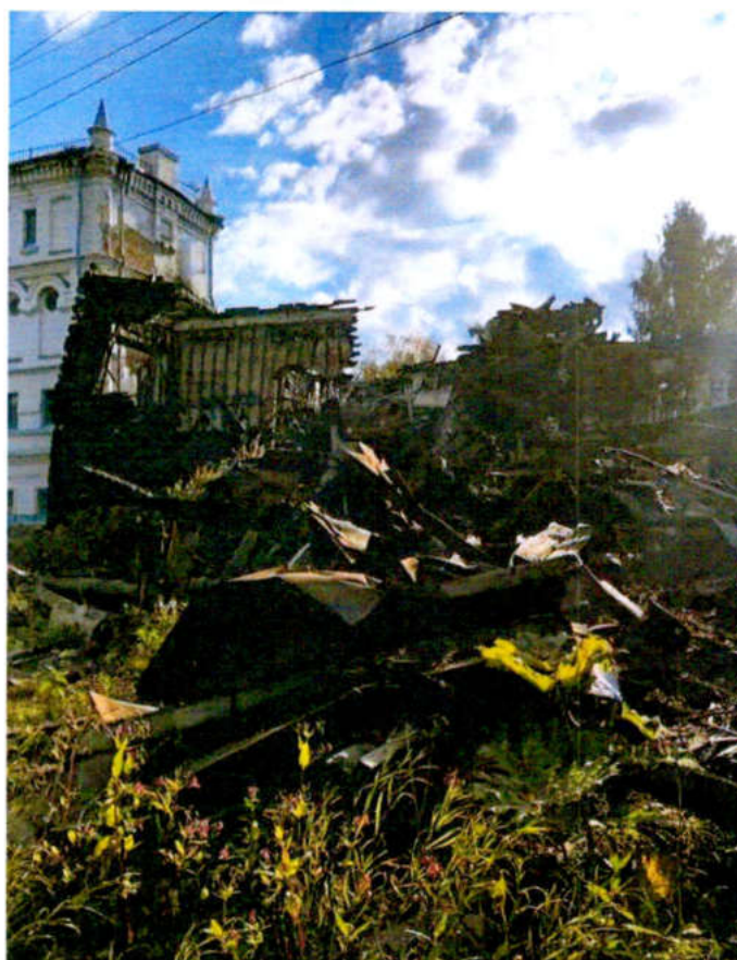
Фото 6. «Главный дом» деревянная часть здания после пожара.
