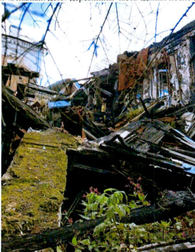
Фото 7. «Главный дом» деревянная часть здания после пожара.
