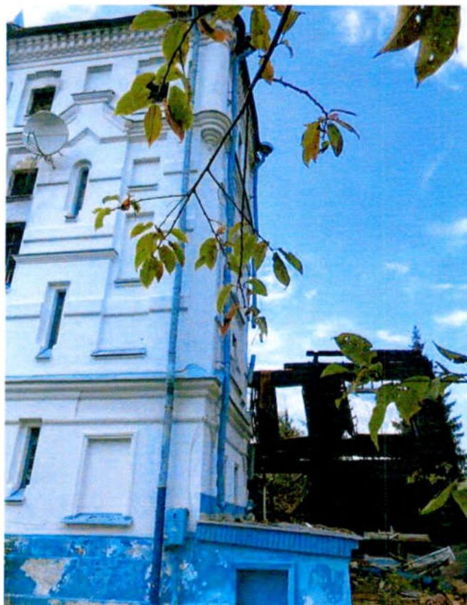
Фото 2. «Главный дом» Кирпичная пристройка с восточной стороны.
