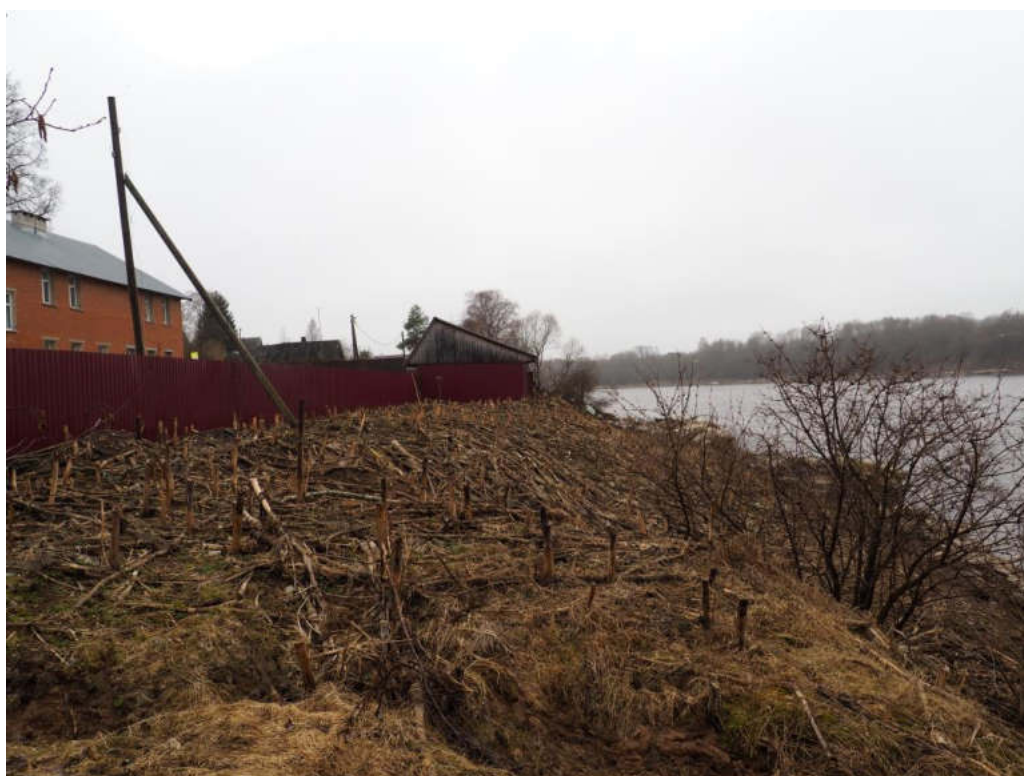
Илл. 37. Точка фотофиксации 17. Общий вид на зоны ЗОЛ и ЗРЗ и место размещения станции водозабора и станции водоочистки. Вид с северо-востока. 06.05.2024 г.
