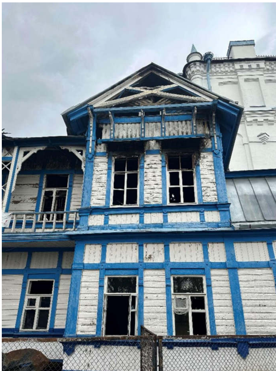
Фото 7. Главный дом. Фрагмент фасада. Вид с юго-запада.
