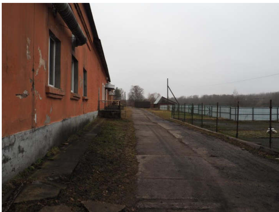
Илл. 28. Точка фотофиксации 13. Общий вид на зону ЗРЗ и место размещения станции водоочистки и станции водозабора. Вид с северо-востока. 06.05.2024 г.
