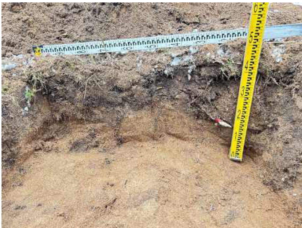
Илл. 20. Ленинградская обл., Выборгский р-н, Приморское гор. поселение, пос. Ключевое. Участок обследования. Шурф 1 разобран до материка. Северная стенка. 19.11.2023 г.
