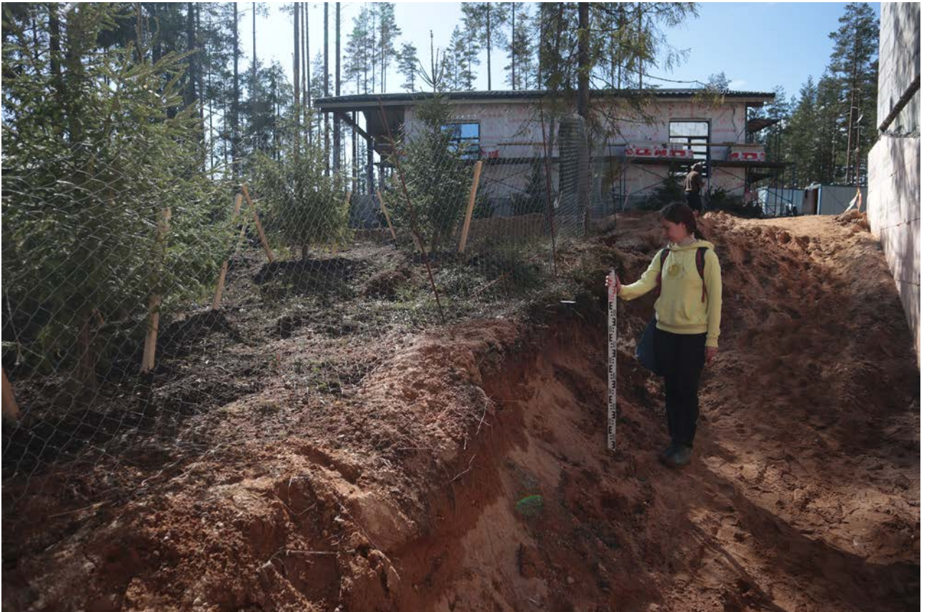
Рис. 46. Ленинградская область, Приозерский район. ЗУ 47:03:0000000:21002. Зачистка 9. Общий вид до начала работ. Вид с севера
