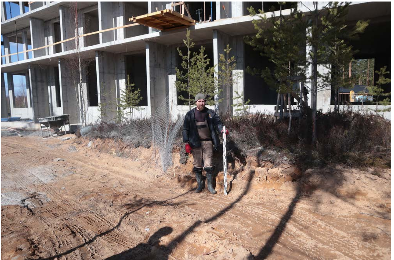
Рис. 44. Ленинградская область, Приозерский район. ЗУ 47:03:0000000:21002. Зачистка 8. Общий вид до начала работ. Вид с юга
