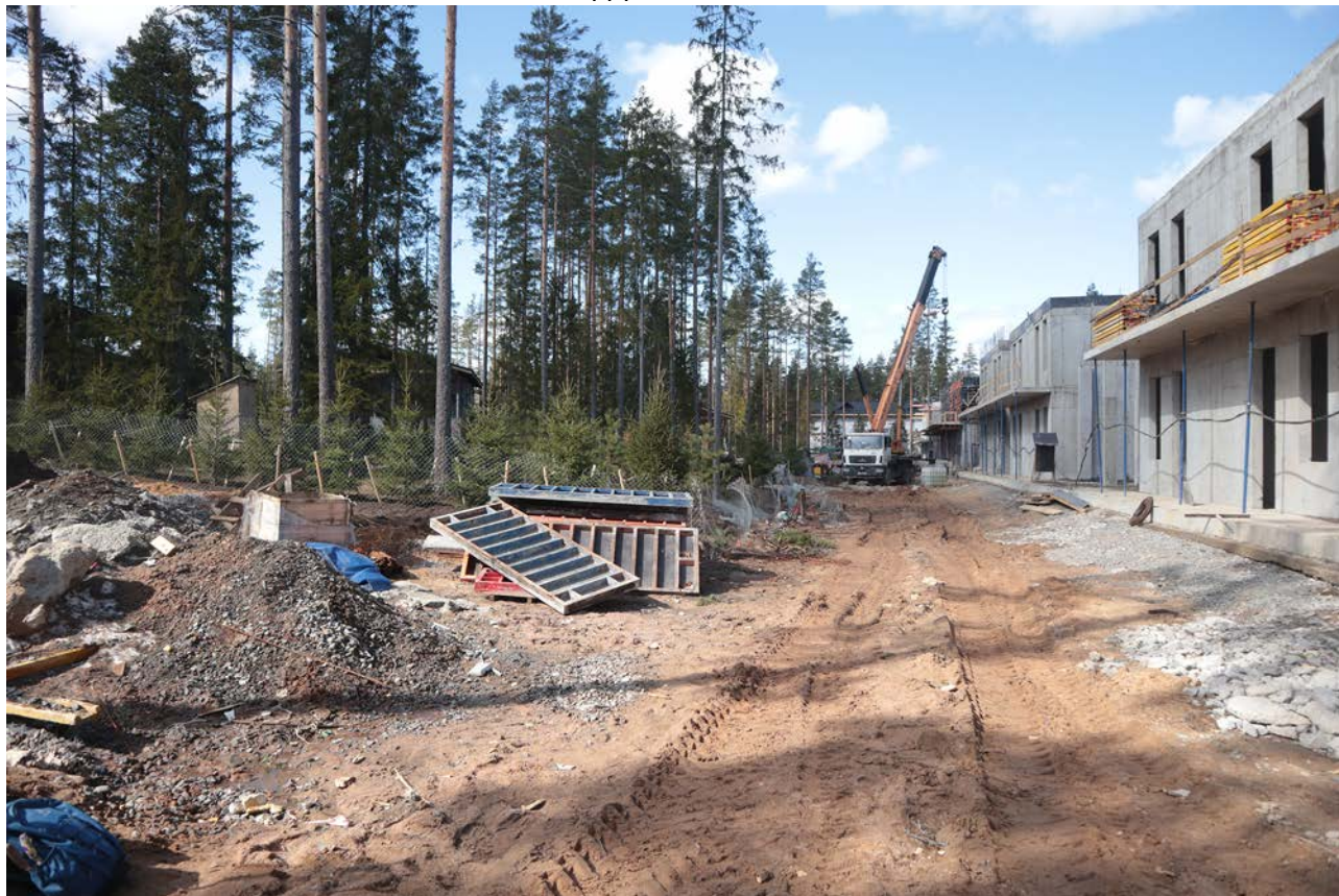
Рис. 17. Ленинградская область, Приозерский район. ЗУ 47:03:0000000:21002. Общий вид центральной части территории обследования. Вид с юго-востока
