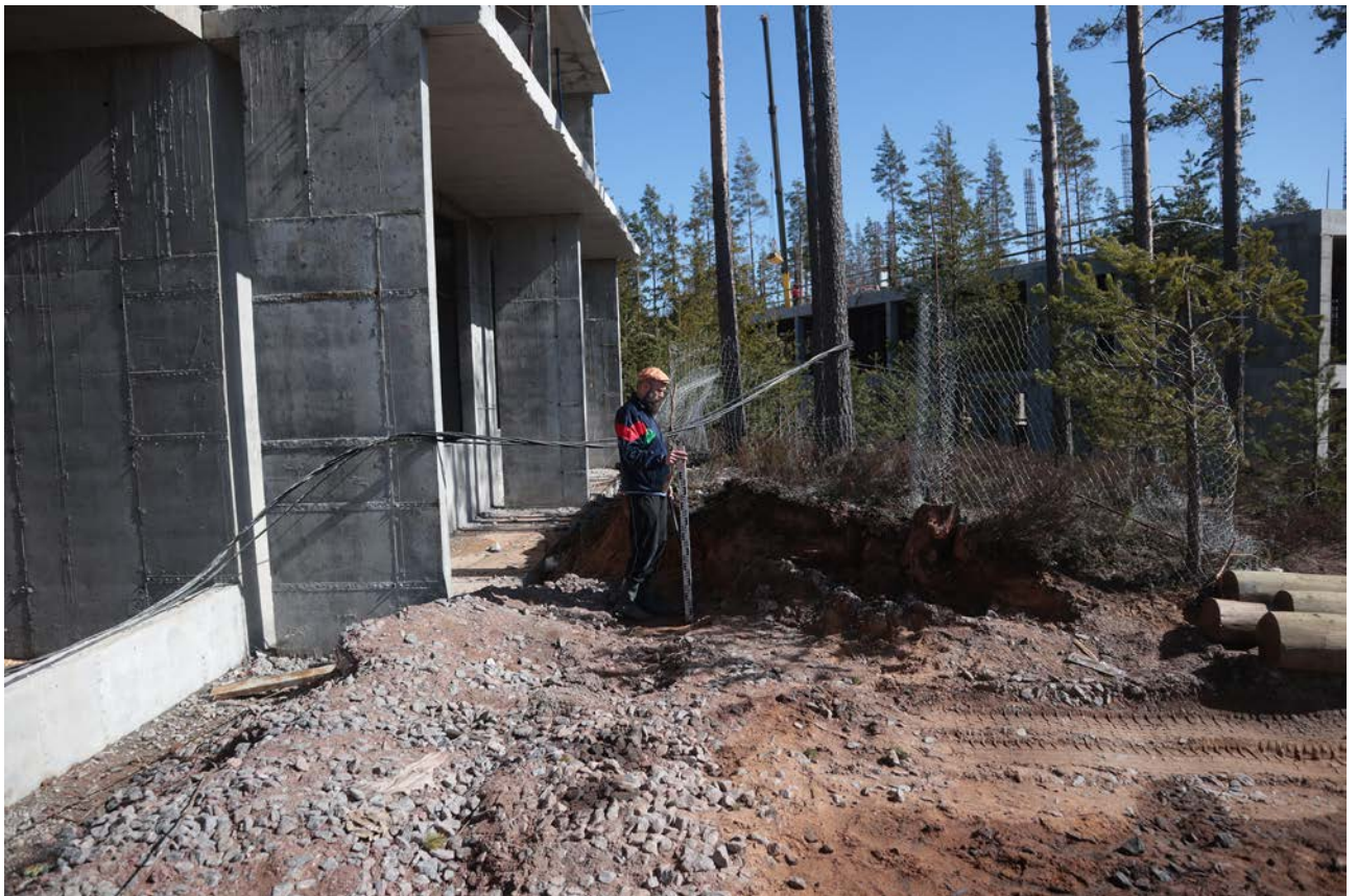
Рис. 42. Ленинградская область, Приозерский район. ЗУ 47:03:0000000:21002. Зачистка 7. Общий вид до начала работ. Вид с запада
