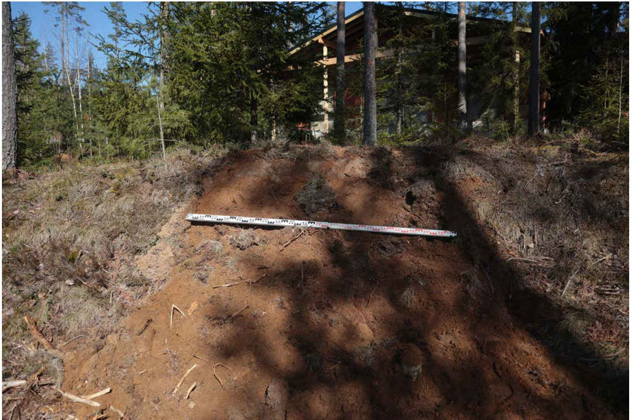
Рис. 27. Ленинградская область, Приозерский район. ЗУ 47:03:0000000:21002. Шурф 2. Рекультивация. Вид с юга
