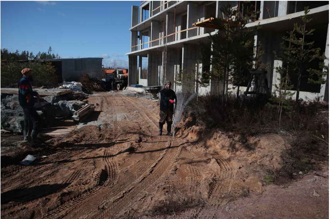
Рис. 14. Ленинградская область, Приозерский район. ЗУ 47:03:0000000:21002. Общий вид западной части территории обследования. Вид на западный угол. Вид с юго-востока
