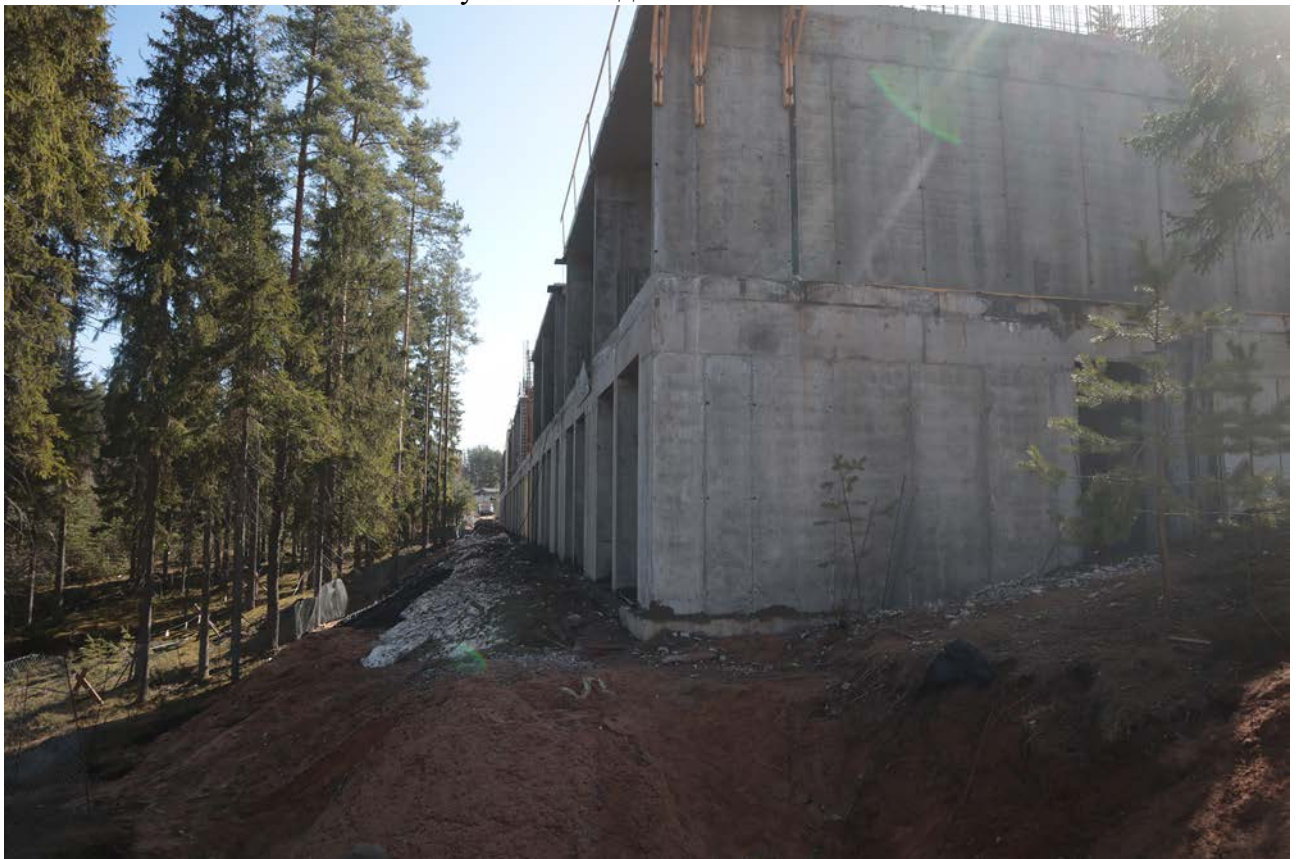
Рис. 16. Ленинградская область, Приозерский район. ЗУ 47:03:0000000:21002. Общий вид северо-восточной части территории обследования. Вид вдоль северо-восточной границы участка. Вид с северо-запада
