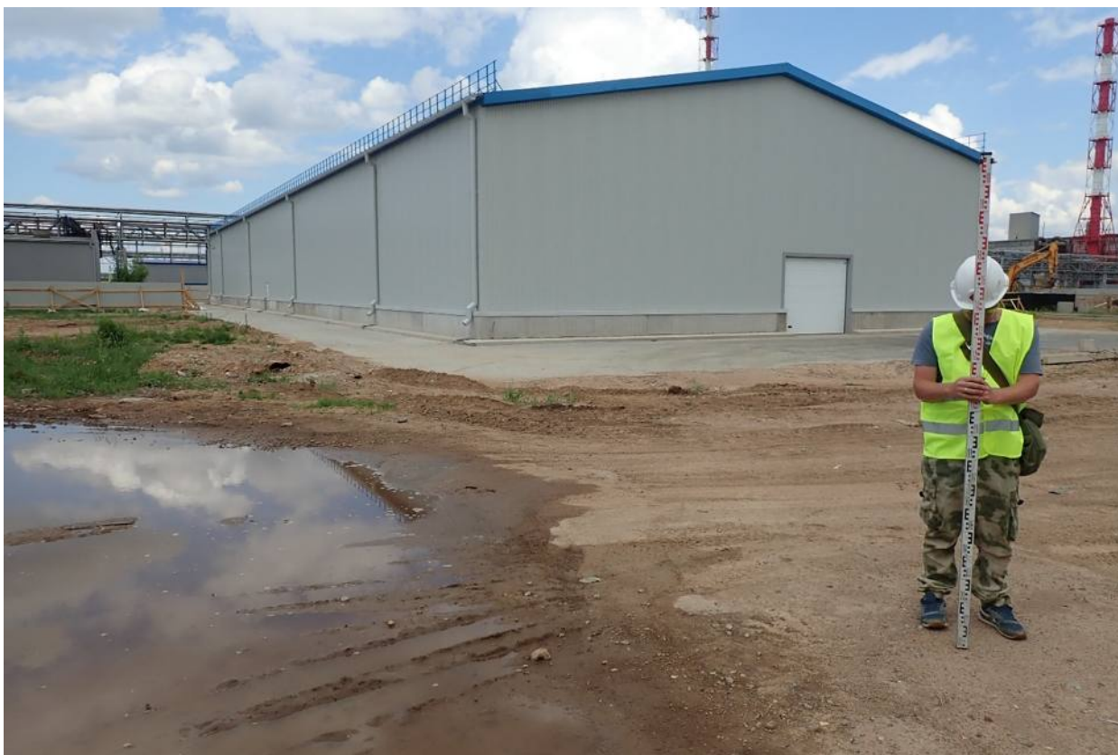
Рис. 11. Земельный участок с кадастровым номером 47:20:0752003:1224, расположенный по адресу: Ленинградская область, Кингисеппский муниципальный район, Большелуцкое сельское поселение, производственная площадка Фосфорит. Точка фотофиксации 1. Новый производственный корпус в северной части участка. Вид с юга
