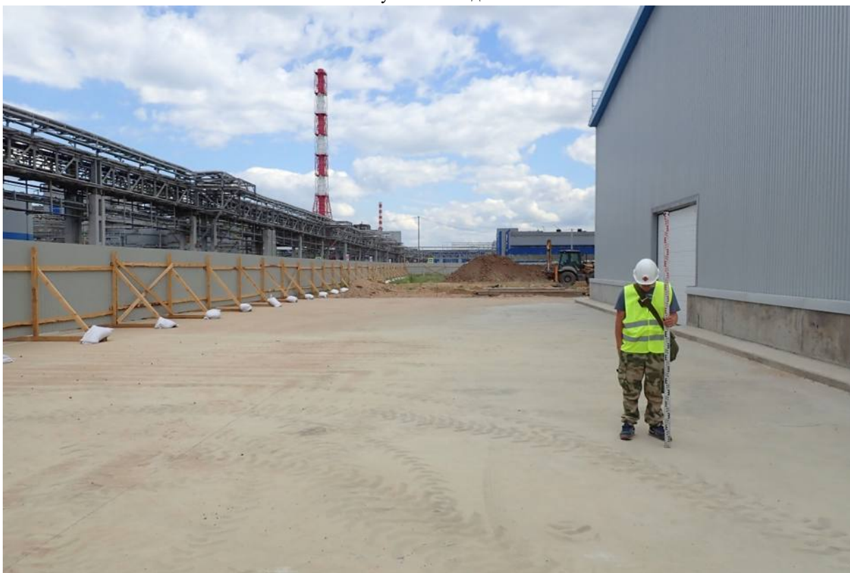
Рис. 12 Земельный участок с кадастровым номером 47:20:0752003:1224, расположенный по адресу: Ленинградская область, Кингисеппский муниципальный район, Большелуцкое сельское поселение, производственная площадка Фосфорит. Бетонная плита в северной части участка. Точка фотофиксации 2, вид с запада.
