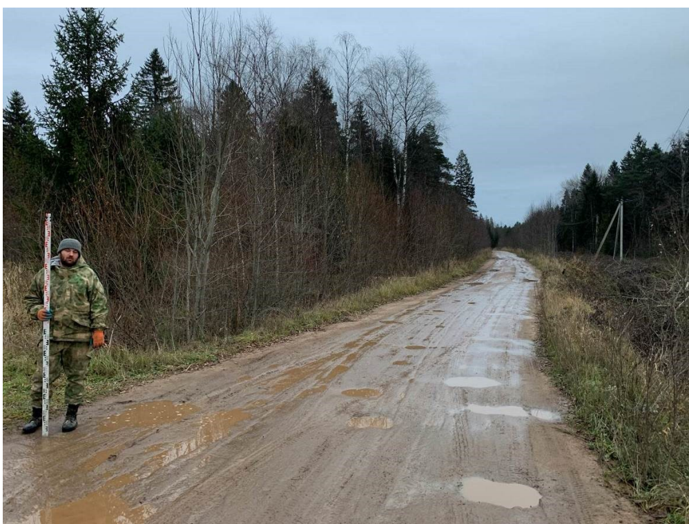
Илл. 109. Ленинградская область, Волховский район. 2024 г. «Газопровод межпоселковый от д. Самушкино – д. Шахново – д. Вороново Волховского района Ленинградской области». Точка фотофиксации 31. Вид с З.
