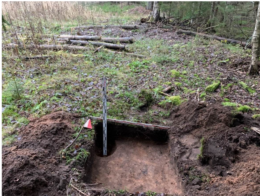
Илл. 105. Ленинградская область, Волховский район. 2024 г. «Газопровод межпоселковый от д. Самушкино – д. Шахново – д. Вороново Волховского района Ленинградской области». Шурф 10. Зачистка по материк. Общий вид с Ю.
