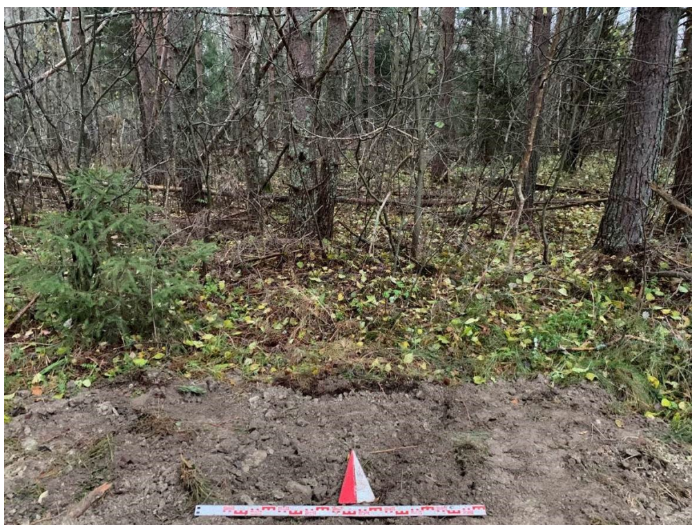
Илл. 46. Ленинградская область, Волховский район. 2024 г. «Газопровод межпоселковый от д. Самушкино – д. Шахново – д. Вороново Волховского района Ленинградской области». Шурф 4. Рекультивация. Вид с Ю.
