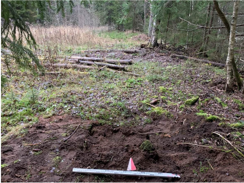
Илл. 106. Ленинградская область, Волховский район. 2024 г. «Газопровод межпоселковый от д. Самушкино – д. Шахново – д. Вороново Волховского района Ленинградской области». Шурф 10. Рекультивация. Вид с Ю.
