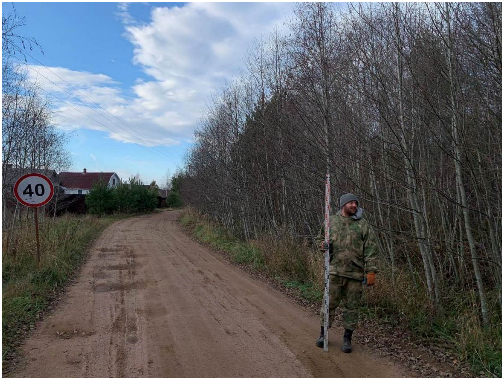
Илл. 48. Ленинградская область, Волховский район. 2024 г. «Газопровод межпоселковый от д. Самушкино – д. Шахново – д. Вороново Волховского района Ленинградской области». Точка фотофиксации 12. Вид с ЮВ.
