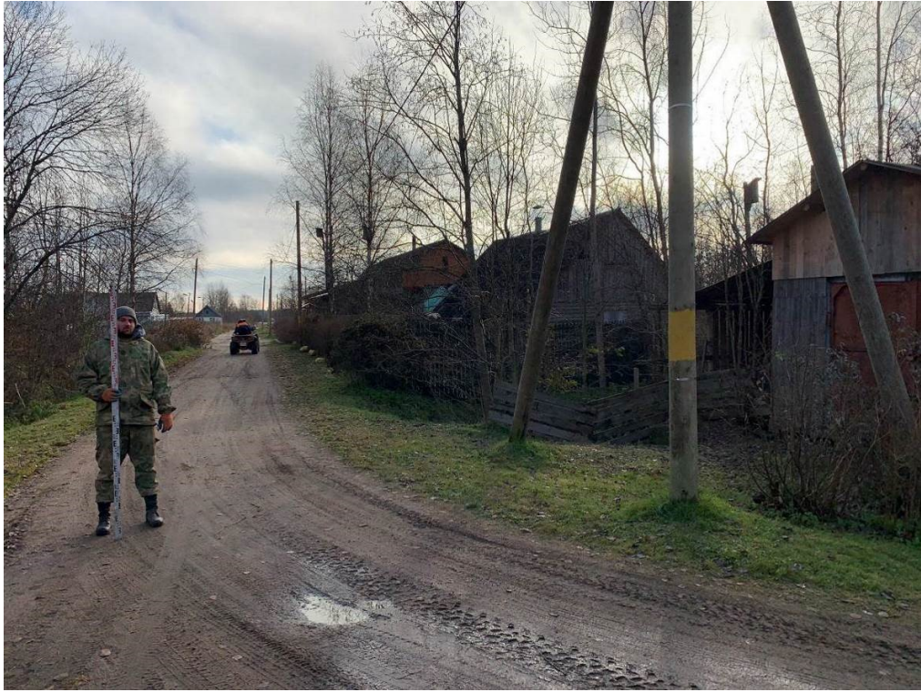
Илл. 19. Ленинградская область, Волховский район. 2024 г. «Газопровод межпоселковый от д. Самушкино – д. Шахново – д. Вороново Волховского района Ленинградской области». Точка фотофиксации 3. Вид с СЗ.
