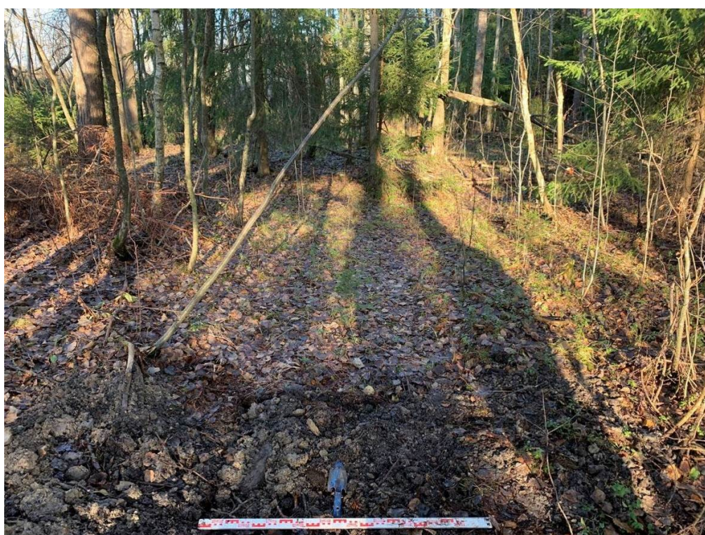
Илл. 32. Ленинградская область, Волховский район. 2024 г. «Газопровод межпоселковый от д. Самушкино – д. Шахново – д. Вороново Волховского района Ленинградской области». Шурф 3. Рекультивация. Вид с Ю.
