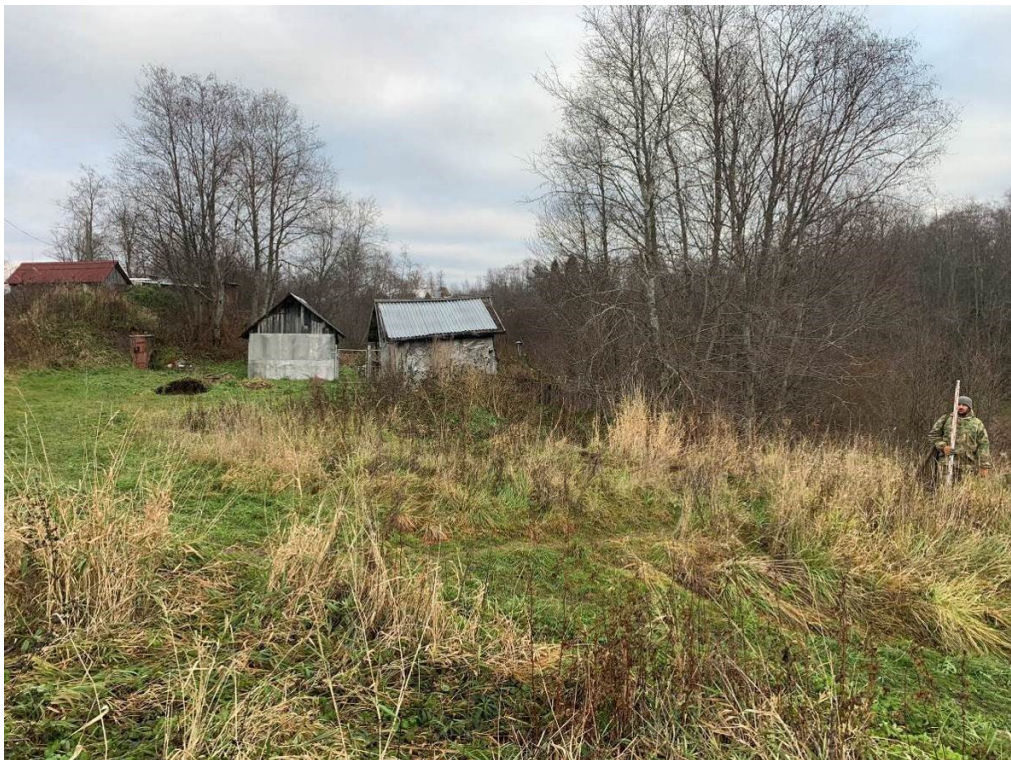
Илл. 10. Ленинградская область, Волховский район. 2024 г. «Газопровод межпоселковый от д. Самушкино – д. Шахново – д. Вороново Волховского района Ленинградской области». Точка фотофиксации 1. Вид с ЗЮЗ.
