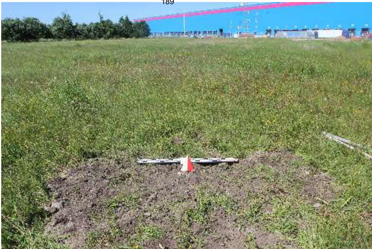
Рис. 171. ЛО_2023. Бугры КН16523, 16524, 16525. Шурф 16 после рекультивации, вид на север.
