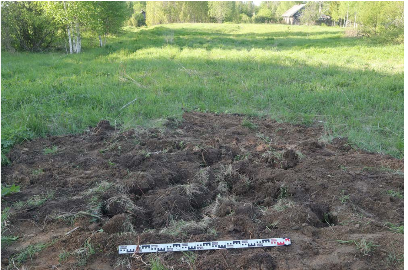
Рис. 146. Ленинградская область, Бокситогорский район. «Межпоселковый газопровод от ГРС Пикалево до д. Анисимова Бокситогорского района Ленинградской области». Шурф 28. Рекультивация. Вид с юга
