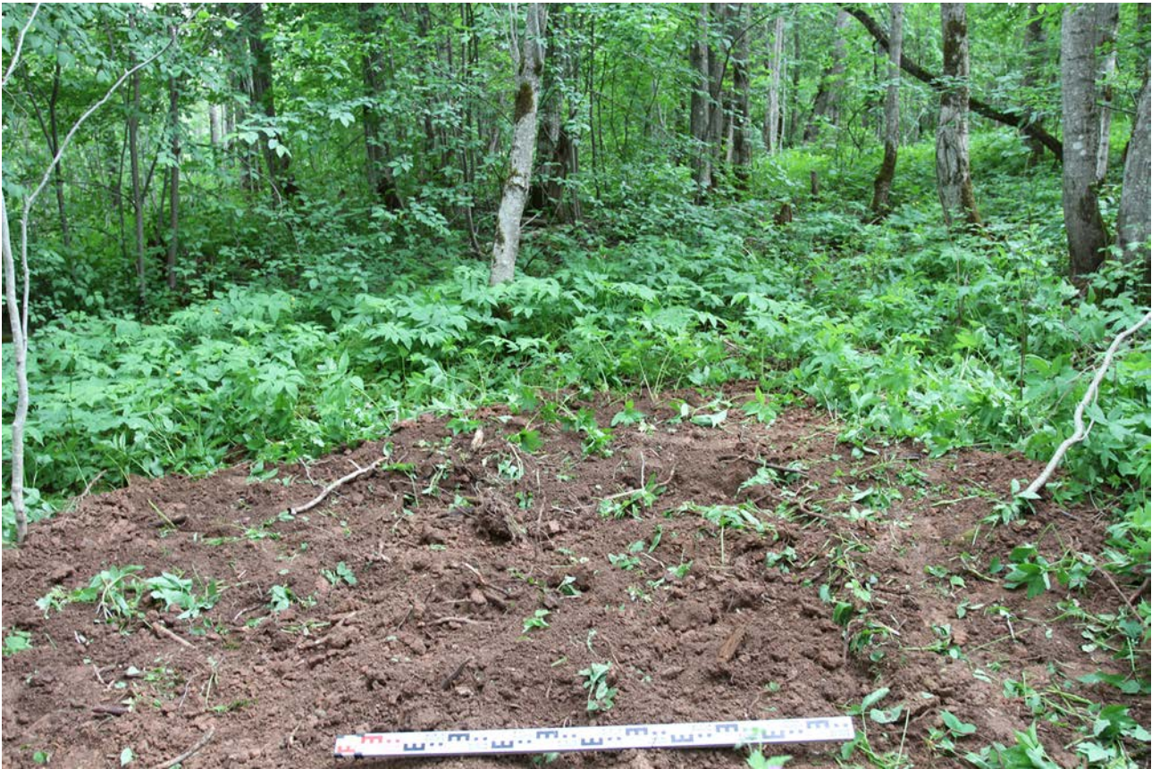
Рис. 62. Ленинградская область, Бокситогорский район. «Межпоселковый газопровод от ГРС Пикалево до д. Анисимово Бокситогорского района Ленинградской области». Шурф 10. Рекультивация. Вид с юга
