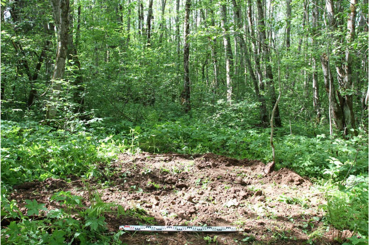
Рис. 54. Ленинградская область, Бокситогорский район. «Межпоселковый газопровод от ГРС Пикалево до д. Анисимово Бокситогорского района Ленинградской области». Шурф 8. Рекультивация. Вид с юга
