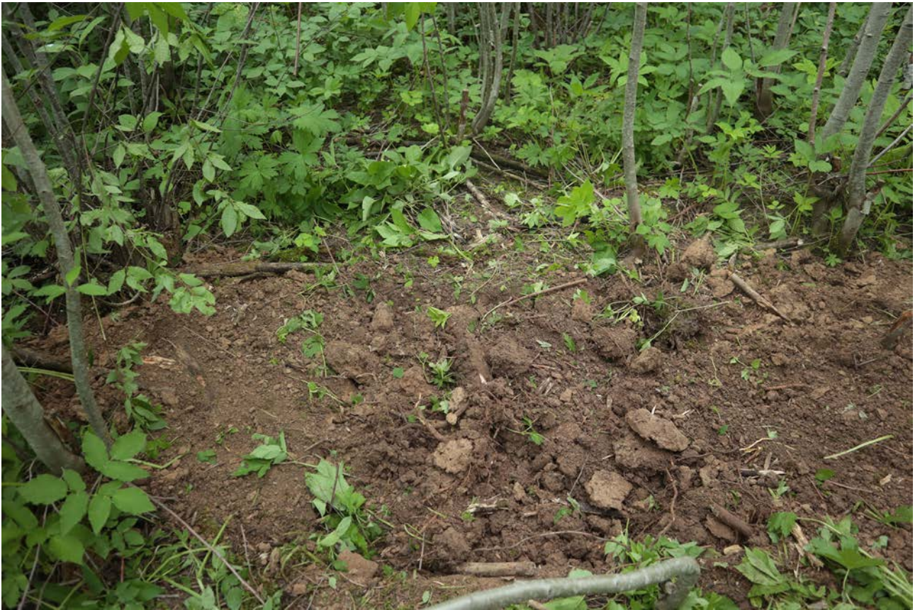
Рис. 70. Ленинградская область, Бокситогорский район. «Межпоселковый газопровод от ГРС Пикалево до д. Анисимово Бокситогорского района Ленинградской области». Шурф 12. Рекультивация. Вид с юга
