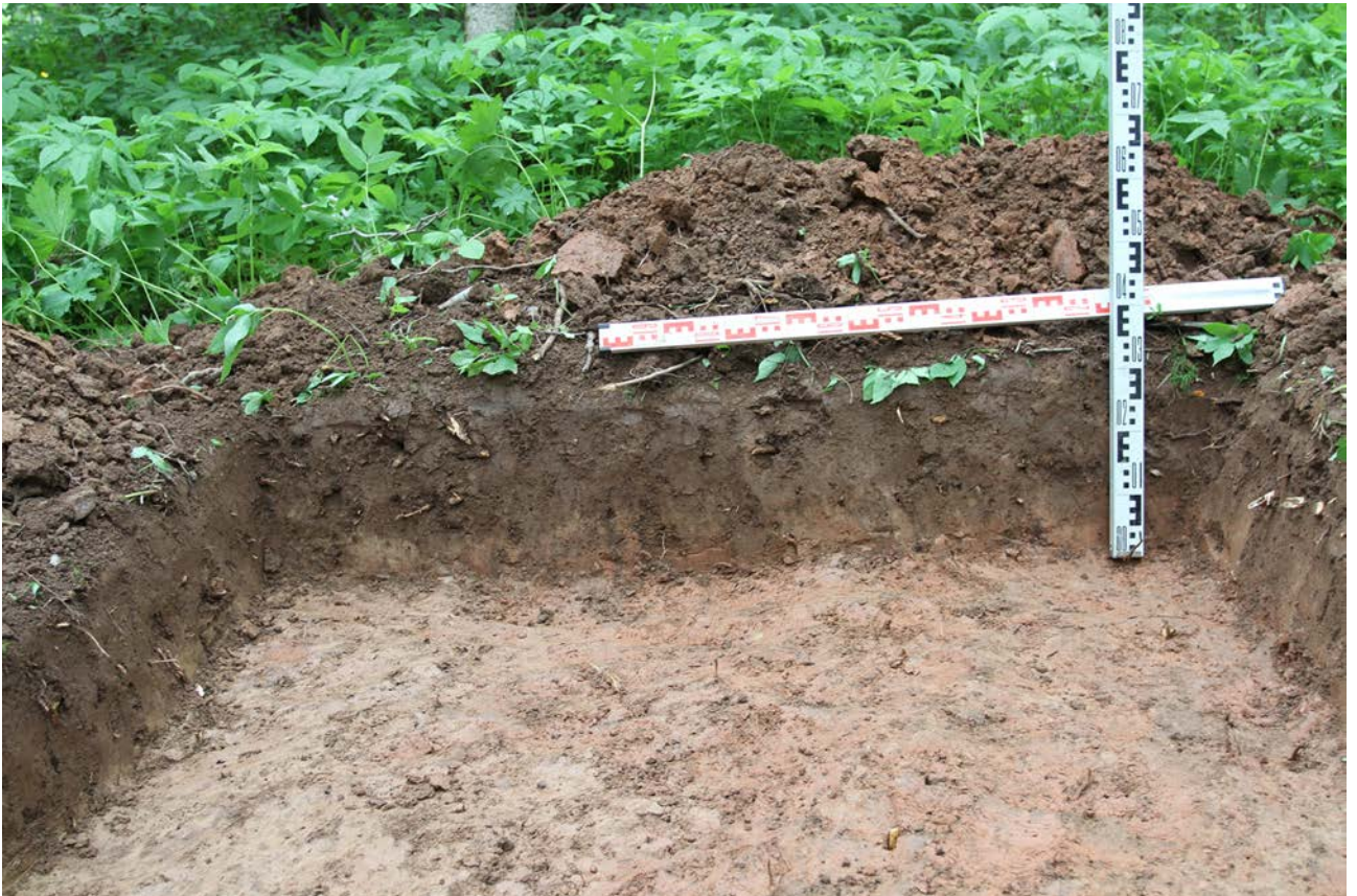
Рис. 61. Ленинградская область, Бокситогорский район. «Межпоселковый газопровод от ГРС Пикалево до д. Анисимова Бокситогорского района Ленинградской области». Шурф 10. Стратиграфия северной стенки. Вид с юга
