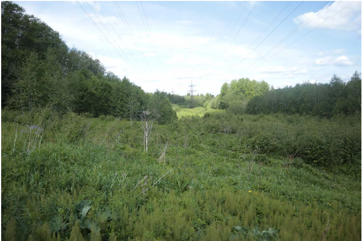
Рис. 15. Ленинградская область, Бокситогорский район. «Межпоселковый газопровод от ГРС Пикалево до д. Анисимово Бокситогорского района Ленинградской области». Прохождение трассы проектируемого газопровода по левому берегу р. Рядань вдоль существующей ЛЭП. Вид с юго-востока
