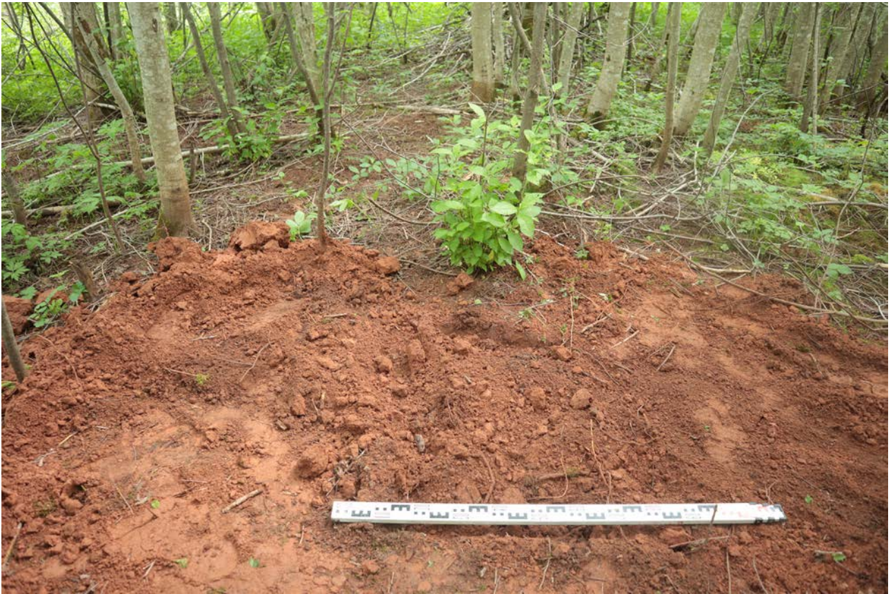
Рис. 78. Ленинградская область, Бокситогорский район. «Межпоселковый газопровод от ГРС Пикалево до д. Анисимово Бокситогорского района Ленинградской области». Шурф 14. Рекультивация. Вид с юга
