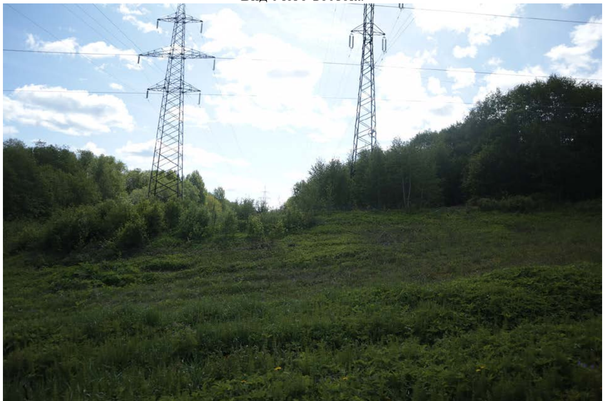
Рис. 16. Ленинградская область, Бокситогорский район. «Межпоселковый газопровод от ГРС Пикалево до д. Анисимово Бокситогорского района Ленинградской области». Прохождение трассы проектируемого газопровода по левому берегу р. Рядань вдоль существующей ЛЭП. Вид с северо-запада
