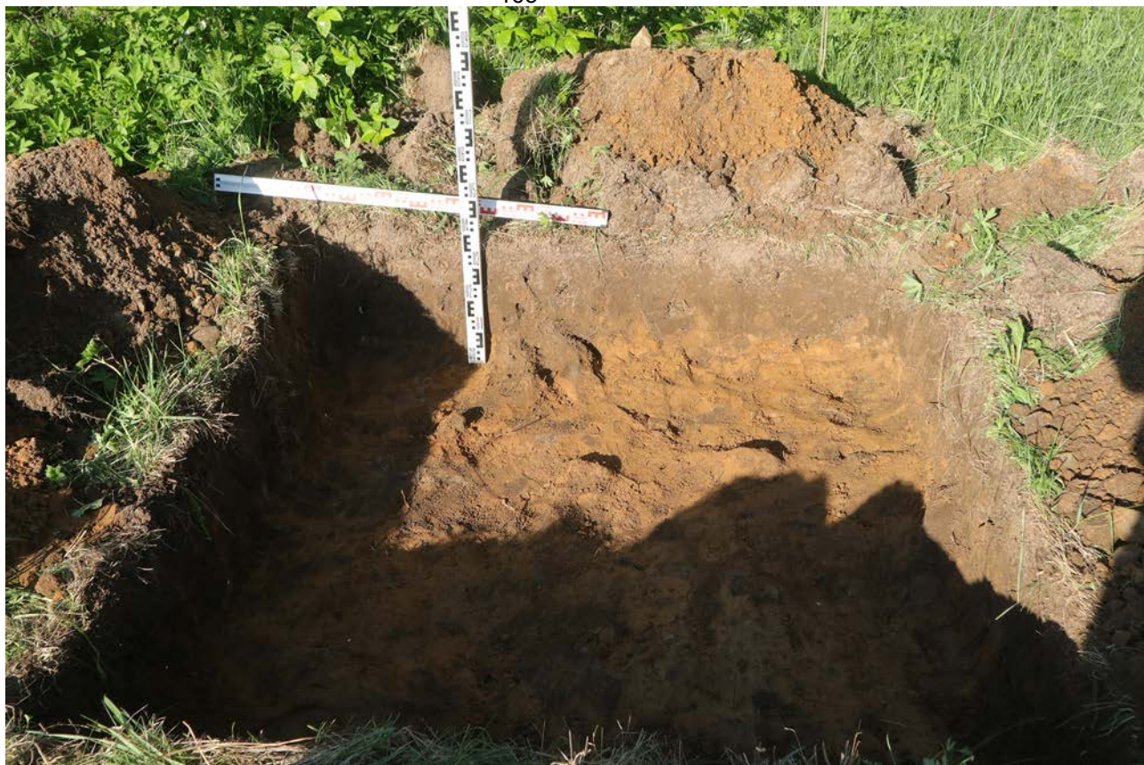
Рис. 140. Ленинградская область, Бокситогорский район. «Межпоселковый газопровод от ГРС Пикалево до д. Анисимово Бокситогорского района Ленинградской области». Шурф 27. Общий вид. Вид с юга
