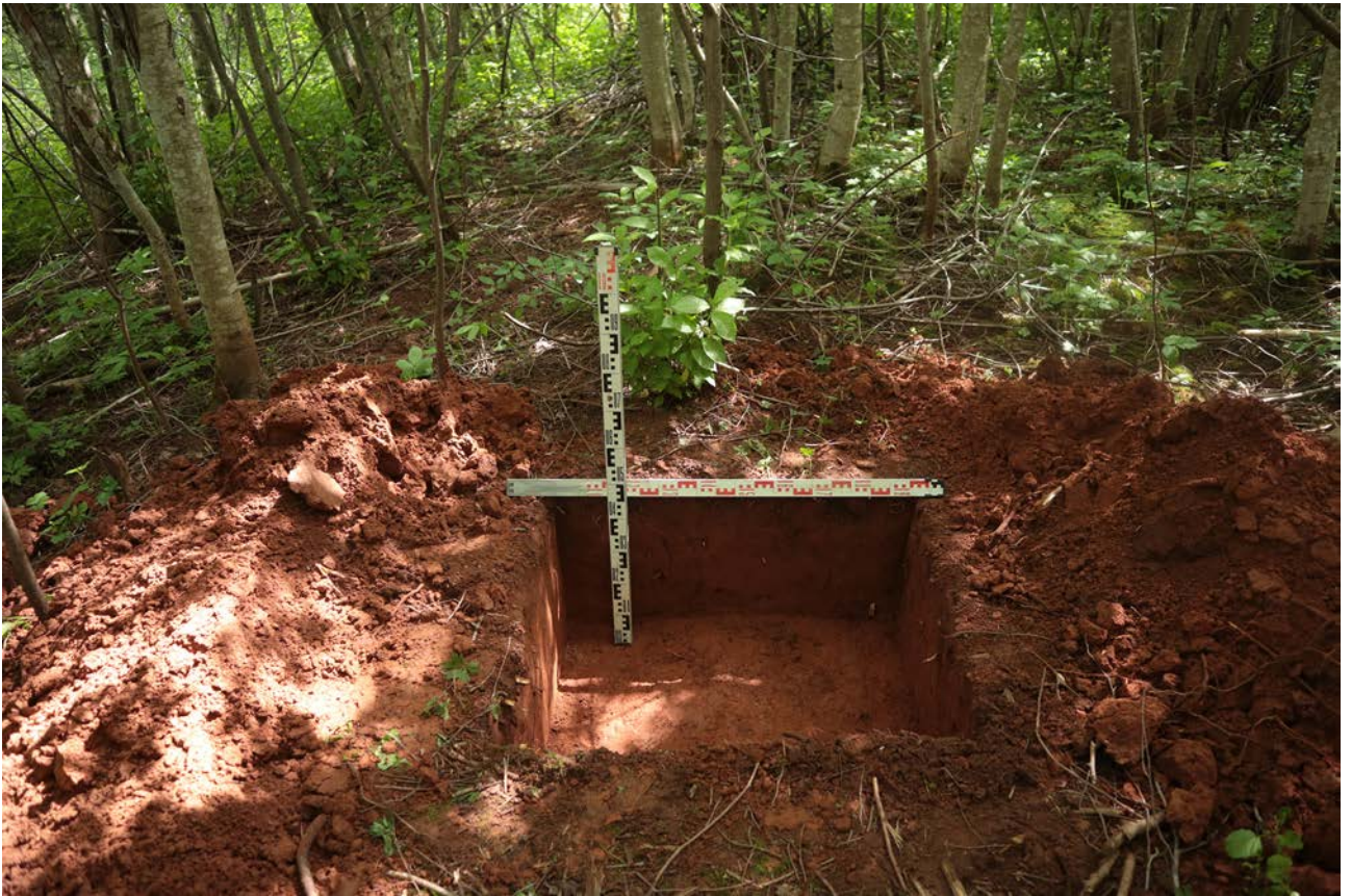
Рис. 76. Ленинградская область, Бокситогорский район. «Межпоселковый газопровод от ГРС Пикалево до д. Анисимово Бокситогорского района Ленинградской области». Шурф 14. Общий вид. Вид с юга
