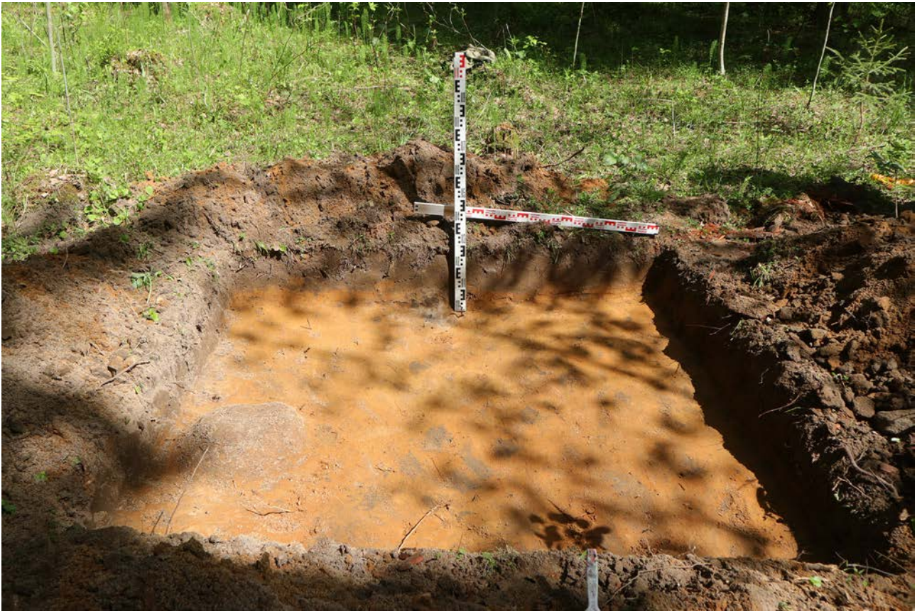
Рис. 100. Ленинградская область, Бокситогорский район. «Межпоселковый газопровод от ГРС Пикалево до д. Анисимово Бокситогорского района Ленинградской области». Шурф 20. Общий вид. Вид с юга
