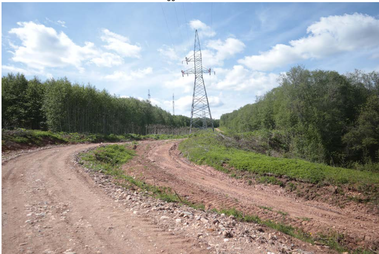
Рис. 13. Ленинградская область, Бокситогорский район. «Межпоселковый газопровод от ГРС Пикалево до д. Анисимово Бокситогорского района Ленинградской области». Берег р. Рядань в месте пересечения с трассой проектируемого газопровода. Вид на левый берег с северо-востока
