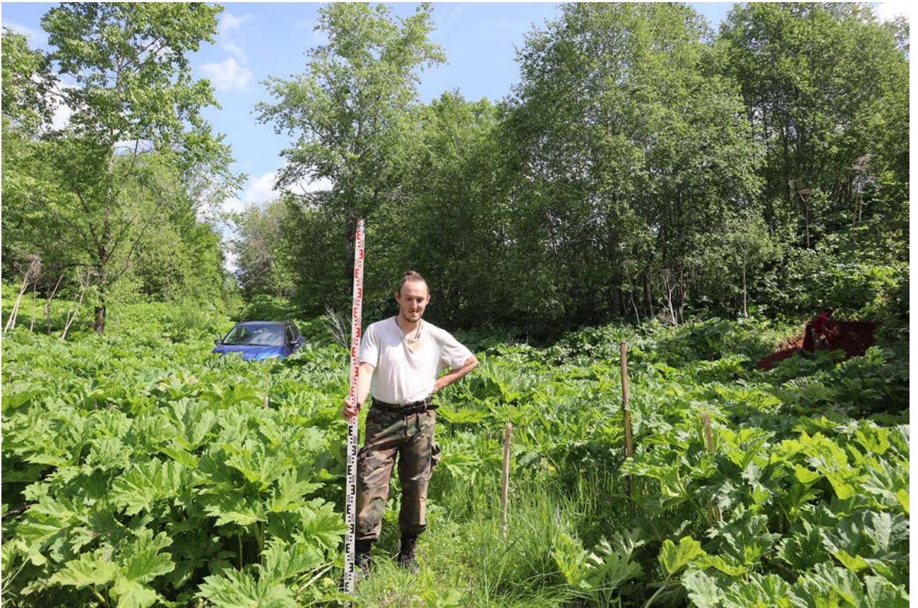
Рис. 27. Ленинградская область, Бокситогорский район. «Межпоселковый газопровод от ГРС Пикалево до д. Анисимово Бокситогорского района Ленинградской области». Шурф 2. Общий вид до начала работ. Вид с юга
