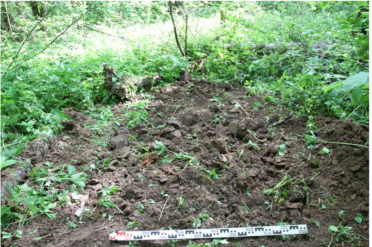
Рис. 58. Ленинградская область, Бокситогорский район. «Межпоселковый газопровод от ГРС Пикалево до д. Анисимово Бокситогорского района Ленинградской области». Шурф 9. Рекультивация. Вид с юга
