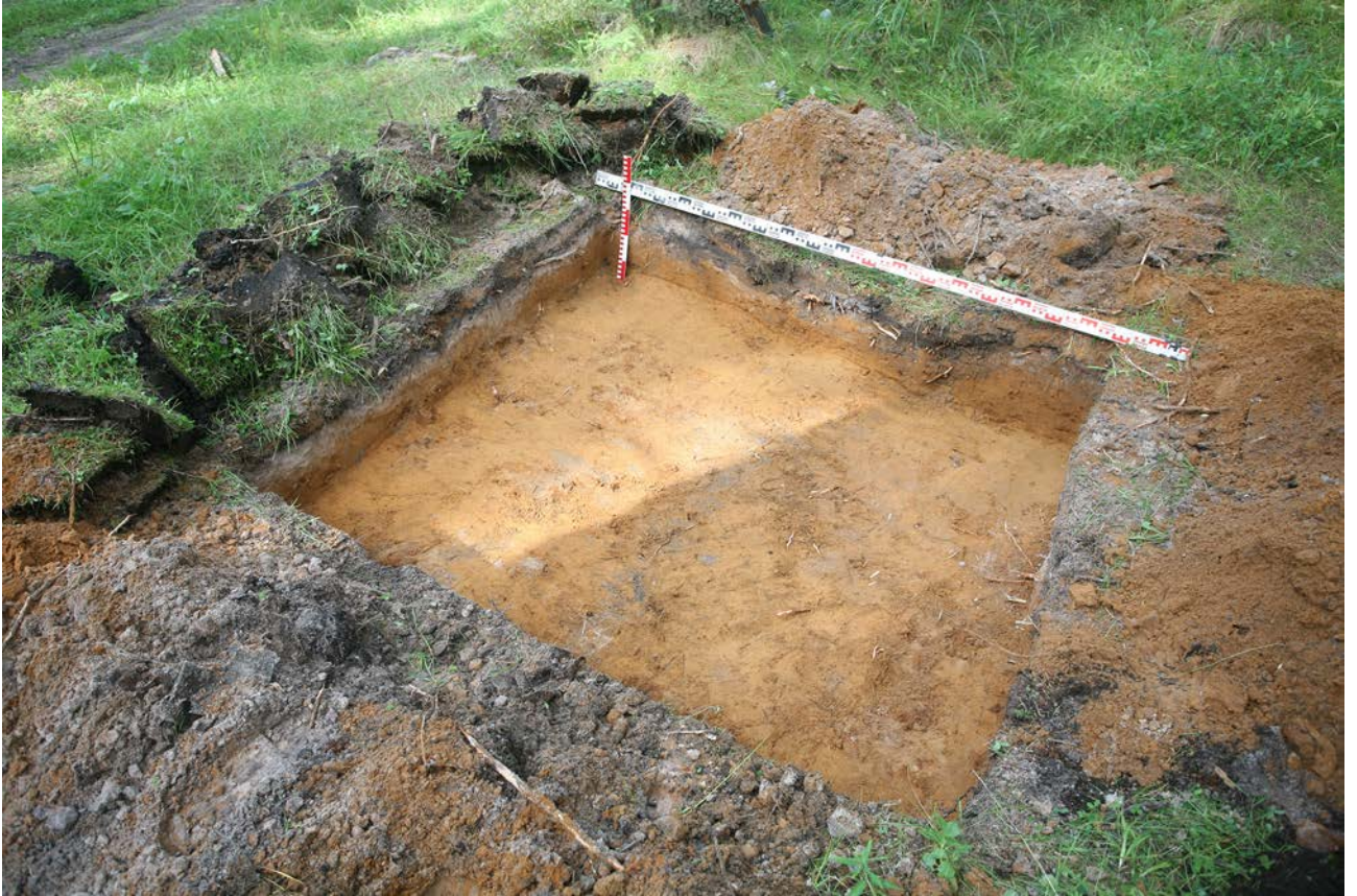
Рис. 124. Ленинградская область, Бокситогорский район. «Межпоселковый газопровод от ГРС Пикалево до д. Анисимова Бокситогорского района Ленинградской области». Шурф 25. Общий вид. Вид с юга
