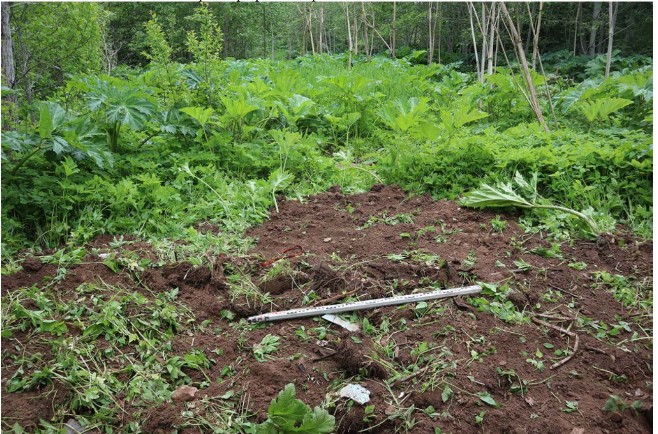
Рис. 42. Ленинградская область, Бокситогорский район. «Межпоселковый газопровод от ГРС Пикалево до д. Анисимово Бокситогорского района Ленинградской области». Шурф 5. Рекультивация. Вид с юга
