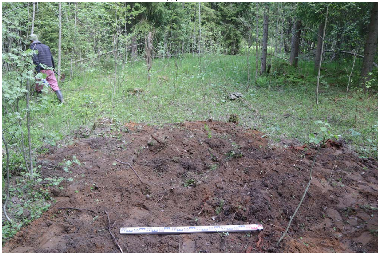
Рис. 102. Ленинградская область, Бокситогорский район. «Межпоселковый газопровод от ГРС Пикалево до д. Анисимова Бокситогорского района Ленинградской области». Шурф 20. Рекультивация. Вид с юга
