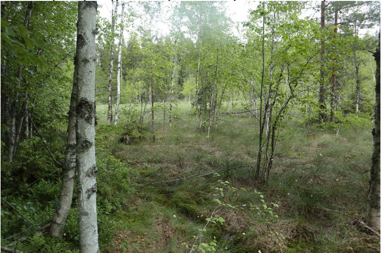
Рис. 131. Ленинградская область, Бокситогорский район. «Межпоселковый газопровод от ГРС Пикалево до д. Анисимово Бокситогорского района Ленинградской области». Прохождение трассы проектируемого газопровода по болоту Анохино. Вид с юга
