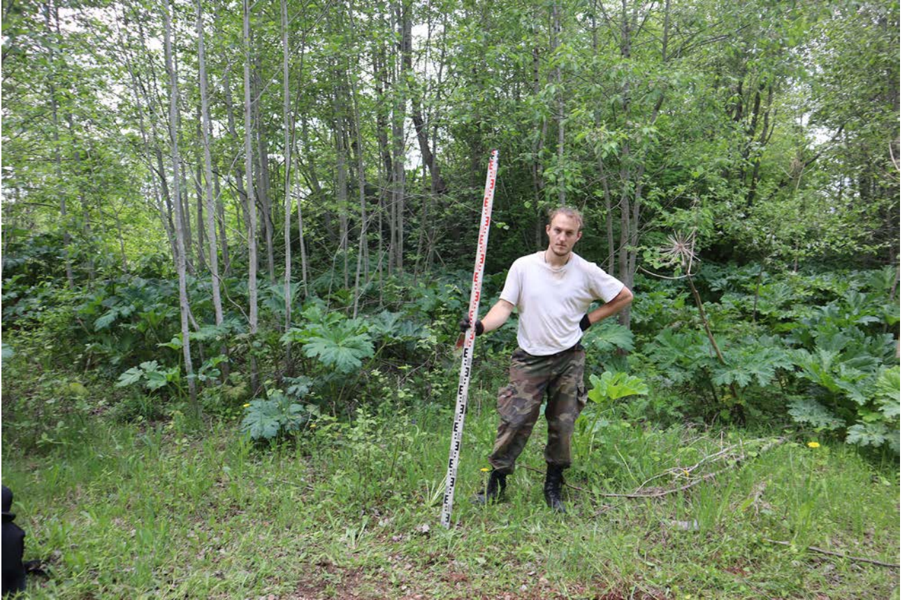
Рис. 35. Ленинградская область, Бокситогорский район. «Межпоселковый газопровод от ГРС Пикалево до д. Анисимово Бокситогорского района Ленинградской области». Шурф 4. Общий вид до начала работ. Вид с юга
