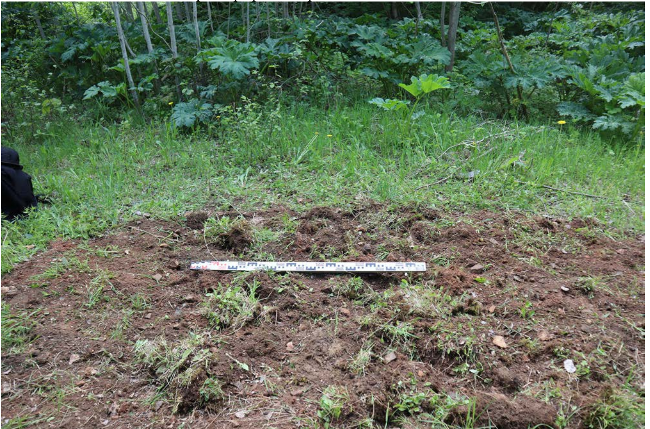
Рис. 38. Ленинградская область, Бокситогорский район. «Межпоселковый газопровод от ГРС Пикалево до д. Анисимово Бокситогорского района Ленинградской области». Шурф 4. Рекультивация. Вид с юга
