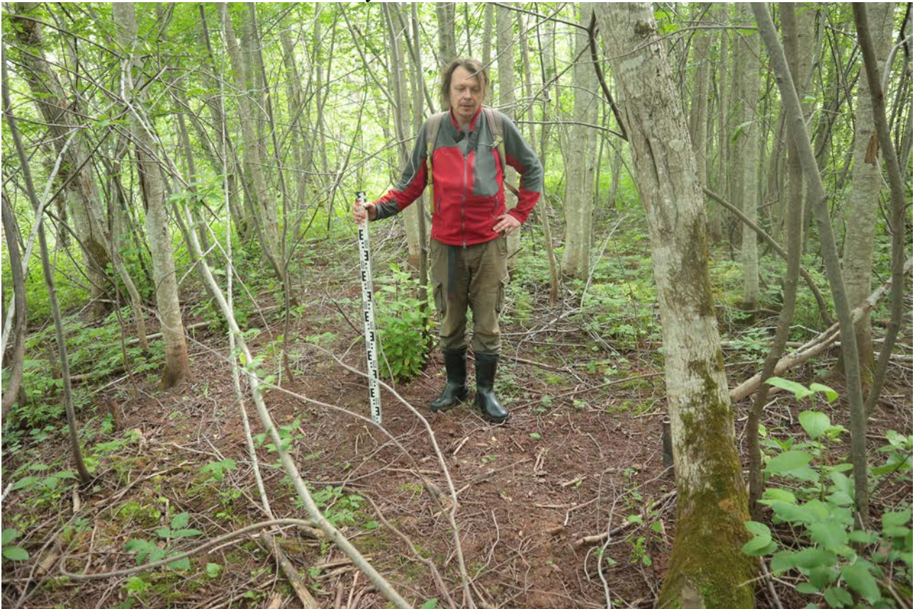
Рис. 75. Ленинградская область, Бокситогорский район. «Межпоселковый газопровод от ГРС Пикалево до д. Анисимово Бокситогорского района Ленинградской области». Шурф 14. Общий вид до начала работ. Вид с юга
