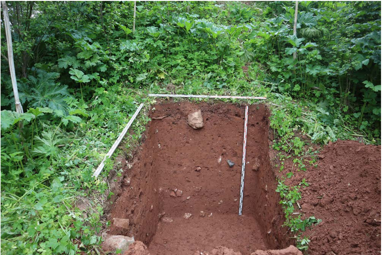
Рис. 48. Ленинградская область, Бокситогорский район. «Межпоселковый газопровод от ГРС Пикалево до д. Анисимово Бокситогорского района Ленинградской области». Шурф 7. Общий вид. Вид с севера
