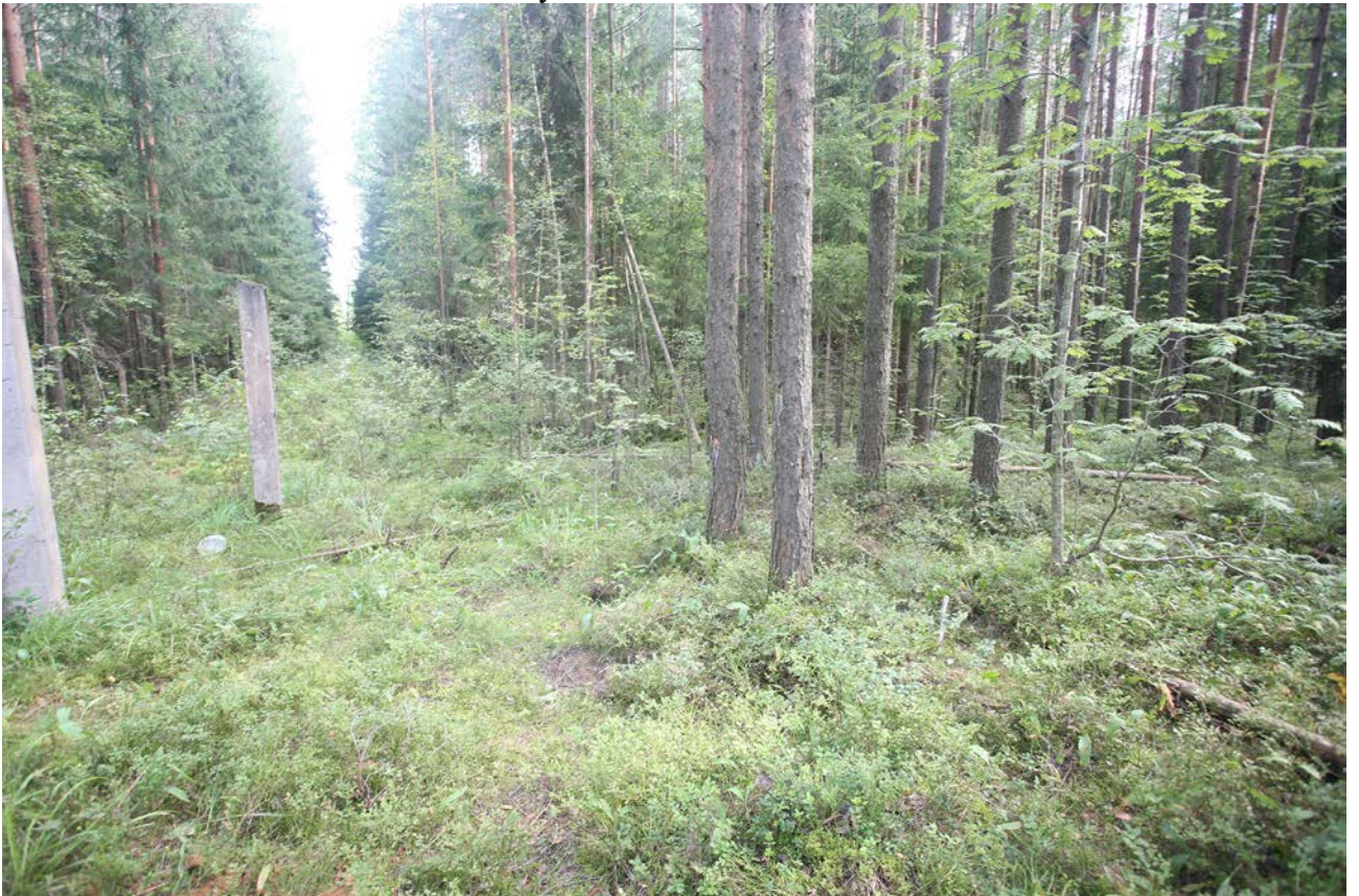
Рис. 119. Ленинградская область, Бокситогорский район. «Межпоселковый газопровод от ГРС Пикалево до д. Анисимово Бокситогорского района Ленинградской области». Шурф 24. Общий вид до начала работ. Вид с юга
