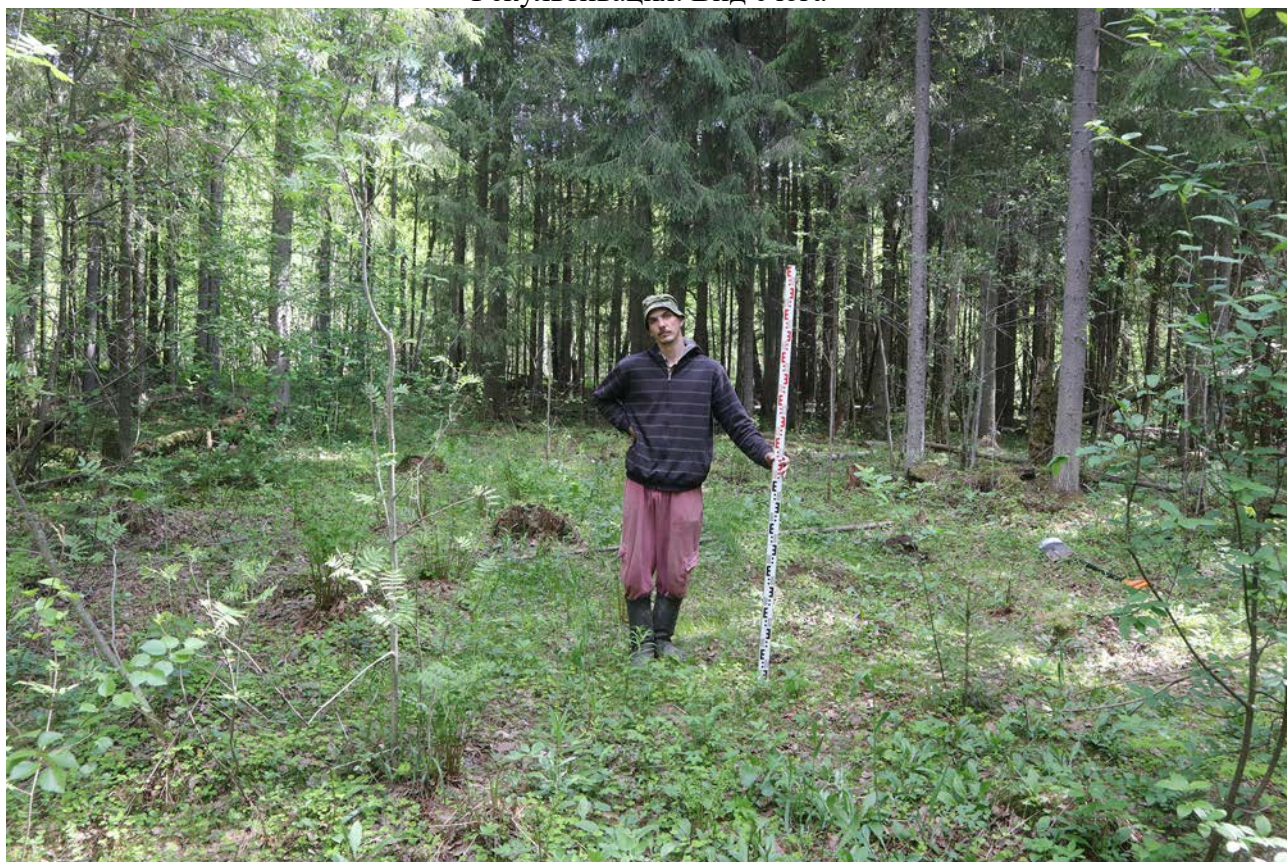
Рис. 103. Ленинградская область, Бокситогорский район. «Межпоселковый газопровод от ГРС Пикалево до д. Анисимова Бокситогорского района Ленинградской области». Шурф 21. Общий вид до начала работ. Вид с юга
