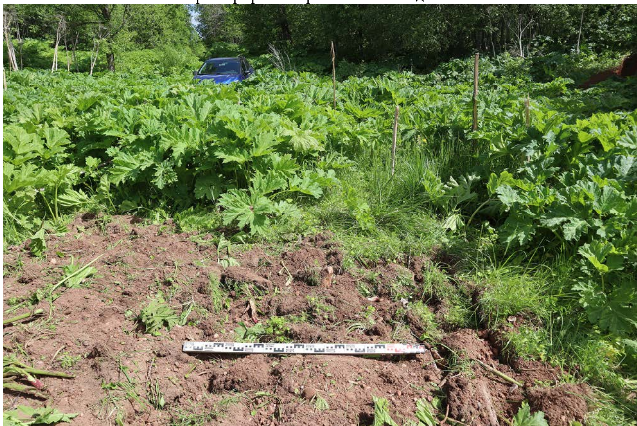
Рис. 30. Ленинградская область, Бокситогорский район. «Межпоселковый газопровод от ГРС Пикалево до д. Анисимово Бокситогорского района Ленинградской области». Шурф 2. Рекультивация. Вид с юга
