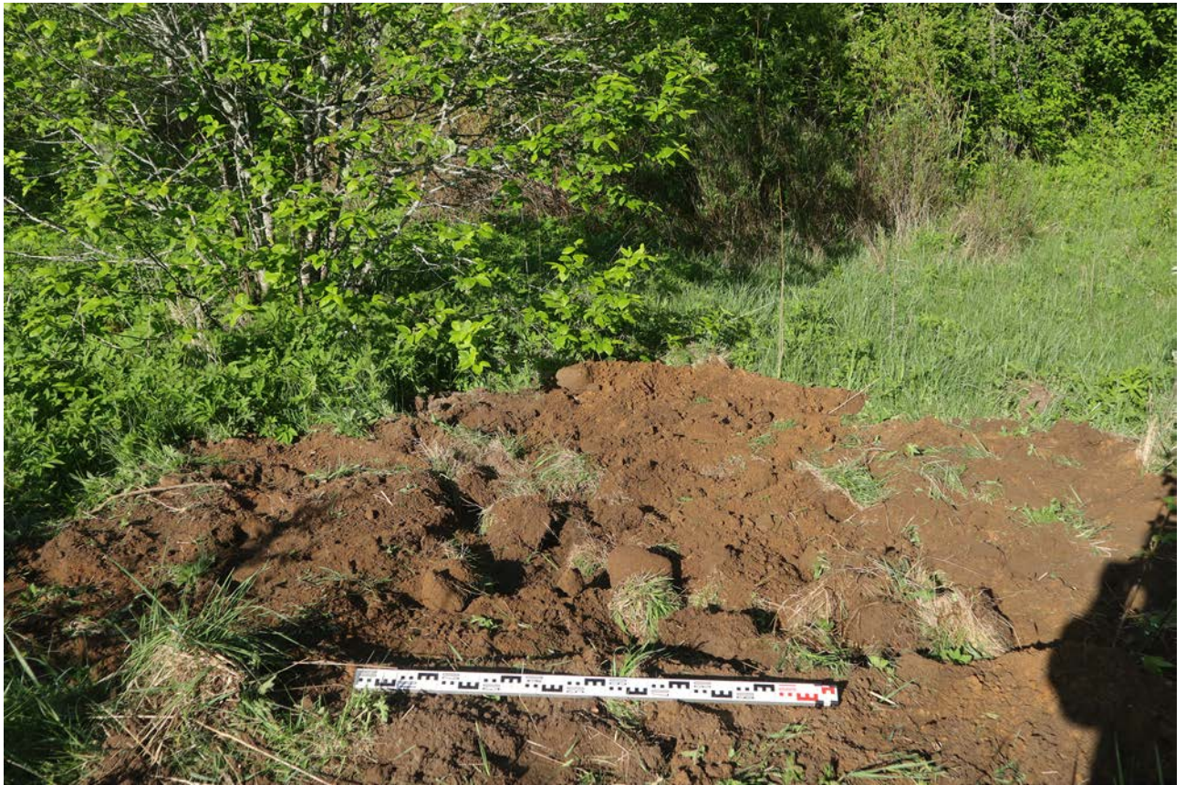
Рис. 142. Ленинградская область, Бокситогорский район. «Межпоселковый газопровод от ГРС Пикалево до д. Анисимово Бокситогорского района Ленинградской области». Шурф 27. Рекультивация. Вид с юга
