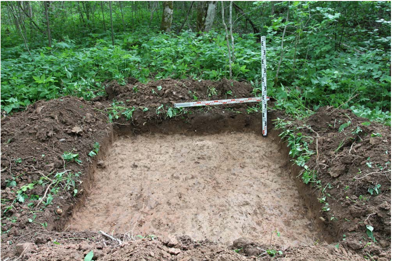
Рис. 64. Ленинградская область, Бокситогорский район. «Межпоселковый газопровод от ГРС Пикалево до д. Анисимово Бокситогорского района Ленинградской области». Шурф 11. Общий вид. Вид с юга
