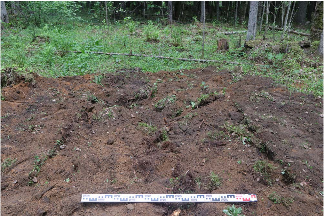
Рис. 106. Ленинградская область, Бокситогорский район. «Межпоселковый газопровод от ГРС Пикалево до д. Анисимово Бокситогорского района Ленинградской области». Шурф 21. Рекультивация. Вид с юга
