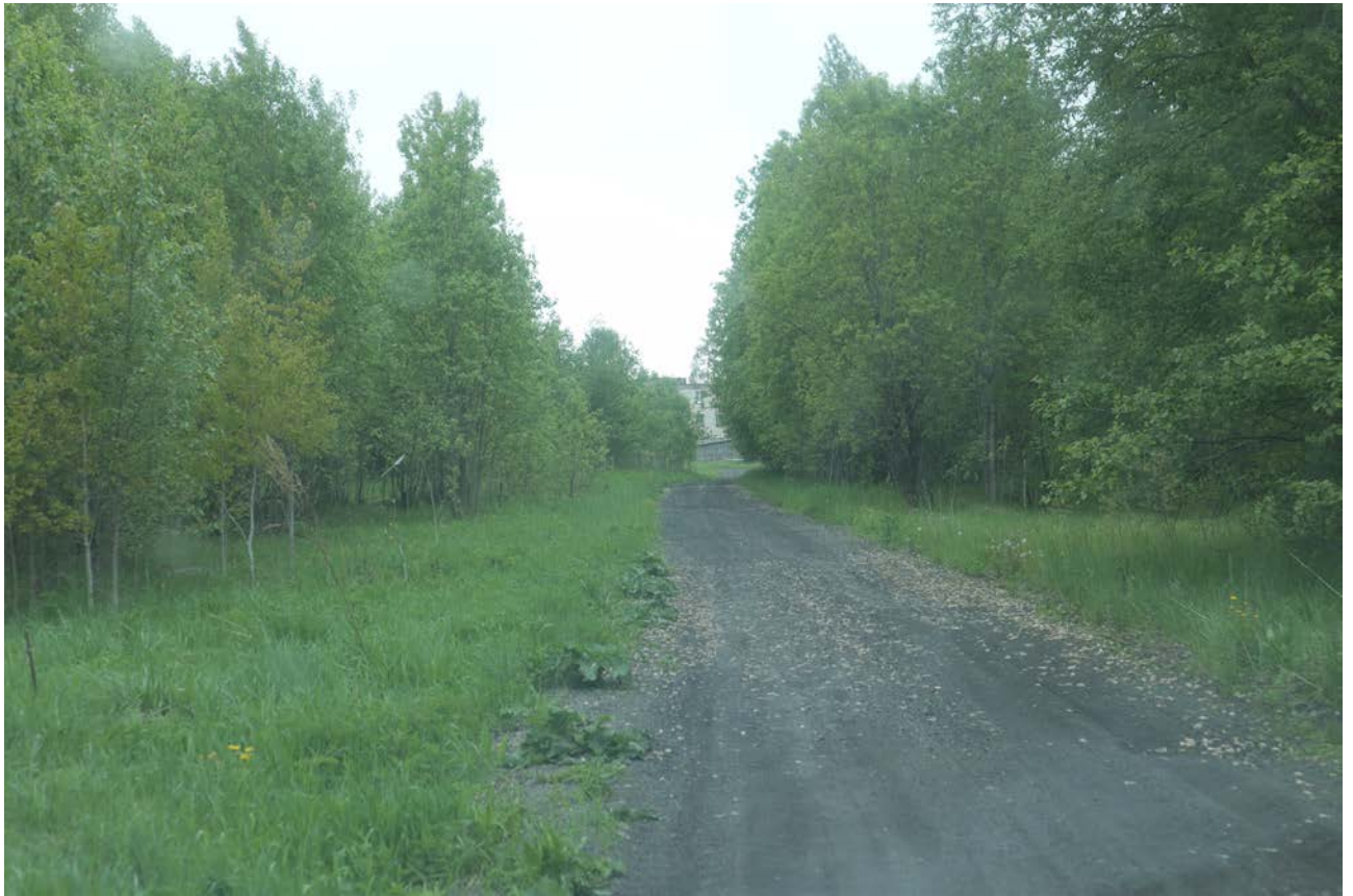
Рис. 134. Ленинградская область, Бокситогорский район. «Межпоселковый газопровод от ГРС Пикалево до д. Анисимово Бокситогорского района Ленинградской области». Финальная точка трассы обследования в д. Анисимово. Вид с востока
