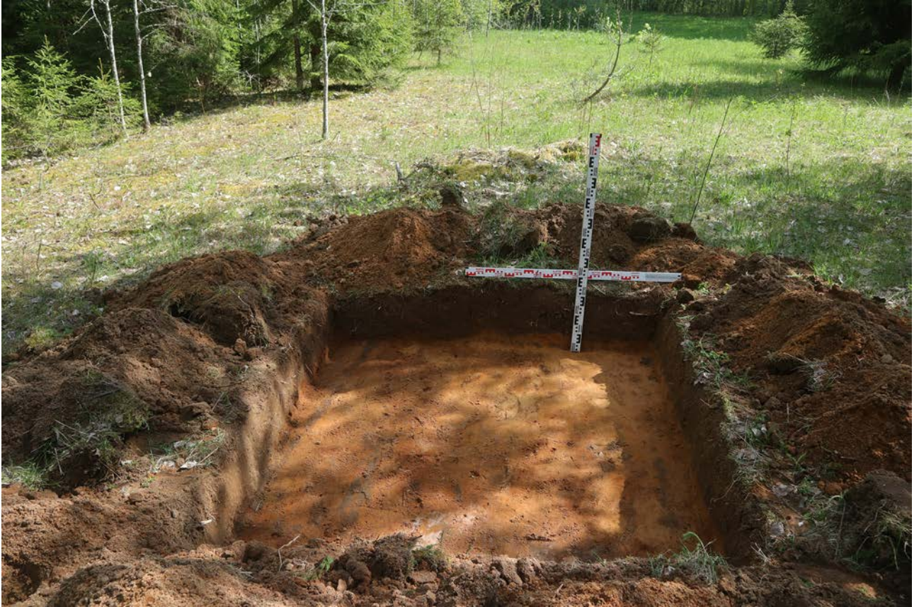
Рис. 96. Ленинградская область, Бокситогорский район. «Межпоселковый газопровод от ГРС Пикалево до д. Анисимово Бокситогорского района Ленинградской области». Шурф 19. Общий вид. Вид с юга
