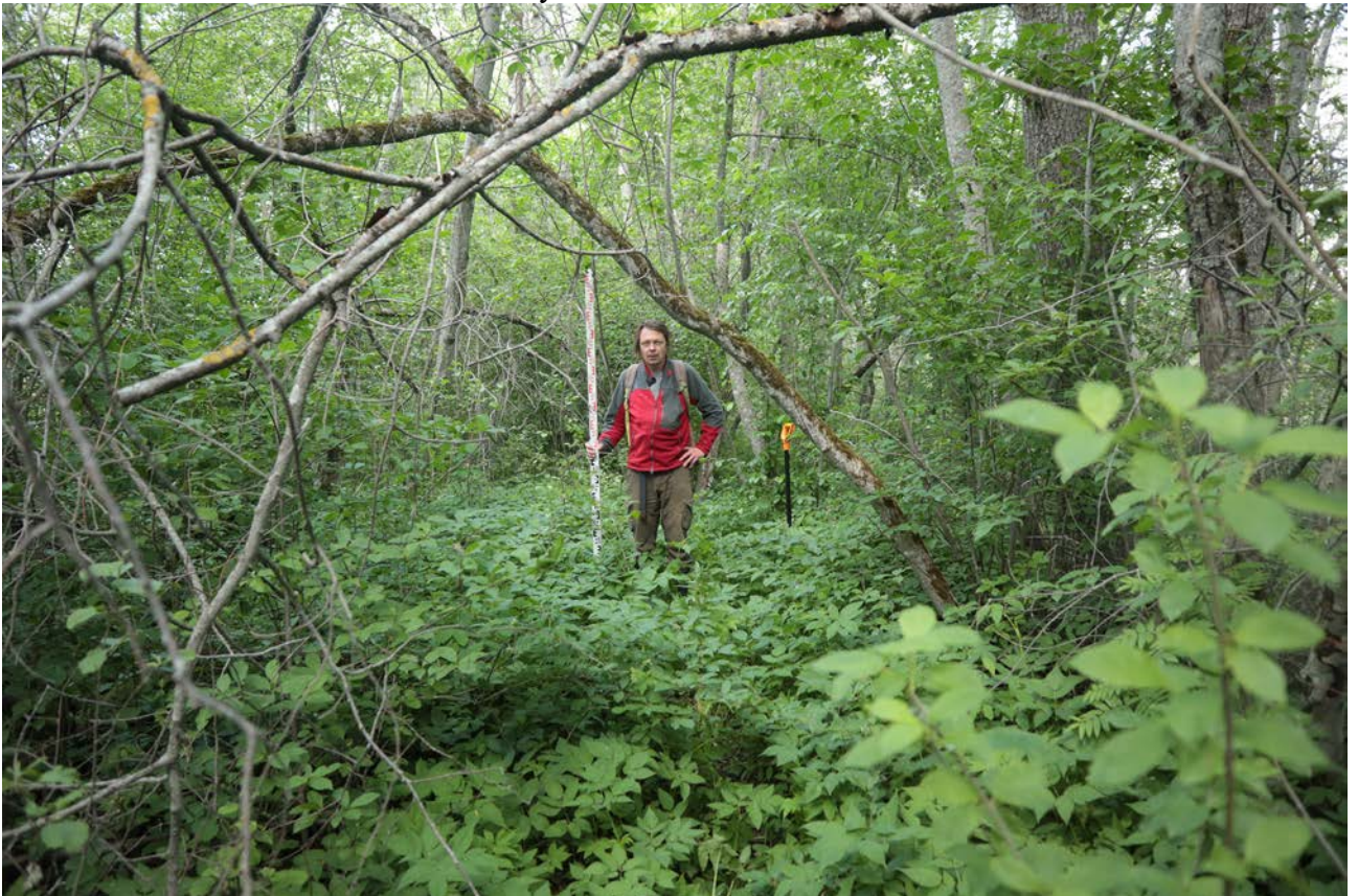
Рис. 71. Ленинградская область, Бокситогорский район. «Межпоселковый газопровод от ГРС Пикалево до д. Анисимово Бокситогорского района Ленинградской области». Шурф 13. Общий вид до начала работ. Вид с юга
