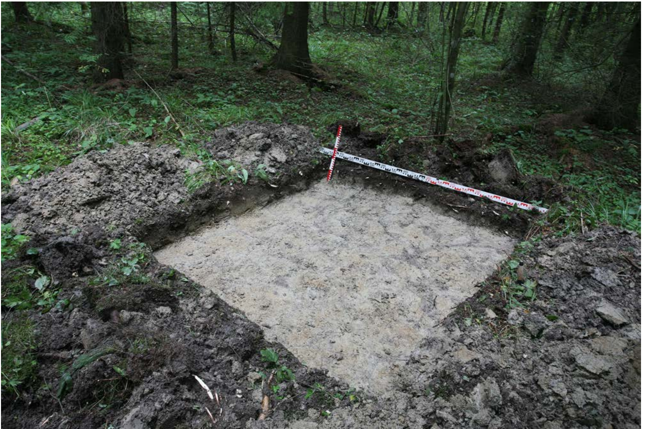
Рис. 112. Ленинградская область, Бокситогорский район. «Межпоселковый газопровод от ГРС Пикалево до д. Анисимово Бокситогорского района Ленинградской области». Шурф 22. Общий вид. Вид с юга
