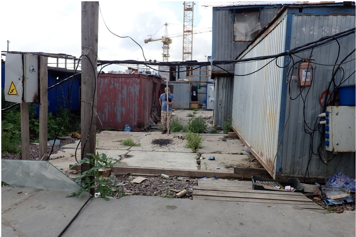
Рис. 27. Ленинградская область. Всеволожский район. Поселок Бугры. Земельный участок с кадастровым номером 47:07:0713003:913. Точка фотофиксации 6. Общий вид восточной части участка. Вид с С.
