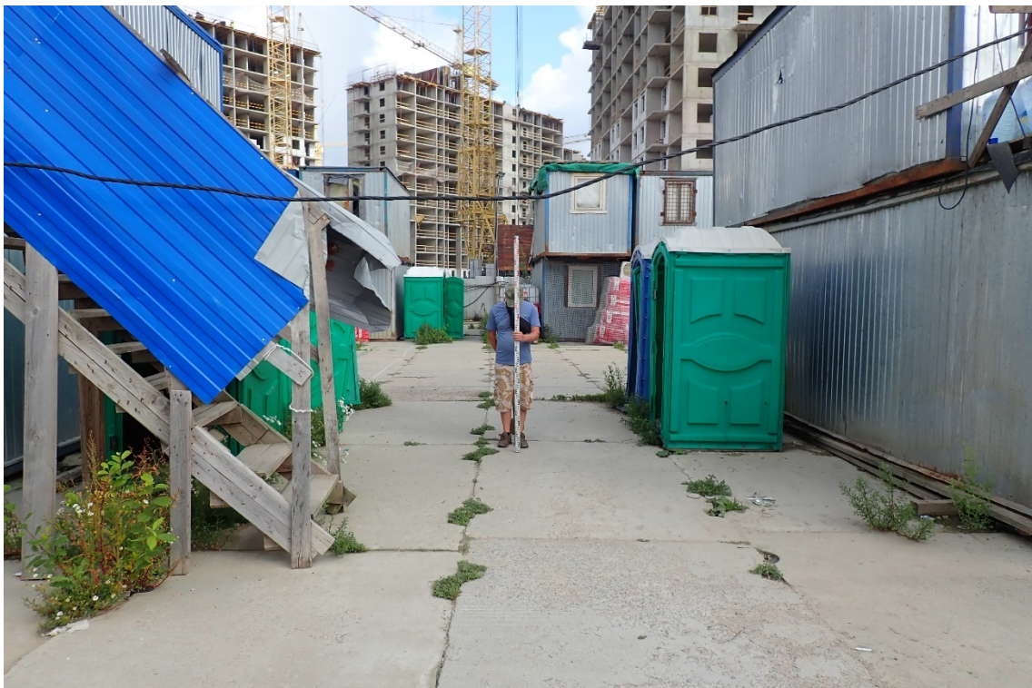
Рис. 26. Ленинградская область. Всеволожский район. Поселок Бугры. Земельный участок с кадастровым номером 47:07:0713003:913. Точка фотофиксации 5. Общий вид юго-восточной части участка. Вид с Ю.
