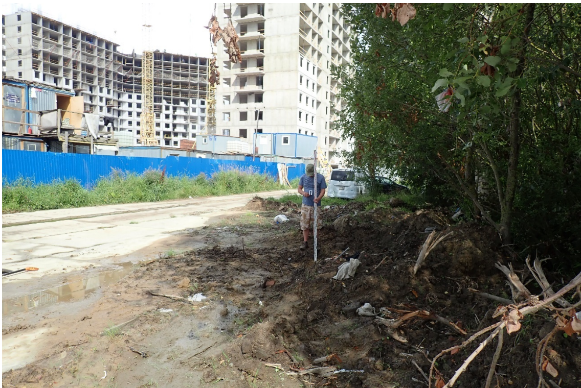
Рис. 32. Ленинградская область. Всеволожский район. Поселок Бугры. Земельный участок с кадастровым номером 47:07:0713003:913. Шурф 1. Месторасположение. Вид с Ю.
