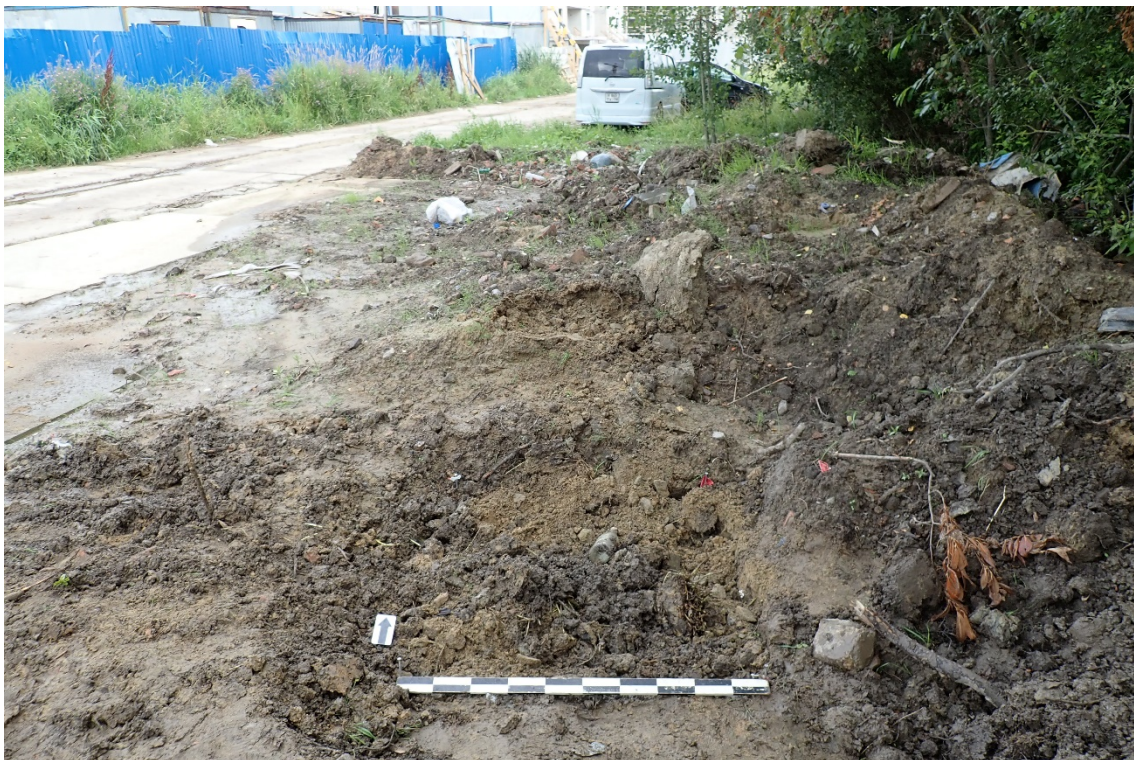
Рис. 37. Ленинградская область. Всеволожский район. Поселок Бугры. Земельный участок с кадастровым номером 47:07:0713003:913. Шурф 1. После рекультивации. Вид с Ю.
