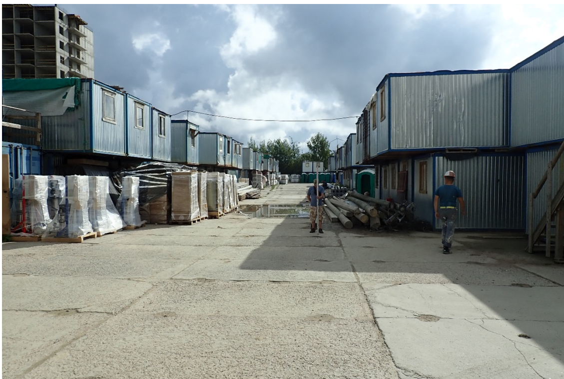
Рис. 14. Ленинградская область. Всеволожский район. Поселок Бугры. Земельный участок с кадастровым номером 47:07:0713003:913. Точка фотофиксации 1. Общий вид северо-западной части участка. Вид с З.
