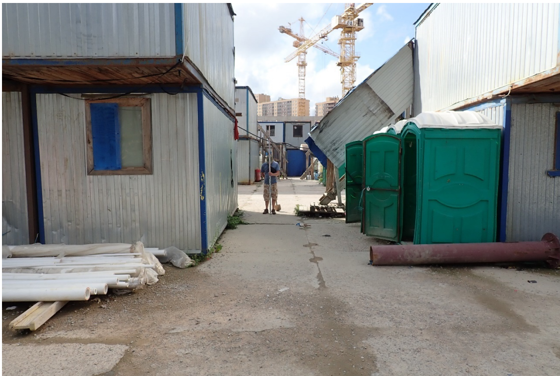
Рис. 15. Ленинградская область. Всеволожский район. Поселок Бугры. Земельный участок с кадастровым номером 47:07:0713003:913. Точка фотофиксации 2. Общий вид юго-восточной части участка. Вид с С.
