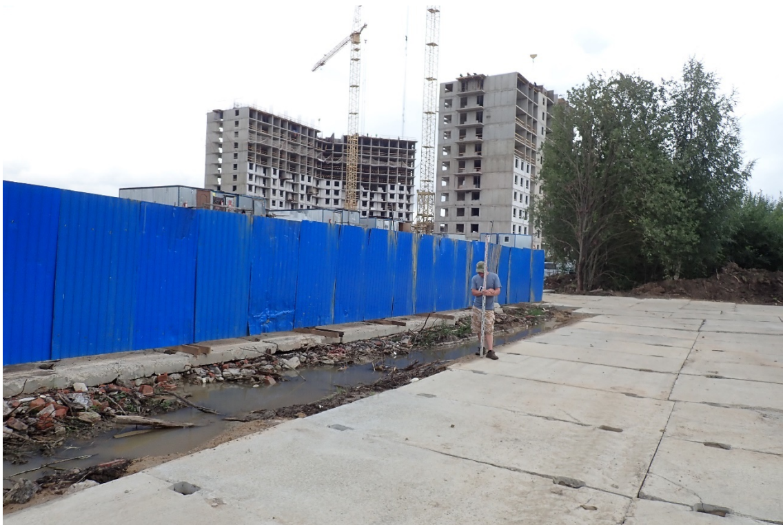
Рис. 31. Ленинградская область. Всеволожский район. Поселок Бугры. Земельный участок с кадастровым номером 47:07:0713003:913. Точка фотофиксации 10. Забор и дренажная канава в восточной части участка. Вид с ЮВ.
