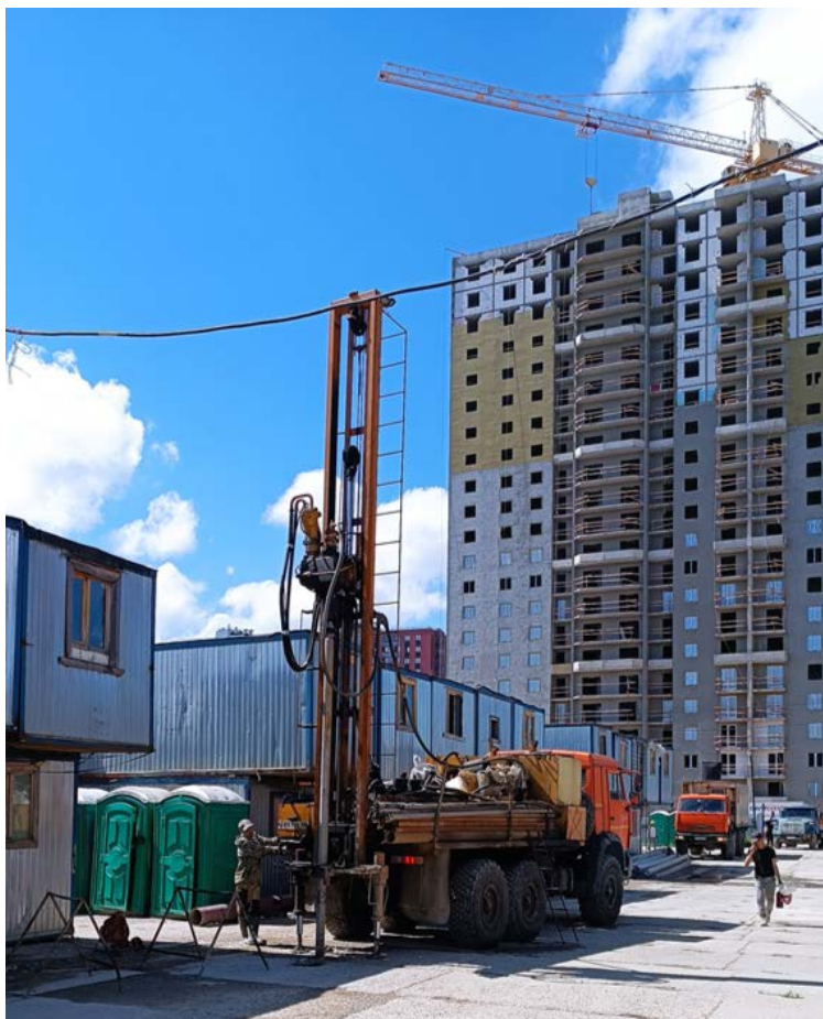
Рисунок 4.1.1 - Бурение скважины на участке изысканий 2024 г. (фотофиксация)
