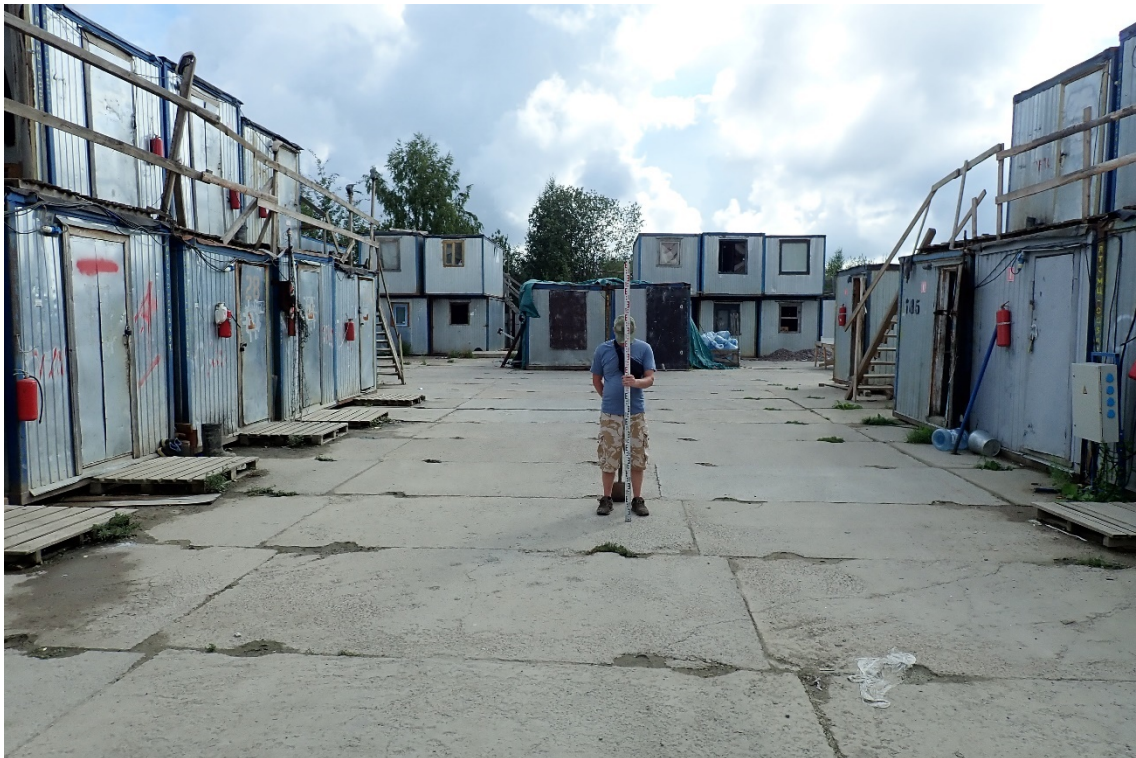
Рис. 24. Ленинградская область. Всеволожский район. Поселок Бугры. Земельный участок с кадастровым номером 47:07:0713003:913. Точка фотофиксации 5. Общий вид юго-восточной части участка. Вид с З.
