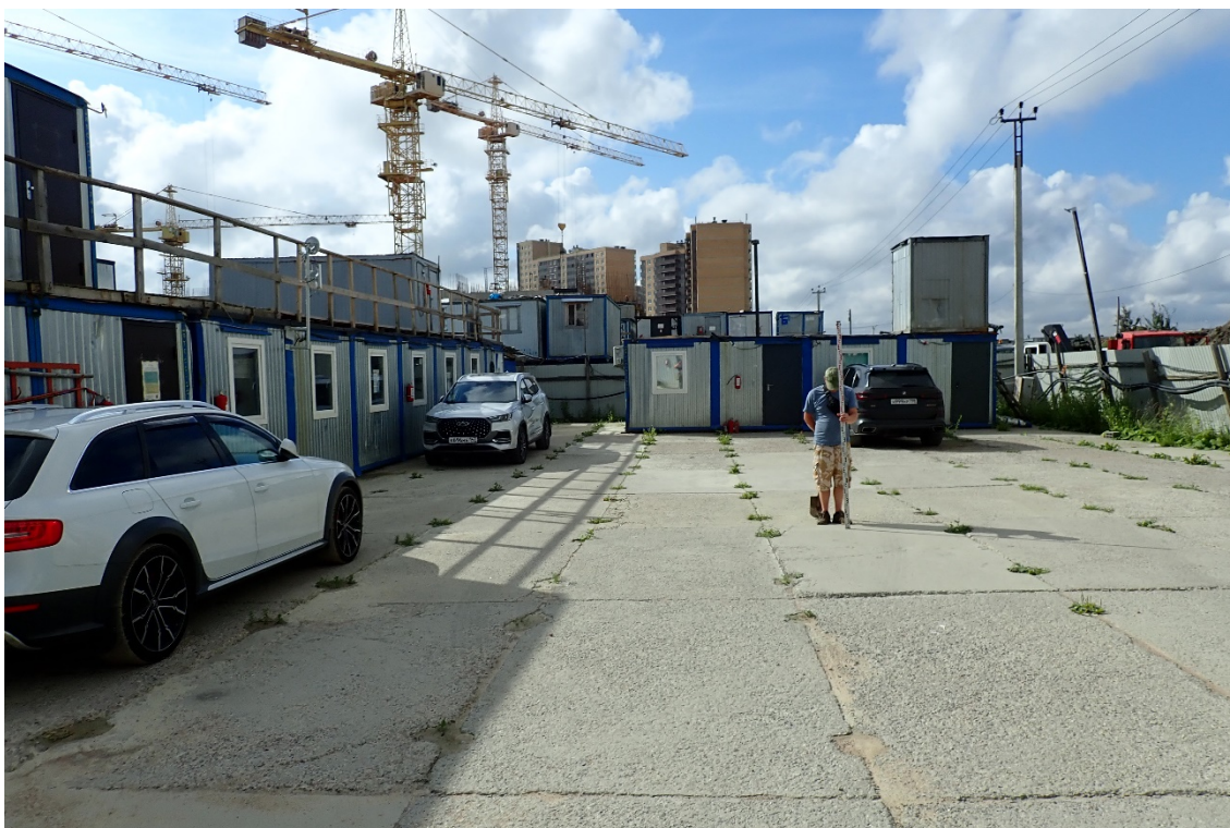
Рис. 13. Ленинградская область. Всеволожский район. Поселок Бугры. Земельный участок с кадастровым номером 47:07:0713003:913. Точка фотофиксации 1. Общий вид северо-западной части участка. Вид с С.
