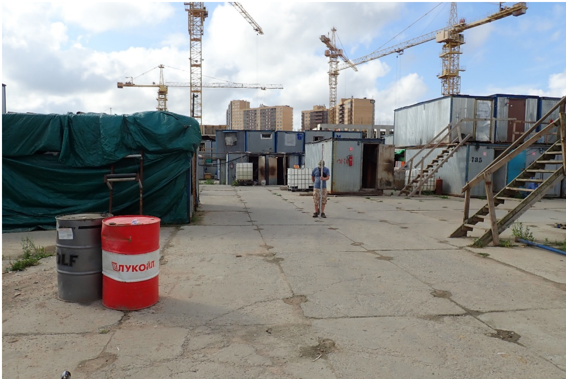
Рис. 23. Ленинградская область. Всеволожский район. Поселок Бугры. Земельный участок с кадастровым номером 47:07:0713003:913. Точка фотофиксации 4. Общий вид юго-восточной части участка. Вид с С.
