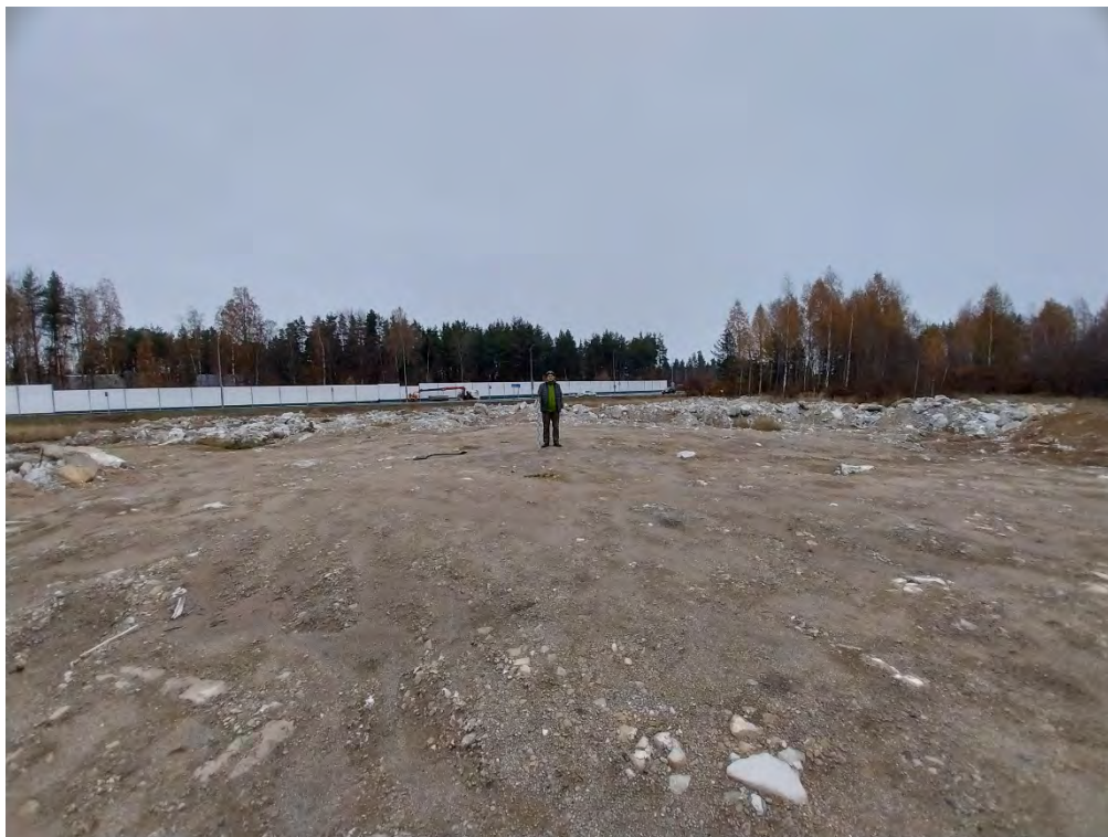
Рис. 18. «Газоперерабатывающий комплекс в составе комплекса переработки этансодержащего газа в районе пос. Усть-Луга. Этап 10. Путепроводная развязка». Точка фотофиксации 5. Вид с юга.
