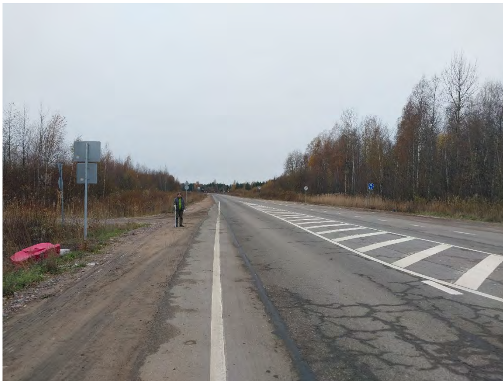
Рис. 20. «Газоперерабатывающий комплекс в составе комплекса переработки этансодержащего газа в районе пос. Усть-Луга. Этап 10. Путепроводная развязка». Точка фотофиксации 7. Конец маршрута обследования. Вид с востока.
