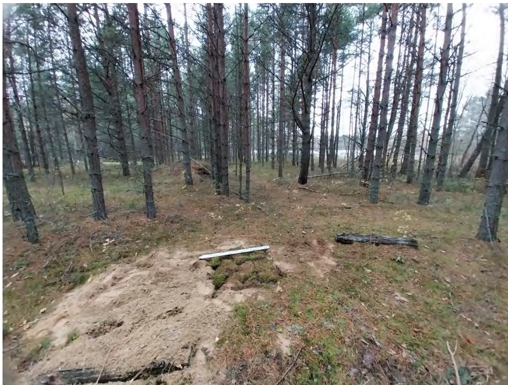
Рис. 16. «Газоперерабатывающий комплекс в составе комплекса переработки этансодержащего газа в районе пос. Усть-Луга. Этап 10. Путепроводная развязка». Шурф 1. Рекультивация. Вид с востока. В качестве масштаба использована линейка длиной 1 м.
