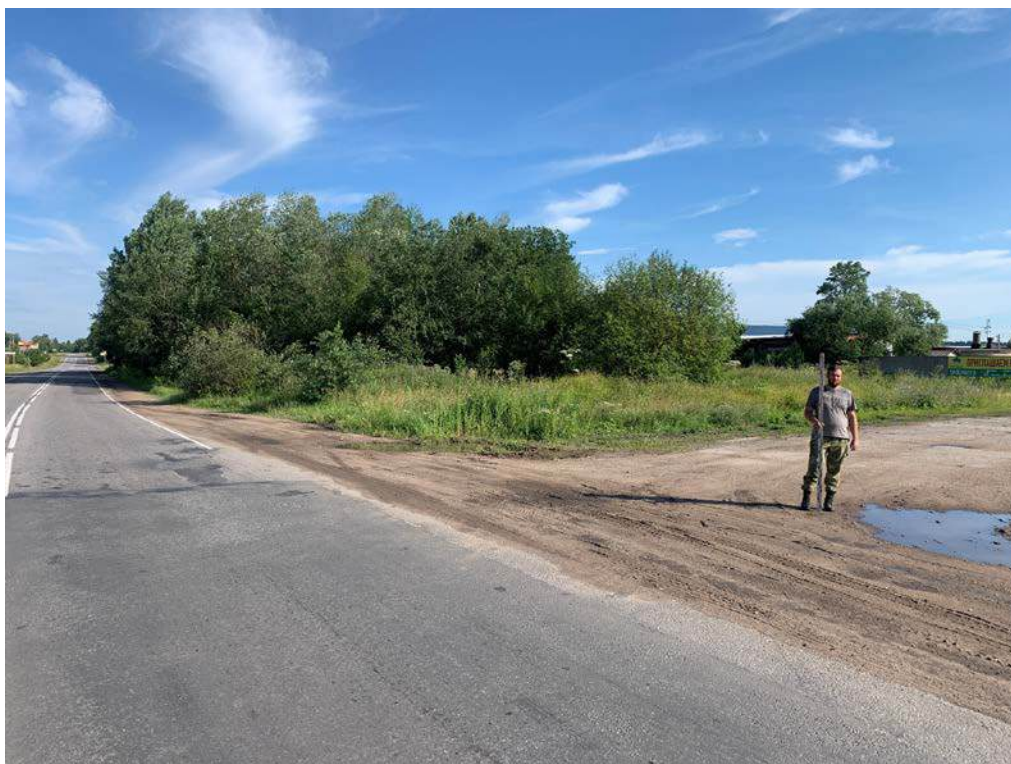
Илл. 19. Ленинградская область, Гатчинский округ, Пудостьское сельское поселение – 2024 г. Точка фотофиксации №2. Вид с Ю.
