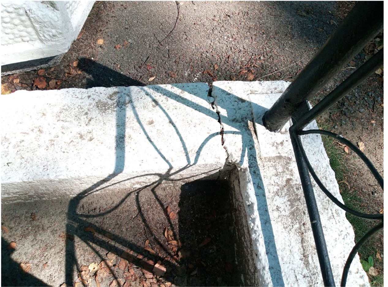
34. Трещины на цоколе ограды в северной части территории.
