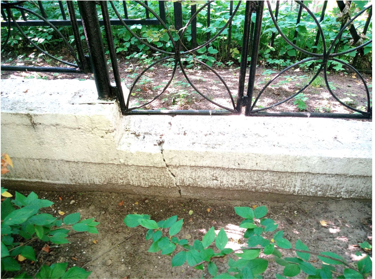
37. Сквозные трещины на цоколе ограды вдоль юго-западной границы территории.
