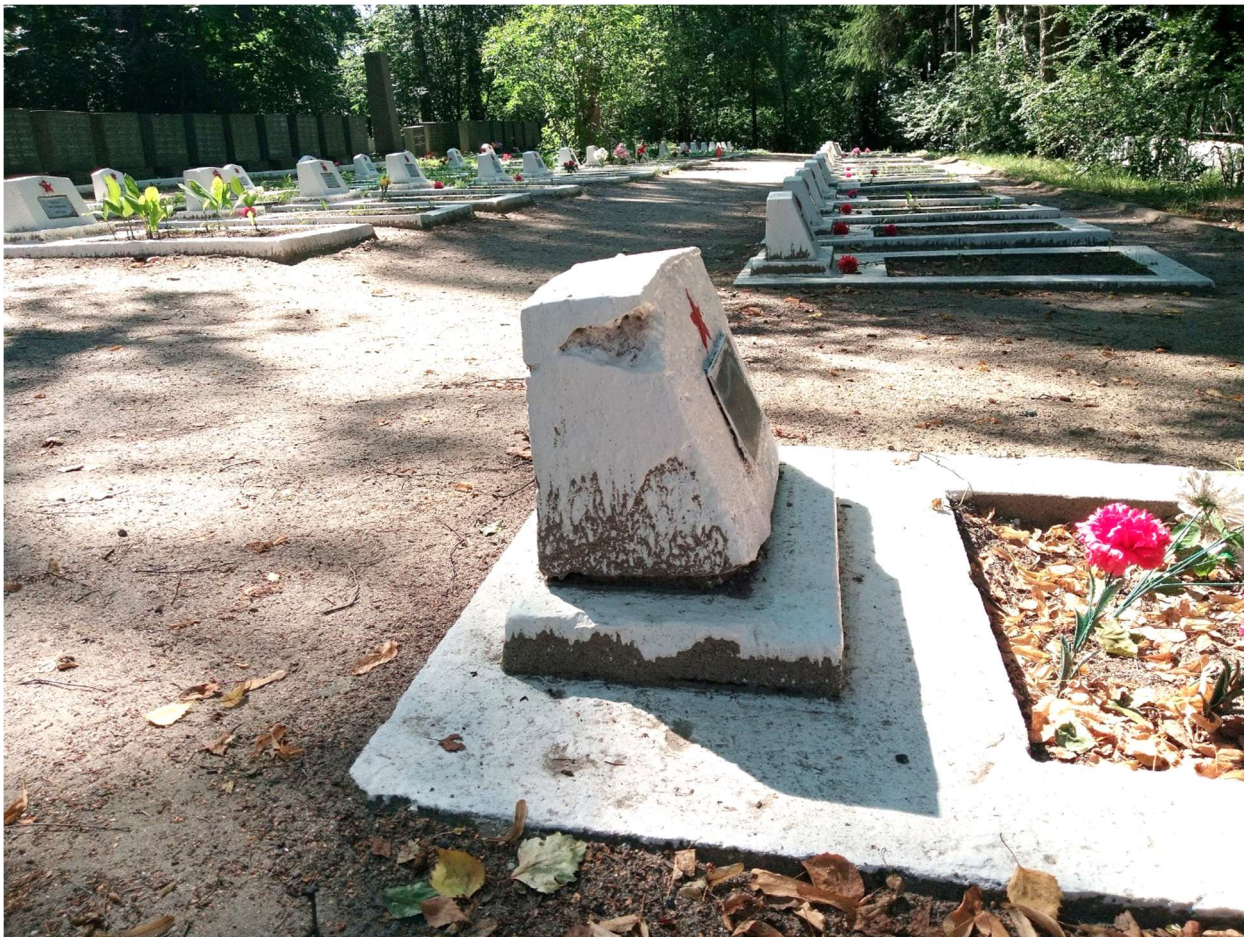
33. Индивидуальная могила с утраченным фрагментом изголовья и многослойным неравномерным окрашиванием.
