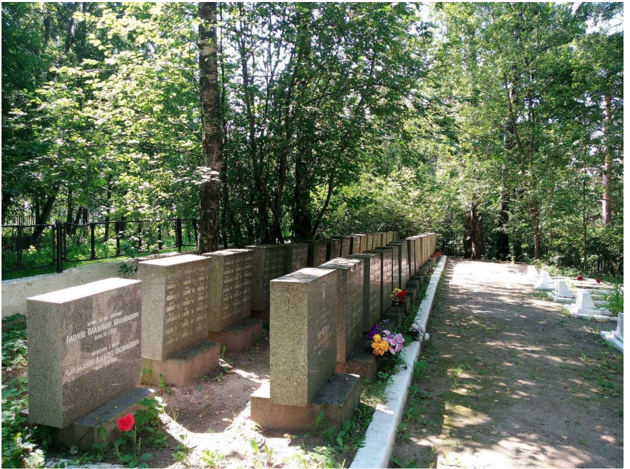
18. Плиты братских захоронений в южной части кладбища. Гранитные блоки имеют крены и смещения.
