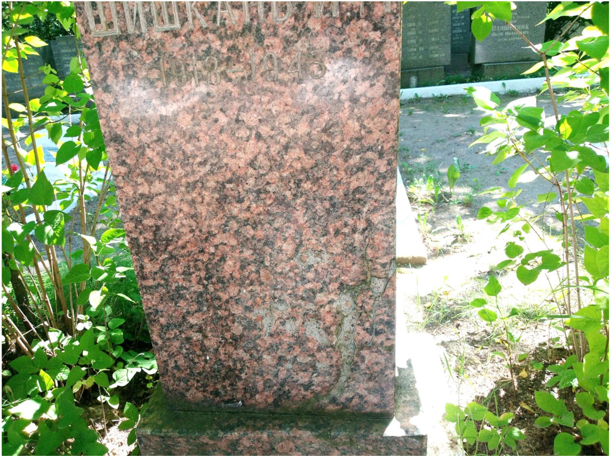
23. Биопоражения цоколя постамента, сколы гранита в нижней части постамента с цементными замазками.
