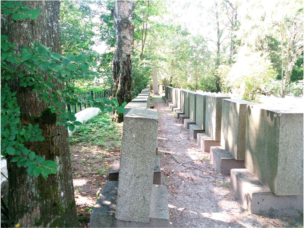
11. Плиты братских захоронений. Гранитные блоки накрены и смещены.
