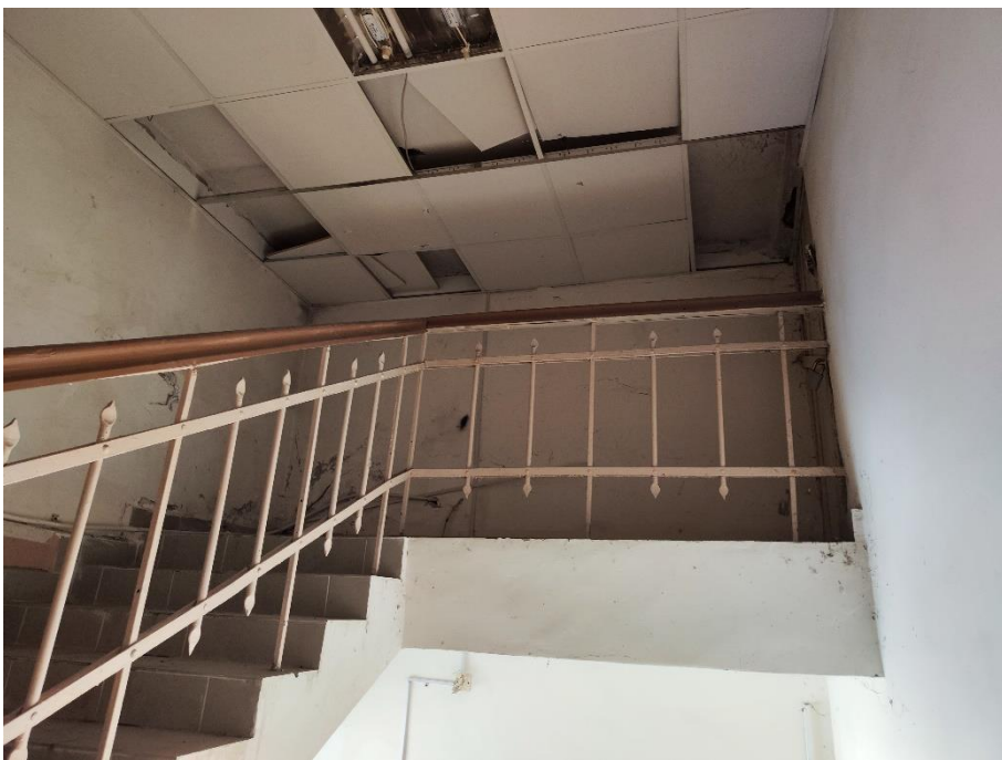
66. «Здание, где в июле-августе 1941 г. формировались Тосненские партизанские отряды для борьбы с фашистскими захватчиками. На здании установлена памятная доска», Ленинградская область, г. Тосно, пр. Ленина, д.50. Второй этаж. Помещение №30. Общий вид. Фото 31.05.2024г.
