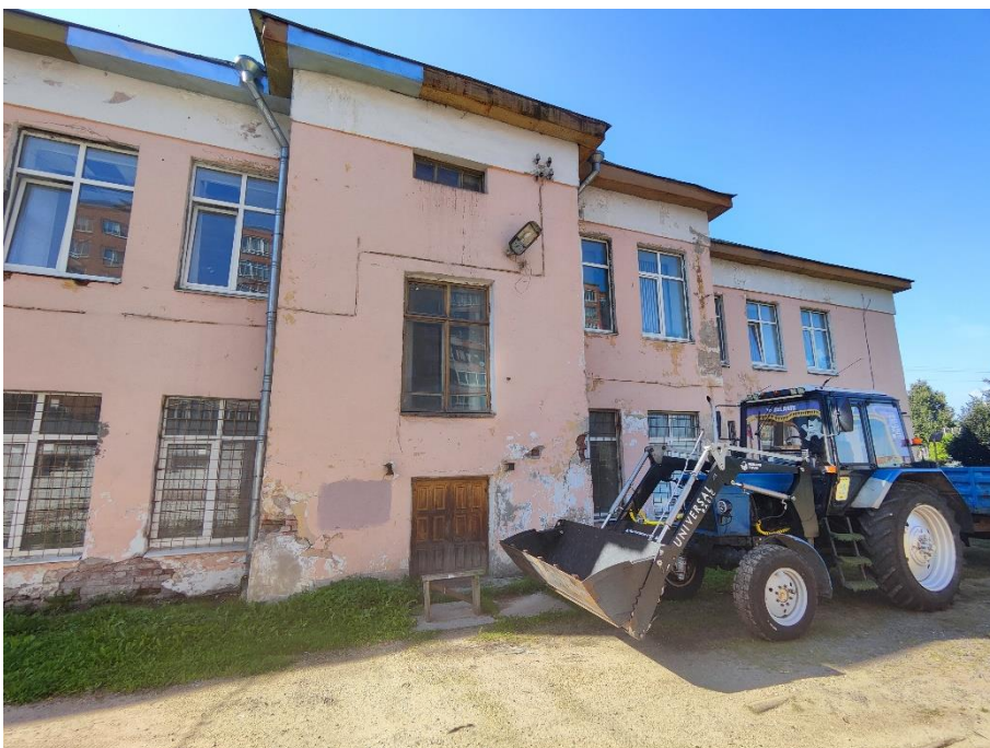
13. «Здание, где в июле-августе 1941 г. формировались Тосненские партизанские отряды для борьбы с фашистскими захватчиками. На здании установлена памятная доска», Ленинградская область, г. Тосно, пр. Ленина, д.50. Северо-восточный фасад. Фрагмент. Фото 31.05.2024г.
