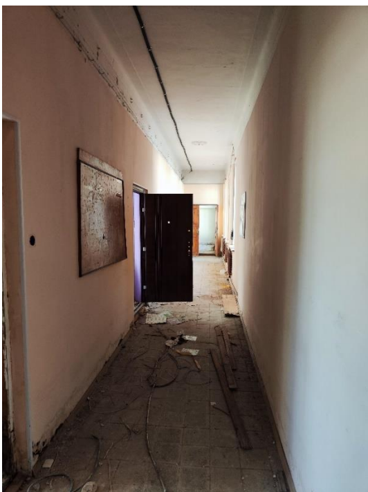
35. «Здание, где в июле-августе 1941 г. формировались Тосненские партизанские отряды для борьбы с фашистскими захватчиками. На здании установлена памятная доска», Ленинградская область, г. Тосно, пр. Ленина, д.50. Первый этаж. Помещение №29. Общий вид. Фото 31.05.2024г.
