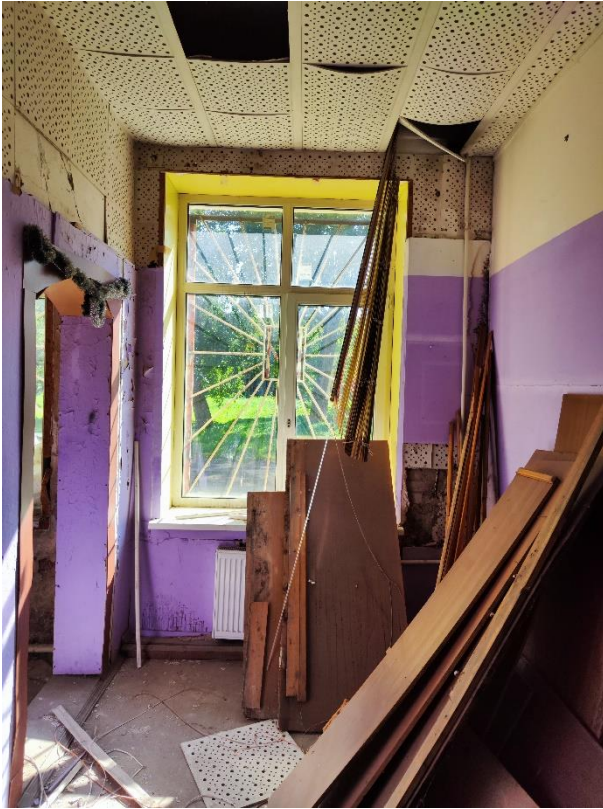
37. «Здание, где в июле-августе 1941 г. формировались Тосненские партизанские отряды для борьбы с фашистскими захватчиками. На здании установлена памятная доска», Ленинградская область, г. Тосно, пр. Ленина, д.50. Первый этаж. Помещение №31. Общий вид. Фото 31.05.2024г.
