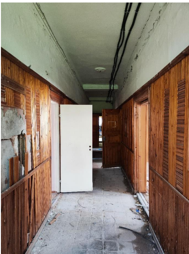
34. «Здание, где в июле-августе 1941 г. формировались Тосненские партизанские отряды для борьбы с фашистскими захватчиками. На здании установлена памятная доска», Ленинградская область, г. Тосно, пр. Ленина, д.50. Первый этаж. Помещение №29. Общий вид. Фото 31.05.2024г.
