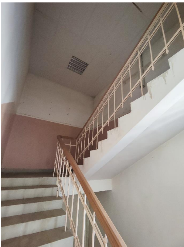
65. «Здание, где в июле-августе 1941 г. формировались Тосненские партизанские отряды для борьбы с фашистскими захватчиками. На здании установлена памятная доска», Ленинградская область, г. Тосно, пр. Ленина, д.50. Второй этаж. Помещение №30. Общий вид. Фото 31.05.2024г.
