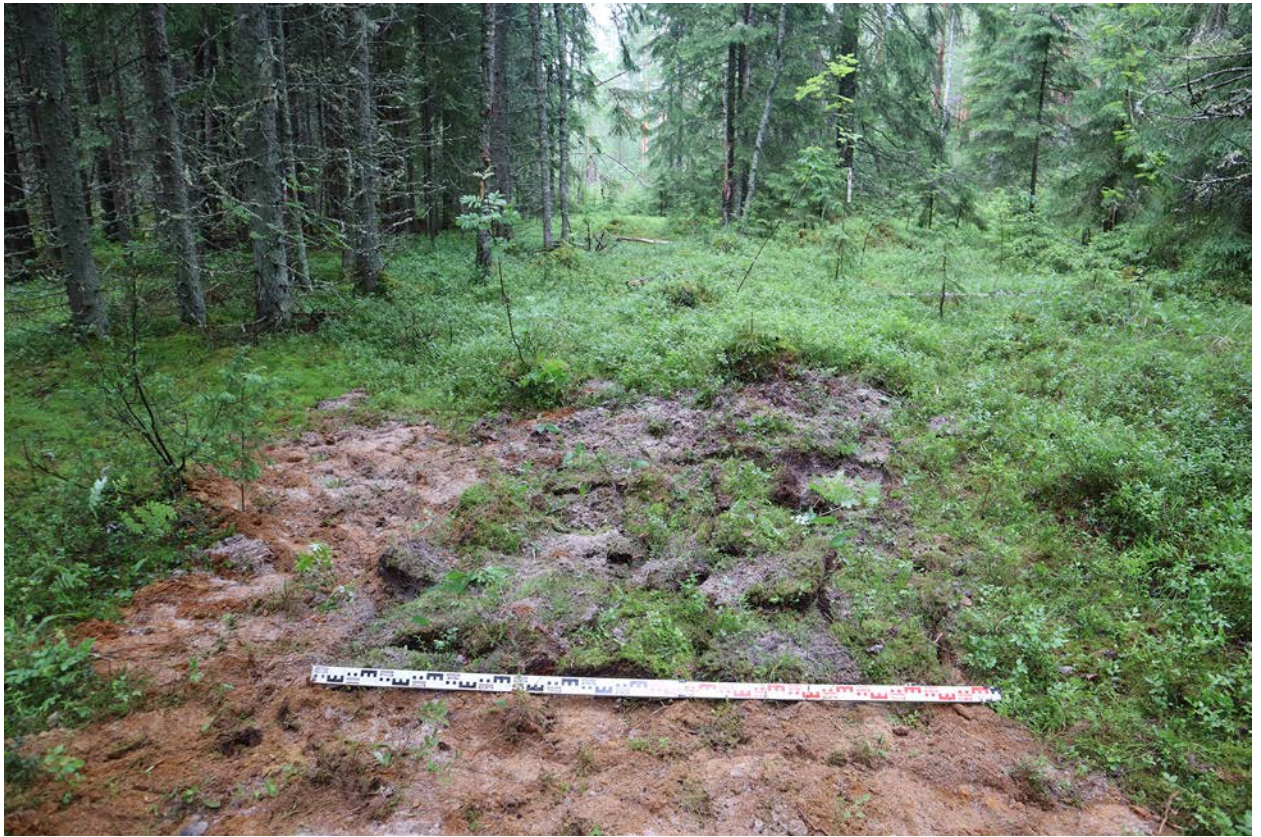
Рис. 70. Ленинградская область, Приозерский район. Газопровод межпоселковый от г. Приозерск к д. Бурнево, п. Кузнечное с отводом на п. Сторожевое Приозерского района Ленинградской области. Шурф 13. Рекультивация. Вид с юга.
