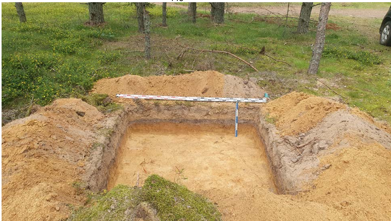
Рис. 88. Ленинградская область, Приозерский район. Газопровод межпоселковый от г. Приозерск к д. Бурнево, п. Кузнечное с отводом на п. Сторожевое Приозерского района Ленинградской области. Шурф 18. Общий вид. Вид с юга.
