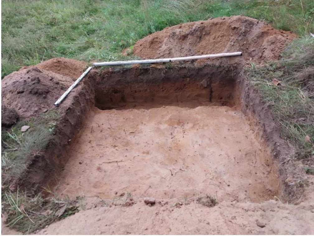
Рис. 20. Ленинградская область, Приозерский район. Газопровод межпоселковый от г. Приозерск к д. Бурнево, п. Кузнечное с отводом на п. Сторожевое Приозерского района Ленинградской области. Шурф 3. Общий вид. Вид с юга.
