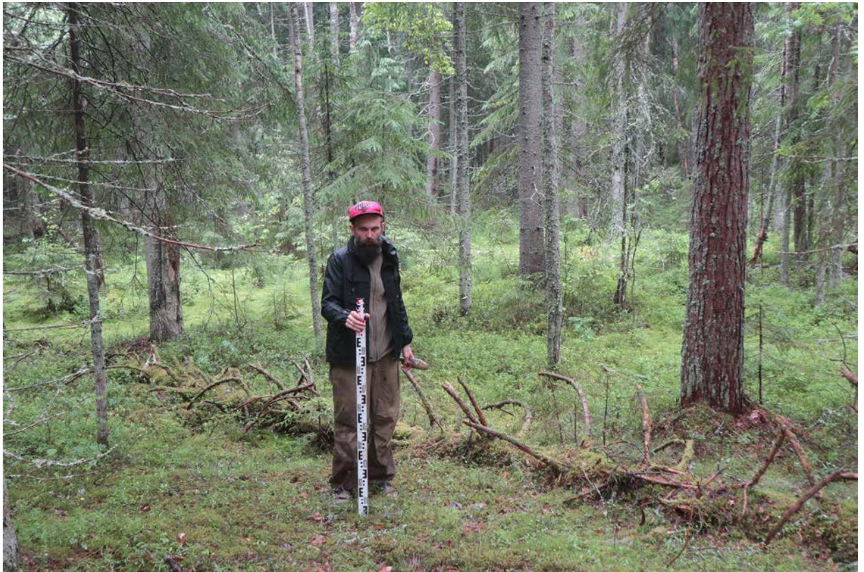
Рис. 63. Ленинградская область, Приозерский район. Газопровод межпоселковый от г. Приозерск к д. Бурнево, п. Кузнечное с отводом на п. Сторожевое Приозерского района Ленинградской области. Шурф 12. Общий вид до начала работ. Вид с юга.
