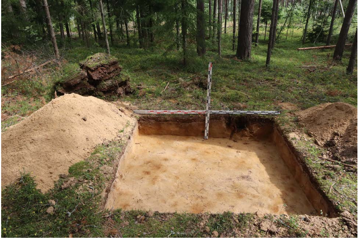
Рис. 80. Ленинградская область, Приозерский район. Газопровод межпоселковый от г. Приозерск к д. Бурнево, п. Кузнечное с отводом на п. Сторожевое Приозерского района Ленинградской области. Шурф 16. Общий вид. Вид с юга.
