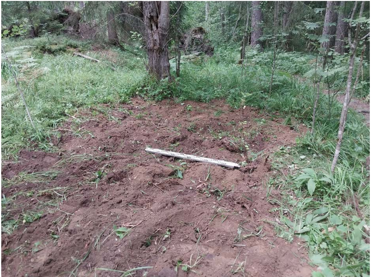
Рис. 34. Ленинградская область, Приозерский район. Газопровод межпоселковый от г. Приозерск к д. Бурнево, п. Кузнечное с отводом на п. Сторожевое Приозерского района Ленинградской области. Шурф 6. Рекультивация. Вид с юга.
