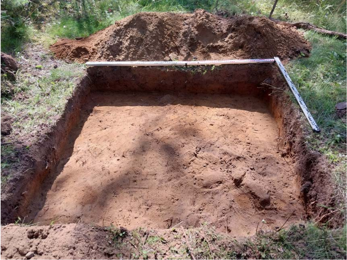
Рис. 104. Ленинградская область, Приозерский район. Газопровод межпоселковый от г. Приозерск к д. Бурнево, п. Кузнечное с отводом на п. Сторожевое Приозерского района Ленинградской области. Шурф 22. Общий вид. Вид с юга.
