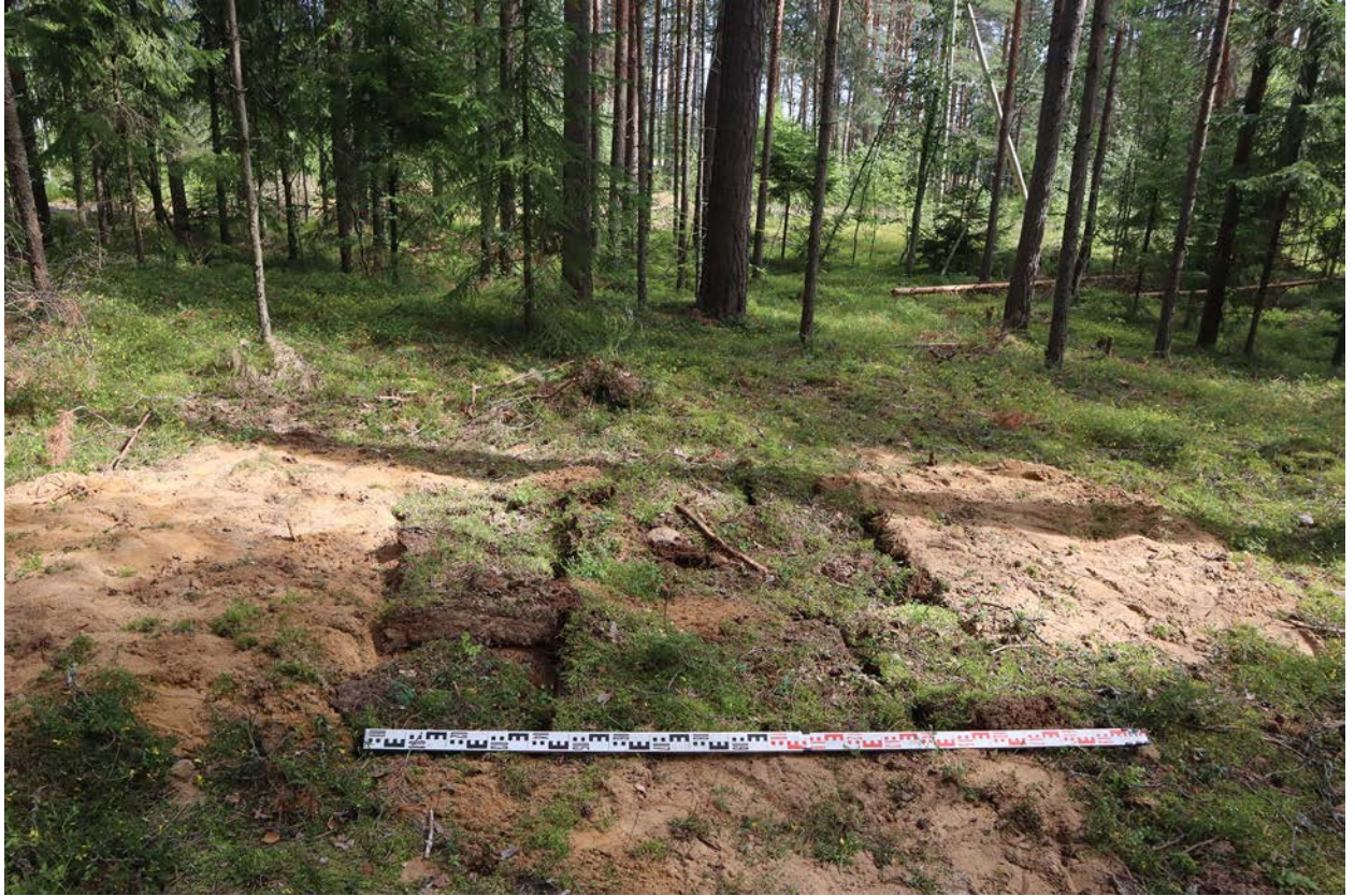
Рис. 82. Ленинградская область, Приозерский район. Газопровод межпоселковый от г. Приозерск к д. Бурнево, п. Кузнечное с отводом на п. Сторожевое Приозерского района Ленинградской области. Шурф 16. Рекультивация. Вид с юга.
