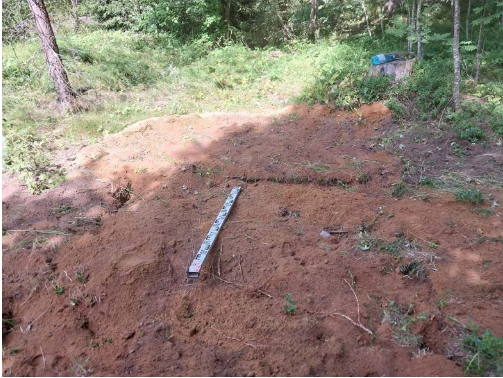
Рис. 94. Ленинградская область, Приозерский район. Газопровод межпоселковый от г. Приозерск к д. Бурнево, п. Кузнечное с отводом на п. Сторожевое Приозерского района Ленинградской области. Шурф 19. Рекультивация. Вид с юга.
