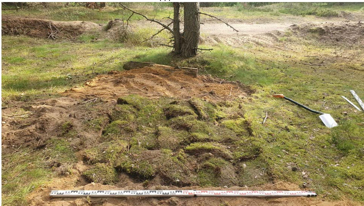
Рис. 86. Ленинградская область, Приозерский район. Газопровод межпоселковый от г. Приозерск к д. Бурнево, п. Кузнечное с отводом на п. Сторожевое Приозерского района Ленинградской области. Шурф 17. Рекультивация. Вид с юга.
