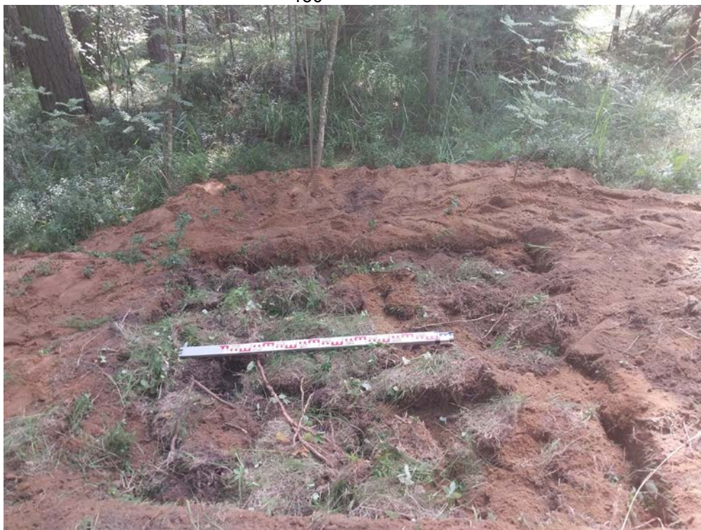
Рис. 98. Ленинградская область, Приозерский район. Газопровод межпоселковый от г. Приозерск к д. Бурнево, п. Кузнечное с отводом на п. Сторожевое Приозерского района Ленинградской области. Шурф 20. Рекультивация. Вид с юга.
