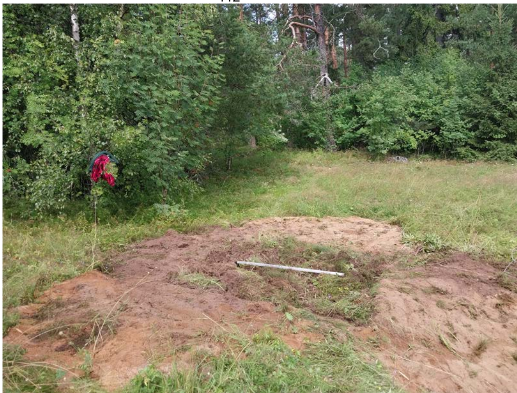
Рис. 22. Ленинградская область, Приозерский район. Газопровод межпоселковый от г. Приозерск к д. Бурнево, п. Кузнечное с отводом на п. Сторожевое Приозерского района Ленинградской области. Шурф 3. Рекультивация. Вид с юга.
