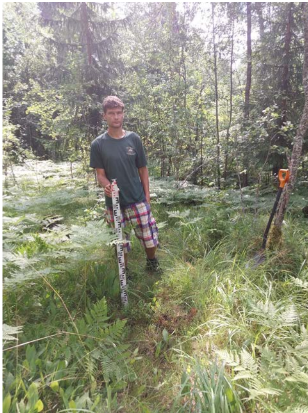
Рис. 15. Ленинградская область, Приозерский район. Газопровод межпоселковый от г. Приозерск к д. Бурнево, п. Кузнечное с отводом на п. Сторожевое Приозерского района Ленинградской области. Шурф 2. Общий вид до начала работ. Вид с юга.
