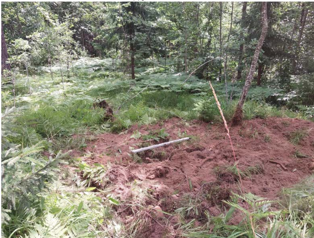
Рис. 18. Ленинградская область, Приозерский район. Газопровод межпоселковый от г. Приозерск к д. Бурнево, п. Кузнечное с отводом на п. Сторожевое Приозерского района Ленинградской области. Шурф 2. Рекультивация. Вид с юга.
