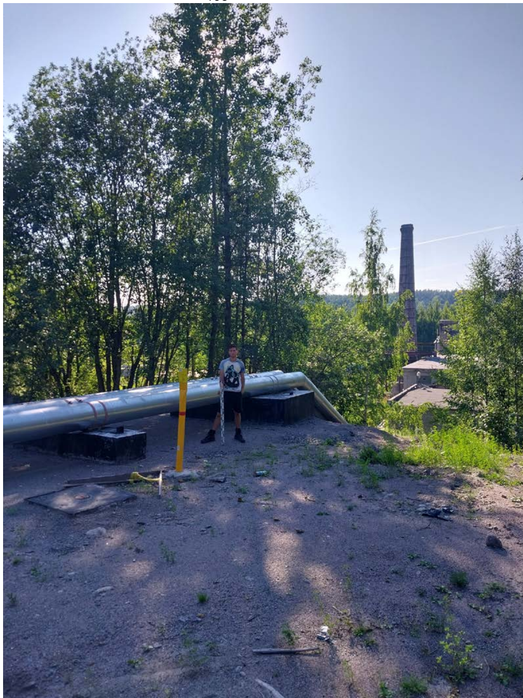
Рис. 5. Ленинградская область, Приозерский район. Газопровод межпоселковый от г. Приозерск к д. Бурнево, п. Кузнечное с отводом на п. Сторожевое Приозерского района Ленинградской области. Начало трасы проектируемого газопровода. Вид с востока.
