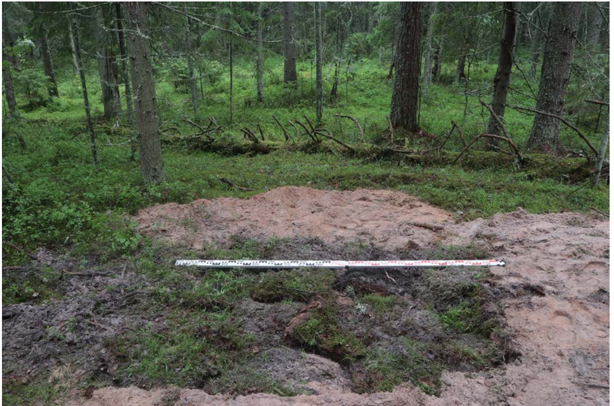
Рис. 66. Ленинградская область, Приозерский район. Газопровод межпоселковый от г. Приозерск к д. Бурнево, п. Кузнечное с отводом на п. Сторожевое Приозерского района Ленинградской области. Шурф 12. Рекультивация. Вид с юга.
