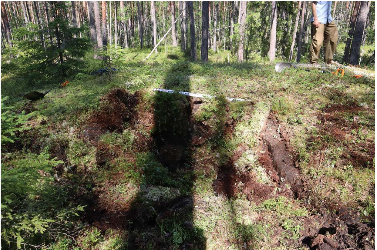
Рис. 54. Ленинградская область, Приозерский район. Газопровод межпоселковый от г. Приозерск к д. Бурнево, п. Кузнечное с отводом на п. Сторожевое Приозерского района Ленинградской области. Шурф 10. Рекультивация. Вид с юга.
