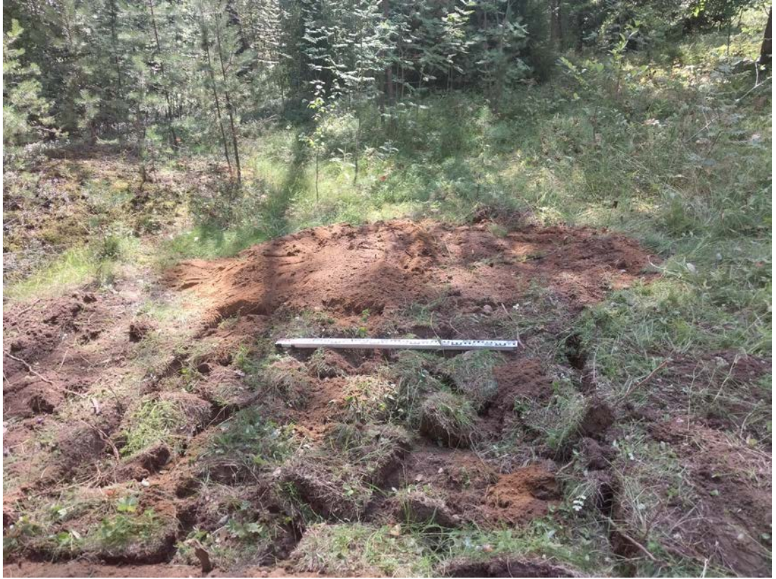
Рис. 106. Ленинградская область, Приозерский район. Газопровод межпоселковый от г. Приозерск к д. Бурнево, п. Кузнечное с отводом на п. Сторожевое Приозерского района Ленинградской области. Шурф 22. Рекультивация. Вид с юга.
