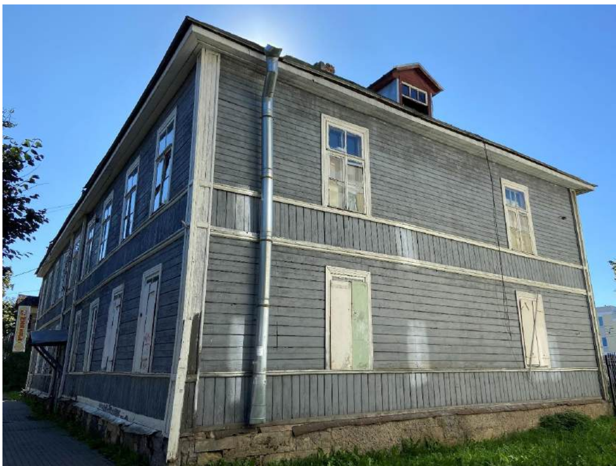
Фото 6. Торцевой фасад дома № 60 по улице Чкалова.
