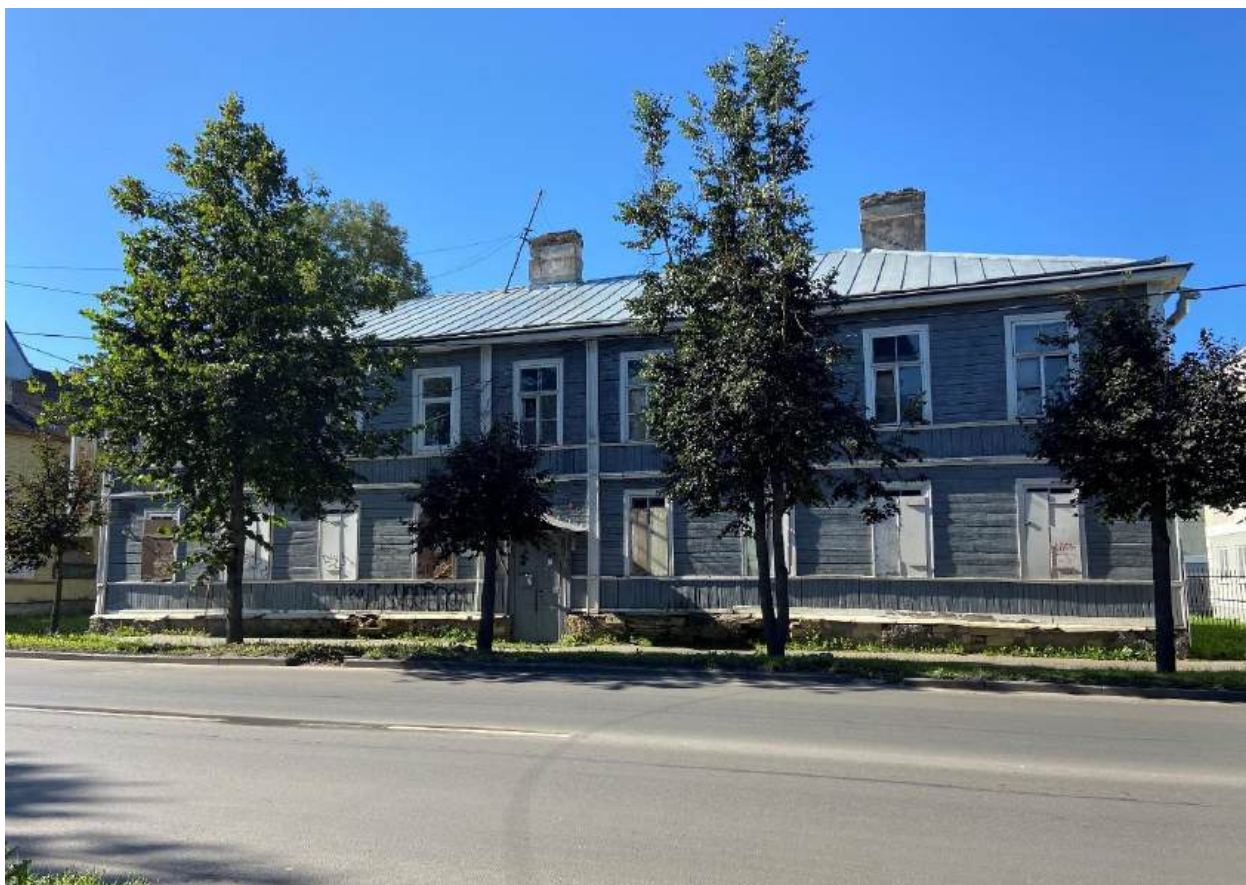
Фото 3. Лицевой фасад дома № 60 по улице Чкалова.
