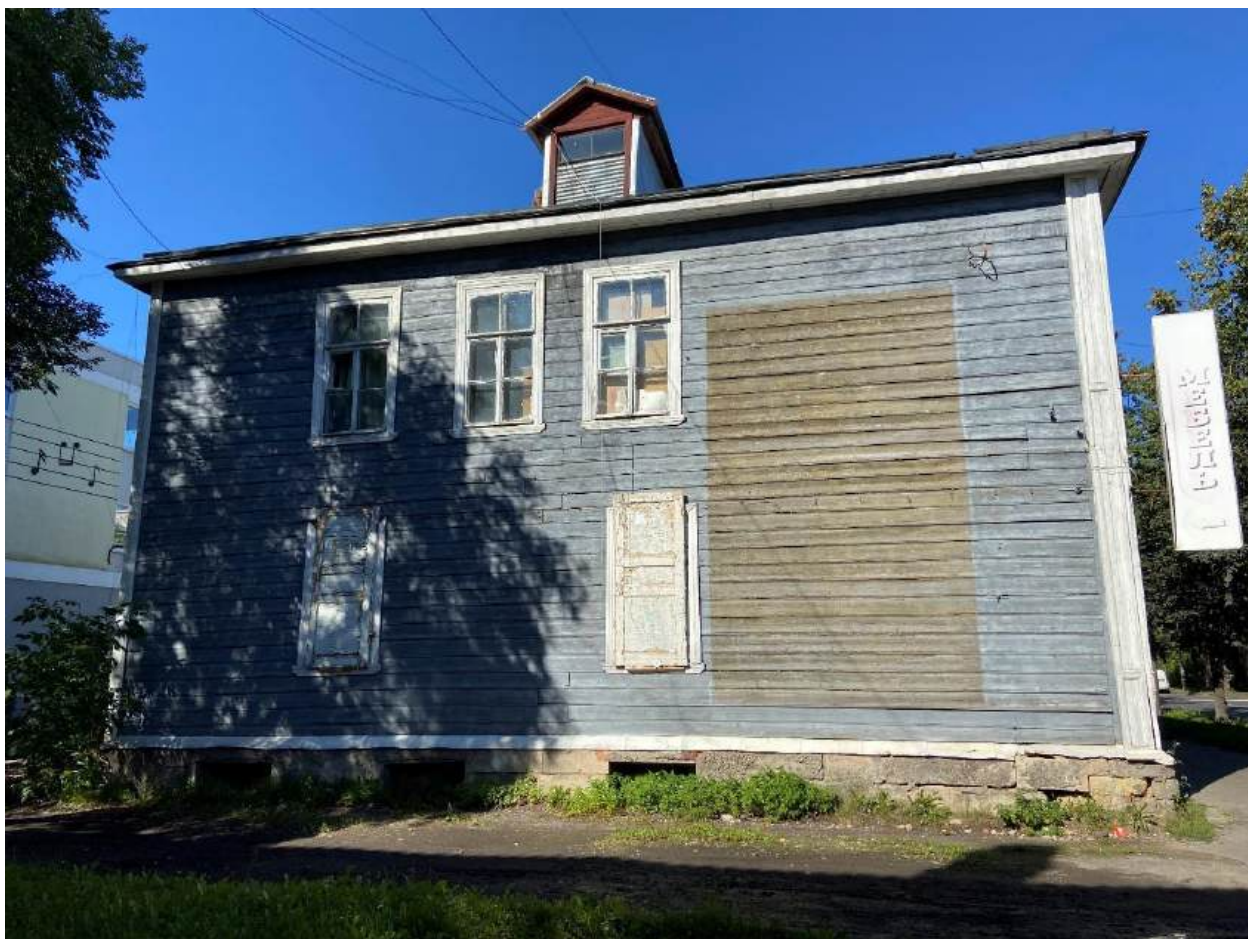
Фото 7. Торцевой фасад дома № 60 по улице Чкалова.
