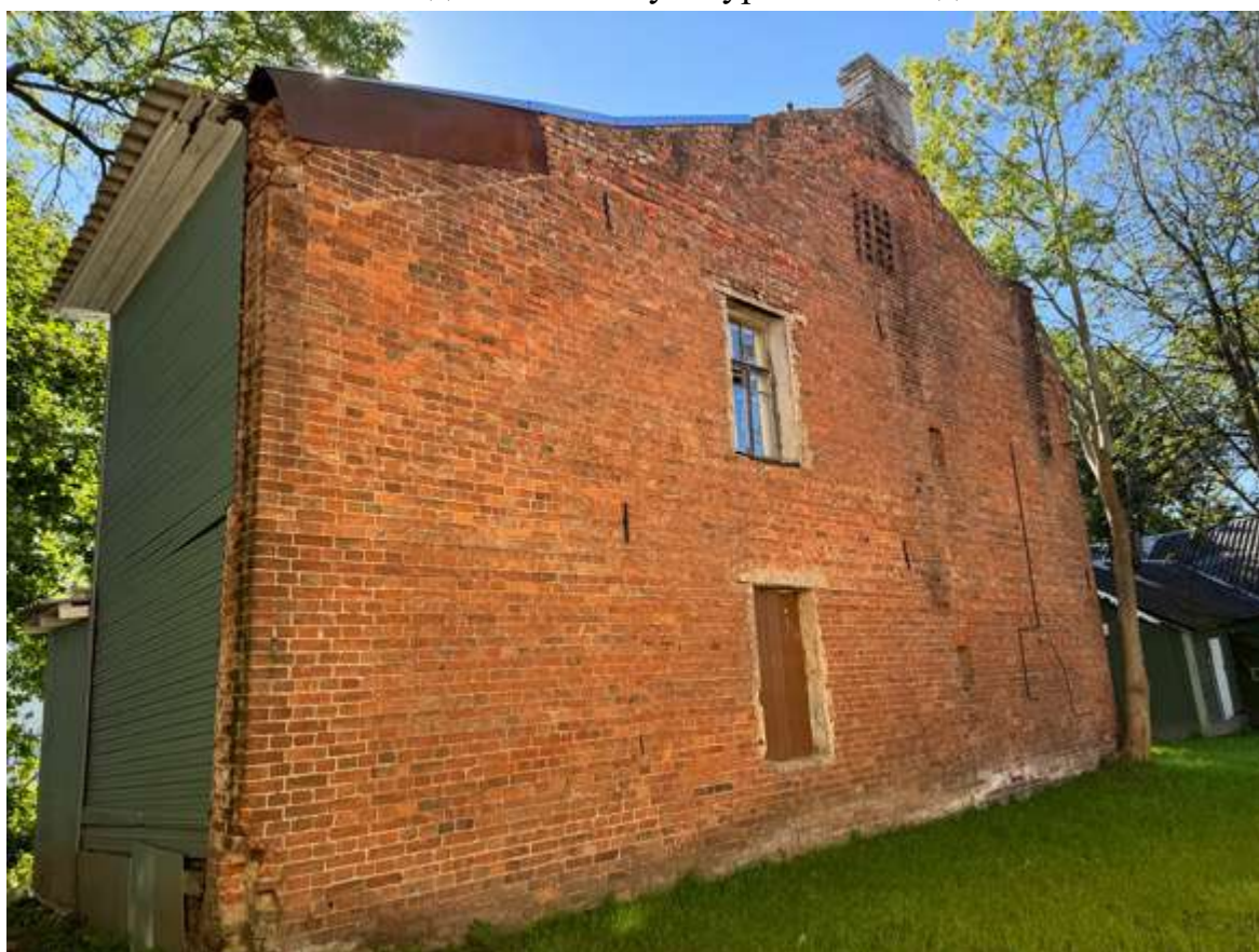
5. Вид на объект культурного наследия
