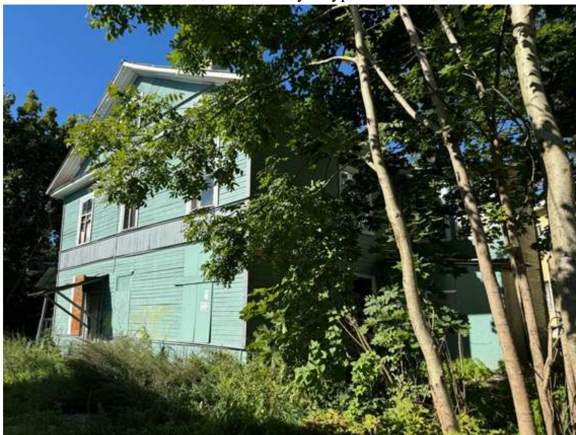
3. Вид на объект культурного наследия
