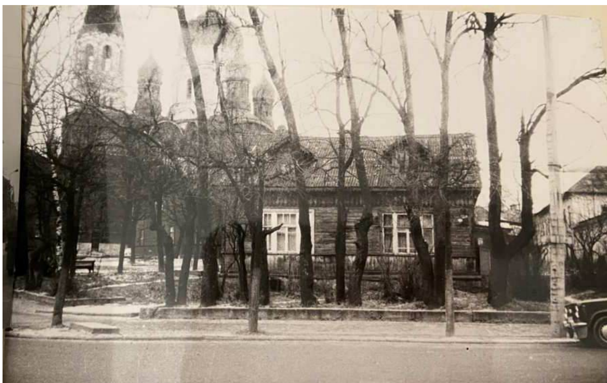
21. Дом № 75 по улице Чкалова, 1989 год – Архив комитета по сохранению культурного наследия Ленинградской области, дело: Н-4902
