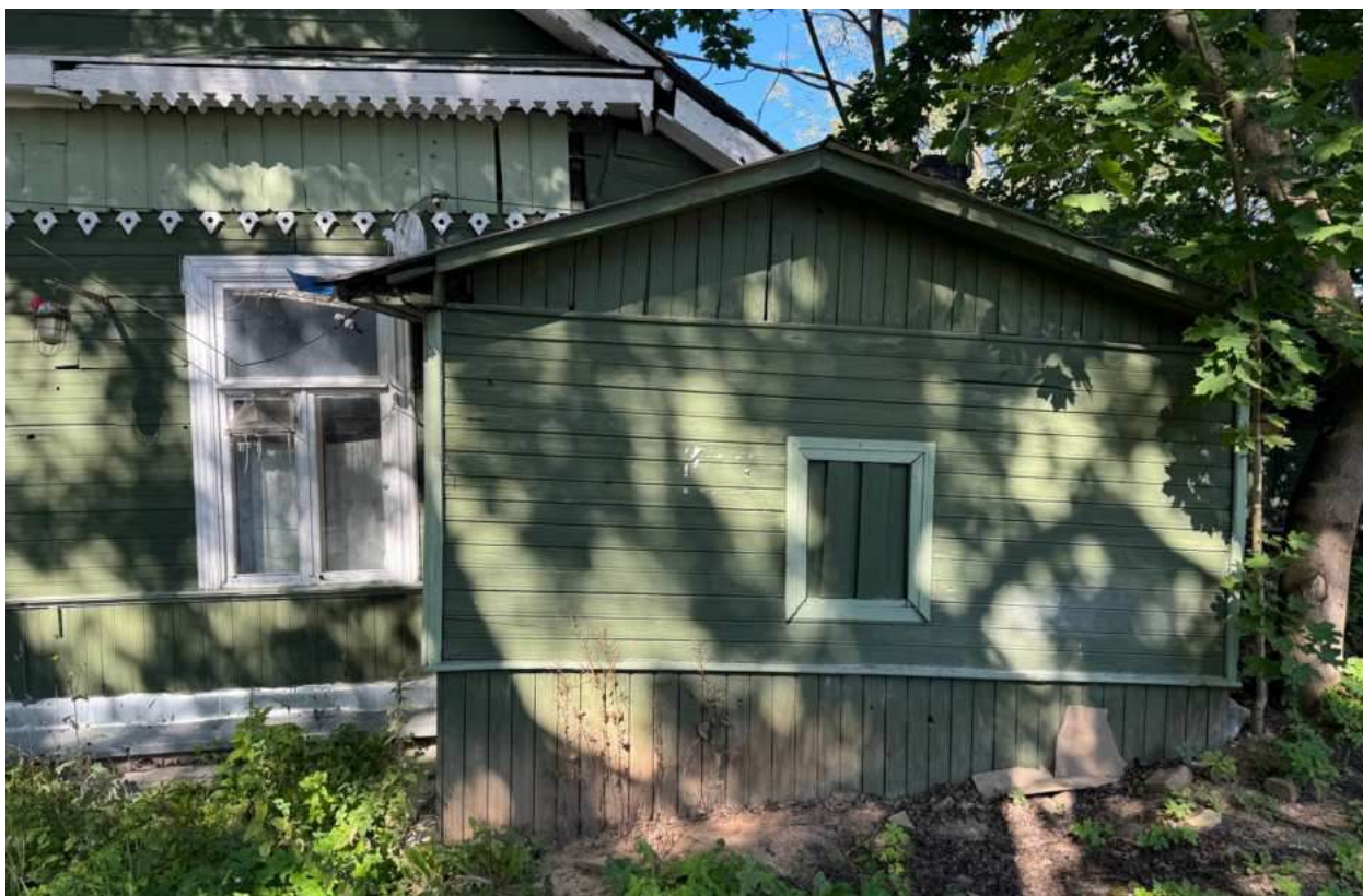
Фото 13. Фрагмент южного фасада объекта культурного наследия.
