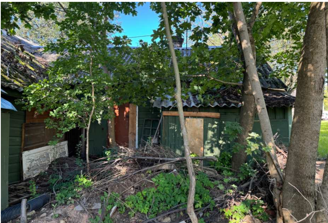
Фото 11. Фрагмент южного фасада объекта культурного наследия.
