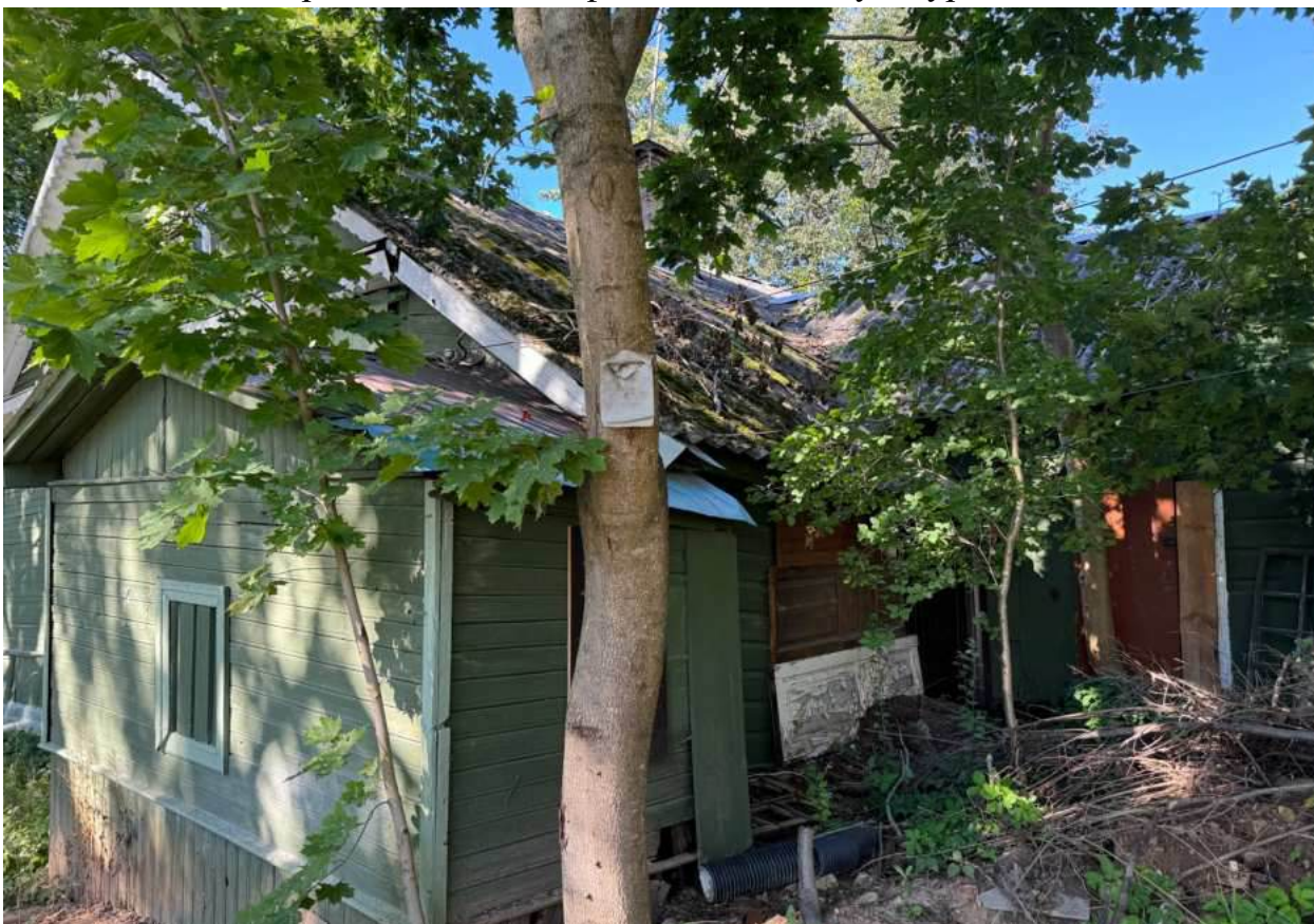
Фото 12. Фрагмент южного фасада объекта культурного наследия.
