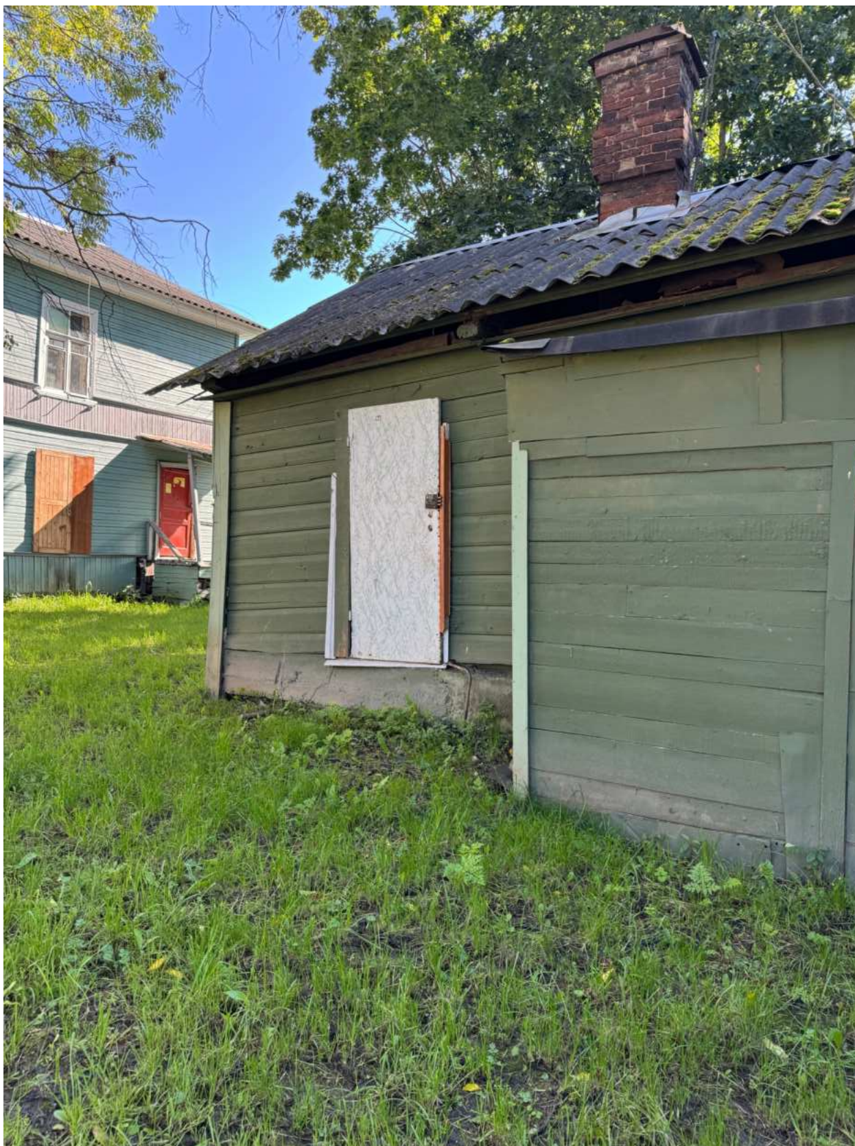
Фото 6. Фрагмент северного фасада объекта культурного наследия.
