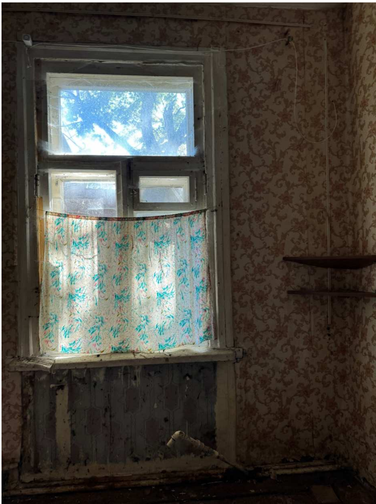
Фото 27. Интерьер помещения и оконного заполнения объекта культурного наследия.
