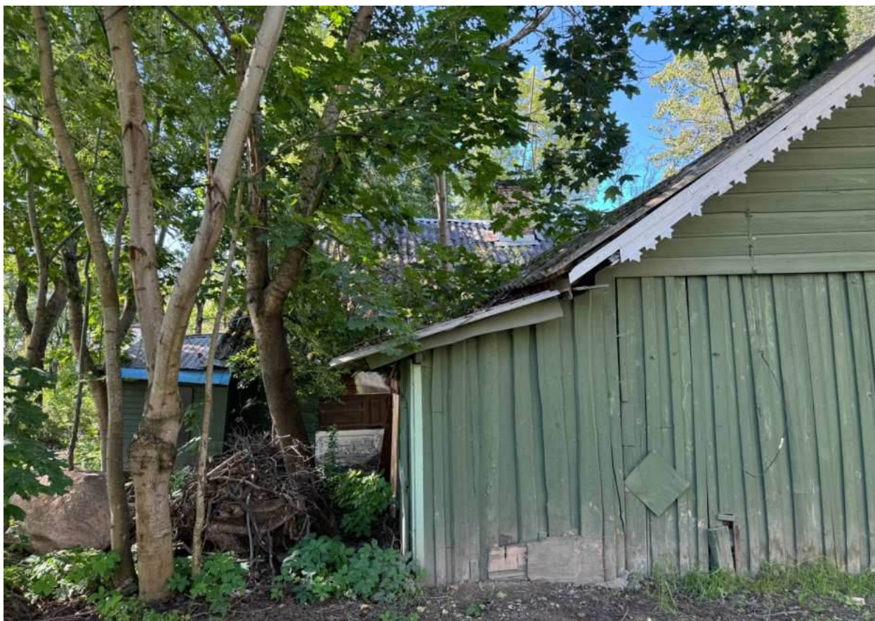
Фото 9. Фрагмент восточного фасада объекта культурного наследия.
