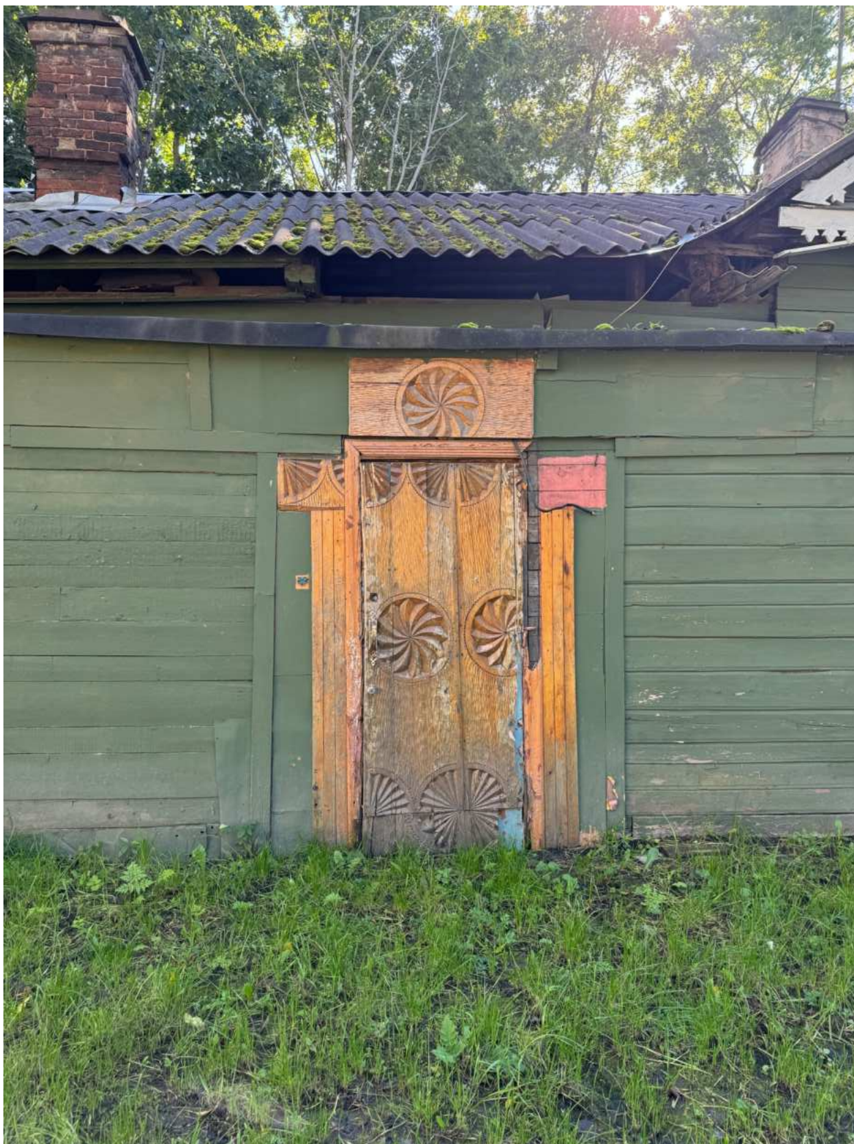
Фото 4. Фрагмент северного фасада объекта культурного наследия.
