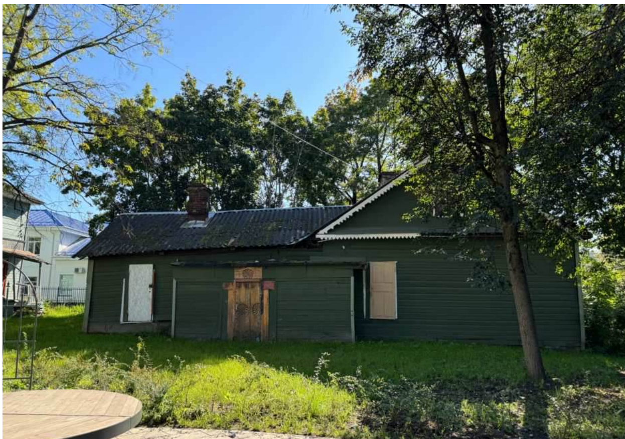
Фото 3. Общий вид северного фасада объекта культурного наследия.
