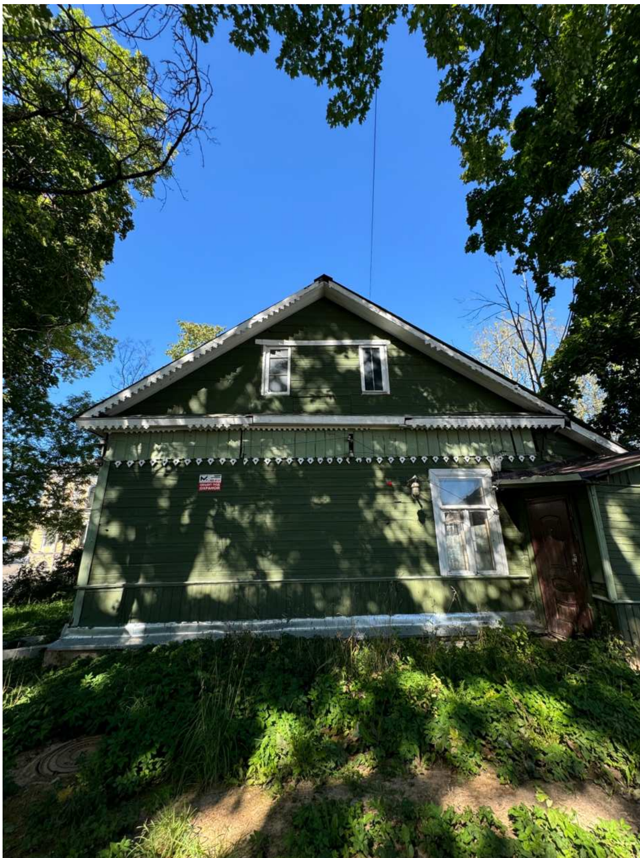
Фото 16. Фрагмент южного фасада объекта культурного наследия.
