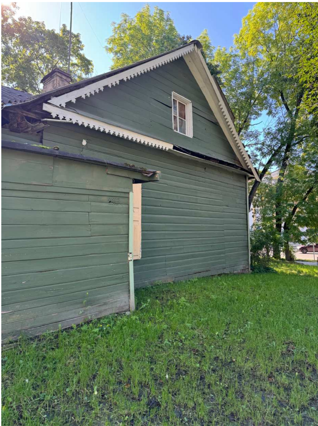
Фото 5. Фрагмент северного фасада объекта культурного наследия.
