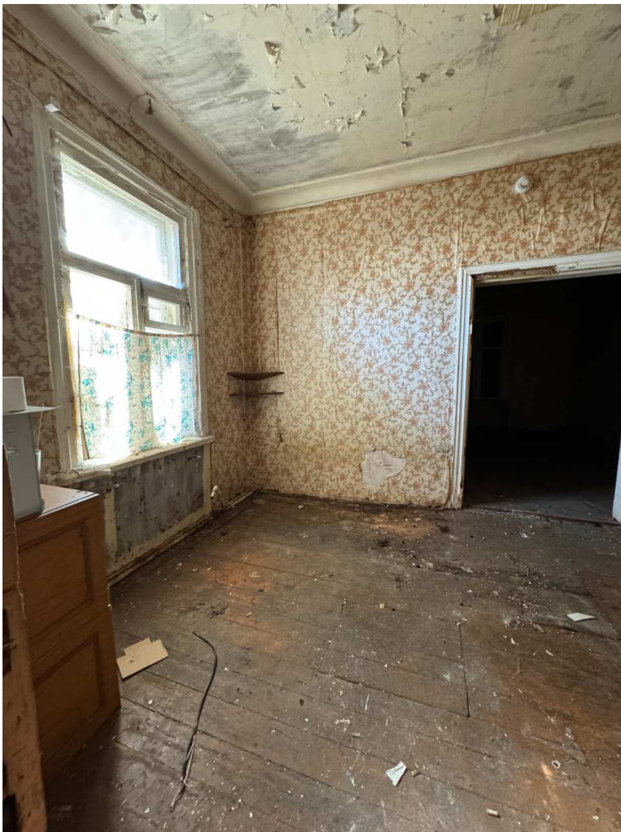
Фото 18. Интерьер помещения объекта культурного наследия.
