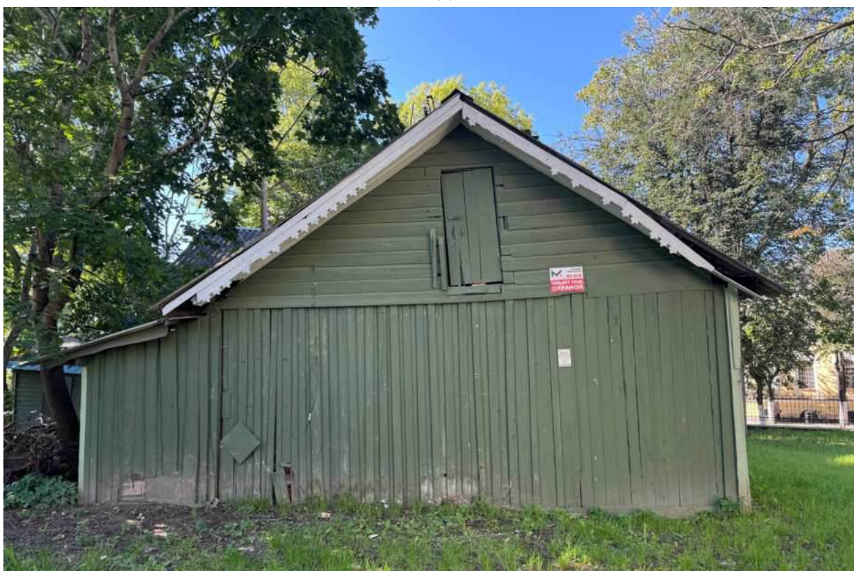
Фото 8. Общий вид восточного фасада объекта культурного наследия.
