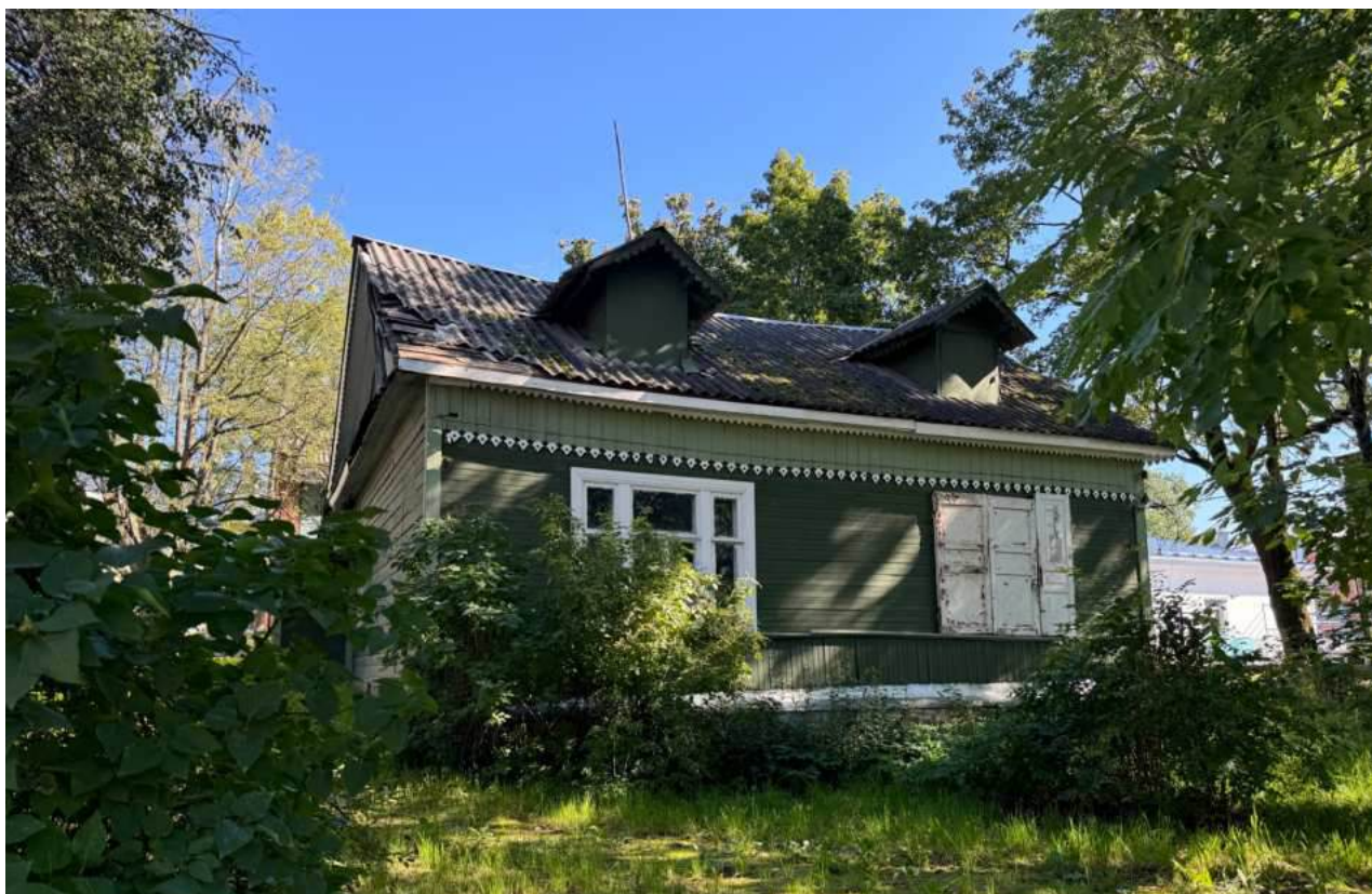
Фото 1. Общий вид западного фасада объекта культурного наследия.
