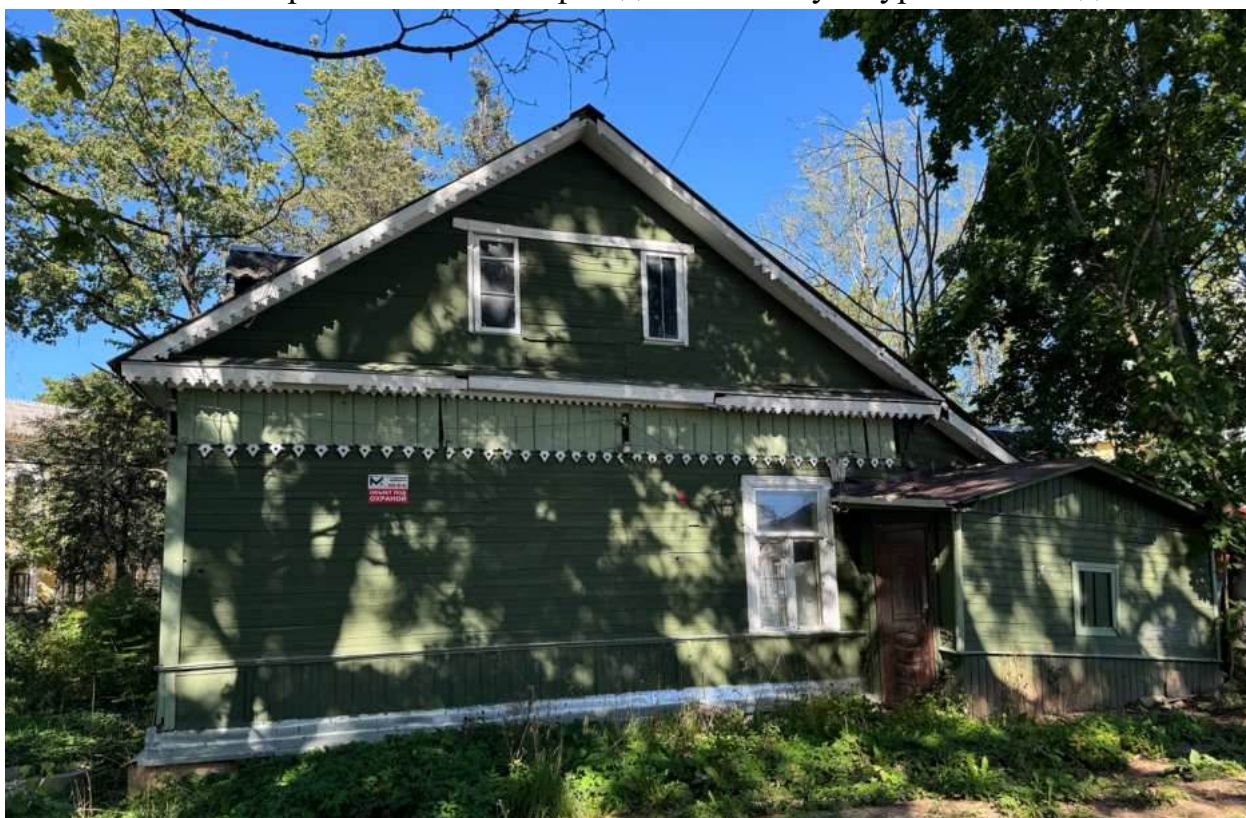
Фото 14. Фрагмент южного фасада объекта культурного наследия.
