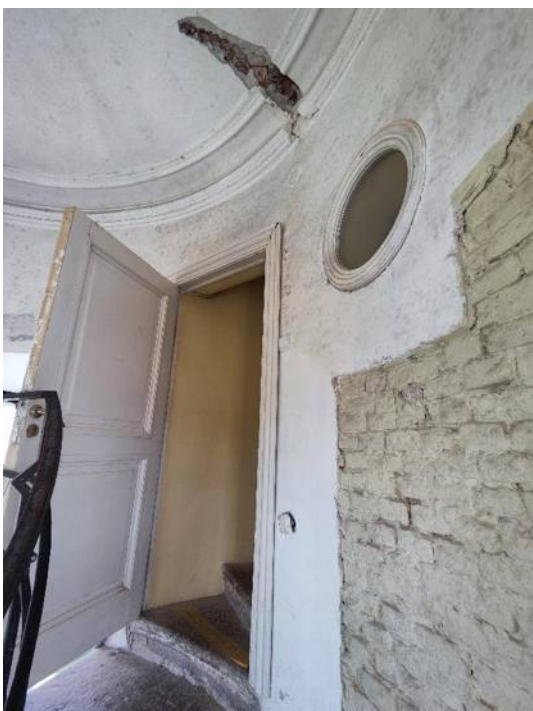
27. «Гатчинский дворец (с Арсенальным и Кухонным каре)», 1766-1781 гг., 1793-1797 гг., (перестроен), 1844-1851 гг., Ленинградская область, Гатчинский муниципальный район, Гатчинское городское поселение, г. Гатчина, Дворцовый парк, Красноармейский пр., д.1, лит. А. Сигнальная башня. Проход во внутрискривую винтовую лестницу. Общий вид. Фото 14.06.2024г.
