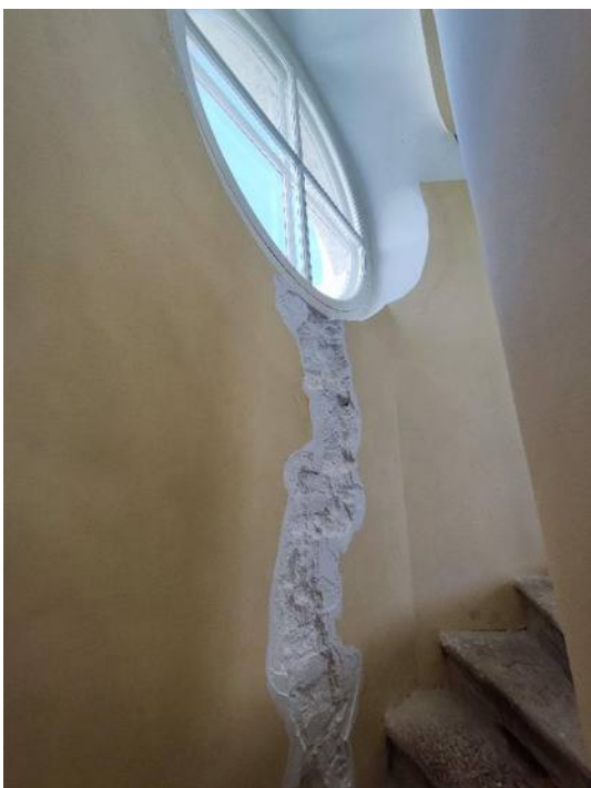
29. «Гатчинский дворец (с Арсенальным и Кухонным каре)», 1766-1781 гг., 1793-1797 гг., (перестроен), 1844-1851 гг., Ленинградская область, Гатчинский муниципальный район, Гатчинское городское поселение, г. Гатчина, Дворцовый парк, Красноармейский пр., д.1, лит. А. Сигнальная башня. Внутрестенная винтовая лестница. Фрагмент. Фото 14.06.2024г.
