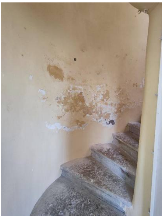
31. «Гатчинский дворец (с Арсенальным и Кухонным каре)», 1766-1781 гг., 1793-1797 гг., (перестроен), 1844-1851 гг., Ленинградская область, Гатчинский муниципальный район, Гатчинское городское поселение, г. Гатчина, Дворцовый парк, Красноармейский пр., д.1, лит. А. Сигнальная башня. Внутростенная винтовая лестница. Фрагмент. Фото 14.06.2024г.
