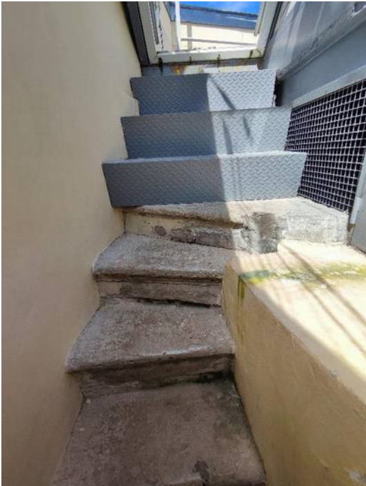
34. «Гатчинский дворец (с Арсенальным и Кухонным каре)», 1766-1781 гг., 1793-1797 гг., (перестроен), 1844-1851 гг., Ленинградская область, Гатчинский муниципальный район, Гатчинское городское поселение, г. Гатчина, Дворцовый парк, Красноармейский пр., д.1, лит. А. Сигнальная башня. Внутрискрипная винтовая лестница. Фрагмент. Фото 14.06.2024г.
