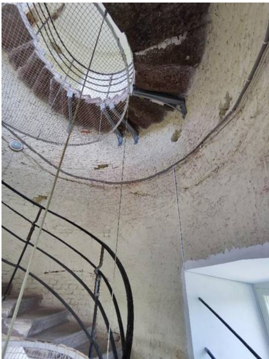
20. «Гатчинский дворец (с Арсенальным и Кухонным каре)», 1766-1781 гг., 1793-1797 гг., (перестроен), 1844-1851 гг., Ленинградская область, Гатчинский муниципальный район, Гатчинское городское поселение, г. Гатчина, Дворцовый парк, Красноармейский пр., д.1, лит. А. Сигнальная башня. Винтовая лестница. Фрагмент. Фото 14.06.2024г.
