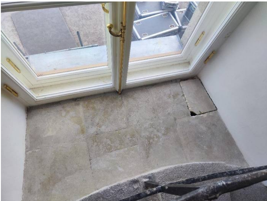
6. «Гатчинский дворец (с Арсенальным и Кухонным каре)», 1766-1781 гг., 1793-1797 гг., (перестроен), 1844-1851 гг., Ленинградская область, Гатчинский муниципальный район, Гатчинское городское поселение, г. Гатчина, Дворцовый парк, Красноармейский пр., д.1, лит. А. Сигнальная башня. Оконное заполнение. Фрагмент. Фото 14.06.2024г.
