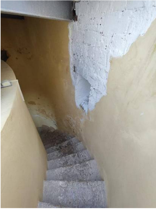
33. «Гатчинский дворец (с Арсенальным и Кухонным каре)», 1766-1781 гг., 1793-1797 гг., (перестроен), 1844-1851 гг., Ленинградская область, Гатчинский муниципальный район, Гатчинское городское поселение, г. Гатчина, Дворцовый парк, Красноармейский пр., д.1, лит. А. Сигнальная башня. Внутрискрипная винтовая лестница. Фрагмент. Фото 14.06.2024г.
