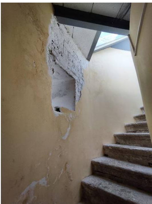
32. «Гатчинский дворец (с Арсенальным и Кухонным каре)», 1766-1781 гг., 1793-1797 гг., (перестроен), 1844-1851 гг., Ленинградская область, Гатчинский муниципальный район, Гатчинское городское поселение, г. Гатчина, Дворцовый парк, Красноармейский пр., д.1, лит. А. Сигнальная башня. Внутростенная винтовая лестница. Фрагмент. Фото 14.06.2024г.
