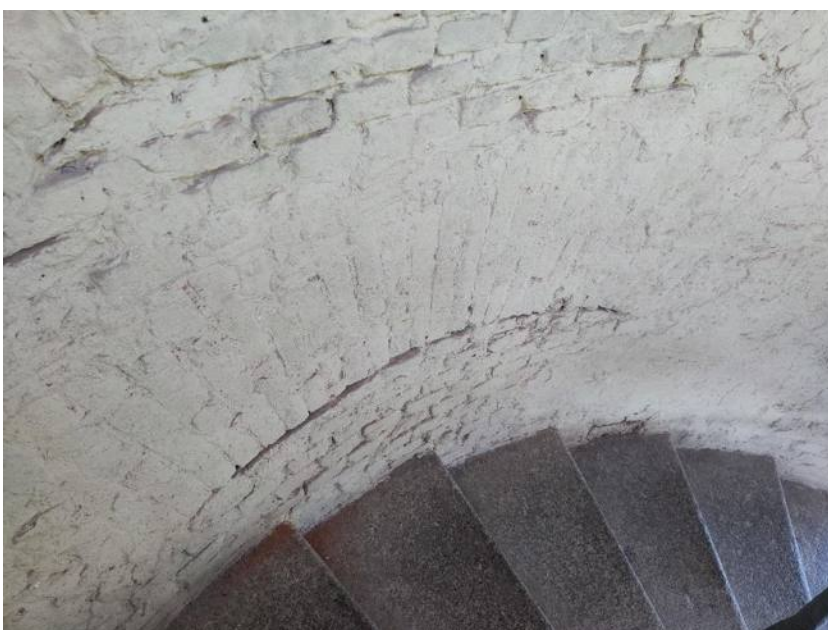
22. «Гатчинский дворец (с Арсенальным и Кухонным каре)», 1766-1781 гг., 1793-1797 гг., (перестроен), 1844-1851 гг., Ленинградская область, Гатчинский муниципальный район, Гатчинское городское поселение, г. Гатчина, Дворцовый парк, Красноармейский пр., д.1, лит. А. Сигнальная башня. Винтовая лестница. Фрагмент. Фото 14.06.2024г.
