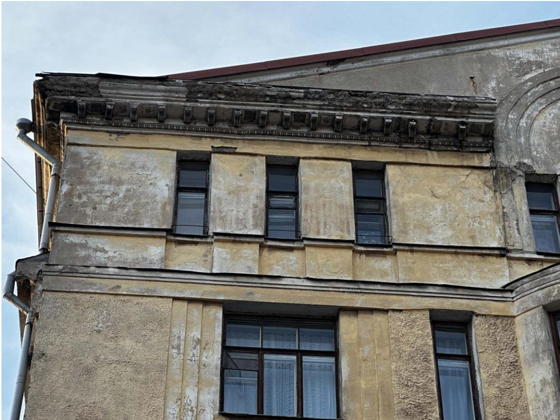
Фото 18. Фрагмент южного бокового уличного фасада здания. Дата съемки: 21.05.2024 г. Автор съемки: Куваева Ю.П.
