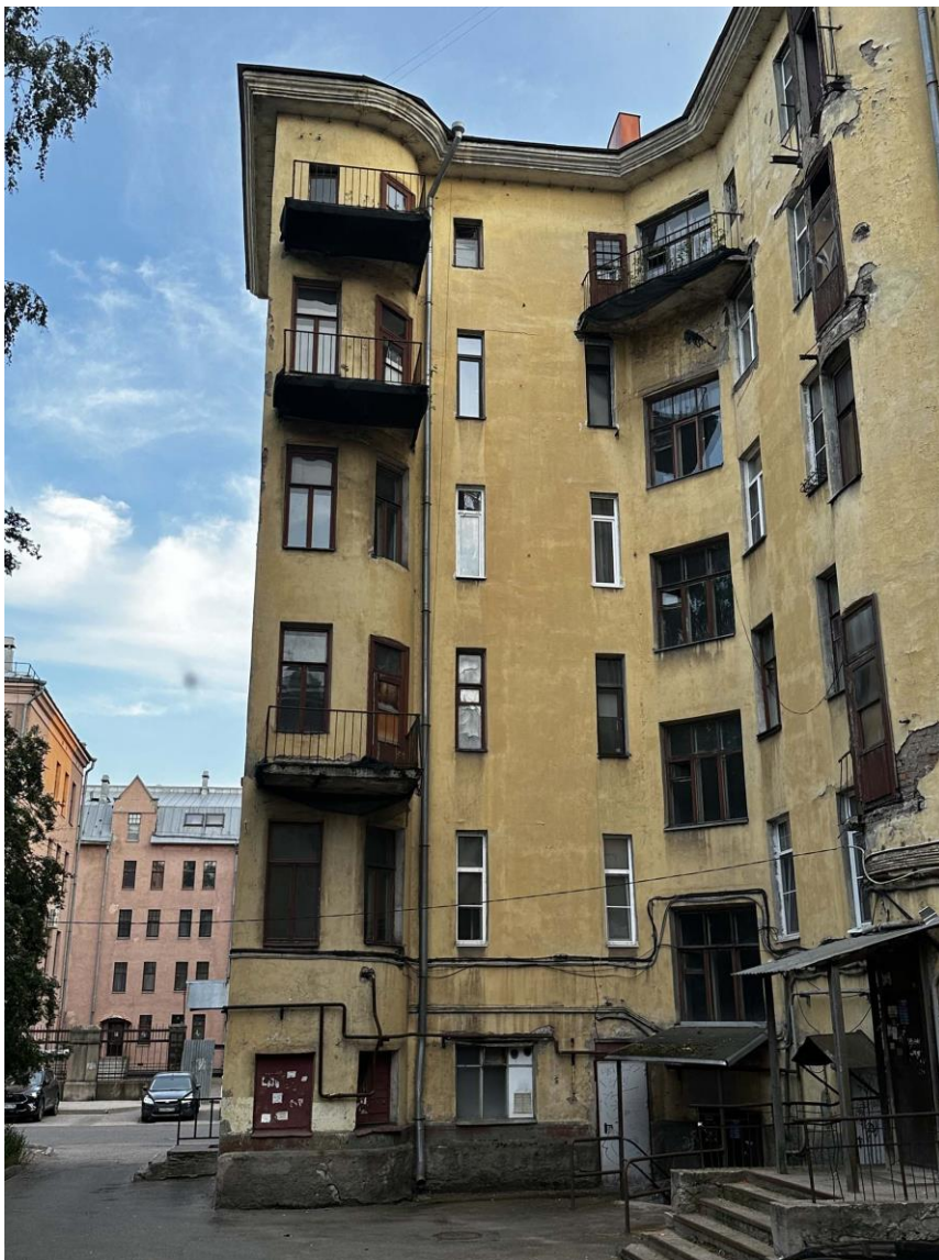
Фото 25. Общий вид северного дворового фасада восточного ризалита основного объема здания. Дата съемки: 21.05.2024 г. Автор съемки: Куваева Ю.П.
