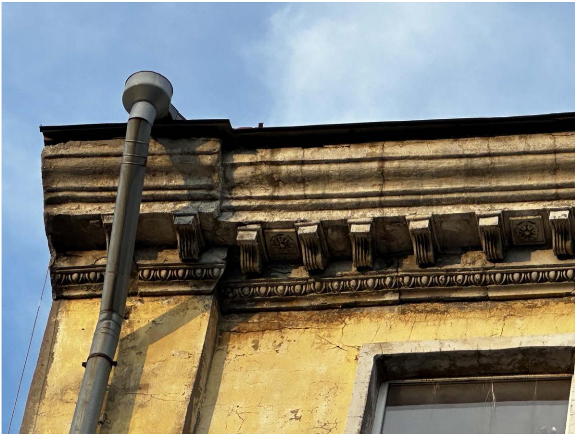
Фото 16. Фрагмент левой части западного лицевого фасада здания. Дата съемки: 21.05.2024 г. Автор съемки: Куваева Ю.П.
