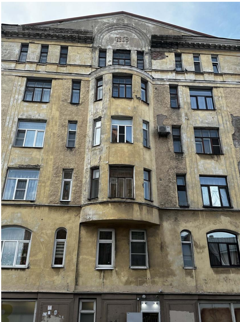
Фото 19. Фрагмент южного бокового уличного фасада здания. Центральная часть. Дата съемки: 21.05.2024 г. Автор съемки: Куваева Ю.П.
