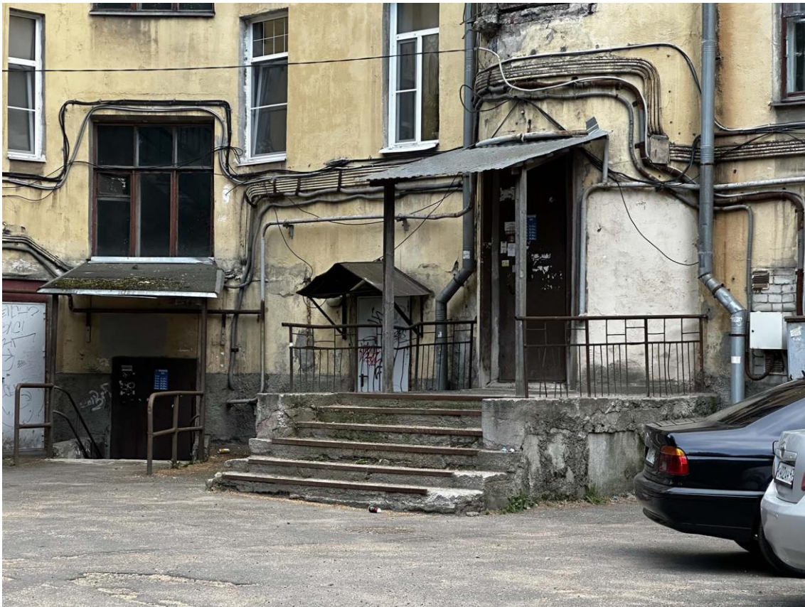
Фото 35. Фрагмент восточного дворового фасада здания. Крыльцо. Фото с северо-востока. Дата съемки: 21.05.2024 г. Автор съемки: Куваева Ю.П.
