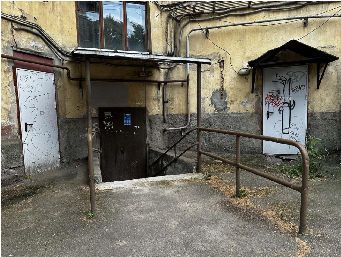
Фото 28. Фрагмент внутреннего северо-восточного угла дворовых фасадов здания. Спуск в подвал. Дата съемки: 21.05.2024 г. Автор съемки: Куваева Ю.П.
