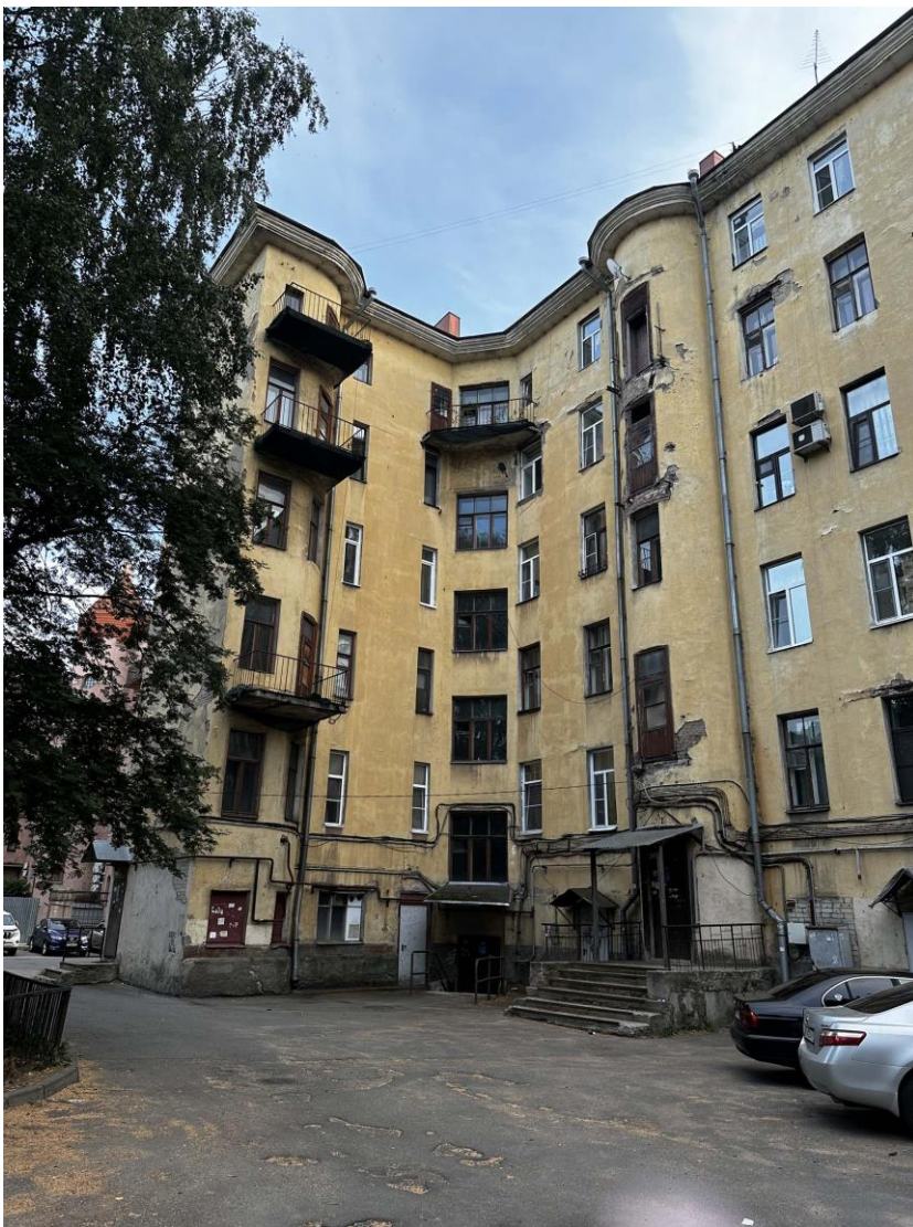
Фото 27. Общий вид дворовых фасадов здания с северо-востока. Дата съемки: 21.05.2024 г. Автор съемки: Куваева Ю.П.
