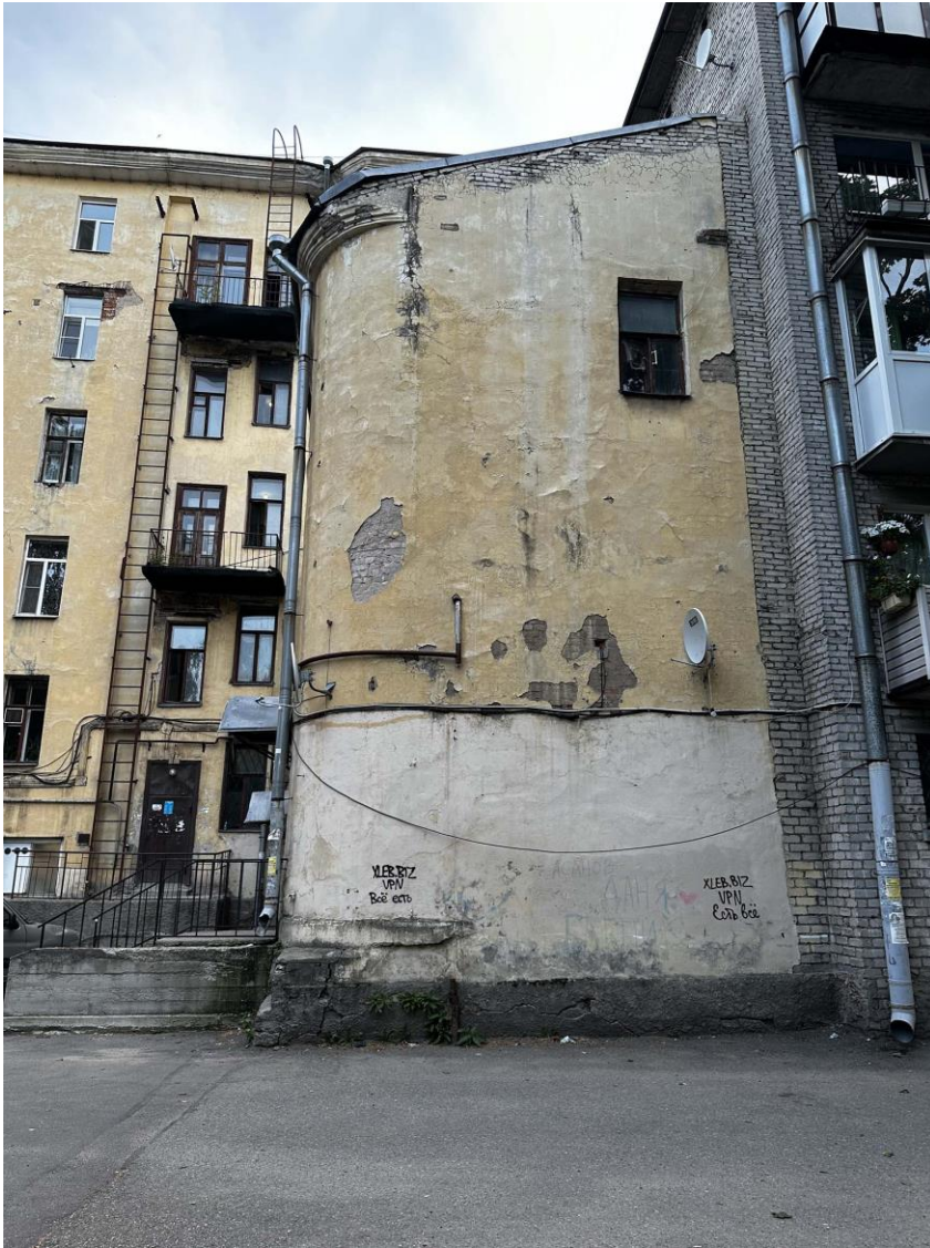
Фото 41. Общий вид восточного фасада северо-восточного дворового крыла здания. Дата съемки: 21.05.2024 г. Автор съемки: Куваева Ю.П.
