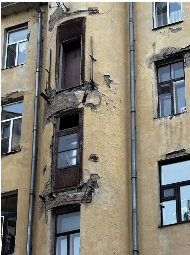
Фото 32. Фрагмент восточного дворового фасада здания. Дата съемки: 21.05.2024 г. Автор съемки: Куваева Ю.П.
