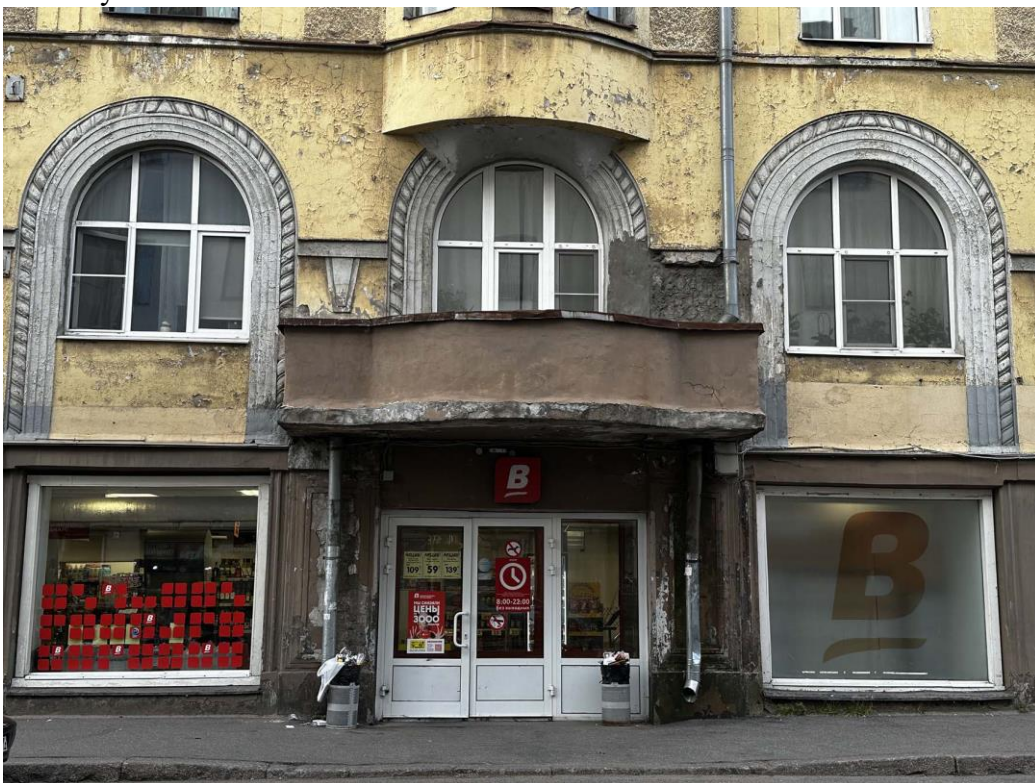
Фото 9. Фрагмент левой части западного лицевого фасада здания. Дата съемки: 21.05.2024 г. Автор съемки: Куваева Ю.П.
