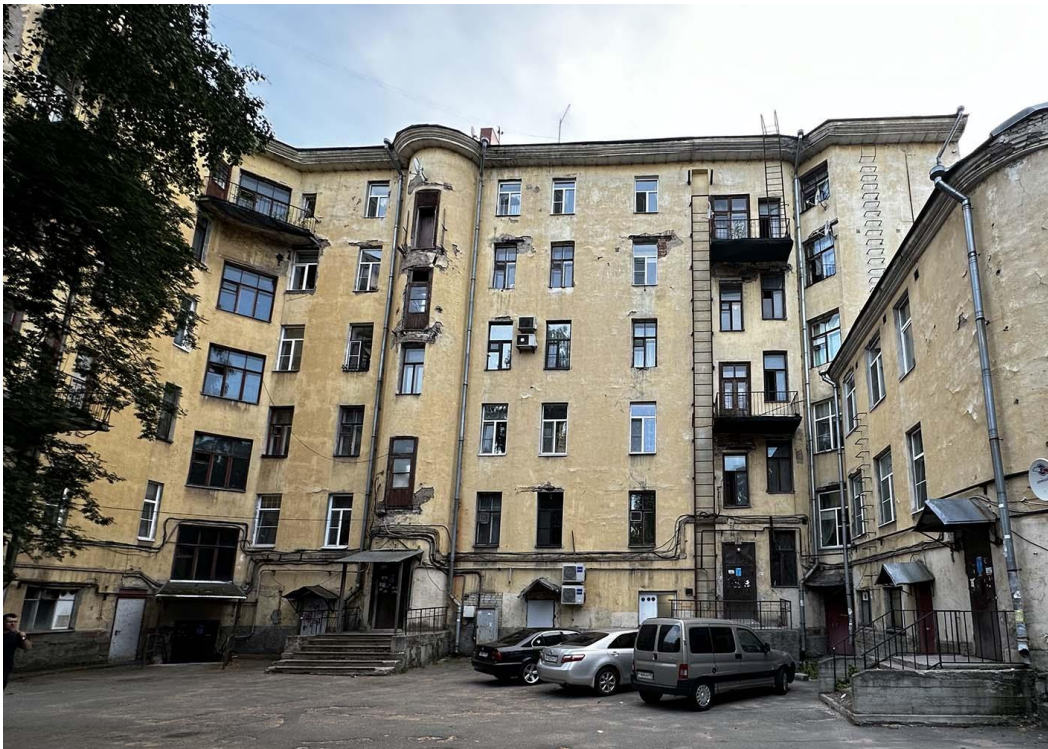
Фото 31. Общий вид восточного дворового фасада здания. Дата съемки: 21.05.2024 г. Автор съемки: Куваева Ю.П.
