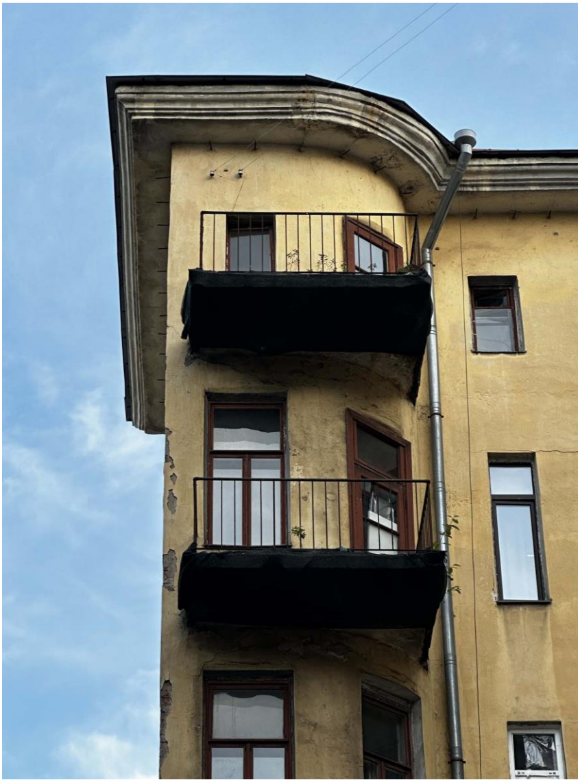
Фото 26. Фрагмент северного дворового фасада восточного ризалита основного объема здания. Дата съемки: 21.05.2024 г. Автор съемки: Куваева Ю.П.
