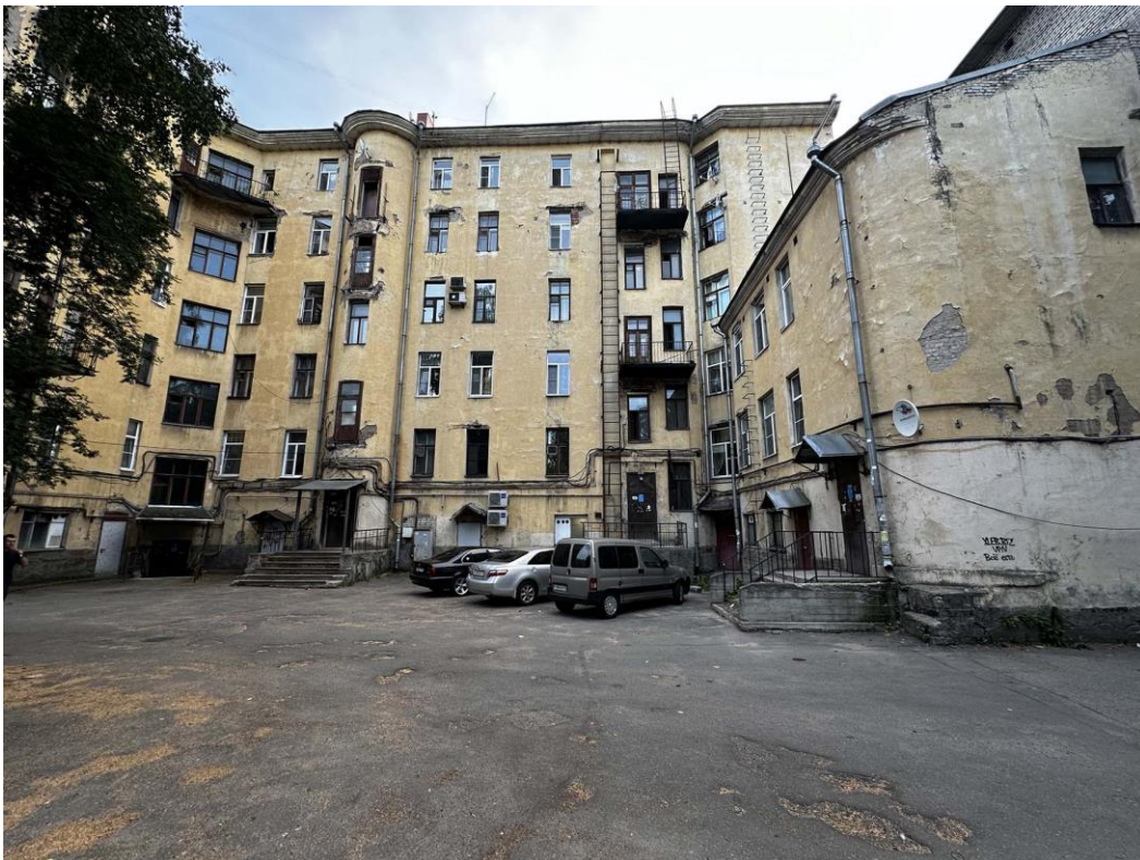
Фото 4. Общий вид дворовых фасадов с востока. Дата съемки: 21.05.2024 г. Автор съемки: Куваева Ю.П.
