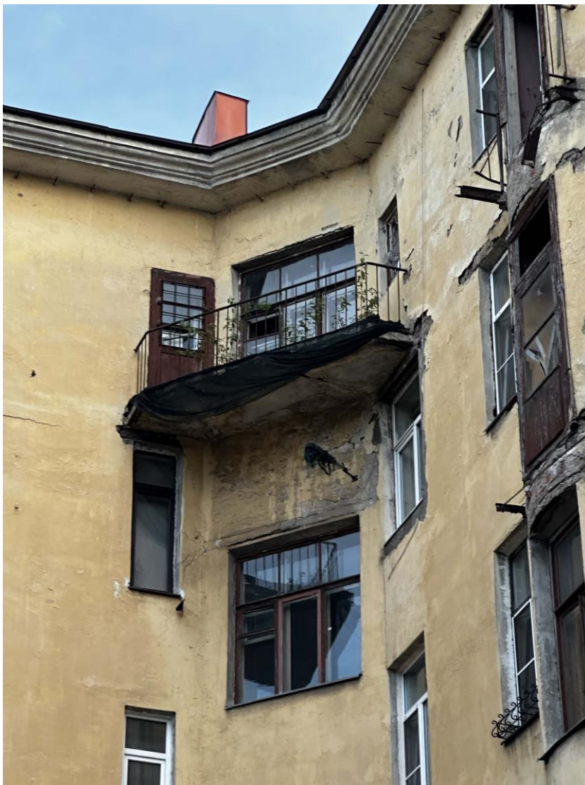
Фото 30. Фрагмент внутреннего северо-восточного угла дворовых фасадов здания. Дата съемки: 21.05.2024 г. Автор съемки: Куваева Ю.П.
