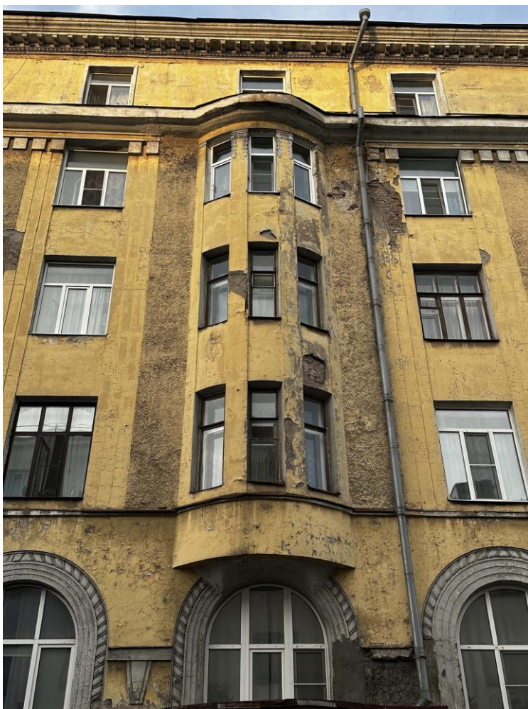
Фото 10. Фрагмент левой части западного лицевого фасада здания. Дата съемки: 21.05.2024 г. Автор съемки: Куваева Ю.П.
