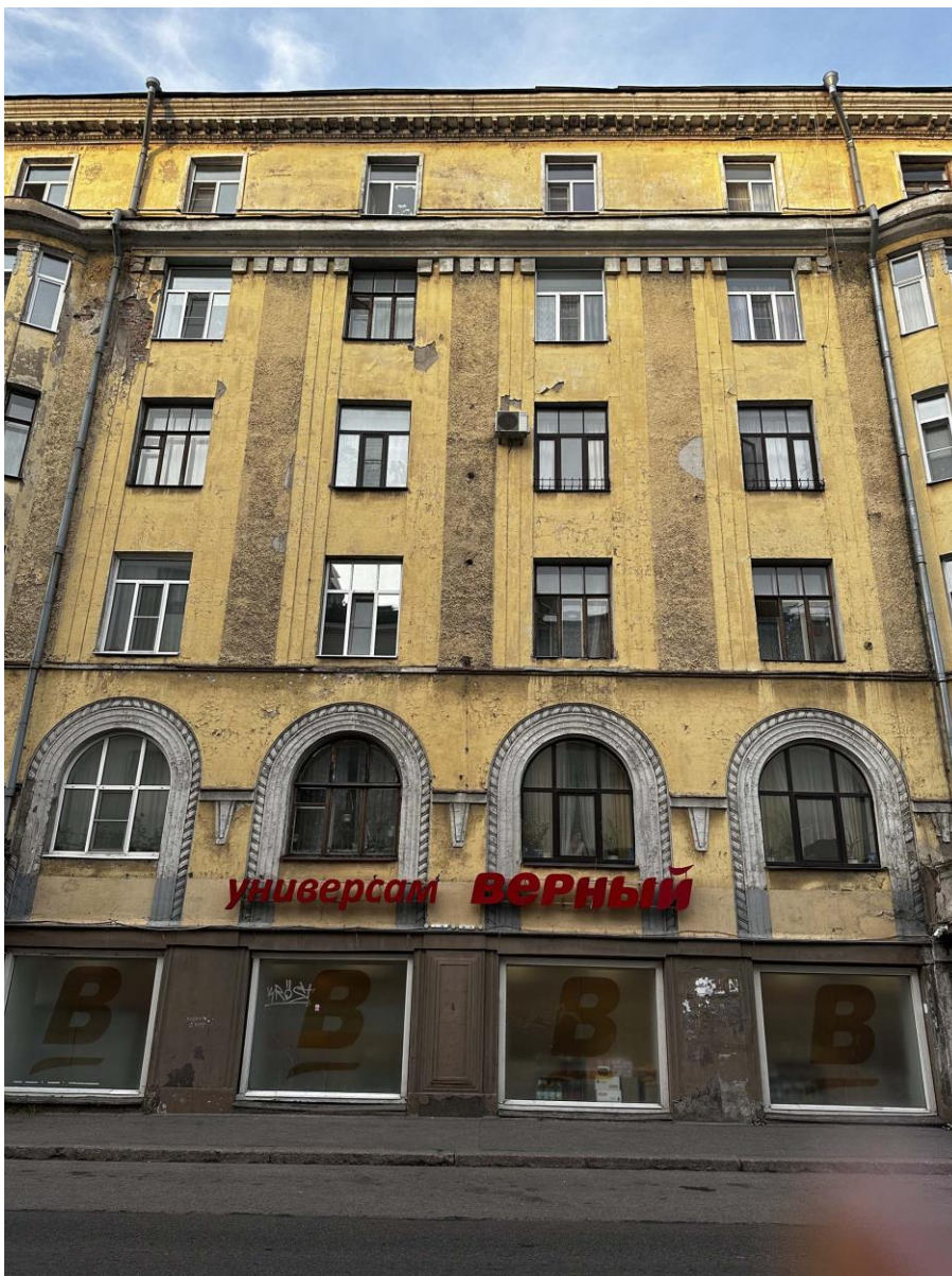
Фото 12. Фрагмент западного лицевого фасада здания. Центральная часть. Дата съемки: 21.05.2024 г. Автор съемки: Куваева Ю.П.
