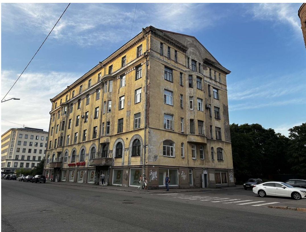
Фото 2. Общий вид здания с юго-запада. Дата съемки: 21.05.2024 г. Автор съемки: Куваева Ю.П.
