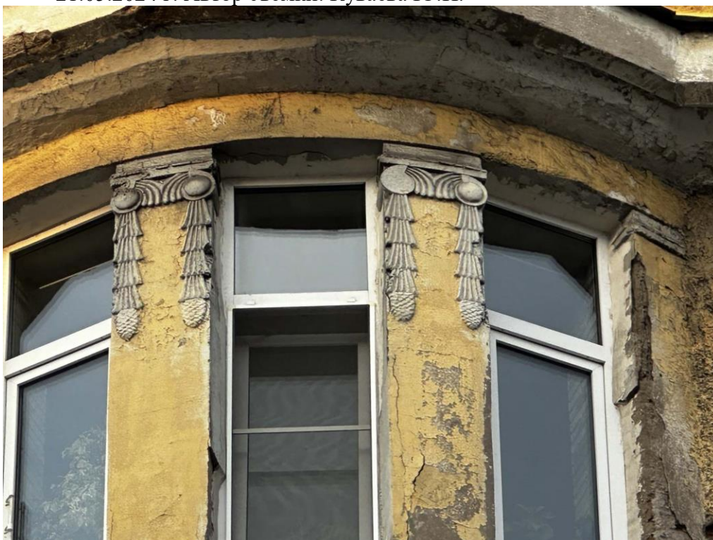
Фото 11. Фрагмент эркера левой части западного лицевого фасада здания. Дата съемки: 21.05.2024 г. Автор съемки: Куваева Ю.П.
