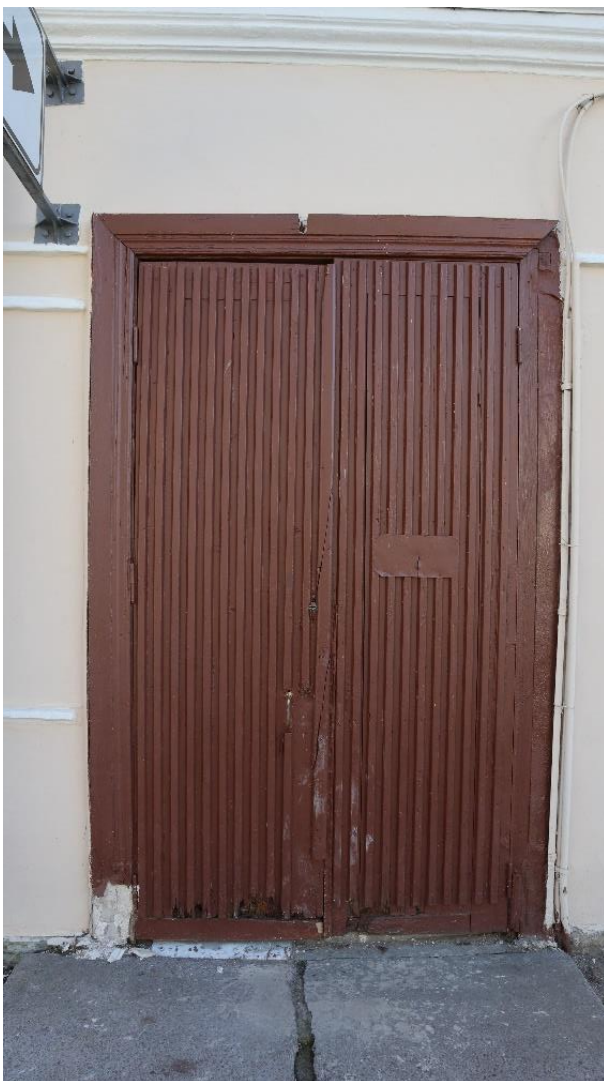
Фото 4. Входная дверь по лицевому фасаду.
