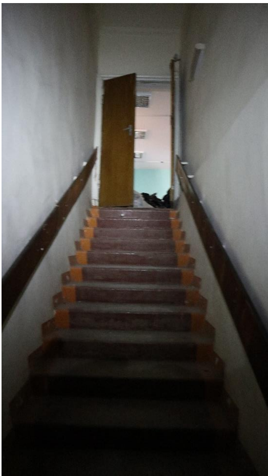
Фото 9. Центральная лестница. Вид с междуэтажной площадки.
