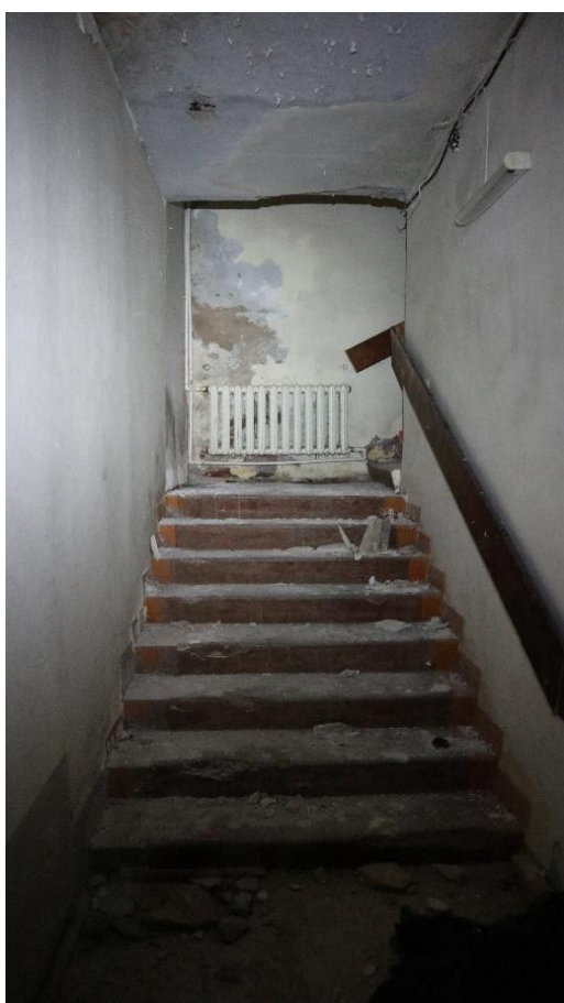
Фото 8. Центральная лестница. Вид с площадки 1 этажа.
