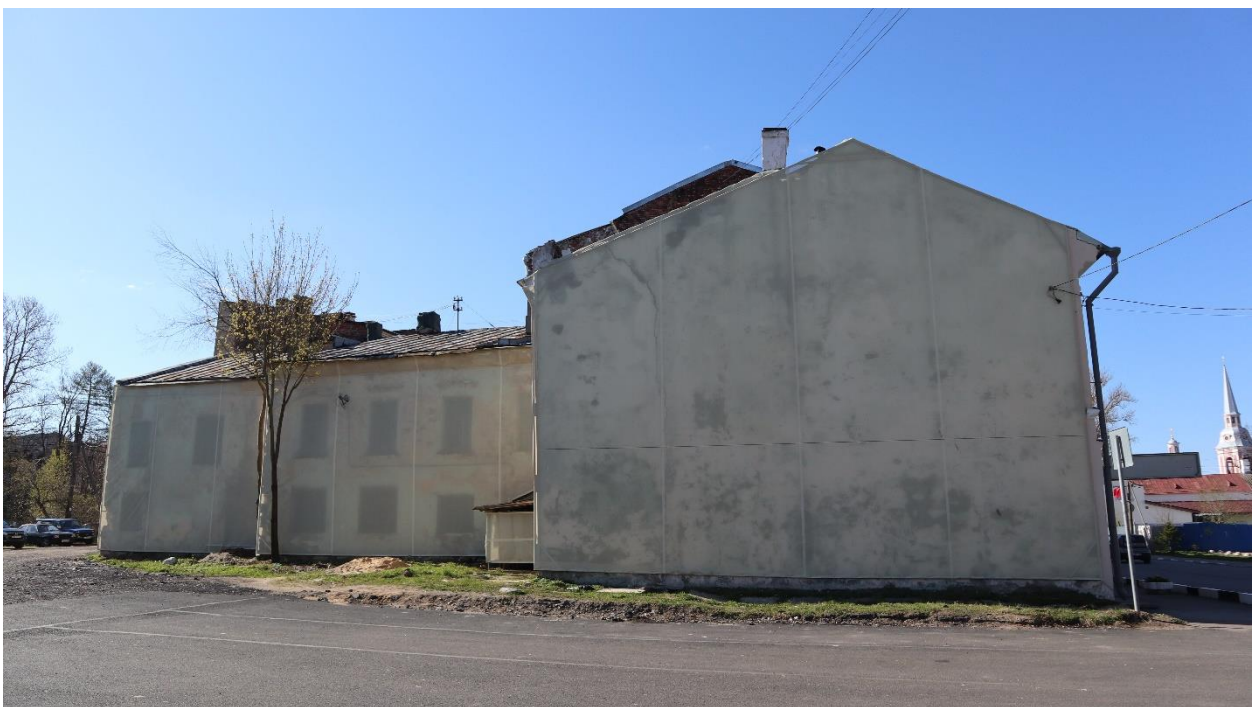
Фото 2. Брандмауэр, торцевой фасад.
