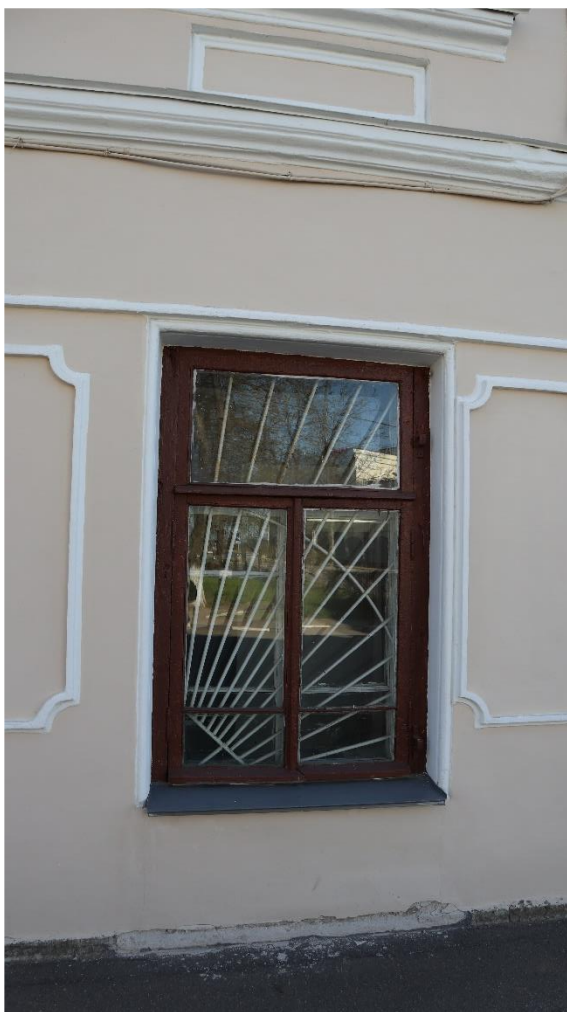
Фото 5. Оконный проем на месте дверного по лицевому фасаду.
