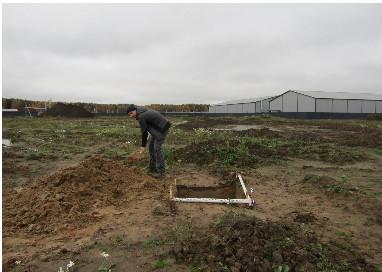
Рисунок 69. «Предприятие по производству сухих строительных смесей». Шурф № 2. Рабочий момент. Засыпка шурфа. Вид с севера.
