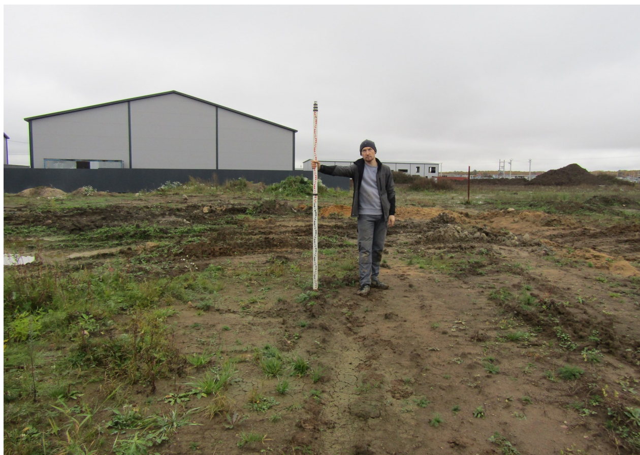
Рисунок 25. «Предприятие по производству сухих строительных смесей». Точка фотофиксации № 4. Вид с запада.
