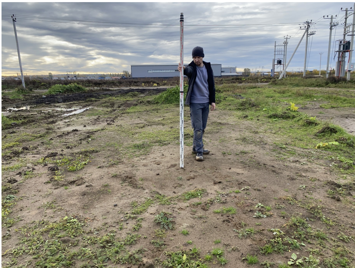
Рисунок 82. «Предприятие по производству сухих строительных смесей». Шурф № 4. Вид на место закладки шурфа до начала работ. Вид с севера.
