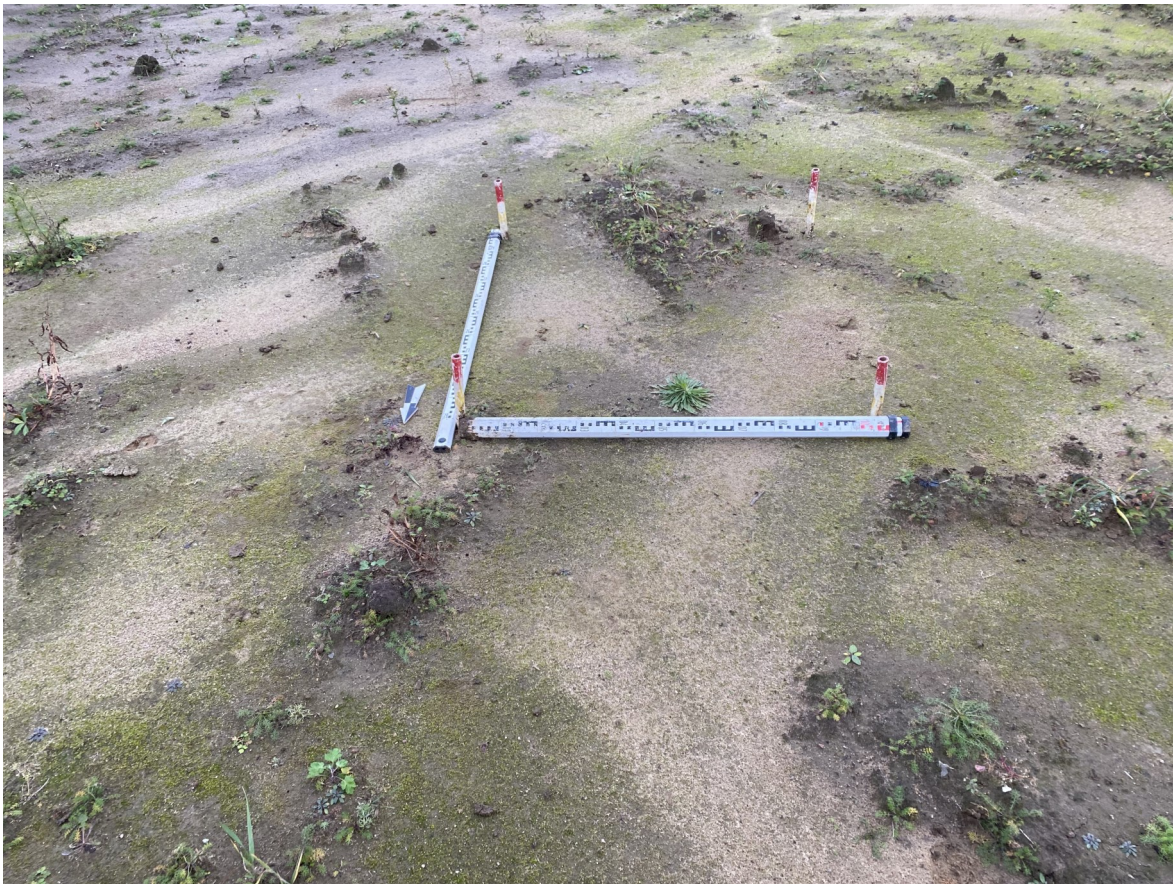
Рисунок 74. «Предприятие по производству сухих строительных смесей». Шурф № 3. Вид на размеченный шурф. Вид с севера.
