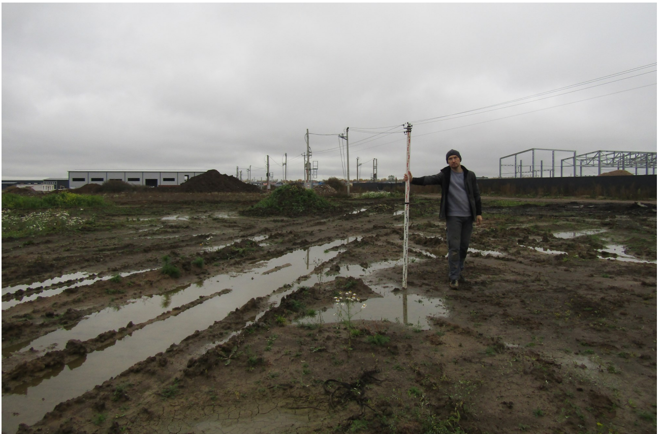
Рисунок 17. «Предприятие по производству сухих строительных смесей». Точка фотофиксации № 2. Вид с запада.
