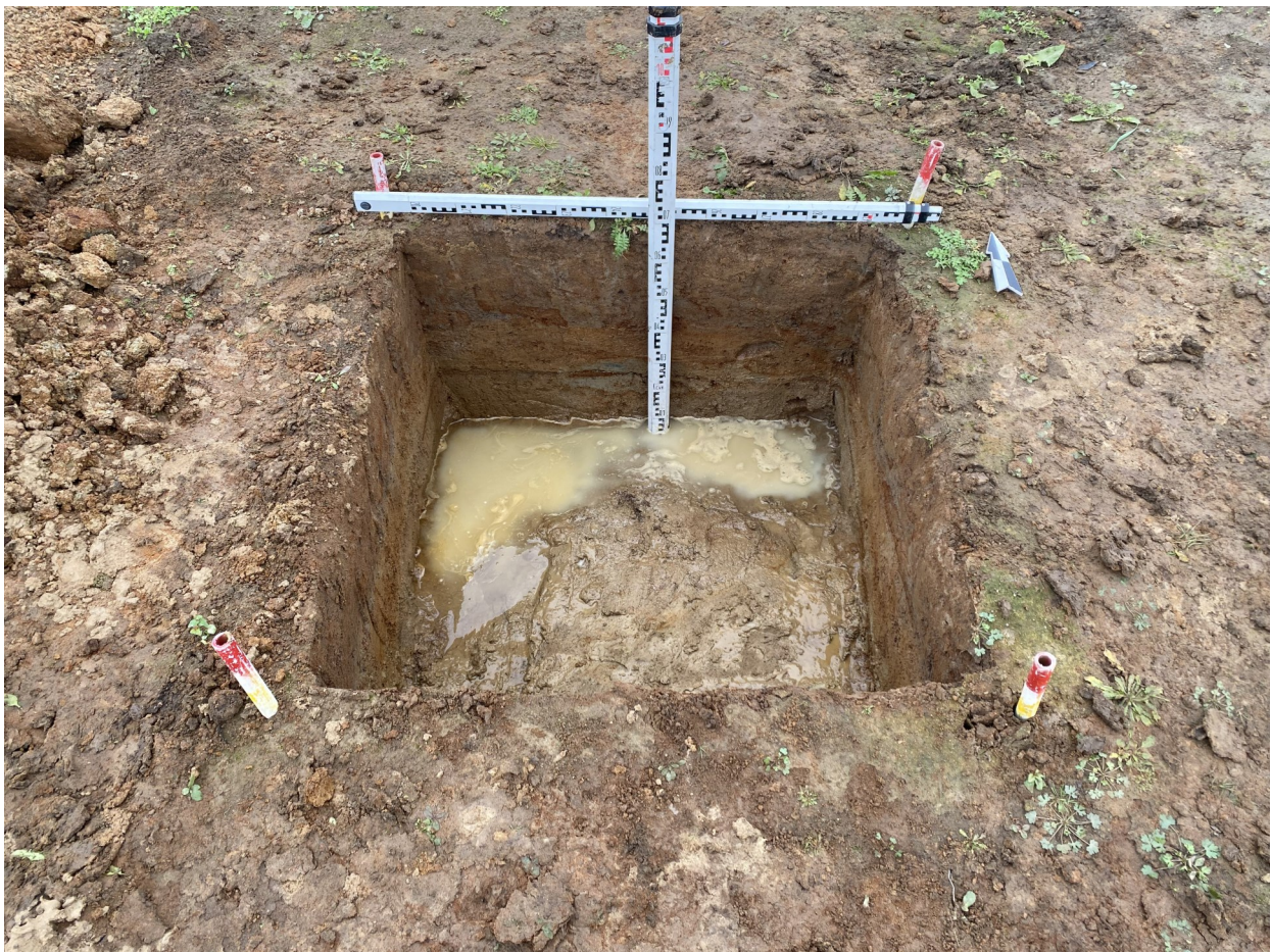
Рисунок 56. «Предприятие по производству сухих строительных смесей». Шурф № 1. Вид на северную стенку и дно шурфа. Вид с юга.
