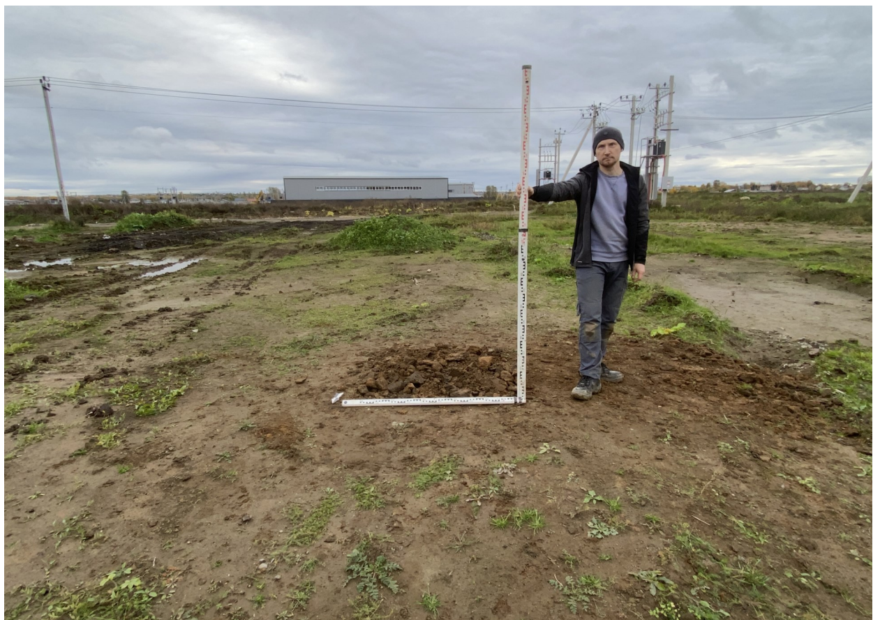
Рисунок 91. «Предприятие по производству сухих строительных смесей». Шурф № 4. Вид после окончания работ и засыпки шурфа. Вид с севера.
