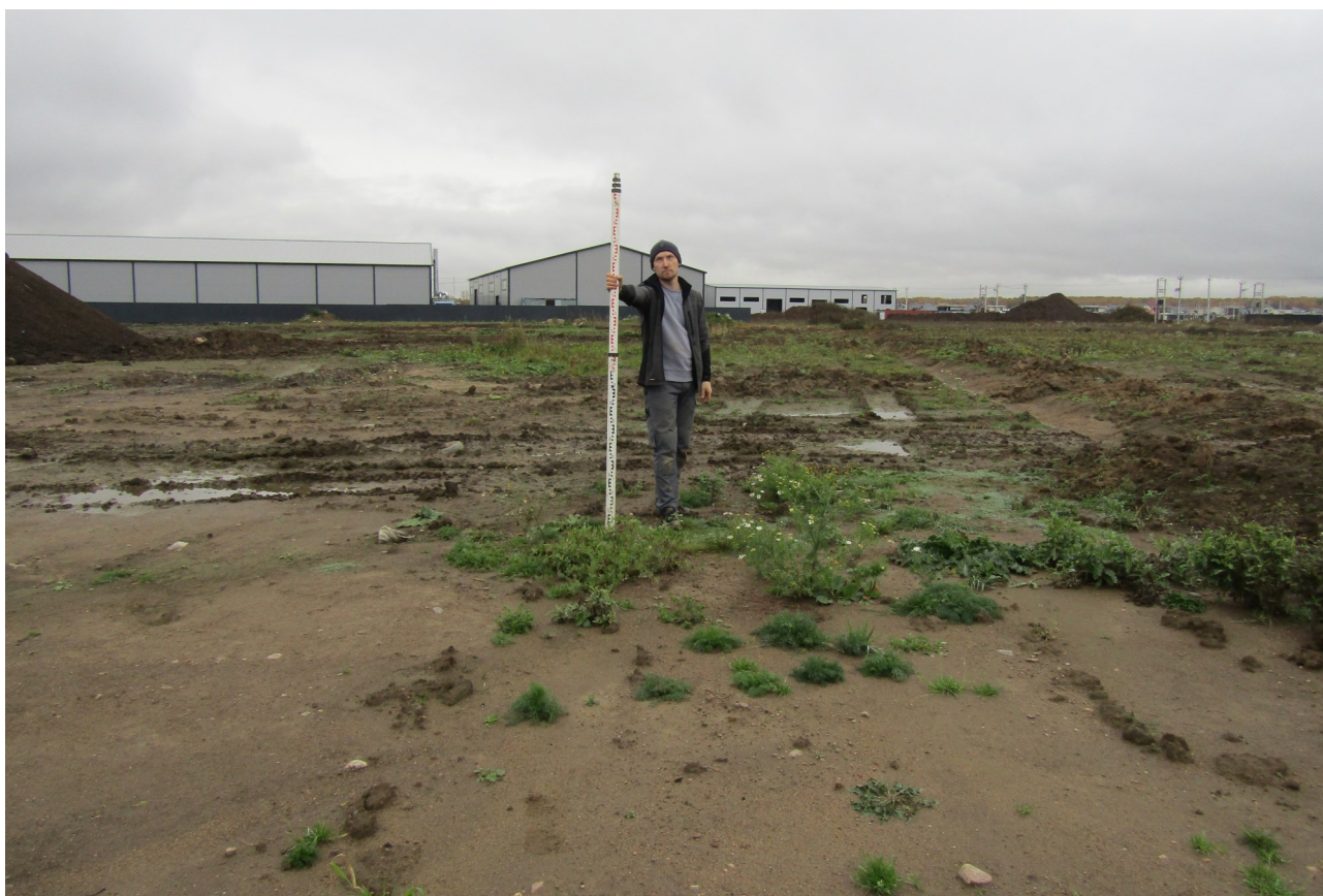
Рисунок 37. «Предприятие по производству сухих строительных смесей». Точка фотофиксации № 7. Вид с запада.
