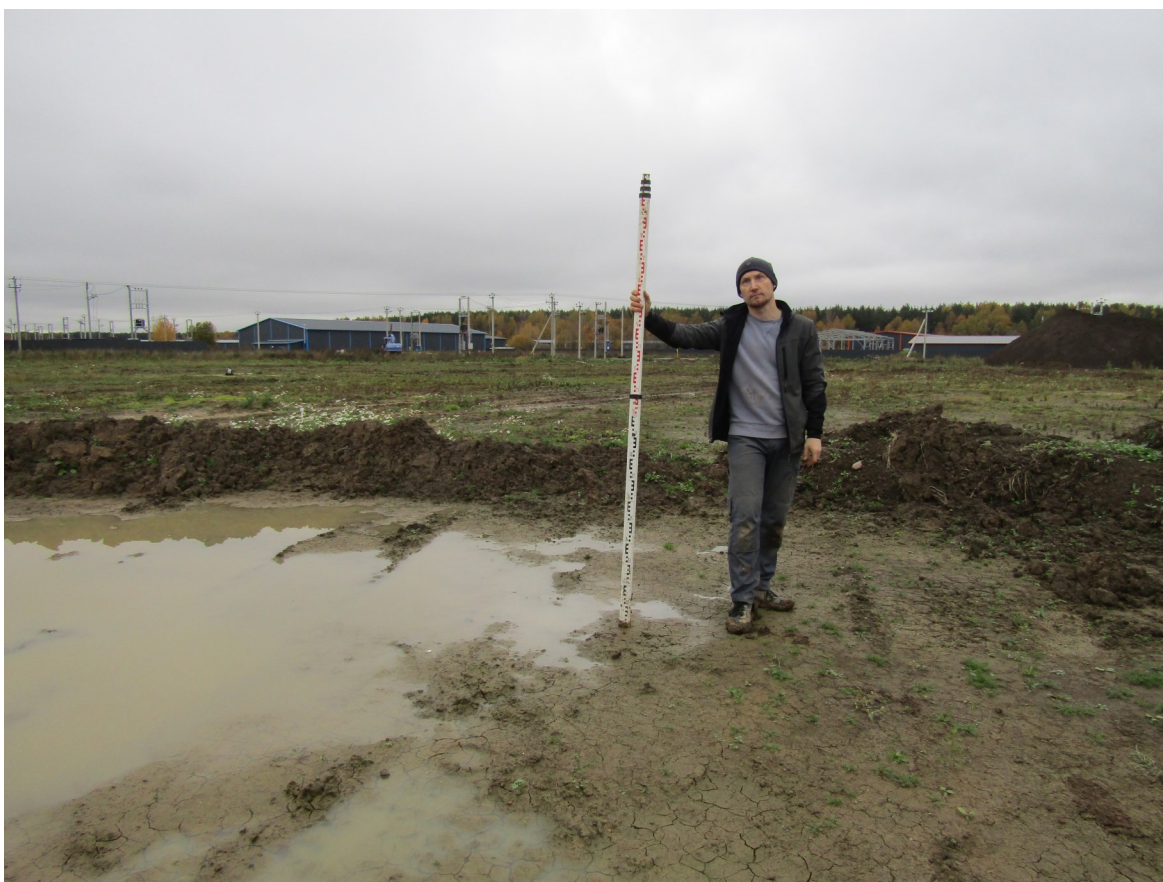
Рисунок 19. «Предприятие по производству сухих строительных смесей». Точка фотофиксации № 3. Вид с востока.
