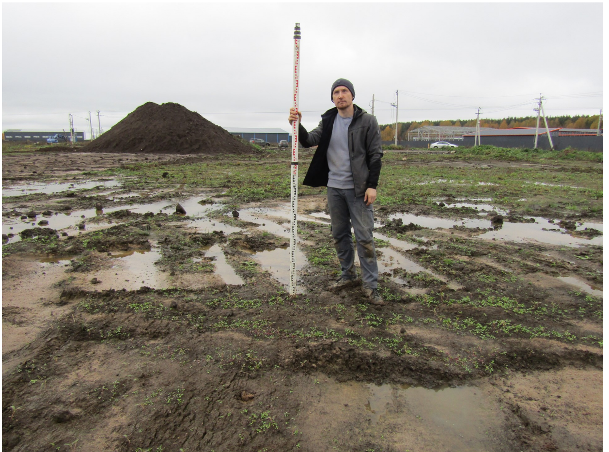
Рисунок 27. «Предприятие по производству сухих строительных смесей». Точка фотофиксации № 5. Вид с востока.
