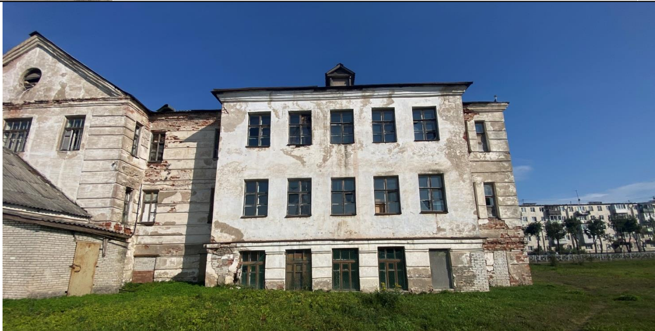
Фот. 14. Фрагмент дворового фасада, южный боковой ризалит
