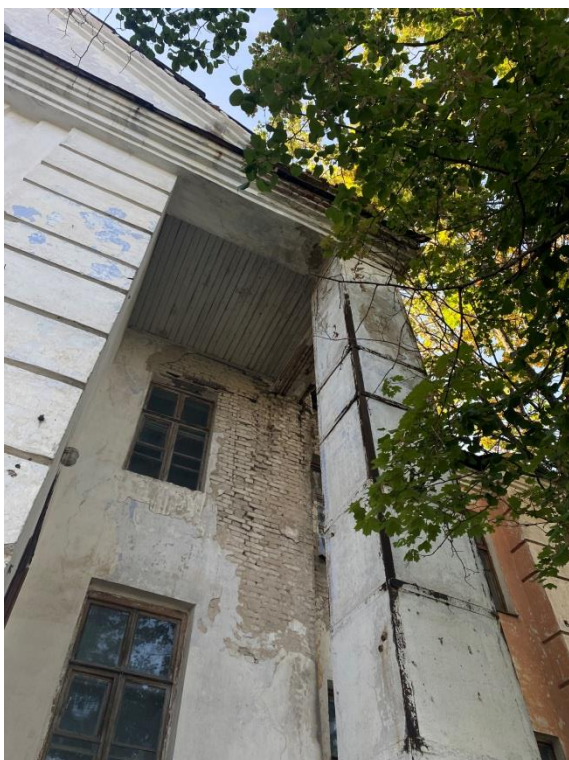
Фот. 10-11. Фрагменты ризалита, лоджии, состояние фасада, колонны, укрепленные металлической обоймой
