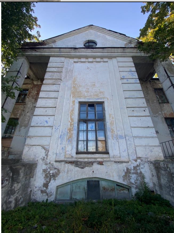
Фот. 8. Фрагмент лицевого фасада, ризалит
