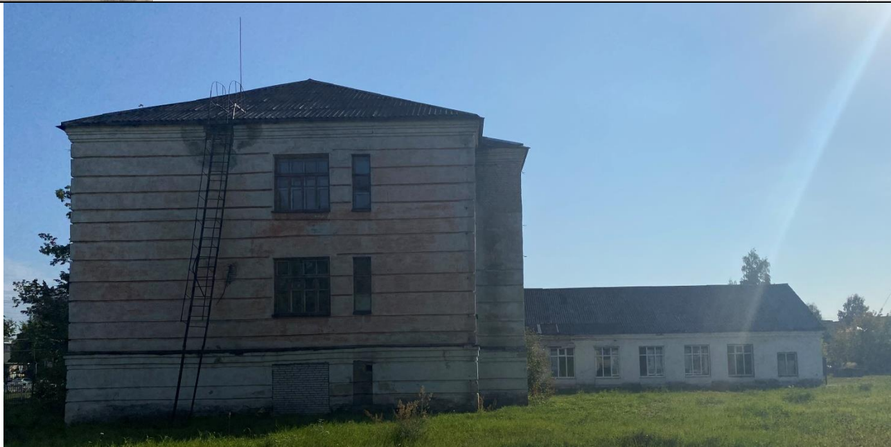
Фот. 4. Вид на торцевой северный фасад
