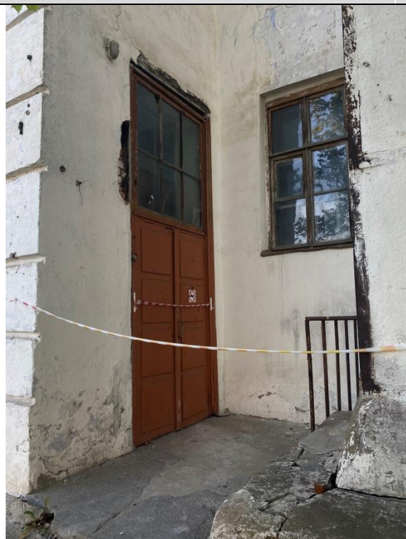
Фот. 9. Фрагмент ризалита, правая лоджия, столярные заполнения
