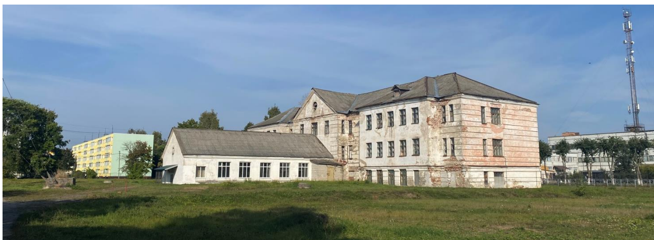
Фот. 2. Общий вид с юго-запада
