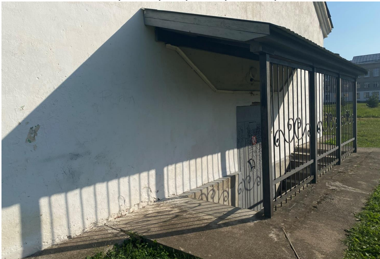
Фот. 17. Вход в пристройку (спортзал)
