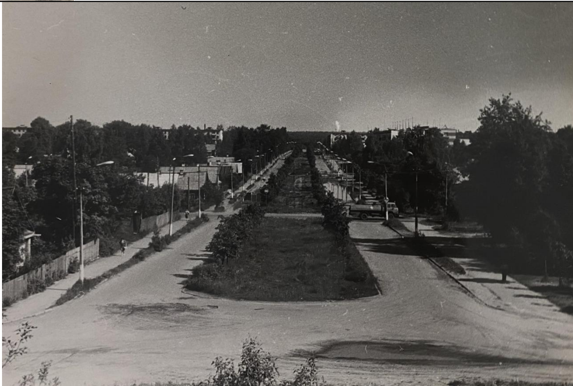
Илл. 17. Ул. Гагарина, вид от железной дороги, 1991 г. г.Лодейное Поле Ленинградской области. Проект зон охраны. Научно-проектная документация. Натурные исследования. Изобразительный материал. Фотофиксация. Копии исторических чертежей. т.2 кн.1. АО "Аринис", 1991 г. Архив КСКН ЛО, Д. 51-2
