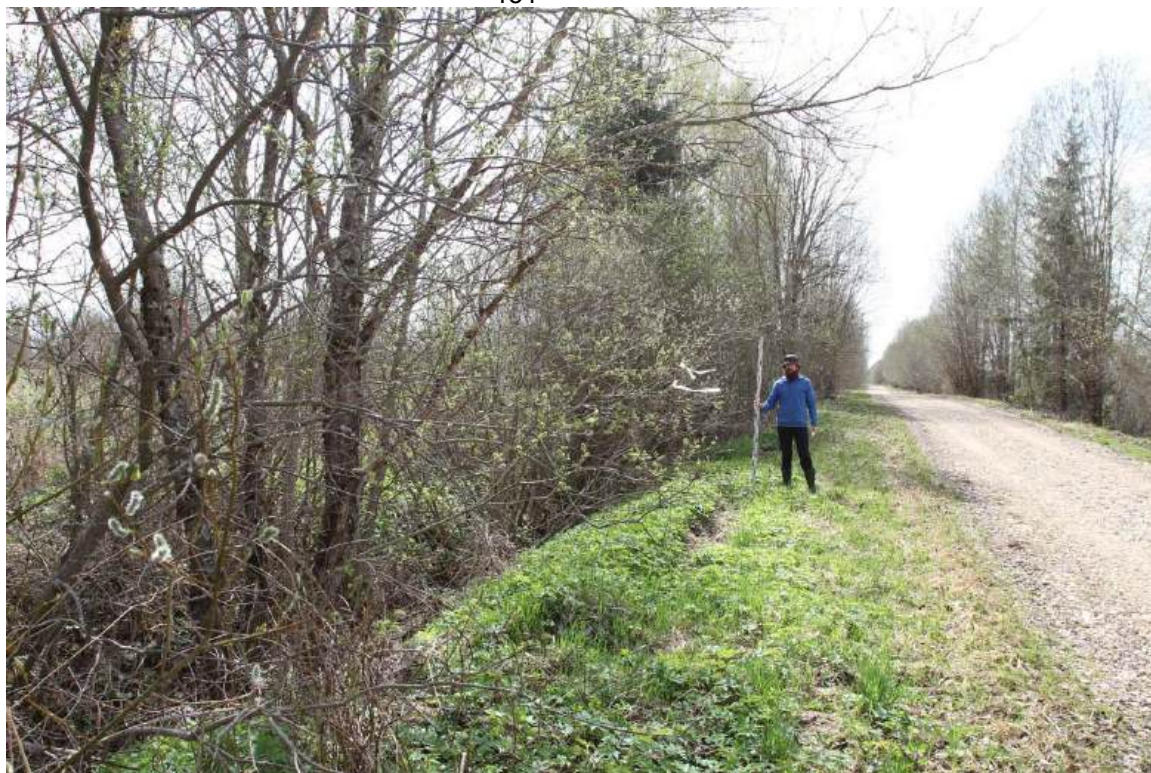
Рис. 101. Ленинградская область. Волосовский район. Большеврудское СП, Сабское СП. Общий вид маршрута трассы проектирования газопровода на расстоянии 1 км к северо-востоку от д. Мышкино (ТС-11). Вид с СВ.
