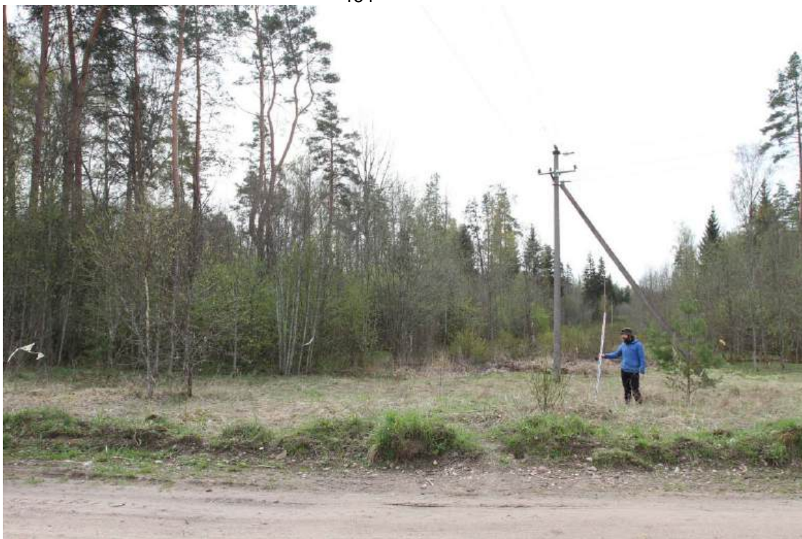
Рис. 106. Ленинградская область. Волосовский район. Большеврудское СП, Сабское СП. Общий вид маршрута трассы проектирования газопровода в месте пересечения с ЛЭП в южной части д. Редкино (ТС-14). Вид с С.
