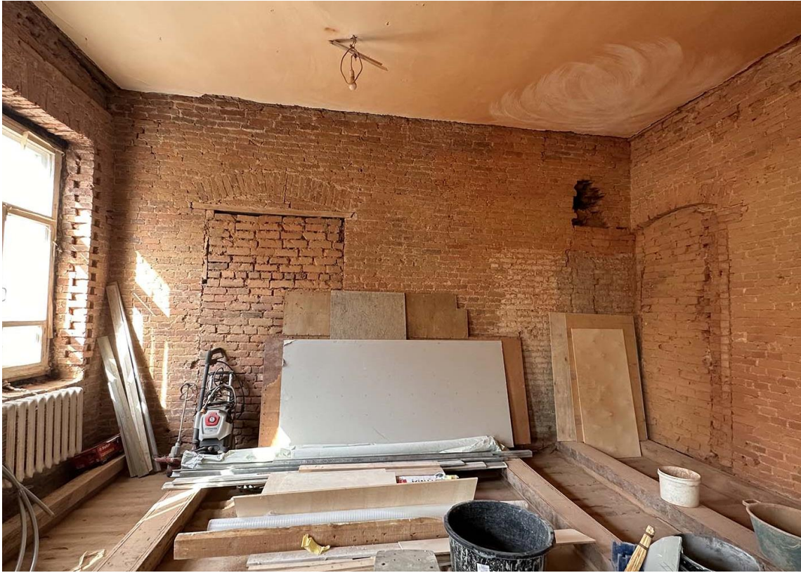
Фото 5. Северо-западная стена помещения кв. № 12. Дата съемки: 26.08.2024 г. Автор съемки: Глинская Н.Б.
