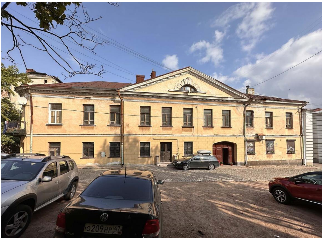
Фото 2. Общий вид лицевого юго-западного фасада. Дата съемки: 26.08.2024 г. Автор съемки: Глинская Н.Б.
