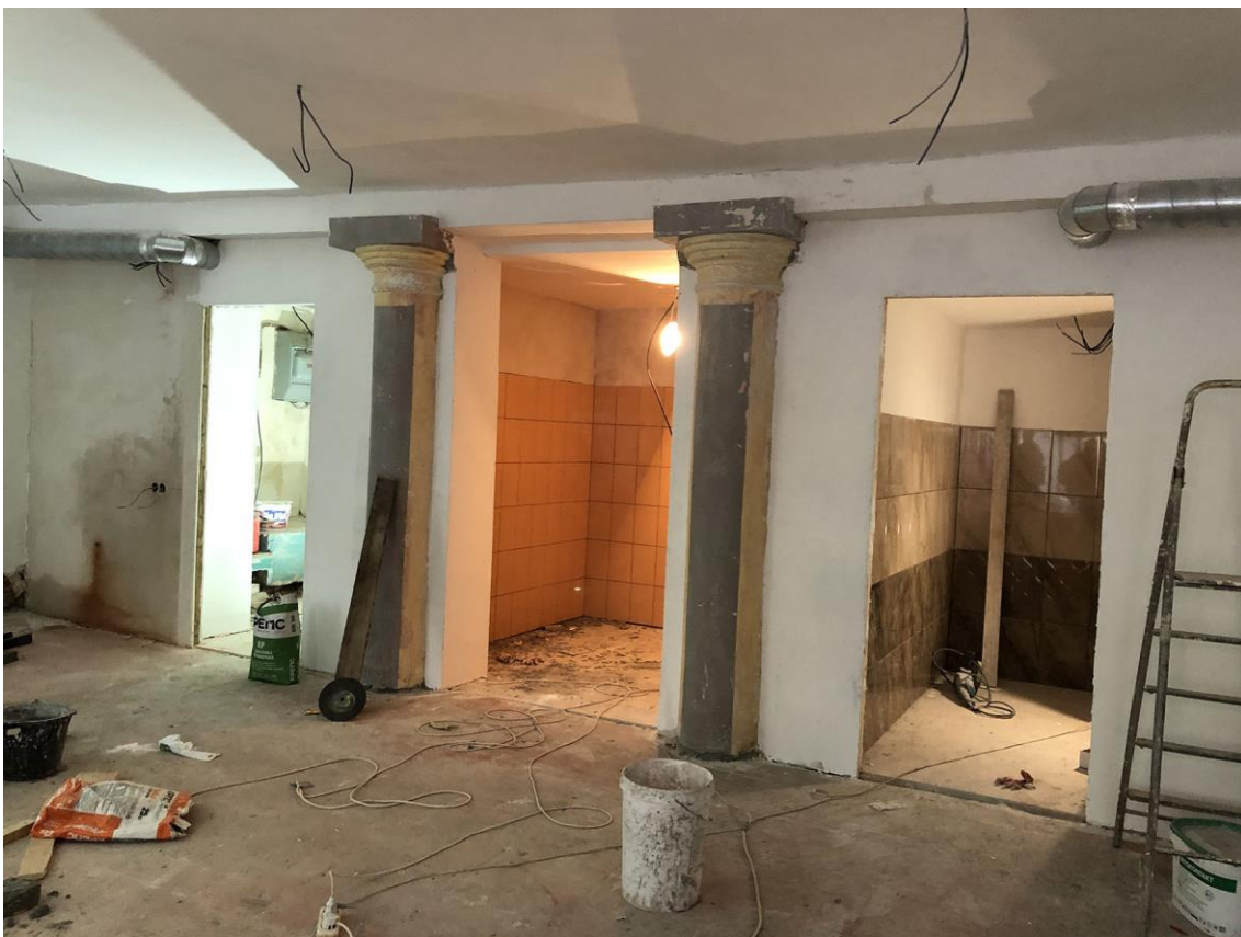
Фото 4. Пом. 1.1. Вид на северо-восточную часть торгового зала. Дата съемки: 22.08.2024 г. Автор съемки: Глинская Н.Б.
