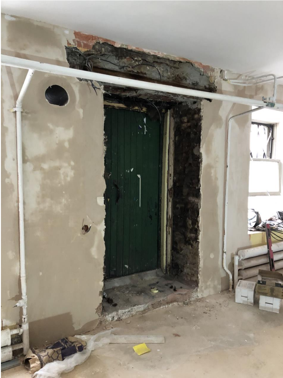
Фото 6. Пом. 1.1. Входной проем. Фото из помещения с востока. Дата съемки: 22.08.2024 г. Автор съемки: Глинская Н.Б.
