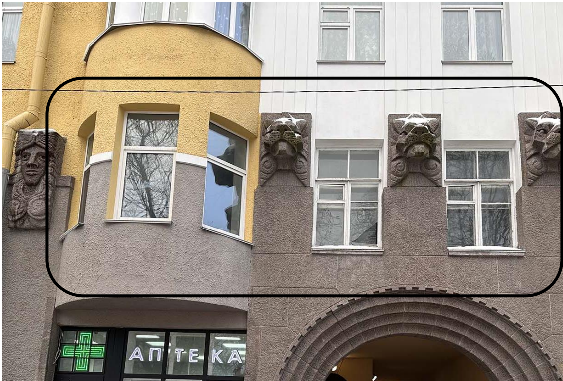
Фото 4. Фрагмент лицевого северо-восточного фасада здания (2-ой этаж), соответствующий помещениям Заказчика. Дата съемки: 01.11.2024 г. Автор съемки: Глинская Н.Б.
