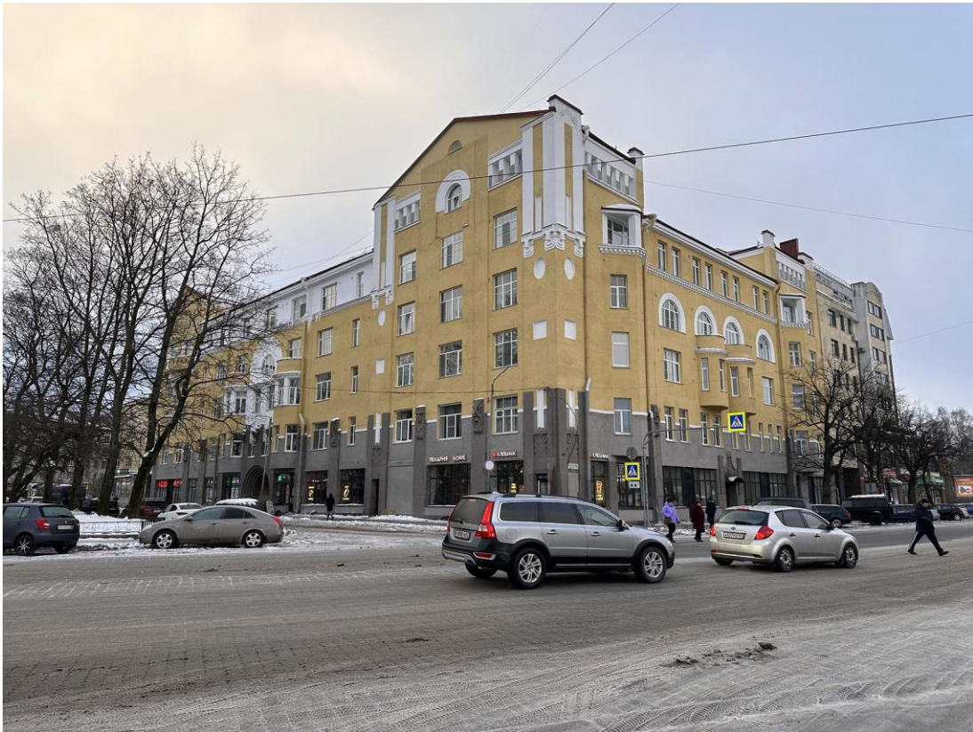
Фото 1. Общий вид здания с севера, со стороны Ленинградского проспекта. Дата съемки: 01.11.2024 г. Автор съемки: Глинская Н.Б.
