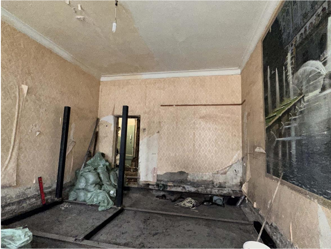
Фото 12. Квартира № 41 (2-ой этаж). Пом. 2.3. Вид на юго-западную часть помещения. Дата съемки: 01.11.2024 г. Автор съемки: Глинская Н.Б.
