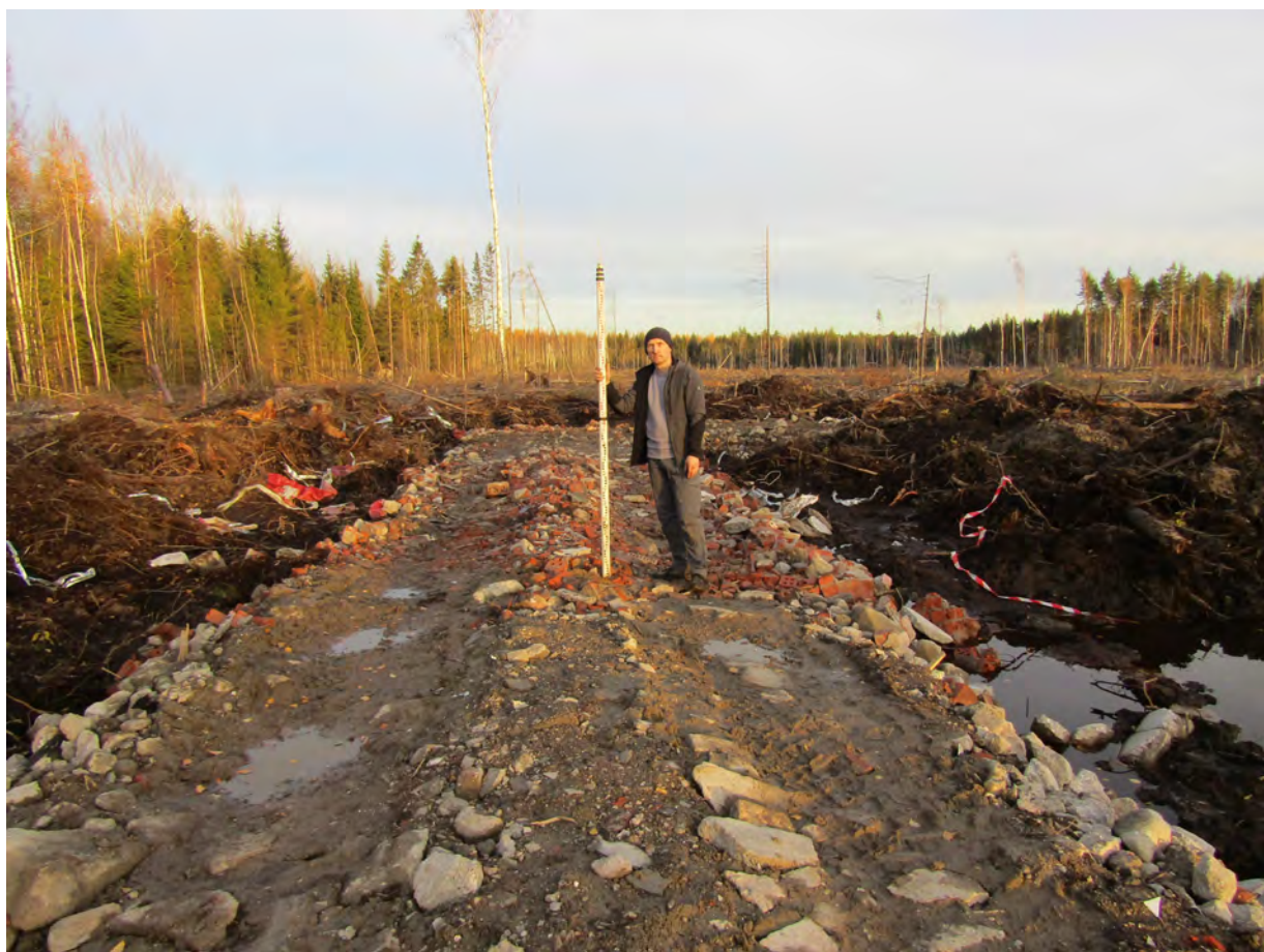
Рисунок 27. «Строительство многоэтажных жилых домов со встроенно-пристроенными помещениями и дошкольной образовательной организации на 235 мест в городе Мурино». Точка фотофиксации № 4. Вид с запада.
