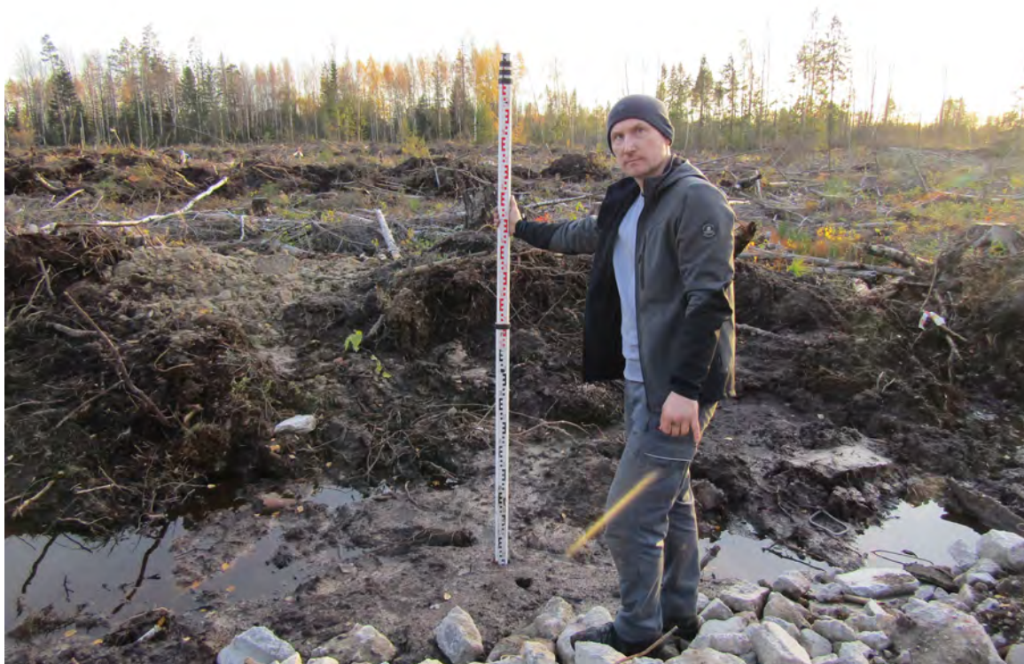
Рисунок 24. «Строительство многоэтажных жилых домов со встроенно-пристроенными помещениями и дошкольной образовательной организации на 235 мест в городе Мурино». Точка фотофиксации № 4. Вид с севера.
