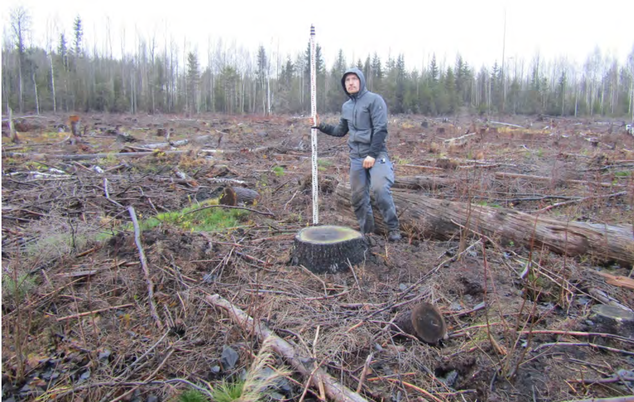
Рисунок 62. «Строительство многоэтажных жилых домов со встроенно-пристроенными помещениями, многоуровневой и плоскостной открытыми наземными стоянками в г. Мурино». Точка фотофиксации № 13. Вид с юга.
