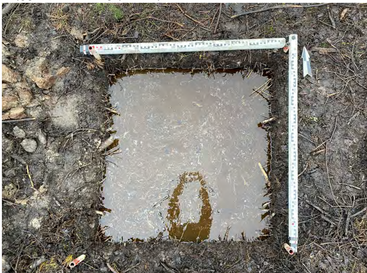
Рисунок 139. «Строительство многоэтажных жилых домов со встроенно-пристроенными помещениями, многоуровневой и плоскостной открытыми наземными стоянками в г. Мурино». Шурф № 7. Вид на раскопанный шурф. Вид с юга.
