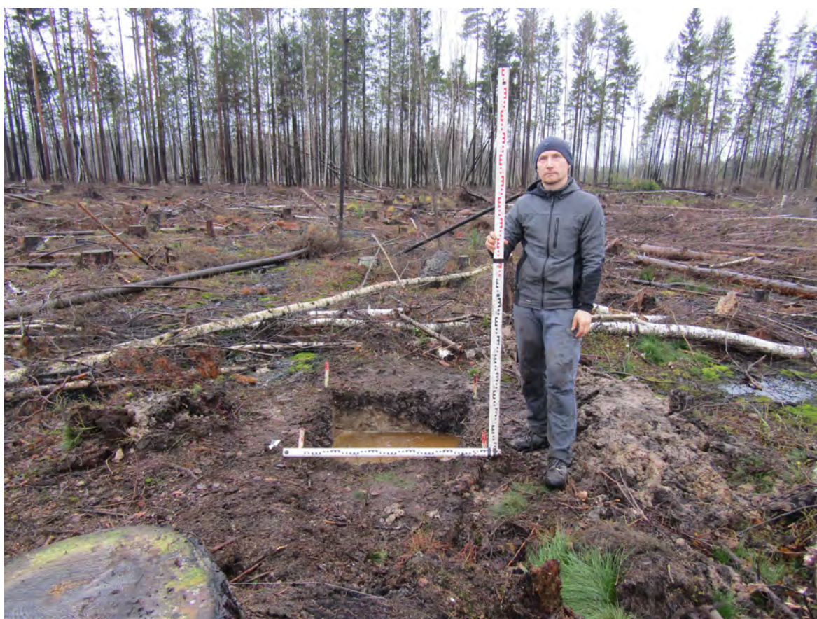
Рисунок 125. «Строительство многоэтажных жилых домов со встроенно-пристроенными помещениями, многоуровневой и плоскостной открытыми наземными стоянками в г. Мурино». Шурф № 6. Общий вид на раскопанный шурф. Вид с севера.
