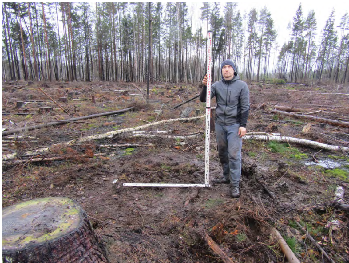
Рисунок 130. «Строительство многоэтажных жилых домов со встроенно-пристроенными помещениями, многоуровневой и плоскостной открытыми наземными стоянками в г. Мурино». Шурф № 6. Вид после окончания работ, засыпки и рекультивации шурфа. Вид с севера.
