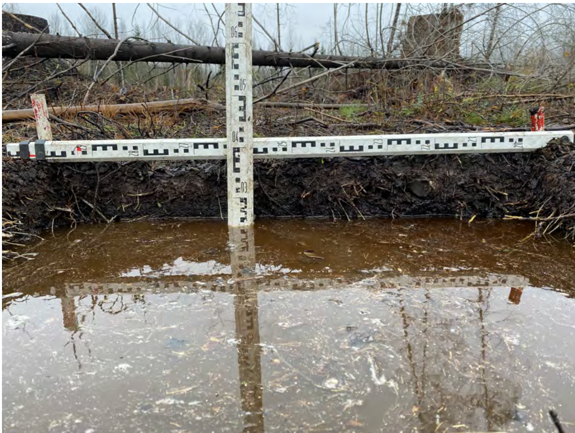
Рисунок 138. «Строительство многоэтажных жилых домов со встроенно-пристроенными помещениями, многоуровневой и плоскостной открытыми наземными стоянками в г. Мурино». Шурф № 7. Вид на северную стенку. Вид с юга.
