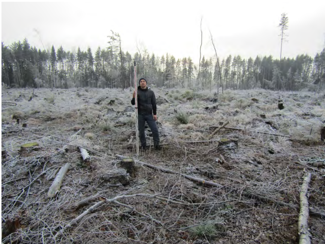
Рисунок 112. «Строительство многоэтажных жилых домов со встроенно-пристроенными помещениями, многоуровневой и плоскостной открытыми наземными стоянками в г. Мурино». Шурф № 5. Вид на место закладки шурфа до начала работ. Вид с севера.
