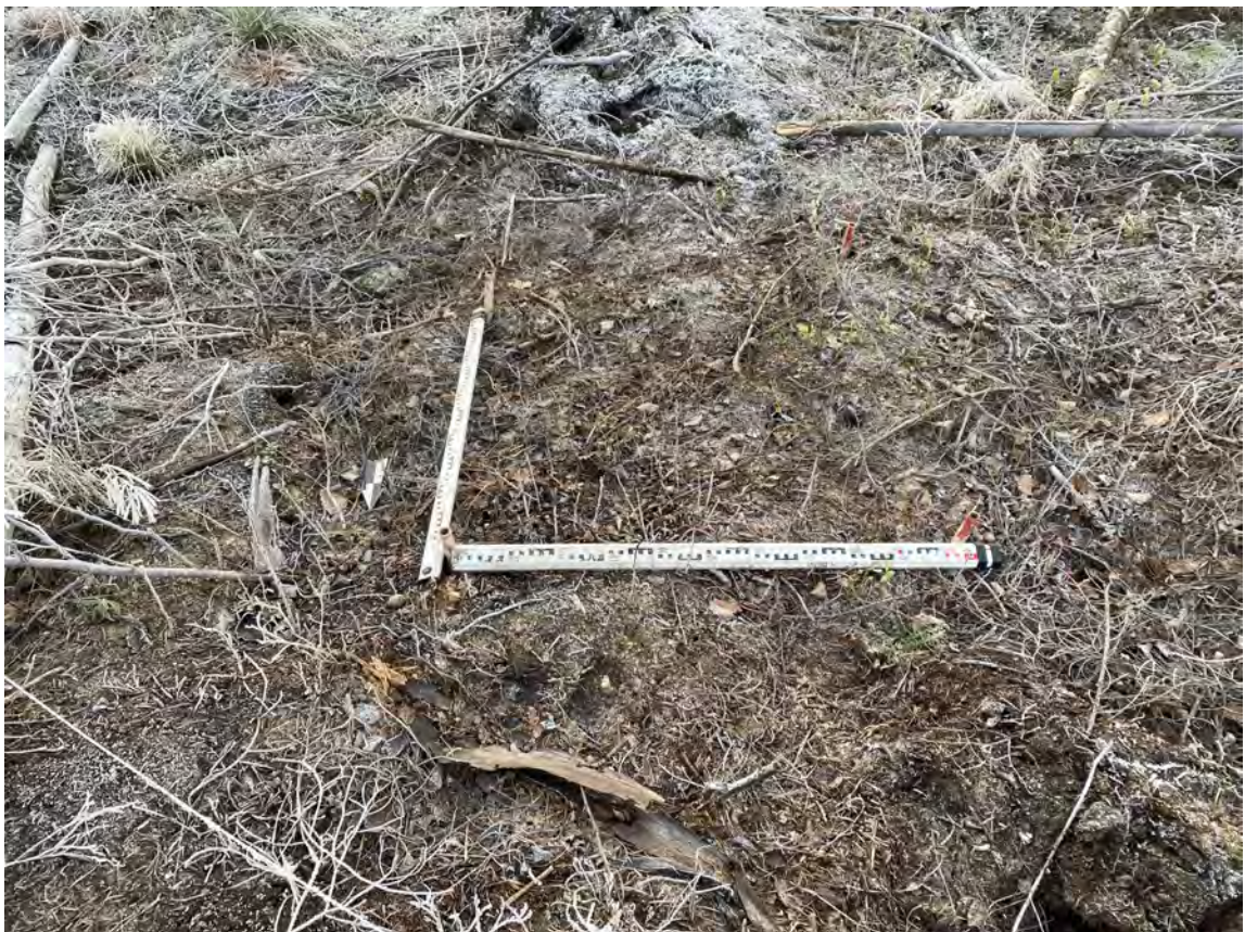
Рисунок 115. «Строительство многоэтажных жилых домов со встроенно-пристроенными помещениями, многоуровневой и плоскостной открытыми наземными стоянками в г. Мурино». Шурф № 5. Вид на размеченный шурф. Вид с севера.
