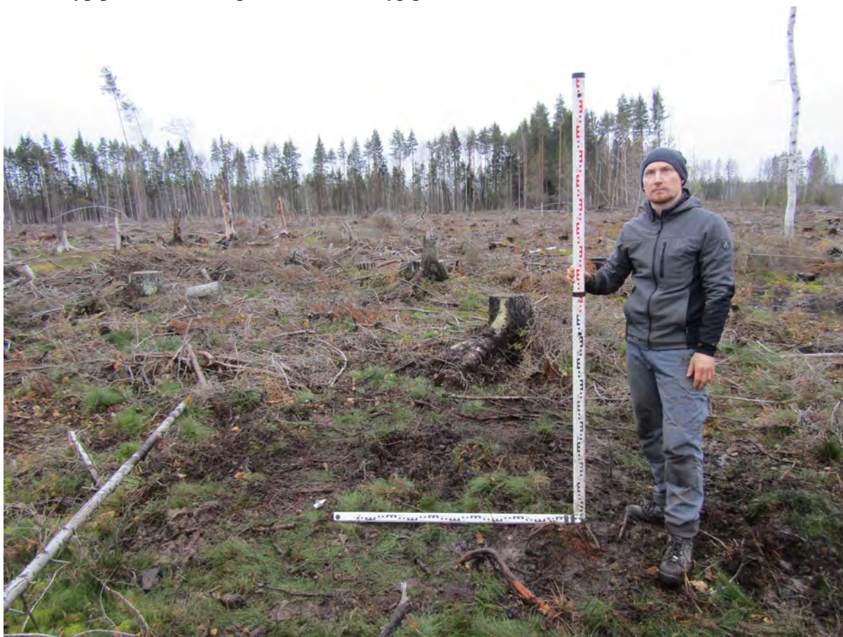
Рисунок 101. «Строительство многоэтажных жилых домов со встроенно-пристроенными помещениями, многоуровневой и плоскостной открытыми наземными стоянками в г. Мурино». Шурф № 3. Вид после окончания работ, засыпки и рекультивации шурфа. Вид с севера.
