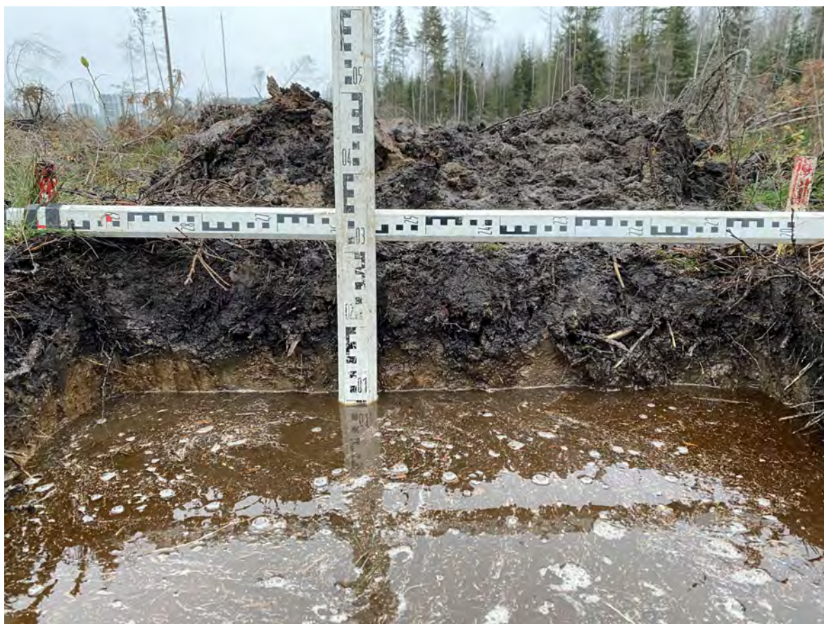
Рисунок 99. «Строительство многоэтажных жилых домов со встроенно-пристроенными помещениями, многоуровневой и плоскостной открытыми наземными стоянками в г. Мурино». Шурф № 3. Вид на западную стенку. Вид с востока.
