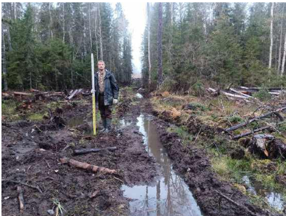
Илл. 373. Ленинградская область, Тосненский район. 2024 г. «Создание высокоскоростной железнодорожной магистрали Санкт-Петербург – Москва (участок Крюково (Алабушево) – Обухово)». «1 этап - Строительство участка Обухово-2 (искл.) - Великий Новгород ВСМ (вкл.)». Общий вид участка обследования. Точка фотофиксации №ЛО-45. Вид с ЮЮВ.
