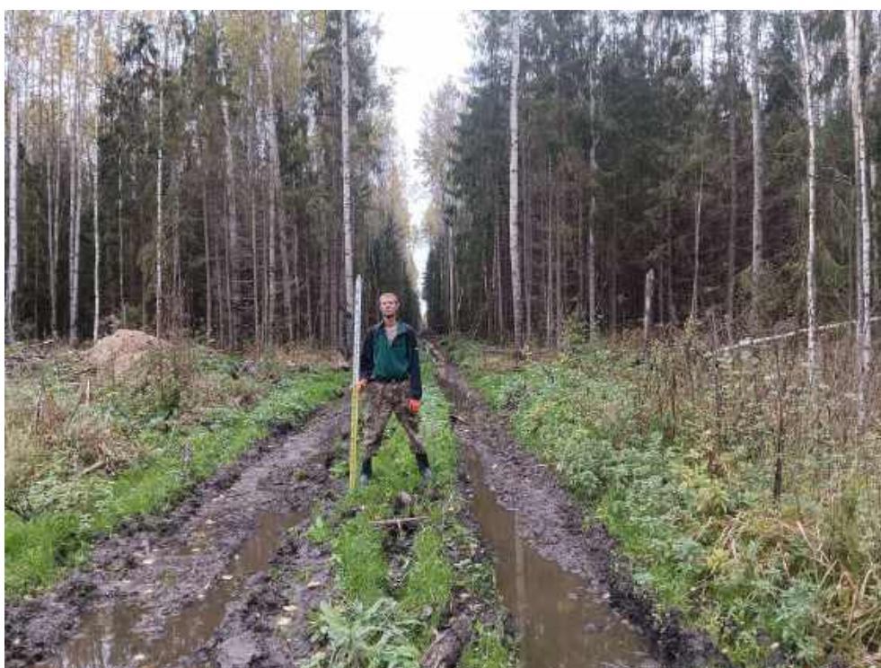
Илл. 215. Ленинградская область, Тосненский район. 2024 г. «Создание высокоскоростной железнодорожной магистрали Санкт-Петербург – Москва (участок Крюково (Алабушево) – Обухово)». «1 этап - Строительство участка Обухово-2 (искл.) - Великий Новгород ВСМ (вкл.)». Общий вид участка обследования. Точка фотофиксации №ЛО-27. Вид с ЮЮВ.
