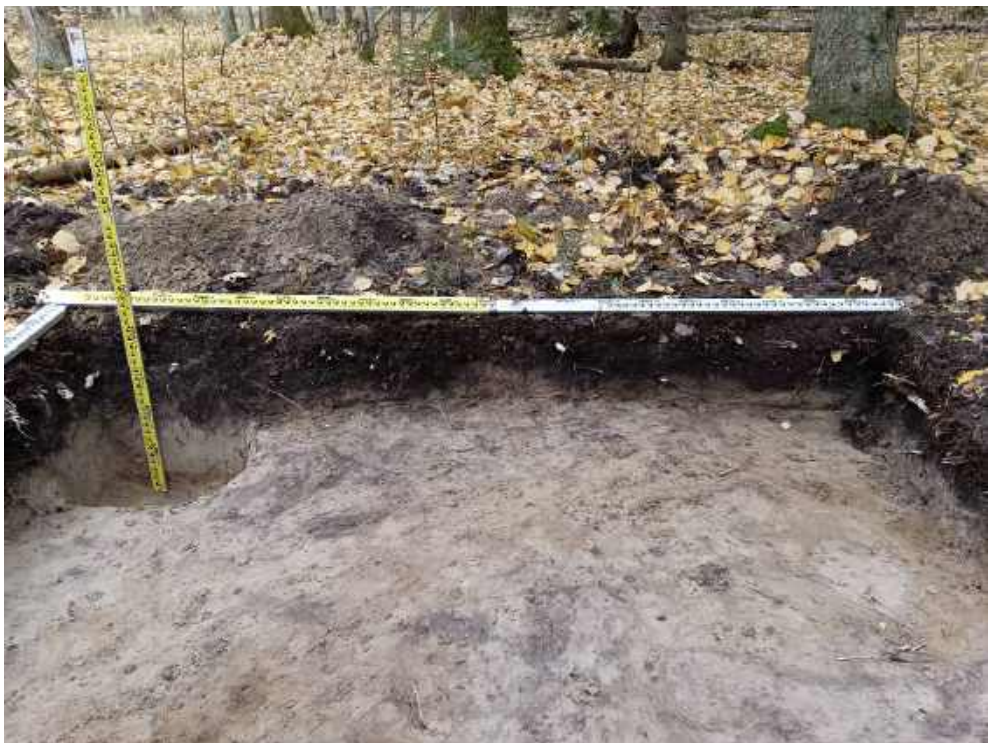
Илл. 507. Ленинградская область, Тосненский район. 2024 г. «Создание высокоскоростной железнодорожной магистрали Санкт-Петербург – Москва (участок Крюково (Алабушево) – Обухово)». «1 этап - Строительство участка Обухово-2 (искл.) - Великий Новгород ВСМ (вкл.)». Шурф №ЛО-52. Северная стенка и контрольный прокоп. Вид с Ю.
