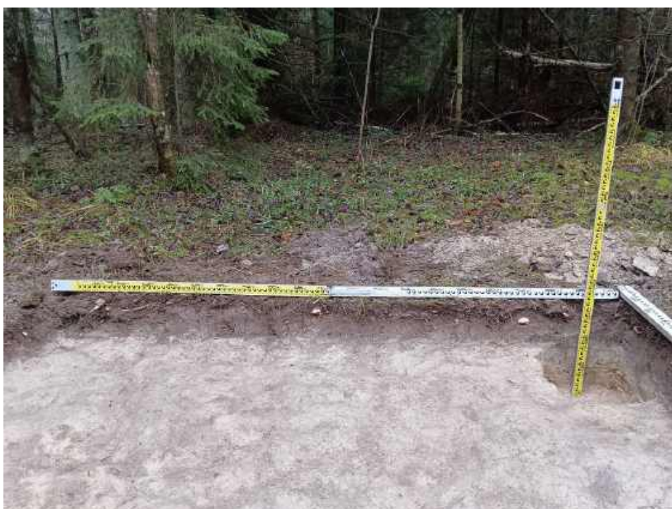
Илл. 161. Ленинградская область, Тосненский район. 2024 г. «Создание высокоскоростной железнодорожной магистрали Санкт-Петербург – Москва (участок Крюково (Алабушево) – Обухово)». «1 этап - Строительство участка Обухово-2 (искл.) - Великий Новгород ВСМ (вкл.)». Шурф №ЛО-19. Северная стенка и контрольный прокоп. Вид с Ю.
