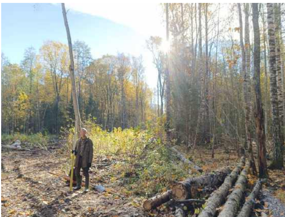
Илл. 530. Ленинградская область, Тосненский район. 2024 г. «Создание высокоскоростной железнодорожной магистрали Санкт-Петербург – Москва (участок Крюково (Алабушево) – Обухово)». «1 этап - Строительство участка Обухово-2 (искл.) - Великий Новгород ВСМ (вкл.)». Общий вид участка обследования. Точка фотофиксации №ЛО-66. Вид с ССЗ.
