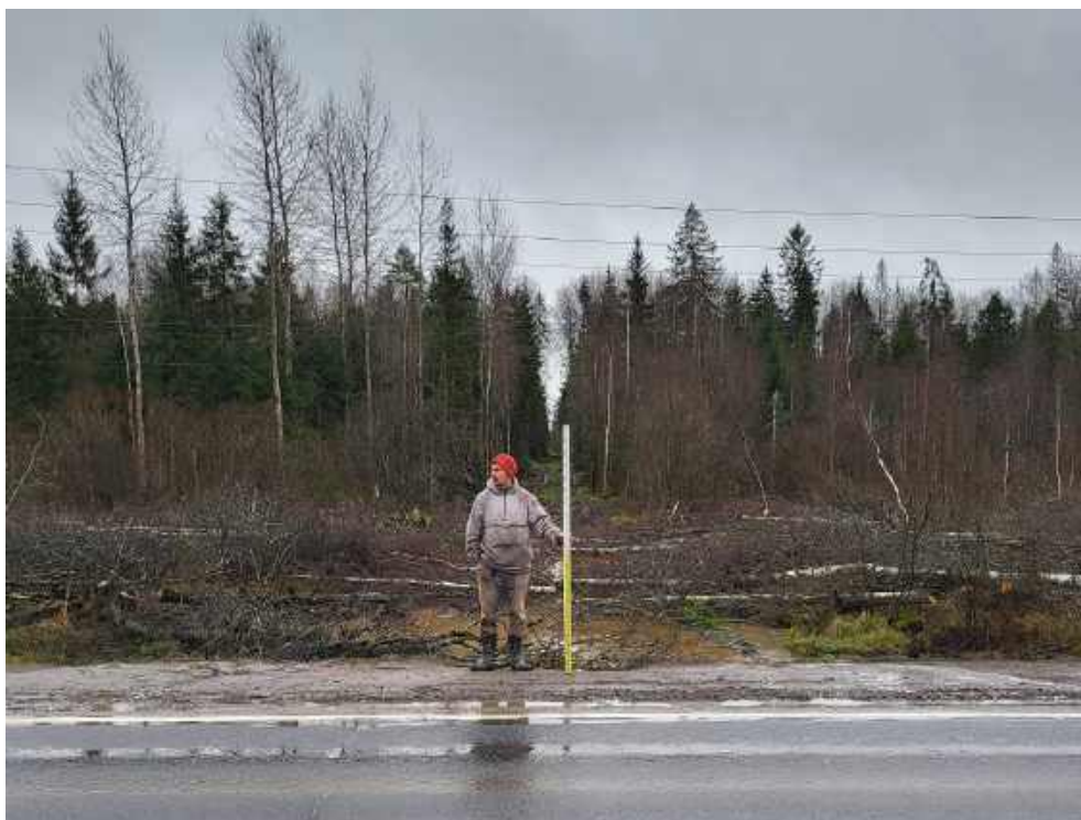
Илл. 202. Ленинградская область, Тосненский район. 2024 г. «Создание высокоскоростной железнодорожной магистрали Санкт-Петербург – Москва (участок Крюково (Алабушево) – Обухово)». «1 этап - Строительство участка Обухово-2 (искл.) - Великий Новгород ВСМ (вкл.)». Общий вид участка обследования. Переход а/д А-120 «Санкт-Петербургское Южное полукольцо». Точка фотофиксации №ЛО-23. Вид с ССЗ.
