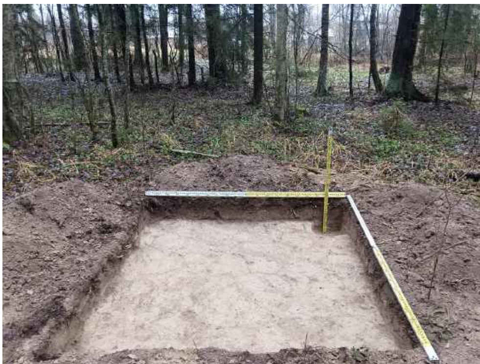
Илл. 83. Ленинградская область, Тосненский район. 2024 г. «Создание высокоскоростной железнодорожной магистрали Санкт-Петербург – Москва (участок Крюково (Алабушево) – Обухово)». «1 этап - Строительство участка Обухово-2 (искл.) - Великий Новгород ВСМ (вкл.)». Шурф №ЛО-11. Зачистка по материк. Общий вид с Ю.
