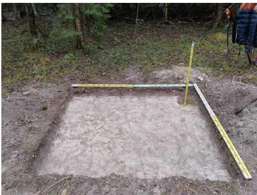
Илл. 159. Ленинградская область, Тосненский район. 2024 г. «Создание высокоскоростной железнодорожной магистрали Санкт-Петербург – Москва (участок Крюково (Алабушево) – Обухово)». «1 этап - Строительство участка Обухово-2 (искл.) - Великий Новгород ВСМ (вкл.)». Шурф №ЛО-19. Зачистка по материке. Общий вид с Ю.
