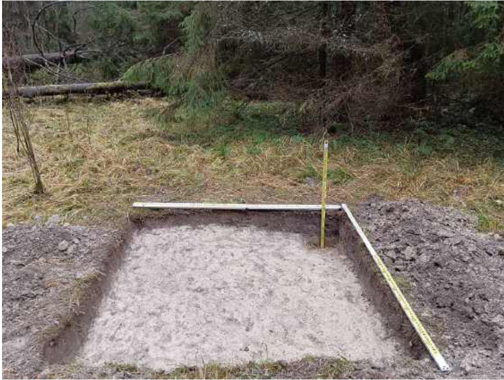
Илл. 134. Ленинградская область, Тосненский район. 2024 г. «Создание высокоскоростной железнодорожной магистрали Санкт-Петербург – Москва (участок Крюково (Алабушево) – Обухово)». «1 этап - Строительство участка Обухово-2 (искл.) - Великий Новгород ВСМ (вкл.)». Шурф №ЛО-16. Зачистка по матерiku. Общий вид с Ю.
