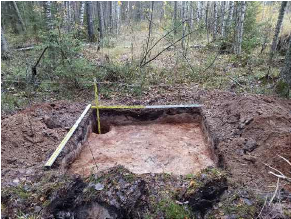
Илл. 551. Ленинградская область, Тосненский район. 2024 г. «Создание высокоскоростной железнодорожной магистрали Санкт-Петербург – Москва (участок Крюково (Алабушево) – Обухово)». «1 этап - Строительство участка Обухово-2 (искл.) - Великий Новгород ВСМ (вкл.)». Шурф №ЛО-55. Зачистка по материке. Общий вид с Ю.
