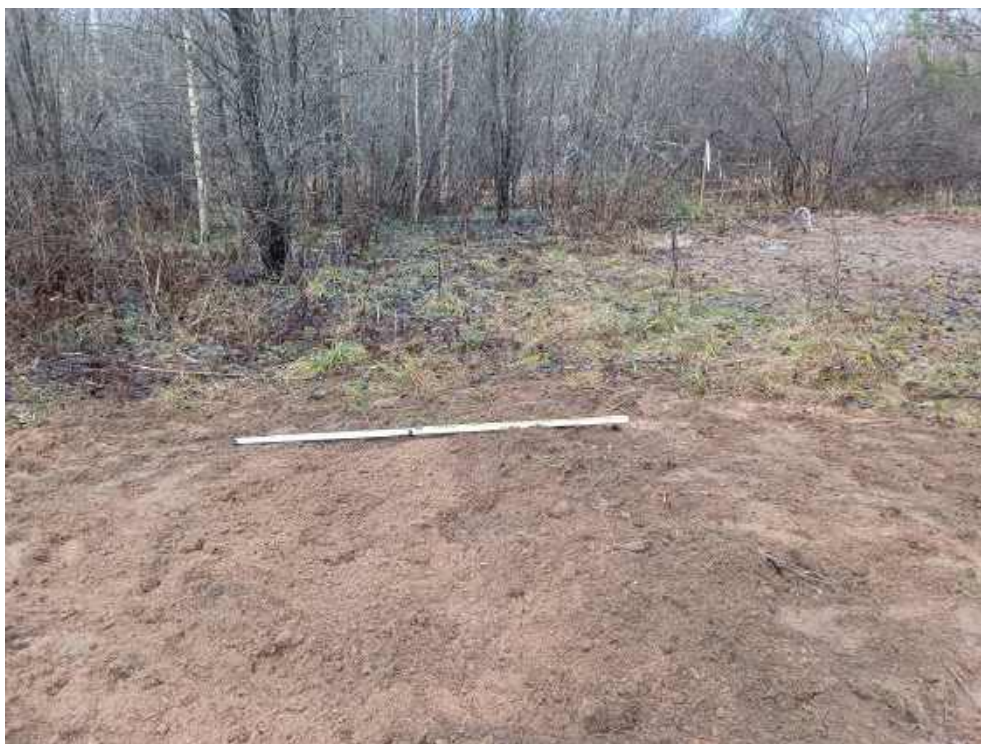
Илл. 327. Ленинградская область, Тосненский район. 2024 г. «Создание высокоскоростной железнодорожной магистрали Санкт-Петербург – Москва (участок Крюково (Алабушево) – Обухово)». «1 этап - Строительство участка Обухово-2 (искл.) - Великий Новгород ВСМ (вкл.)». Шурф №ЛО-34. Рекультивация (засыпка). Вид с Ю.
