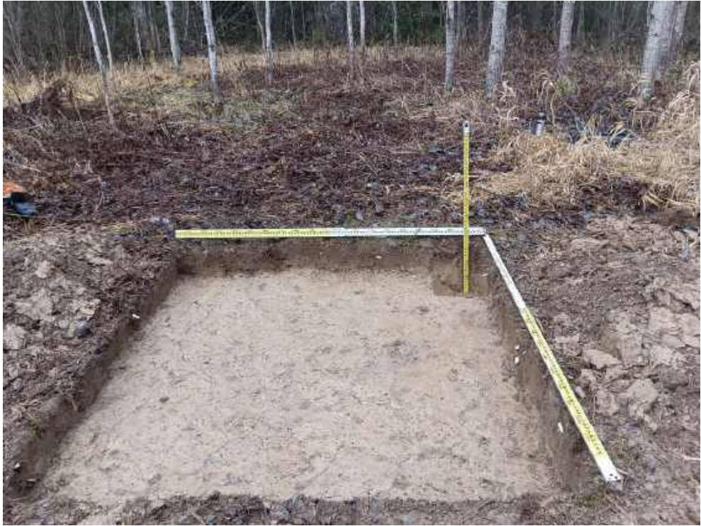
Илл. 458. Ленинградская область, Тосненский район. 2024 г. «Создание высокоскоростной железнодорожной магистрали Санкт-Петербург – Москва (участок Крюково (Алабушево) – Обухово)». «1 этап - Строительство участка Обухово-2 (искл.) - Великий Новгород ВСМ (вкл.)». Шурф №ЛО-47. Зачистка по материке. Общий вид с Ю.
