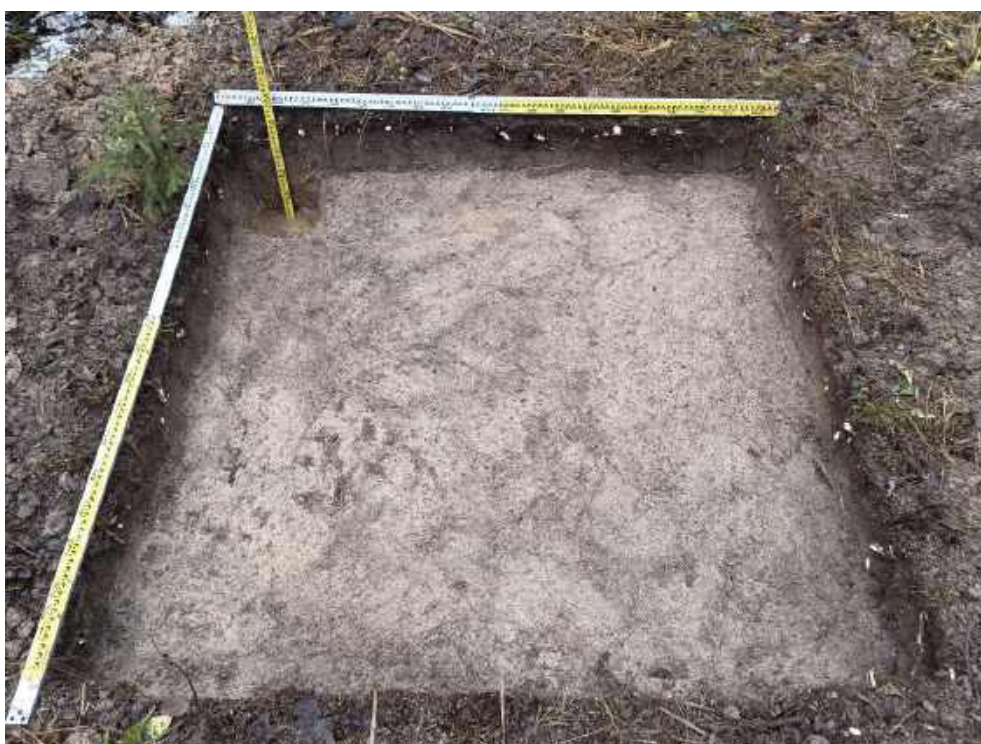
Илл. 294. Ленинградская область, Тосненский район. 2024 г. «Создание высокоскоростной железнодорожной магистрали Санкт-Петербург – Москва (участок Крюково (Алабушево) – Обухово)». «1 этап - Строительство участка Обухово-2 (искл.) - Великий Новгород ВСМ (вкл.)». Шурф №ЛО-31. Материк. Предметный вид с 3.
