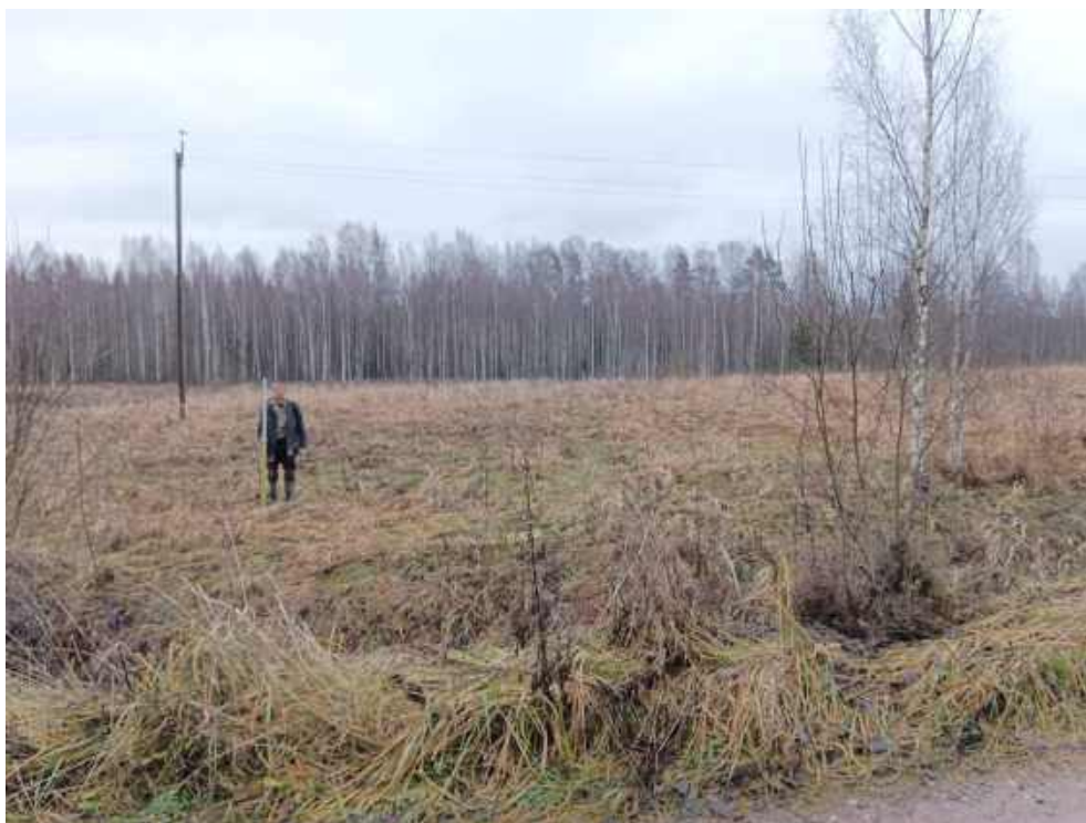
Илл. 391. Ленинградская область, Тосненский район. 2024 г. «Создание высокоскоростной железнодорожной магистрали Санкт-Петербург – Москва (участок Крюково (Алабушево) – Обухово)». «1 этап - Строительство участка Обухово-2 (искл.) - Великий Новгород ВСМ (вкл.)». Общий вид участка обследования. Новый проектируемый подъезд к дер. Турово. Точка фотофиксации №ЛО-49. Вид с ЗЮЗ.
