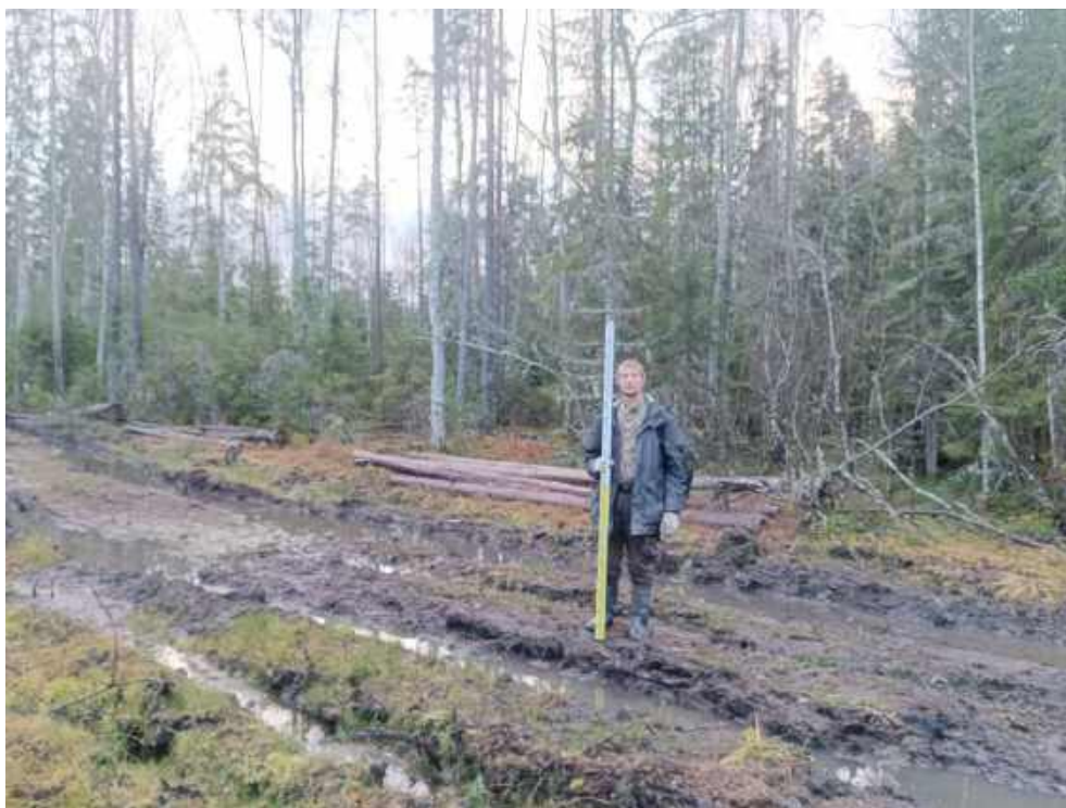
Илл. 375. Ленинградская область, Тосненский район. 2024 г. «Создание высокоскоростной железнодорожной магистрали Санкт-Петербург – Москва (участок Крюково (Алабушево) – Обухово)». «1 этап - Строительство участка Обухово-2 (искл.) - Великий Новгород ВСМ (вкл.)». Общий вид участка обследования. Новая трассировка автодороги «Ушаки – Рублево – Гуммолово». Точка фотофиксации №ЛО-45. Вид с СВ.
