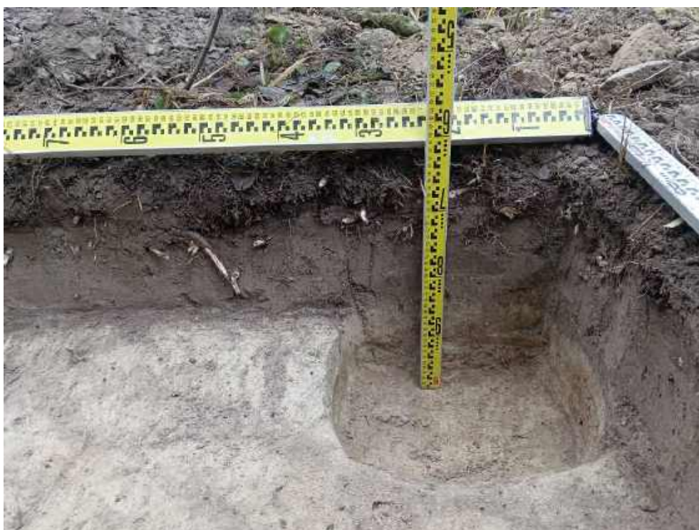
Илл. 86. Ленинградская область, Гостненский район. 2024 г. «Создание высокоскоростной железнодорожной магистрали Санкт-Петербург – Москва (участок Крюково (Алабушево) – Обухово)». «1 этап - Строительство участка Обухово-2 (искл.) - Великий Новгород ВСМ (вкл.)». Шурф №ЛО-11. Контрольный прокоп. Вид с Ю.
