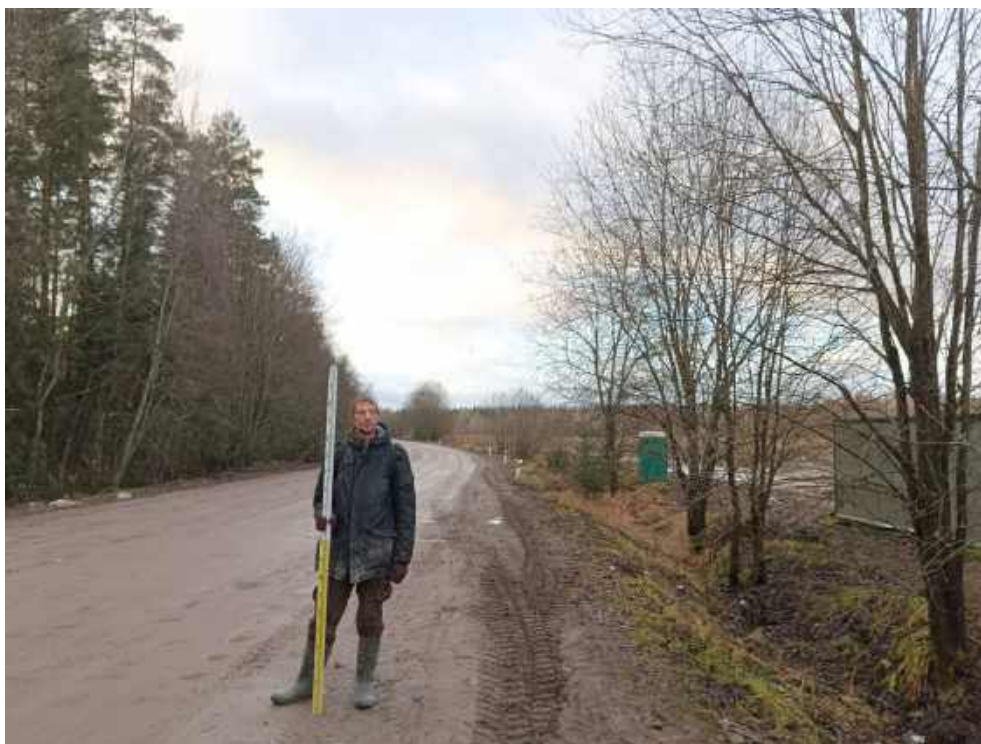
Илл. 371. Ленинградская область, Тосненский район. 2024 г. «Создание высокоскоростной железнодорожной магистрали Санкт-Петербург – Москва (участок Крюково (Алабушево) – Обухово)». «1 этап - Строительство участка Обухово-2 (искл.) - Великий Новгород ВСМ (вкл.)». Общий вид участка обследования. Реконструкция автодороги «Ушаки – Рублево – Гуммолowo». Точка фотофиксации №ЛО-44. Вид с СВ.
