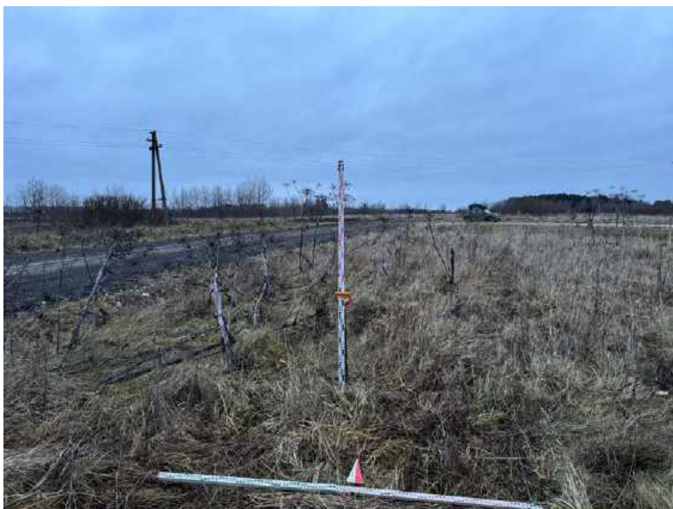
Илл. 52. Ленинградская область, Госненский район. 2024 г. «Создание высокоскоростной железнодорожной магистрали Санкт-Петербург – Москва (участок Крюково (Алабушево) – Обухово)». «1 этап - Строительство участка Обухово-2 (искл.) - Великий Новгород ВСМ (вкл.)». Шурф №ЛО-6. Местоположение. Вид с Ю.
