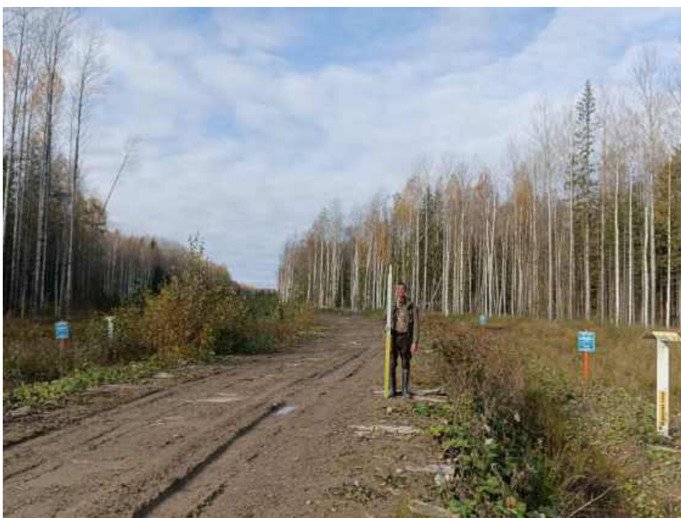
Илл. 540. Ленинградская область, Тосненский район. 2024 г. «Создание высокоскоростной железнодорожной магистрали Санкт-Петербург – Москва (участок Крюково (Алабушево) – Обухово)». «1 этап - Строительство участка Обухово-2 (искл.) - Великий Новгород ВСМ (вкл.)». Общий вид участка обследования. Конец участка перетрассировки Северо-Европейского газопровода (СЕГ-3 ПК 648,72; СЕГ-4 ПК 648,83). Точка фотофиксации №ЛО-68. Вид с ВЮВ.
