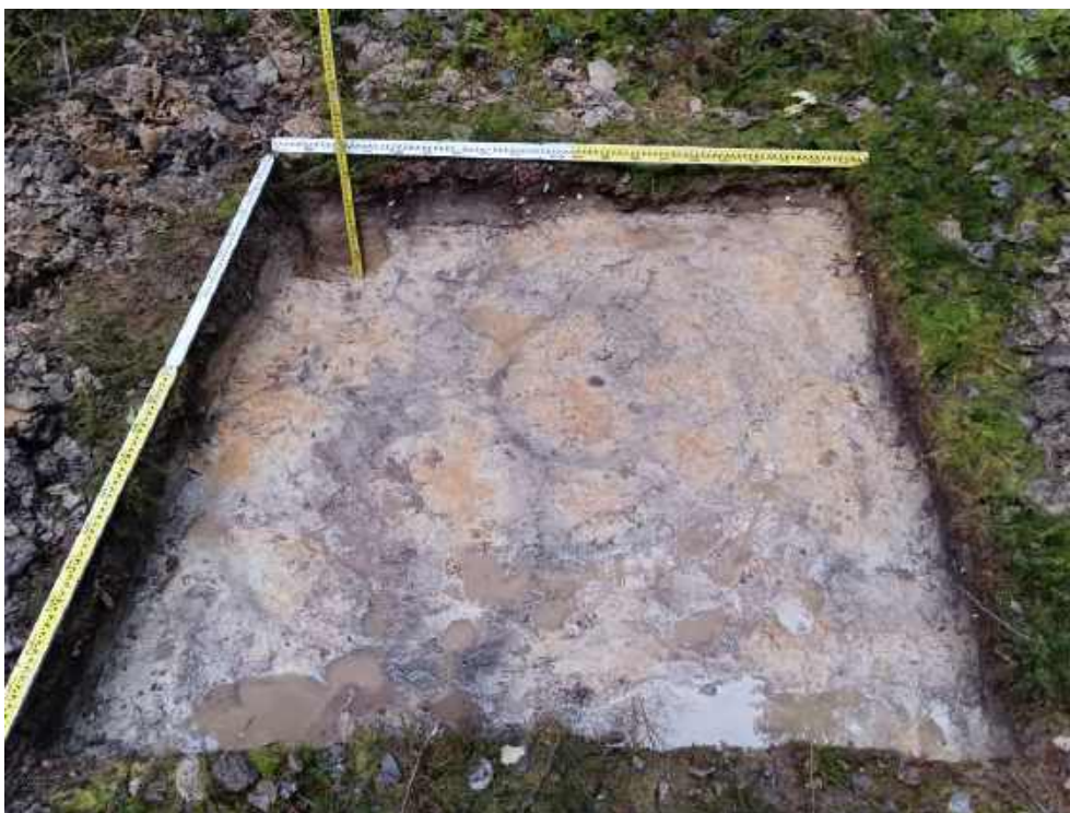
Илл. 561. Ленинградская область, Тосненский район. 2024 г. «Создание высокоскоростной железнодорожной магистрали Санкт-Петербург – Москва (участок Крюково (Алабушево) – Обухово)». «1 этап - Строительство участка Обухово-2 (искл.) - Великий Новгород ВСМ (вкл.)». Шурф №ЛО-56. Материк. Предметный вид с Ю.
