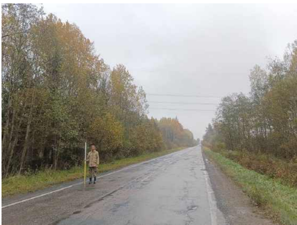
Илл. 235. Ленинградская область, Тосненский район. 2024 г. «Создание высокоскоростной железнодорожной магистрали Санкт-Петербург – Москва (участок Крюково (Алабушево) – Обухово)». «1 этап - Строительство участка Обухово-2 (искл.) - Великий Новгород ВСМ (вкл.)». Общий вид участка обследования. Автодорога «Поги – Новолисино». Точка фотофиксации №ЛО-29. Вид с ЗЮЗ.
