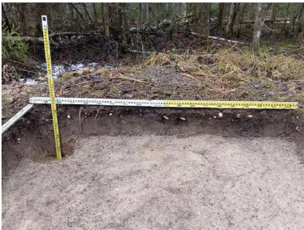
Илл. 295. Ленинградская область, Тосненский район. 2024 г. «Создание высокоскоростной железнодорожной магистрали Санкт-Петербург – Москва (участок Крюково (Алабушево) – Обухово)». «1 этап - Строительство участка Обухово-2 (искл.) - Великий Новгород ВСМ (вкл.)». Шурф №ЛО-31. Восточная стенка и контрольный прокоп. Вид с 3.
