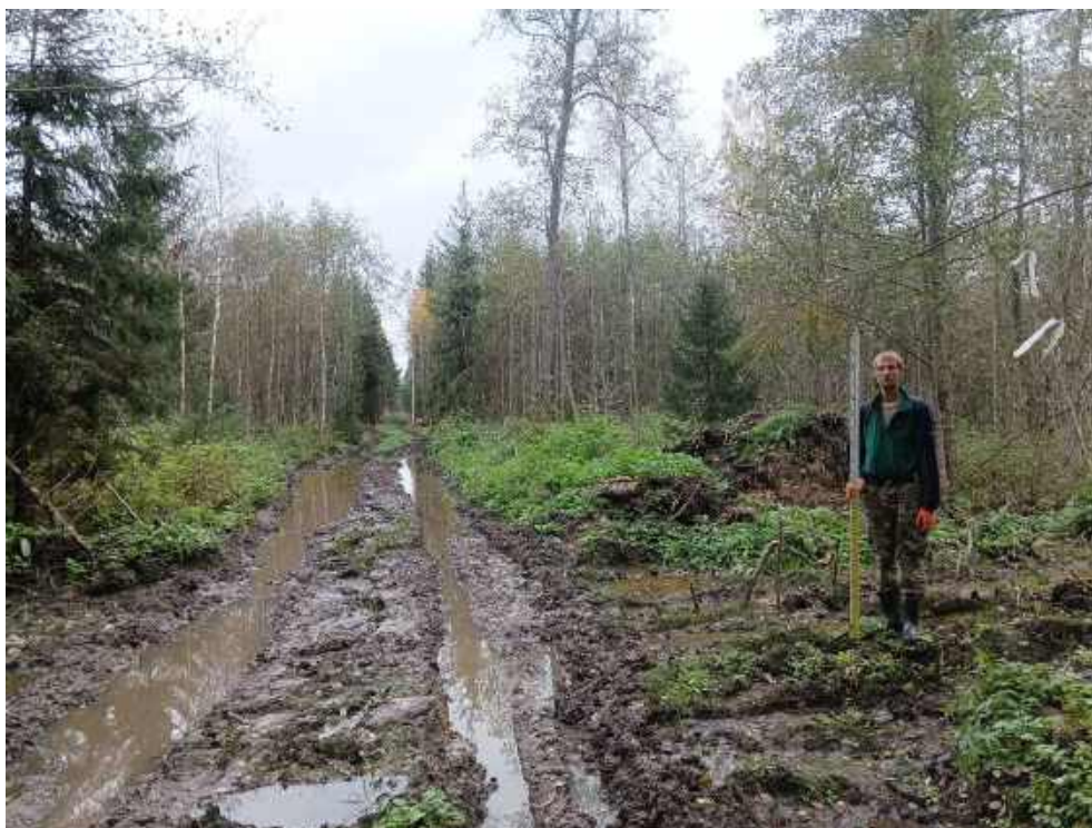
Илл. 204. Ленинградская область, Тосненский район. 2024 г. «Создание высокоскоростной железнодорожной магистрали Санкт-Петербург – Москва (участок Крюково (Алабушево) – Обухово)». «1 этап - Строительство участка Обухово-2 (искл.) - Великий Новгород ВСМ (вкл.)». Общий вид участка обследования. Точка фотофиксации №ЛО-25. Вид с ЮЮВ.
