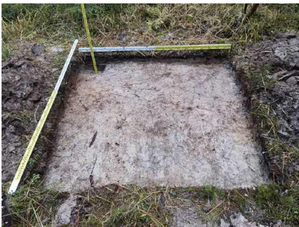
Илл. 211. Ленинградская область, Тосненский район. 2024 г. «Создание высокоскоростной железнодорожной магистрали Санкт-Петербург – Москва (участок Крюково (Алабушево) – Обухово)». «1 этап - Строительство участка Обухово-2 (искл.) - Великий Новгород ВСМ (вкл.)». Шурф №ЛО-23. Материк. Предметный вид с Ю.
