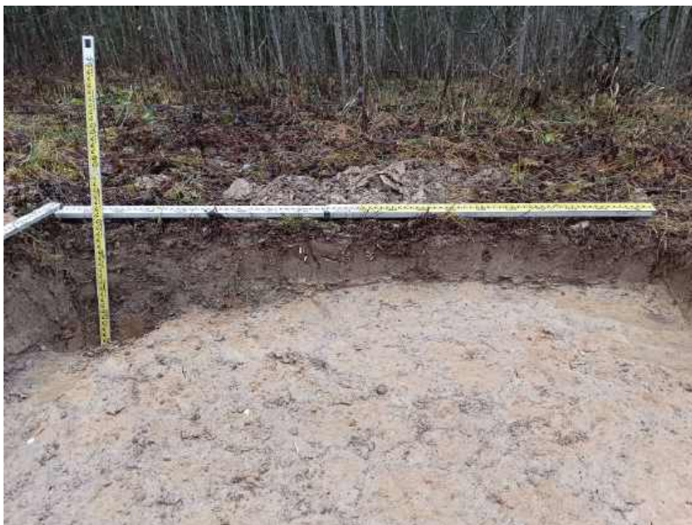
Илл. 399. Ленинградская область, Тосненский район. 2024 г. «Создание высокоскоростной железнодорожной магистрали Санкт-Петербург – Москва (участок Крюково (Алабушево) – Обухово)». «1 этап - Строительство участка Обухово-2 (искл.) - Великий Новгород ВСМ (вкл.)». Шурф №ЛО-41. Северная стенка и контрольный прокоп. Вид с Ю.
