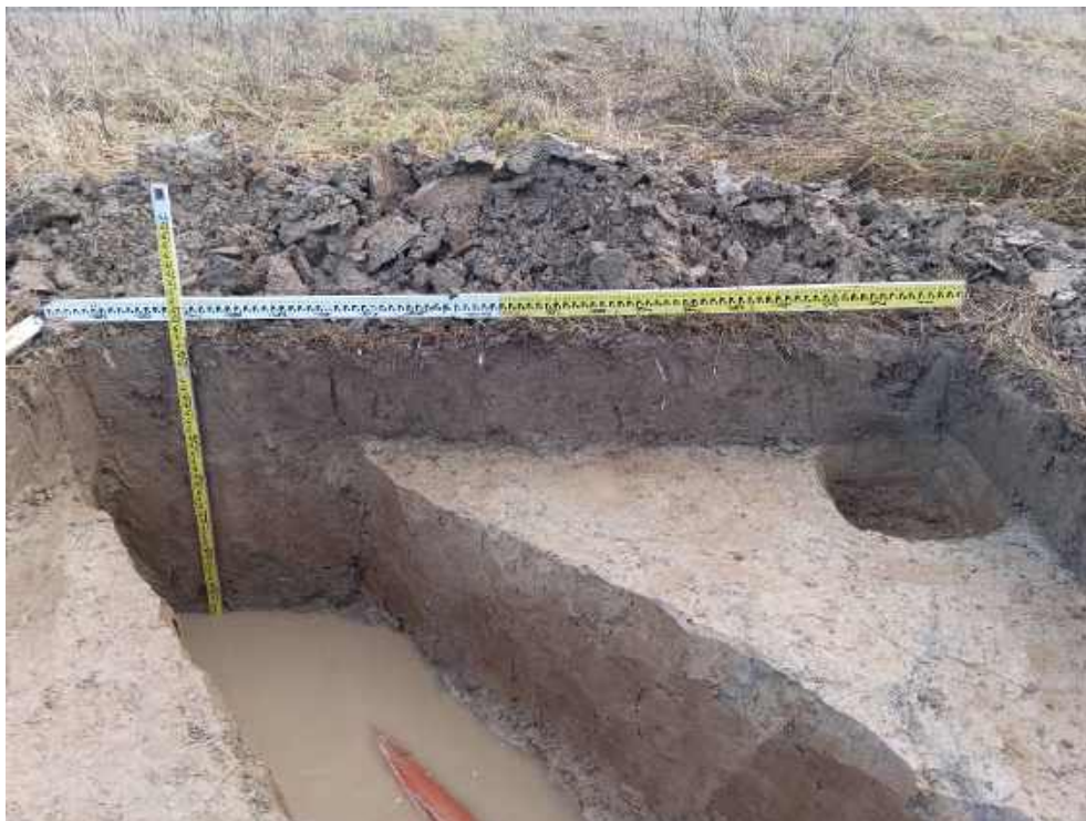
Илл. 354. Ленинградская область, Тосненский район. 2024 г. «Создание высокоскоростной железнодорожной магистрали Санкт-Петербург – Москва (участок Крюково (Алабушево) – Обухово)». «1 этап - Строительство участка Обухово-2 (искл.) - Великий Новгород ВСМ (вкл.)». Шурф №ЛО-38. Юго-восточная стенка и контрольный прокоп. Вид с СЗ.
