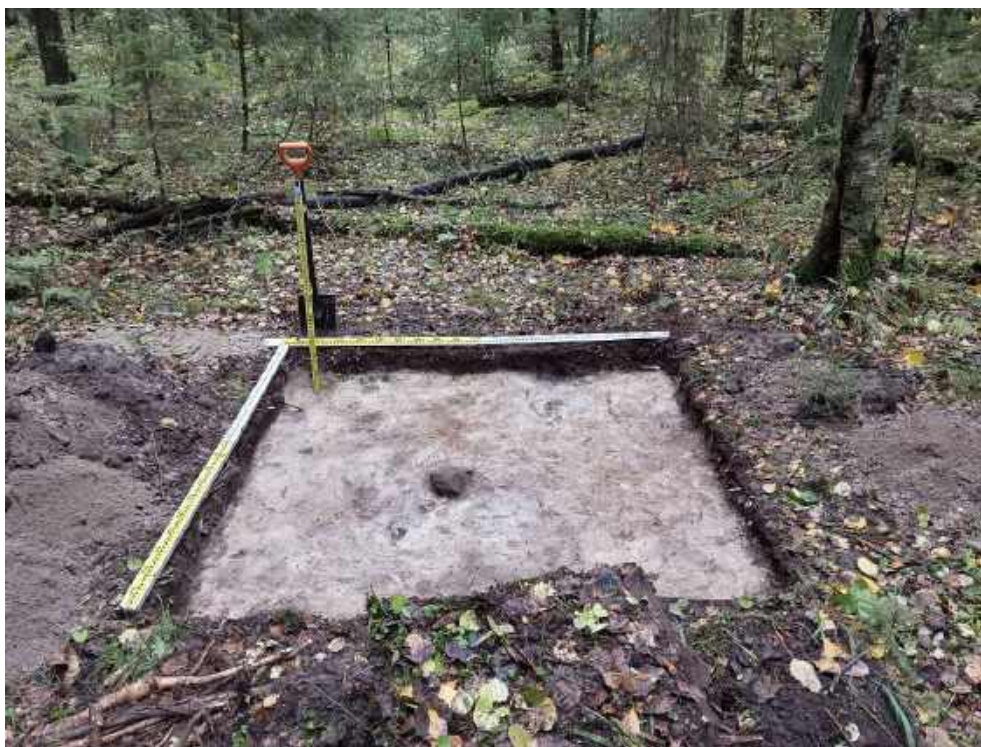
Илл. 230. Ленинградская область, Тосненский район. 2024 г. «Создание высокоскоростной железнодорожной магистрали Санкт-Петербург – Москва (участок Крюково (Алабушево) – Обухово)». «1 этап - Строительство участка Обухово-2 (искл.) - Великий Новгород ВСМ (вкл.)». Шурф №ЛО-25. Зачистка по материке. Общий вид с Ю.
