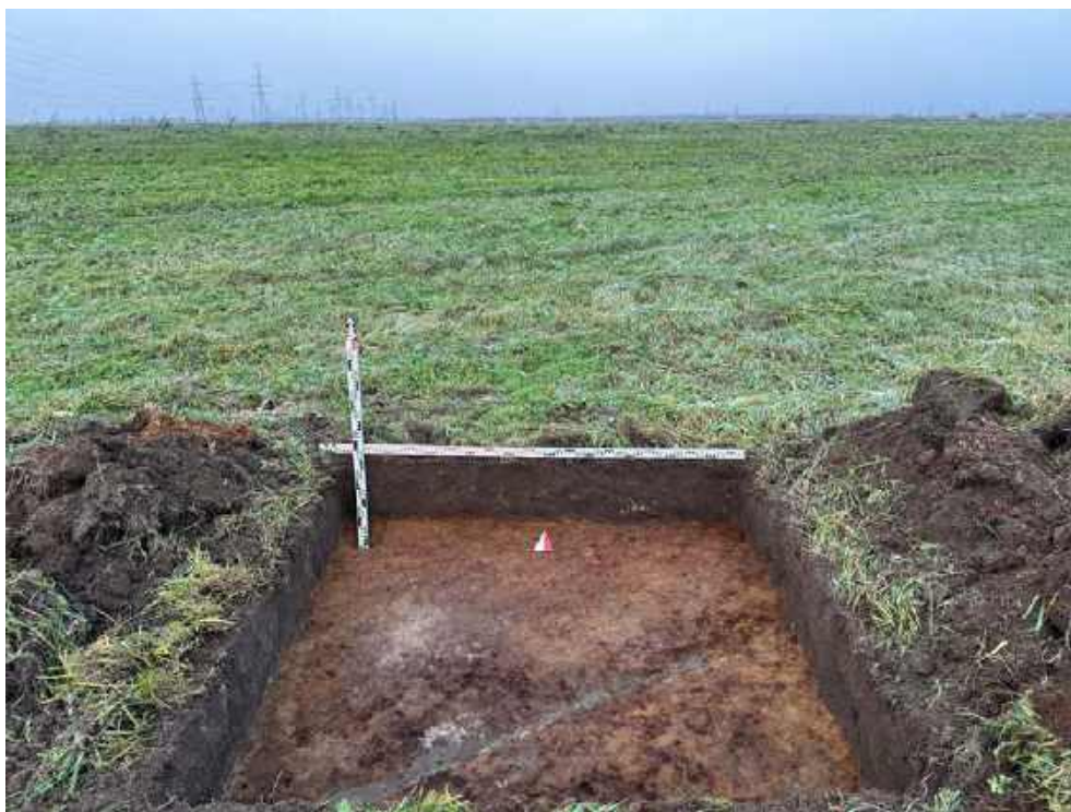
Илл. 21. Ленинградская область, Тосненский район. 2024 г. «Создание высокоскоростной железнодорожной магистрали Санкт-Петербург – Москва (участок Крюково (Алабушево) – Обухово)». «1 этап - Строительство участка Обухово-2 (искл.) - Великий Новгород ВСМ (вкл.)». Шурф №ЛО-2. Зачистка по материке. Общий вид с Ю.
