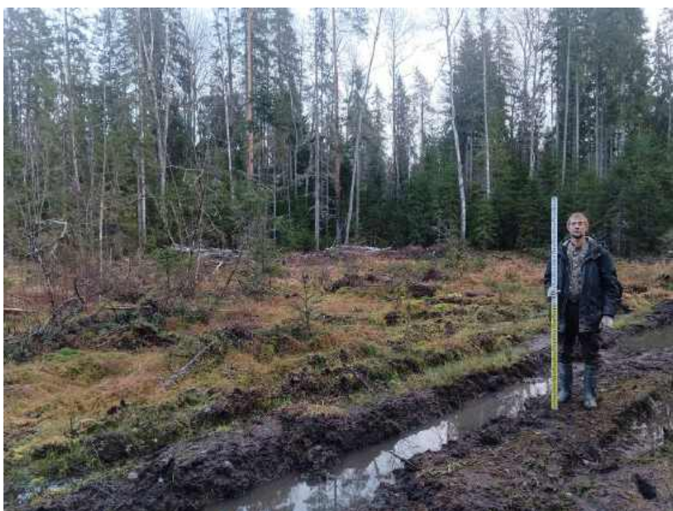
Илл. 374. Ленинградская область, Тосненский район. 2024 г. «Создание высокоскоростной железнодорожной магистрали Санкт-Петербург – Москва (участок Крюково (Алабушево) – Обухово)». «1 этап - Строительство участка Обухово-2 (искл.) - Великий Новгород ВСМ (вкл.)». Общий вид участка обследования. Новая трассировка автодороги «Ушаки – Рублево – Гуммолово». Точка фотофиксации №ЛО-45. Вид с З.
