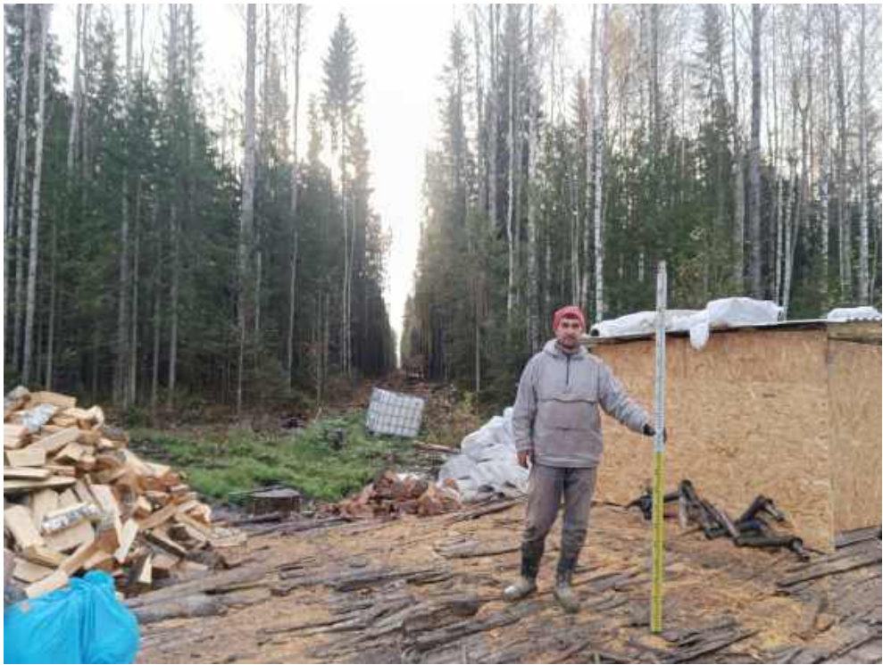
Илл. 492. Ленинградская область, Тосненский район. 2024 г. «Создание высокоскоростной железнодорожной магистрали Санкт-Петербург – Москва (участок Крюково (Алабушево) – Обухово)». «1 этап - Строительство участка Обухово-2 (искл.) - Великий Новгород ВСМ (вкл.)». Общий вид участка обследования. Точка фотофиксации №ЛО-60. Вид с ССЗ.
