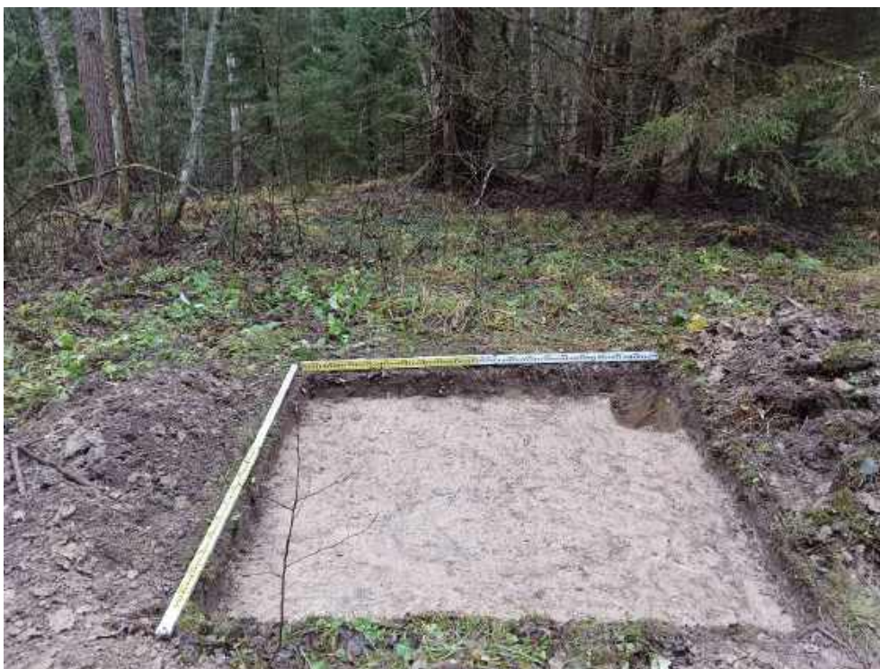
Илл. 118. Ленинградская область, Тосненский район. 2024 г. «Создание высокоскоростной железнодорожной магистрали Санкт-Петербург – Москва (участок Крюково (Алабушево) – Обухово)». «1 этап - Строительство участка Обухово-2 (искл.) - Великий Новгород ВСМ (вкл.)». Шурф №ЛО-14. Зачистка по материке. Общий вид с В.
