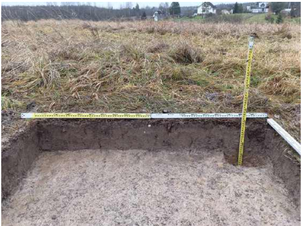
Илл. 314. Ленинградская область, Тосненский район. 2024 г. «Создание высокоскоростной железнодорожной магистрали Санкт-Петербург – Москва (участок Крюково (Алабушево) – Обухово)». «1 этап - Строительство участка Обухово-2 (искл.) - Великий Новгород ВСМ (вкл.)». Шурф №ЛО-33. Южная стенка и контрольный прокоп. Вид с С.
