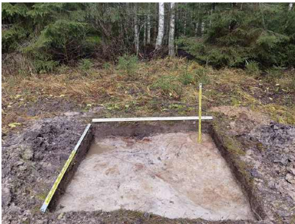
Илл. 273. Ленинградская область, Тосненский район. 2024 г. «Создание высокоскоростной железнодорожной магистрали Санкт-Петербург – Москва (участок Крюково (Алабушево) – Обухово)». «1 этап - Строительство участка Обухово-2 (искл.) - Великий Новгород ВСМ (вкл.)». Шурф №ЛО-29. Зачистка по материке. Общий вид с 3.
