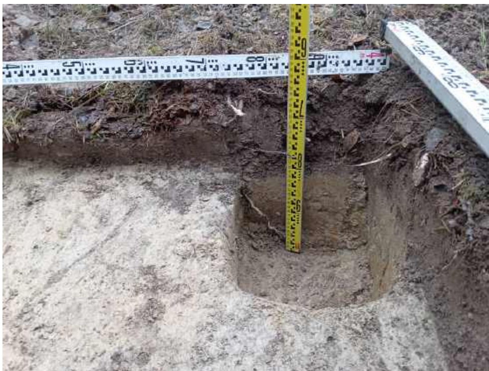
Илл. 146. Ленинградская область, Тосненский район. 2024 г. «Создание высокоскоростной железнодорожной магистрали Санкт-Петербург – Москва (участок Крюково (Алабушево) – Обухово)». «1 этап - Строительство участка Обухово-2 (искл.) - Великий Новгород ВСМ (вкл.)». Шурф №ЛО-17. Контрольный прокоп. Вид с В.
