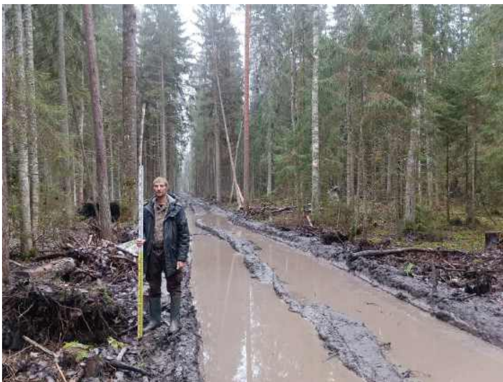
Илл. 114. Ленинградская область, Тосненский район. 2024 г. «Создание высокоскоростной железнодорожной магистрали Санкт-Петербург – Москва (участок Крюково (Алабушево) – Обухово)». «1 этап - Строительство участка Обухово-2 (искл.) - Великий Новгород ВСМ (вкл.)». Общий вид участка обследования. Точка фотофиксации №ЛО-13. Вид с ССЗ.
