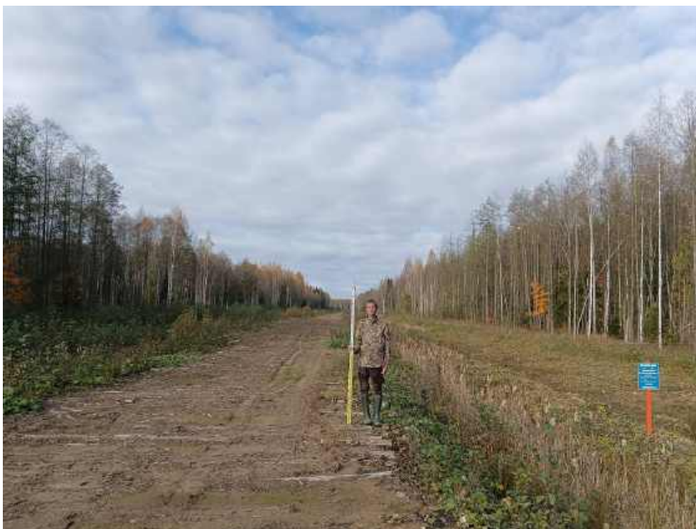
Илл. 545. Ленинградская область, Тосненский район. 2024 г. «Создание высокоскоростной железнодорожной магистрали Санкт-Петербург – Москва (участок Крюково (Алабушево) – Обухово)». «1 этап - Строительство участка Обухово-2 (искл.) - Великий Новгород ВСМ (вкл.)». Общий вид участка обследования. Начало участка перетрассировки Северо-Европейского газопровода (СЕГ-3 ПК 647,50; СЕГ-4 ПК 647,40). Точка фотофиксации №ЛО-70. Вид с ЮВ.
