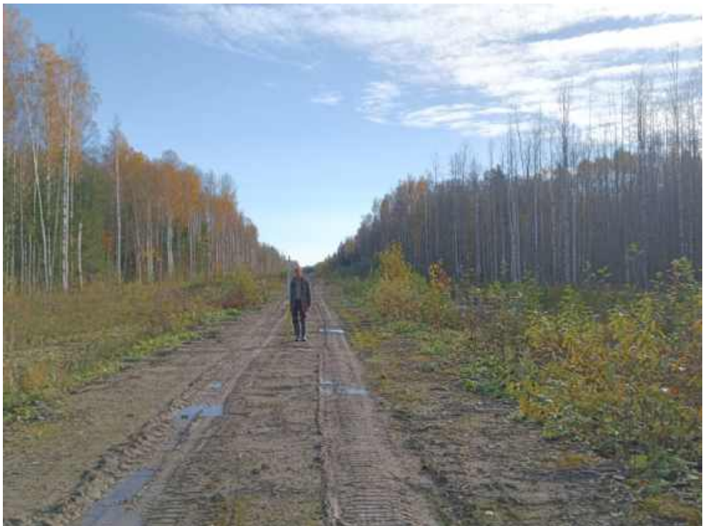
Илл. 542. Ленинградская область, Тосненский район. 2024 г. «Создание высокоскоростной железнодорожной магистрали Санкт-Петербург – Москва (участок Крюково (Алабушево) – Обухово)». «1 этап - Строительство участка Обухово-2 (искл.) - Великий Новгород ВСМ (вкл.)». Общий вид участка обследования. Конец участка перетрассировки Северо-Европейского газопровода (СЕГ-3 ПК 648,72; СЕГ-4 ПК 648,83). Точка фотофиксации №ЛО-68. Вид с СЗ.
