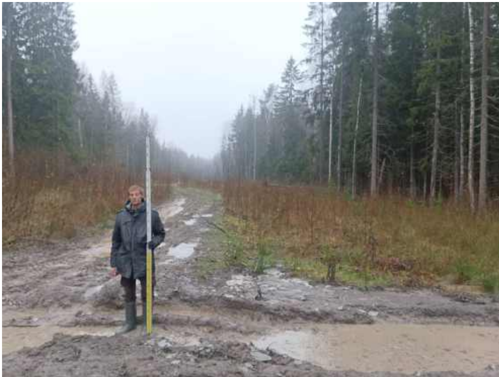
Илл. 94. Ленинградская область, Гosenский район. 2024 г. «Создание высокоскоростной железнодорожной магистрали Санкт-Петербург – Москва (участок Крюково (Алабушево) – Обухово)». «1 этап - Строительство участка Обухово-2 (искл.) - Великий Новгород ВСМ (вкл.)». Общий вид участка обследования. Переход газопровода перемычки между магистральными газопроводами. Точка фотофиксации №ЛО-11. Вид с СВ.
