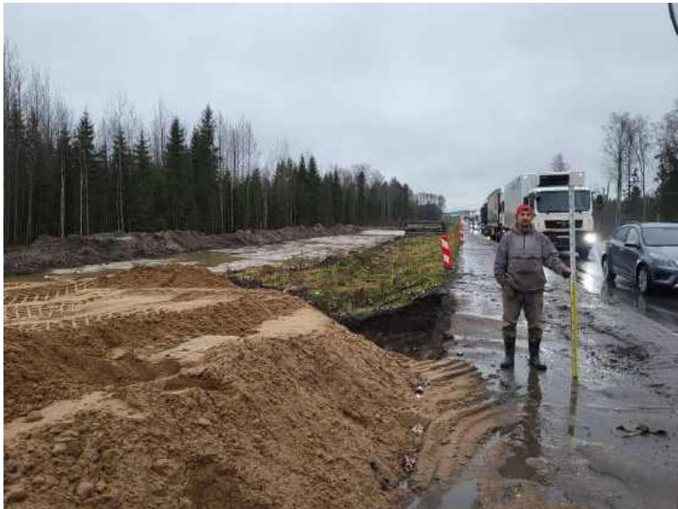
Илл. 203. Ленинградская область, Тосненский район. 2024 г. «Создание высокоскоростной железнодорожной магистрали Санкт-Петербург – Москва (участок Крюково (Алабушево) – Обухово)». «1 этап - Строительство участка Обухово-2 (искл.) - Великий Новгород ВСМ (вкл.)». Общий вид участка обследования. Точка фотофиксации №ЛО-24. Вид с ЮЗ.
