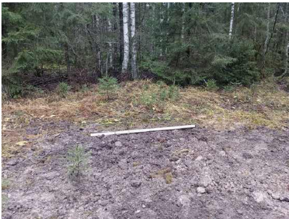
Илл. 277. Ленинградская область, Тосненский район. 2024 г. «Создание высокоскоростной железнодорожной магистрали Санкт-Петербург – Москва (участок Крюково (Алабушево) – Обухово)». «1 этап - Строительство участка Обухово-2 (искл.) - Великий Новгород ВСМ (вкл.)». Шурф №ЛО-29. Рекультивация (засыпка). Вид с 3.
