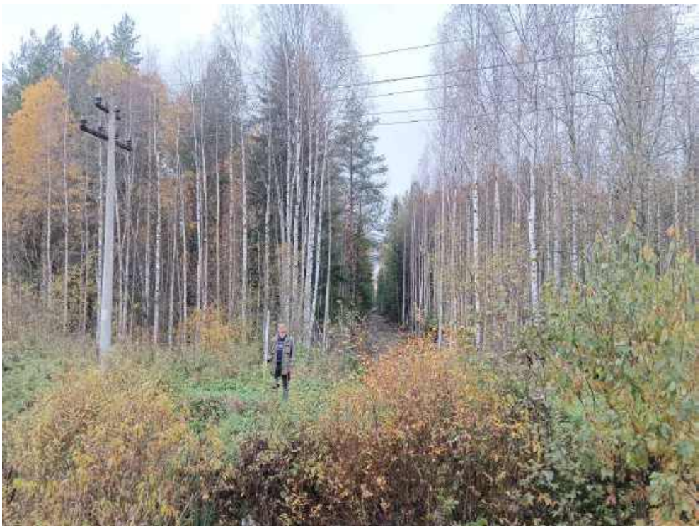
Илл. 185. Ленинградская область, Тосненский район. 2024 г. «Создание высокоскоростной железнодорожной магистрали Санкт-Петербург – Москва (участок Крюково (Алабушево) – Обухово)». «1 этап - Строительство участка Обухово-2 (искл.) - Великий Новгород ВСМ (вкл.)». Общий вид участка обследования. Точка фотофиксации №ЛО-20а. Вид с ЮЮВ.
