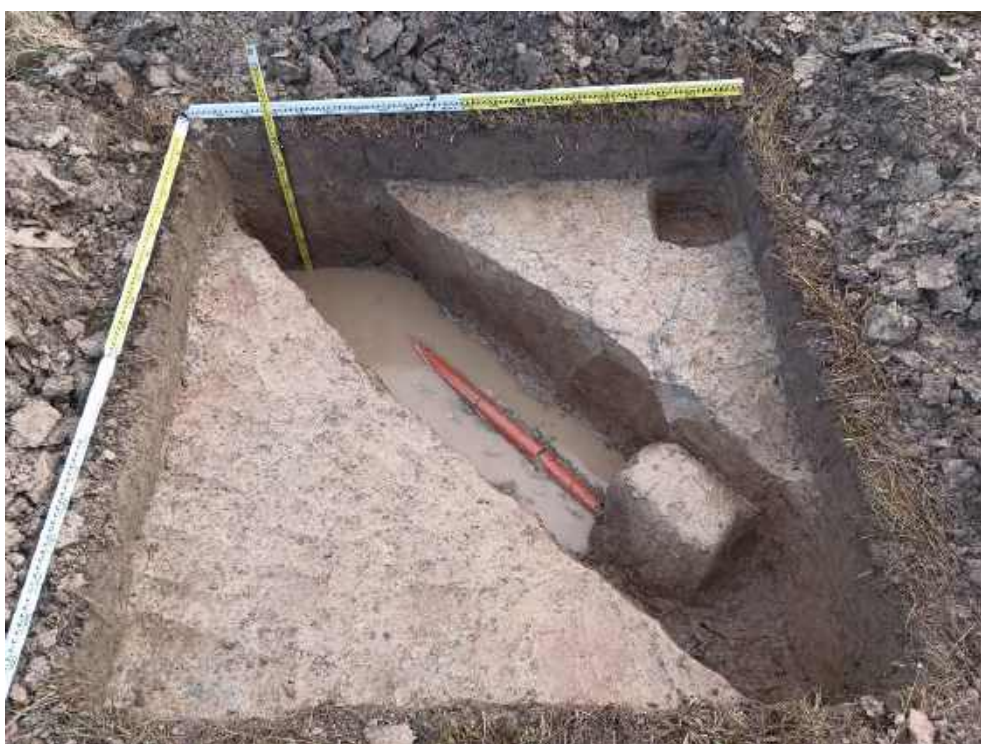
Илл. 352. Ленинградская область, Тосненский район. 2024 г. «Создание высокоскоростной железнодорожной магистрали Санкт-Петербург – Москва (участок Крюково (Алабушево) – Обухово)». «1 этап - Строительство участка Обухово-2 (искл.) - Великий Новгород ВСМ (вкл.)». Шурф №ЛО-38. Материк с выбранной траншеей дренажной керамической трубы. Предметный вид с СЗ.
