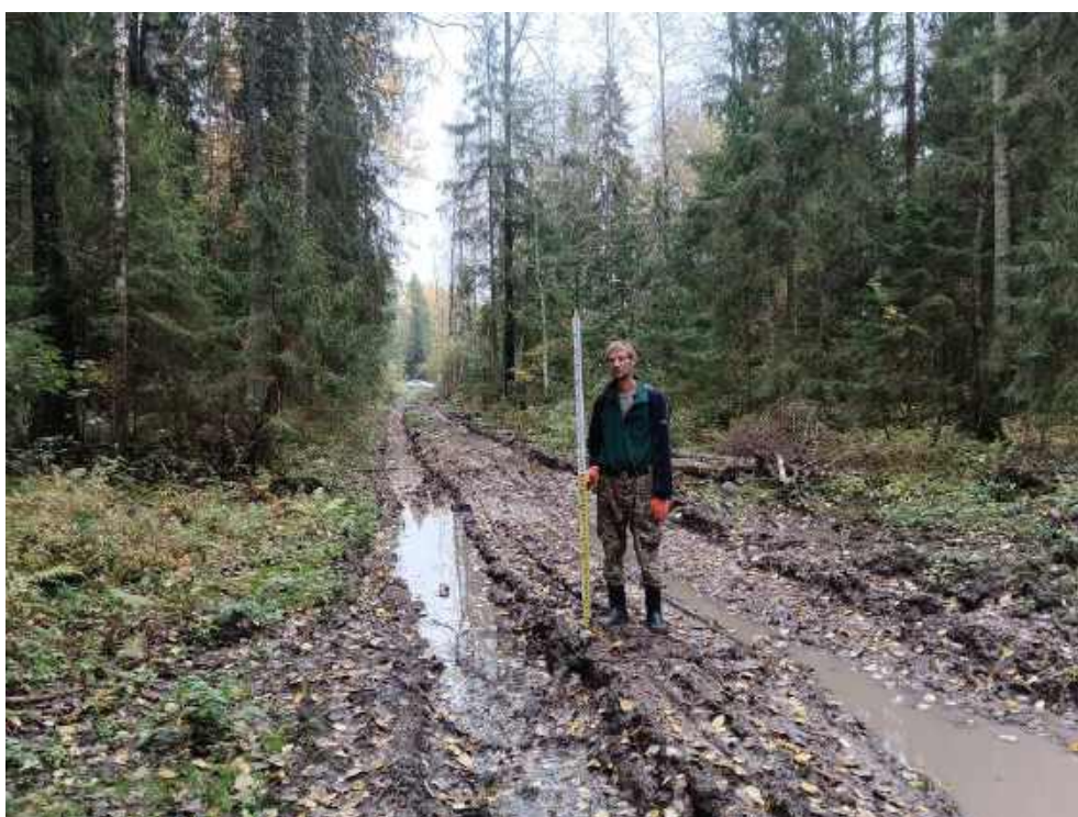
Илл. 227. Ленинградская область, Тосненский район. 2024 г. «Создание высокоскоростной железнодорожной магистрали Санкт-Петербург – Москва (участок Крюково (Алабушево) – Обухово)». «1 этап - Строительство участка Обухово-2 (искл.) - Великий Новгород ВСМ (вкл.)». Общий вид участка обследования. Точка фотофиксации №ЛО-28. Вид с ССЗ.
