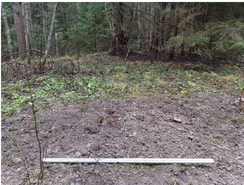
Илл. 122. Ленинградская область, Тосненский район. 2024 г. «Создание высокоскоростной железнодорожной магистрали Санкт-Петербург – Москва (участок Крюково (Алабушево) – Обухово)». «1 этап - Строительство участка Обухово-2 (искл.) - Великий Новгород ВСМ (вкл.)». Шурф №ЛО-14. Рекультивация (засыпка). Вид с В.
