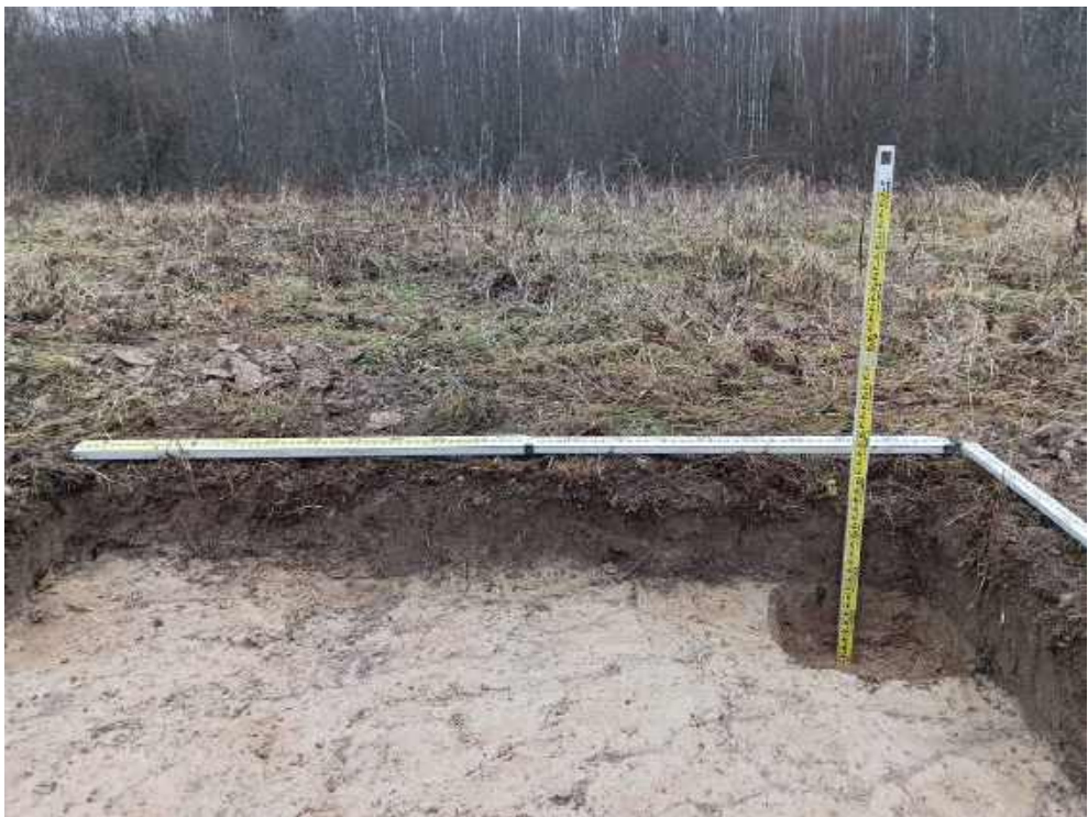
Илл. 453. Ленинградская область, Тосненский район. 2024 г. «Создание высокоскоростной железнодорожной магистрали Санкт-Петербург – Москва (участок Крюково (Алабушево) – Обухово)». «1 этап - Строительство участка Обухово-2 (искл.) - Великий Новгород ВСМ (вкл.)». Шурф №ЛО-46. Южная стенка и контрольный прокоп. Вид с С.
