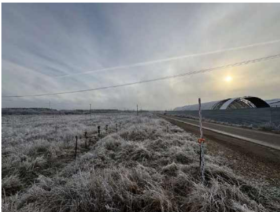
Илл. 42. Ленинградская область, Госненский район. 2024 г. «Создание высокоскоростной железнодорожной магистрали Санкт-Петербург – Москва (участок Крюково (Алабушево) – Обухово)». «1 этап - Строительство участка Обухово-2 (искл.) - Великий Новгород ВСМ (вкл.)». Общий вид участка обследования. Точка фотофиксации №ЛО-5. Вид с ССЗ.
