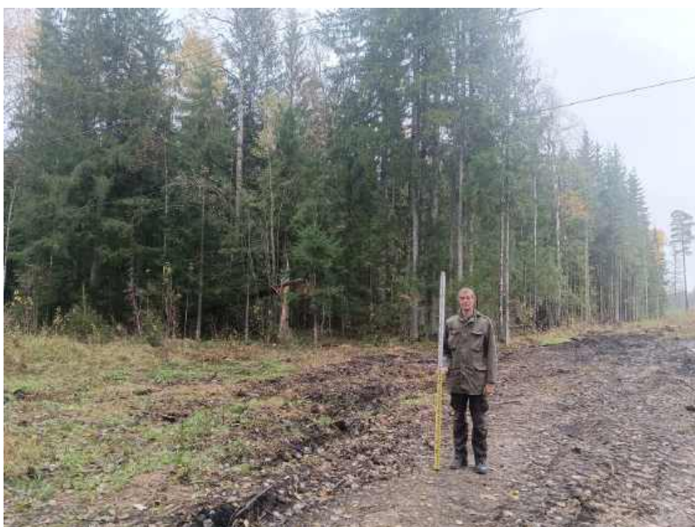
Илл. 207. Ленинградская область, Тосненский район. 2024 г. «Создание высокоскоростной железнодорожной магистрали Санкт-Петербург – Москва (участок Крюково (Алабушево) – Обухово)». «1 этап - Строительство участка Обухово-2 (искл.) - Великий Новгород ВСМ (вкл.)». Общий вид участка обследования. Точка фотофиксации №ЛО-26. Вид с ЮЗ.
