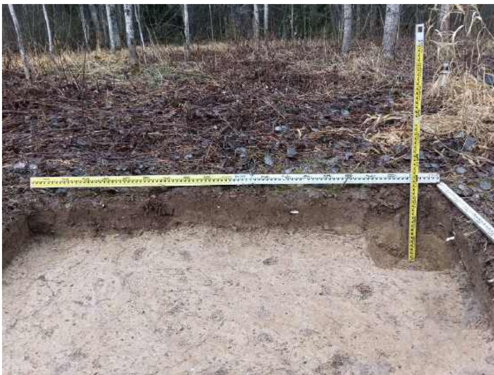
Илл. 460. Ленинградская область, Тосненский район. 2024 г. «Создание высокоскоростной железнодорожной магистрали Санкт-Петербург – Москва (участок Крюково (Алабушево) – Обухово)». «1 этап - Строительство участка Обухово-2 (искл.) - Великий Новгород ВСМ (вкл.)». Шурф №ЛО-47. Северная стенка и контрольный прокоп. Вид с Ю.
