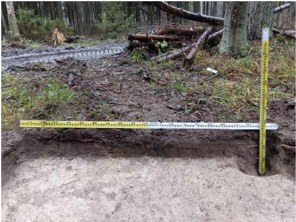
Илл. 100. Ленинградская область, Тосненский район. 2024 г. «Создание высокоскоростной железнодорожной магистрали Санкт-Петербург – Москва (участок Крюково (Алабушево) – Обухово)». «1 этап - Строительство участка Обухово-2 (искл.) - Великий Новгород ВСМ (вкл.)». Шурф №ЛО-12. Западная стенка и контрольный прокоп. Вид с В.
