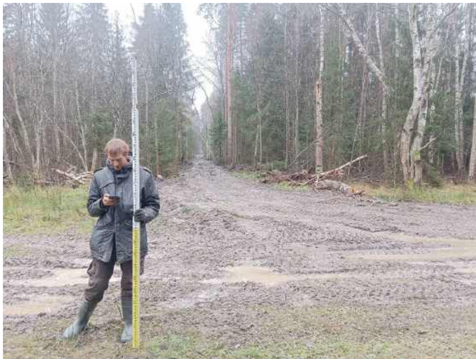
Илл. 91. Ленинградская область, Госненский район. 2024 г. «Создание высокоскоростной железнодорожной магистрали Санкт-Петербург – Москва (участок Крюково (Алабушево) – Обухово)». «1 этап - Строительство участка Обухово-2 (искл.) - Великий Новгород ВСМ (вкл.)». Общий вид участка обследования. Переход магистрального газопровода «Ям-Ижора – Гатчина». Точка фотофиксации №ЛО-10. Вид с ССЗ.
