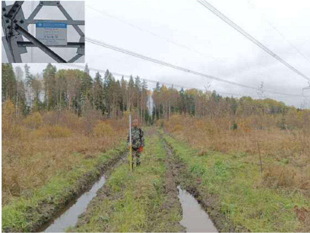
Илл. 428. Ленинградская область, Тосненский район. 2024 г. «Создание высокоскоростной железнодорожной магистрали Санкт-Петербург – Москва (участок Крюково (Алабушево) – Обухово)». «1 этап - Строительство участка Обухово-2 (искл.) - Великий Новгород ВСМ (вкл.)». Общий вид участка обследования. Переход ВЛ 750 кВ «Калининская АЭС – Ленинградская». Точка фотофиксации №ЛО-52. Вид с ССЗ.
