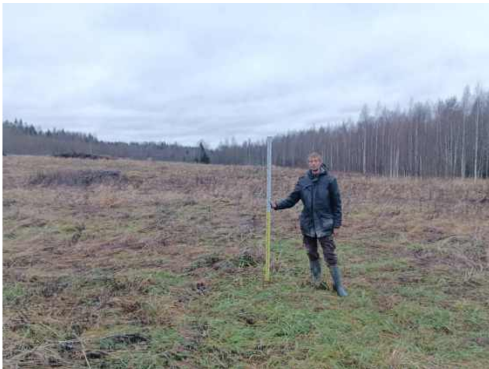
Илл. 384. Ленинградская область, Тосненский район. 2024 г. «Создание высокоскоростной железнодорожной магистрали Санкт-Петербург – Москва (участок Крюково (Алабушево) – Обухово)». «1 этап - Строительство участка Обухово-2 (искл.) - Великий Новгород ВСМ (вкл.)». Шурф №ЛО-40. Местоположение. Вид с Ю.
