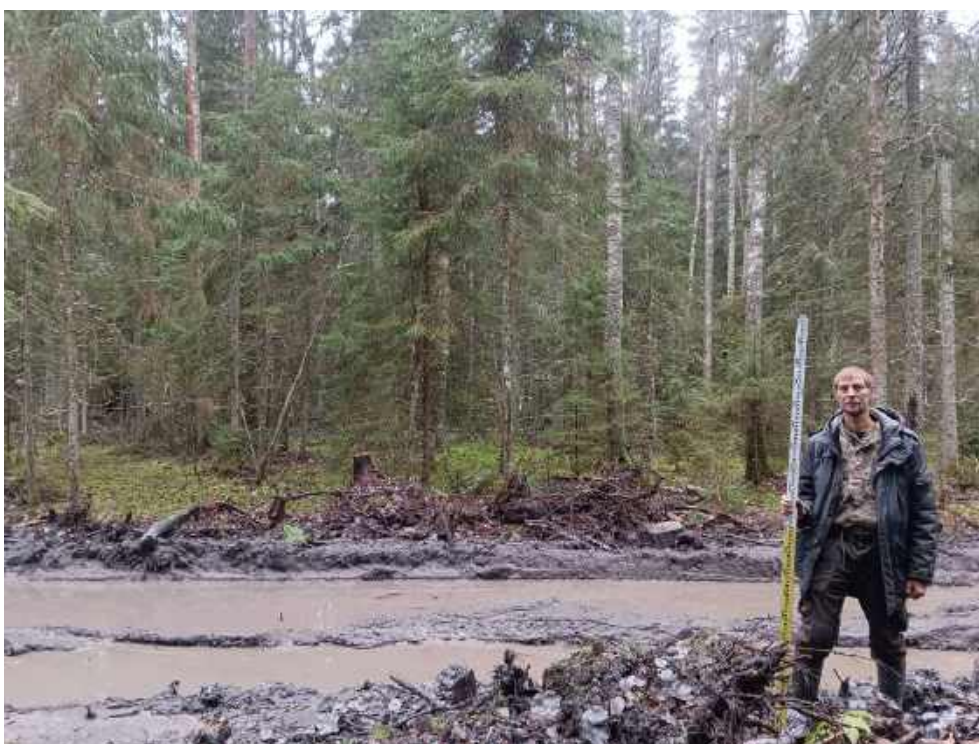
Илл. 115. Ленинградская область, Тосненский район. 2024 г. «Создание высокоскоростной железнодорожной магистрали Санкт-Петербург – Москва (участок Крюково (Алабушево) – Обухово)». «1 этап - Строительство участка Обухово-2 (искл.) - Великий Новгород ВСМ (вкл.)». Общий вид участка обследования. Участок перекладки газопроводов. Точка фотофиксации №ЛО-13. Вид с СВ.
