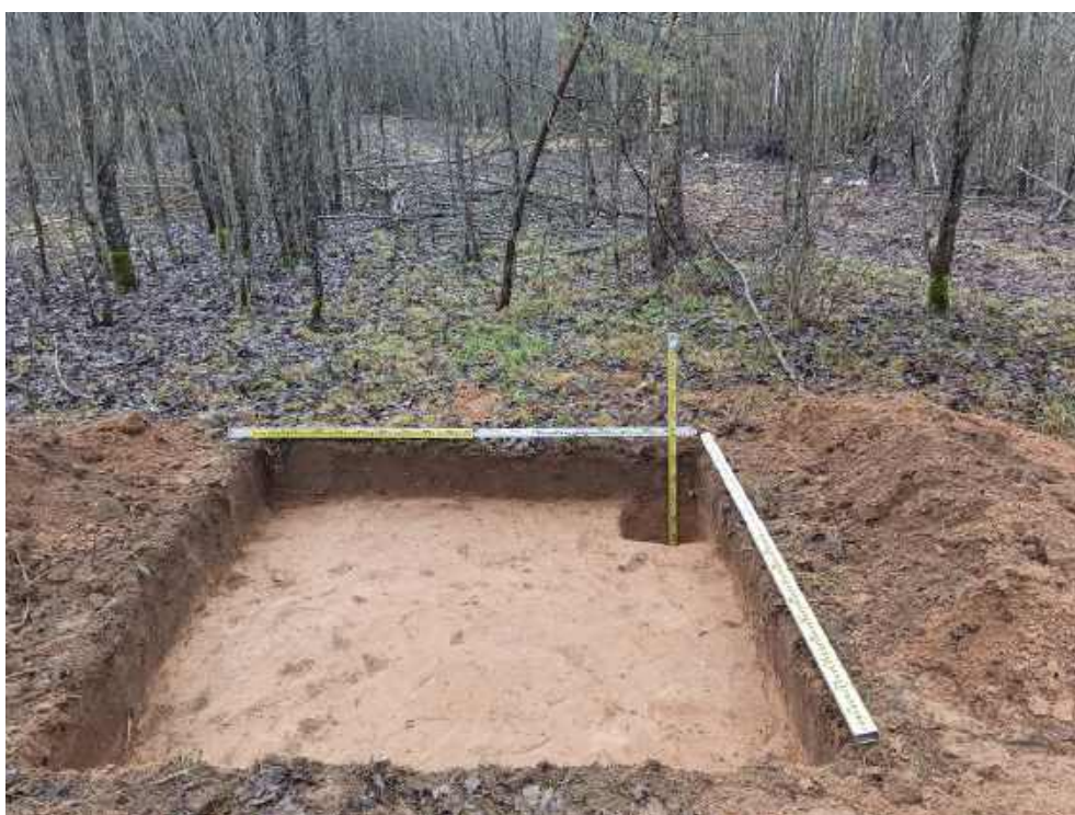
Илл. 330. Ленинградская область, Тосненский район. 2024 г. «Создание высокоскоростной железнодорожной магистрали Санкт-Петербург – Москва (участок Крюково (Алабушево) – Обухово)». «1 этап - Строительство участка Обухово-2 (искл.) - Великий Новгород ВСМ (вкл.)». Шурф №ЛО-35. Зачистка по матерiku. Общий вид с С.
