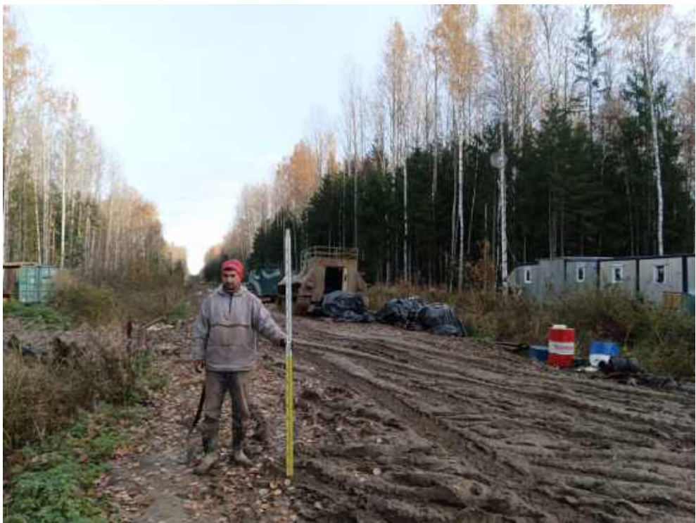
Илл. 491. Ленинградская область, Тосненский район. 2024 г. «Создание высокоскоростной железнодорожной магистрали Санкт-Петербург – Москва (участок Крюково (Алабушево) – Обухово)». «1 этап - Строительство участка Обухово-2 (искл.) - Великий Новгород ВСМ (вкл.)». Общий вид участка обследования. Точка фотофиксации №ЛО-60. Вид с ЮЗ.
