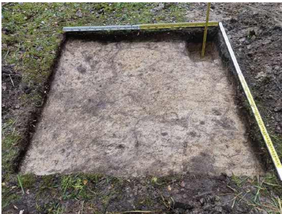
Илл. 220. Ленинградская область, Тосненский район. 2024 г. «Создание высокоскоростной железнодорожной магистрали Санкт-Петербург – Москва (участок Крюково (Алабушево) – Обухово)». «1 этап - Строительство участка Обухово-2 (искл.) - Великий Новгород ВСМ (вкл.)». Шурф №ЛО-24. Материк. Предметный вид с В.
