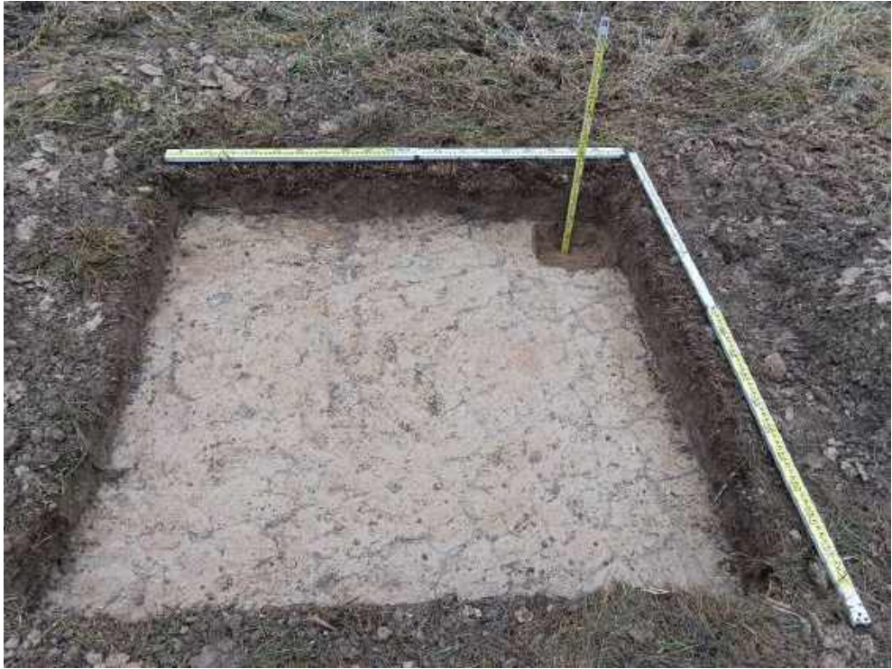
Илл. 452. Ленинградская область, Тосненский район. 2024 г. «Создание высокоскоростной железнодорожной магистрали Санкт-Петербург – Москва (участок Крюково (Алабушево) – Обухово)». «1 этап - Строительство участка Обухово-2 (искл.) - Великий Новгород ВСМ (вкл.)». Шурф №ЛО-46. Материк. Предметный вид с С.
