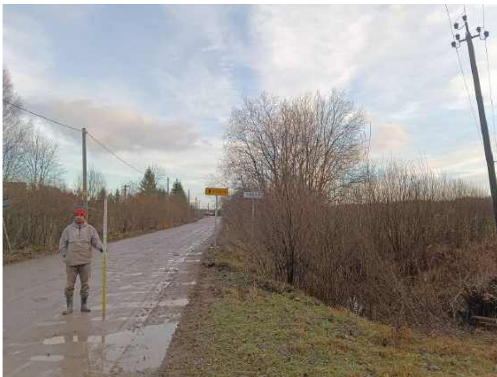
Илл. 367. Ленинградская область, Тосненский район. 2024 г. «Создание высокоскоростной железнодорожной магистрали Санкт-Петербург – Москва (участок Крюково (Алабушево) – Обухово)». «1 этап - Строительство участка Обухово-2 (искл.) - Великий Новгород ВСМ (вкл.)». Общий вид участка обследования. Реконструкция автодороги «Ушаки – Рублево – Гуммолово». Точка фотофиксации №ЛО-43. Вид с ЮЗ.
