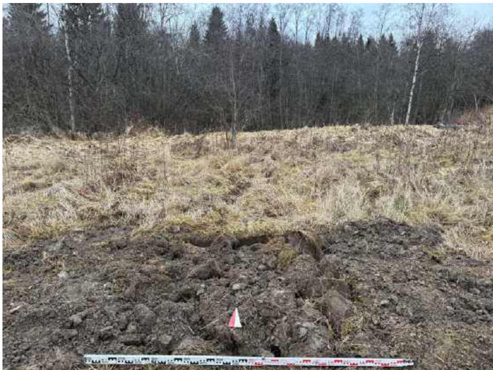
Илл. 78. Ленинградская область, Госненский район. 2024 г. «Создание высокоскоростной железнодорожной магистрали Санкт-Петербург – Москва (участок Крюково (Алабушево) – Обухово)». «1 этап - Строительство участка Обухово-2 (искл.) - Великий Новгород ВСМ (вкл.)». Шурф №ЛО-10. Рекультивация (засыпка). Вид с Ю.
