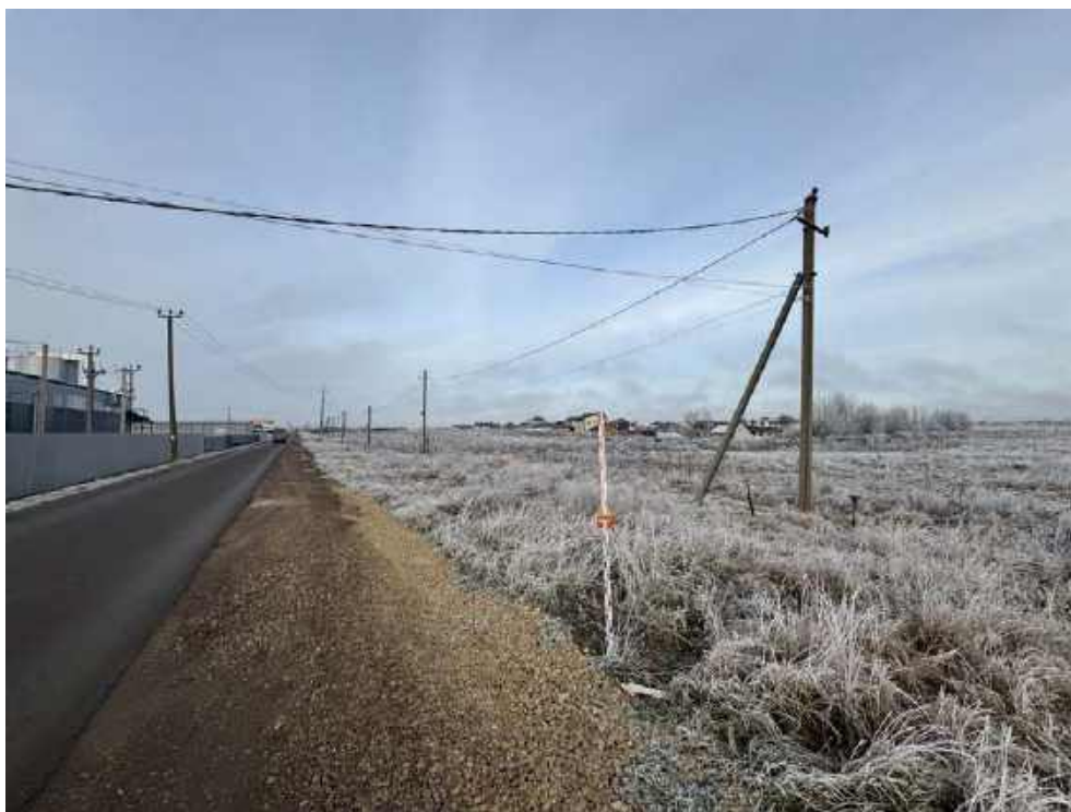
Илл. 41. Ленинградская область, Госненский район. 2024 г. «Создание высокоскоростной железнодорожной магистрали Санкт-Петербург – Москва (участок Крюково (Алабушево) – Обухово)». «1 этап - Строительство участка Обухово-2 (искл.) - Великий Новгород ВСМ (вкл.)». Общий вид участка обследования. Точка фотофиксации №ЛО-5. Вид с ЮЮВ.
