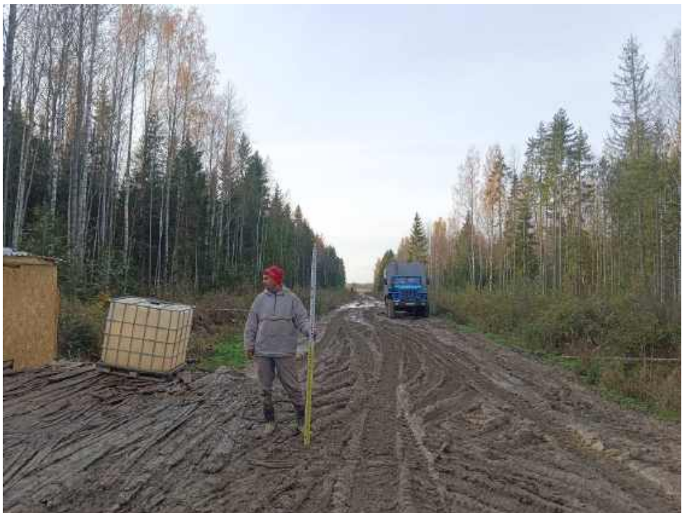
Илл. 493. Ленинградская область, Тосненский район. 2024 г. «Создание высокоскоростной железнодорожной магистрали Санкт-Петербург – Москва (участок Крюково (Алабушево) – Обухово)». «1 этап - Строительство участка Обухово-2 (искл.) - Великий Новгород ВСМ (вкл.)». Общий вид участка обследования. Точка фотофиксации №ЛО-60. Вид с СВ.
