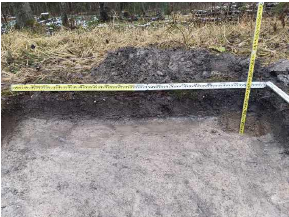
Илл. 469. Ленинградская область, Тосненский район. 2024 г. «Создание высокоскоростной железнодорожной магистрали Санкт-Петербург – Москва (участок Крюково (Алабушево) – Обухово)». «1 этап - Строительство участка Обухово-2 (искл.) - Великий Новгород ВСМ (вкл.)». Шурф №ЛО-48. Западная стенка и контрольный прокоп. Вид с В.
