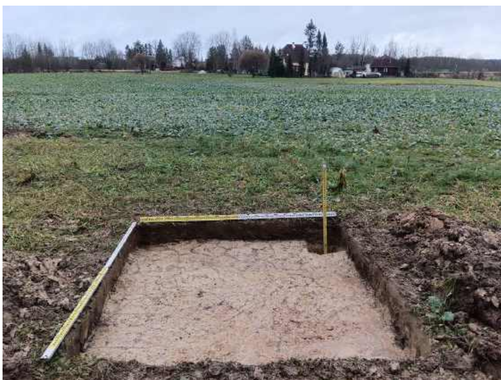
Илл. 362. Ленинградская область, Тосненский район. 2024 г. «Создание высокоскоростной железнодорожной магистрали Санкт-Петербург – Москва (участок Крюково (Алабушево) – Обухово)». «1 этап - Строительство участка Обухово-2 (искл.) - Великий Новгород ВСМ (вкл.)». Шурф №ЛО-39. Зачистка по материке. Общий вид с Ю.
