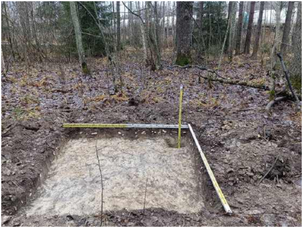
Илл. 180. Ленинградская область, Тосненский район. 2024 г. «Создание высокоскоростной железнодорожной магистрали Санкт-Петербург – Москва (участок Крюково (Алабушево) – Обухово)». «1 этап - Строительство участка Обухово-2 (искл.) - Великий Новгород ВСМ (вкл.)». Шурф №ЛО-21. Зачистка по материке. Общий вид с СЗ.
