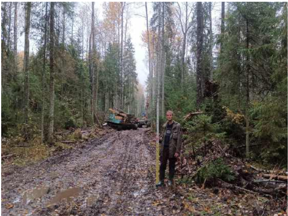
Илл. 177. Ленинградская область, Тосненский район. 2024 г. «Создание высокоскоростной железнодорожной магистрали Санкт-Петербург – Москва (участок Крюково (Алабушево) – Обухово)». «1 этап - Строительство участка Обухово-2 (искл.) - Великий Новгород ВСМ (вкл.)». Общий вид участка обследования. Работа геологов. Точка фотофиксации №ЛО-19. Вид с ССЗ.
