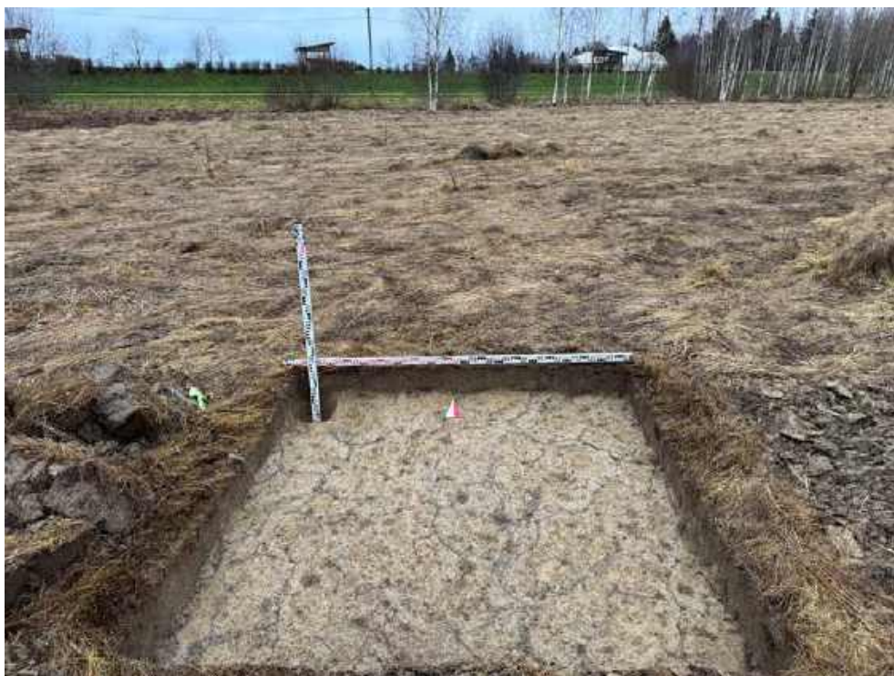
Илл. 70. Ленинградская область, Госненский район. 2024 г. «Создание высокоскоростной железнодорожной магистрали Санкт-Петербург – Москва (участок Крюково (Алабушево) – Обухово)». «1 этап - Строительство участка Обухово-2 (искл.) - Великий Новгород ВСМ (вкл.)». Шурф №ЛО-9. Зачистка по матерiku. Общий вид с Ю.
