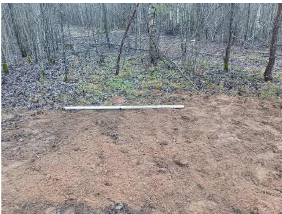
Илл. 334. Ленинградская область, Тосненский район. 2024 г. «Создание высокоскоростной железнодорожной магистрали Санкт-Петербург – Москва (участок Крюково (Алабушево) – Обухово)». «1 этап - Строительство участка Обухово-2 (искл.) - Великий Новгород ВСМ (вкл.)». Шурф №ЛО-35. Рекультивация (засыпка). Вид с С.
