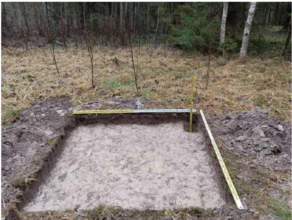
Илл. 107. Ленинградская область, Тосненский район. 2024 г. «Создание высокоскоростной железнодорожной магистрали Санкт-Петербург – Москва (участок Крюково (Алабушево) – Обухово)». «1 этап - Строительство участка Обухово-2 (искл.) - Великий Новгород ВСМ (вкл.)». Шурф №ЛО-13. Зачистка по материке. Общий вид с Ю.
