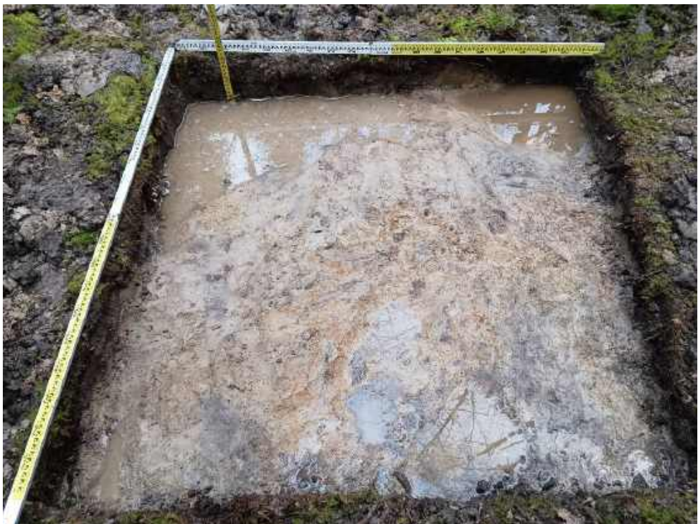
Илл. 264. Ленинградская область, Тосненский район. 2024 г. «Создание высокоскоростной железнодорожной магистрали Санкт-Петербург – Москва (участок Крюково (Алабушево) – Обухово)». «1 этап - Строительство участка Обухово-2 (искл.) - Великий Новгород ВСМ (вкл.)». Шурф №ЛО-28. Материк. Предметный вид с Ю.
