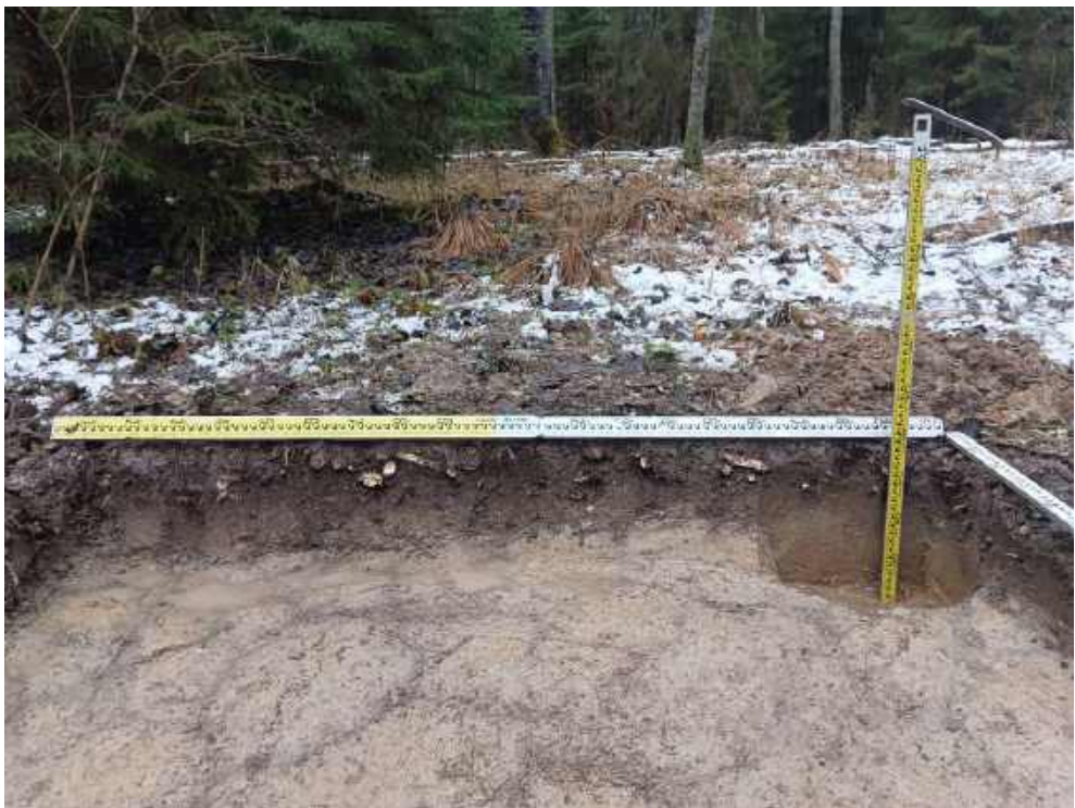
Илл. 485. Ленинградская область, Тосненский район. 2024 г. «Создание высокоскоростной железнодорожной магистрали Санкт-Петербург – Москва (участок Крюково (Алабушево) – Обухово)». «1 этап - Строительство участка Обухово-2 (искл.) - Великий Новгород ВСМ (вкл.)». Шурф №ЛО-50. Северная стенка и контрольный прокоп. Вид с Ю.
