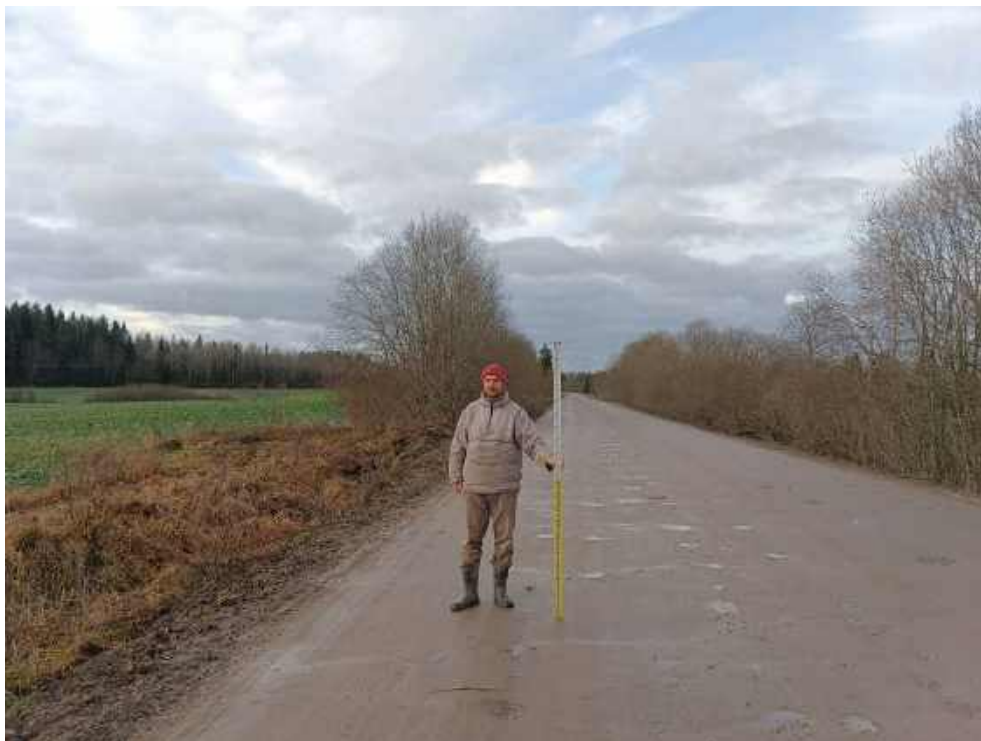
Илл. 358. Ленинградская область, Тосненский район. 2024 г. «Создание высокоскоростной железнодорожной магистрали Санкт-Петербург – Москва (участок Крюково (Алабушево) – Обухово)». «1 этап - Строительство участка Обухово-2 (искл.) - Великий Новгород ВСМ (вкл.)». Общий вид участка обследования. Реконструкция автодороги «Ушаки – Рублево – Гуммоллово». Точка фотофиксации №ЛО-42. Вид с ВСВ.
