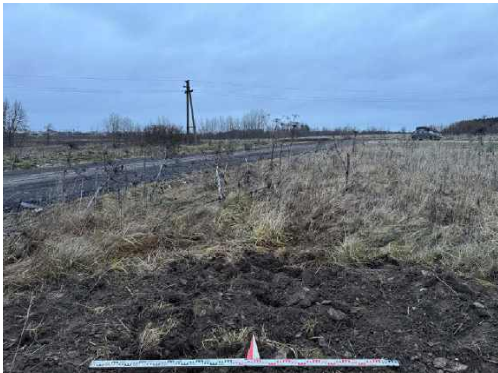
Илл. 56. Ленинградская область, Госненский район. 2024 г. «Создание высокоскоростной железнодорожной магистрали Санкт-Петербург – Москва (участок Крюково (Алабушево) – Обухово)». «1 этап - Строительство участка Обухово-2 (искл.) - Великий Новгород ВСМ (вкл.)». Шурф №ЛО-6. Рекультивация (засыпка). Вид с Ю.
