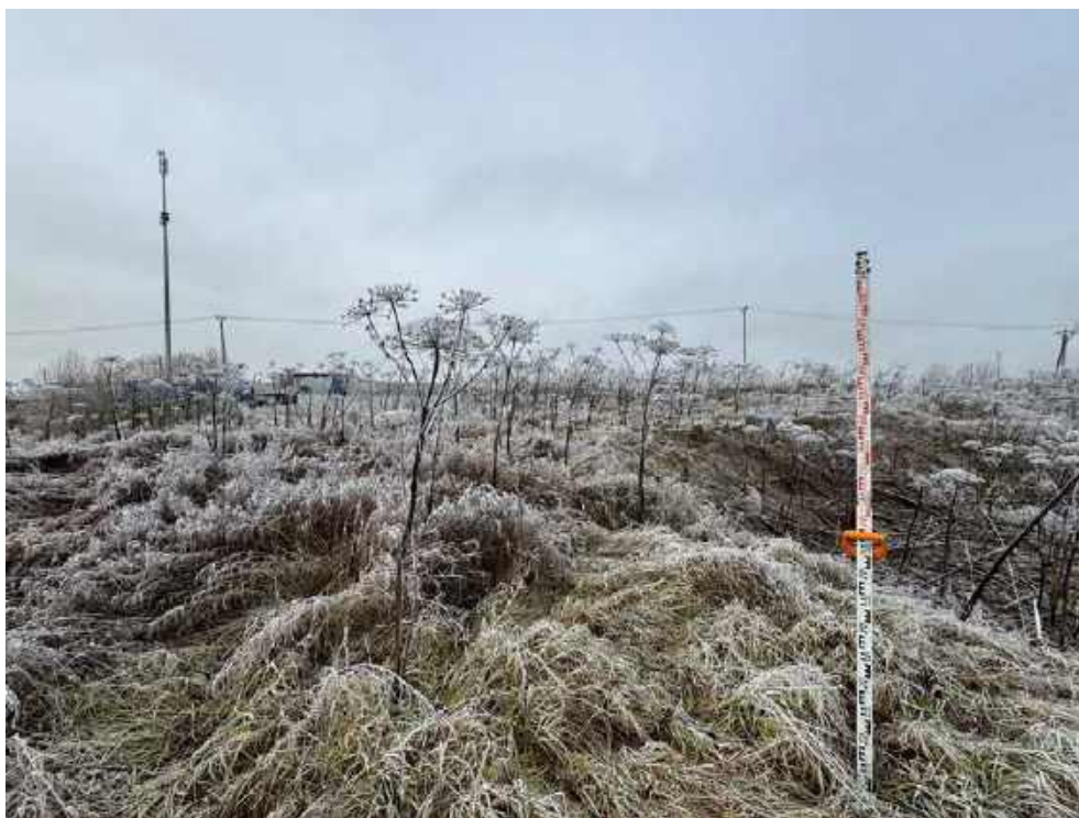
Илл. 48. Ленинградская область, Госненский район. 2024 г. «Создание высокоскоростной железнодорожной магистрали Санкт-Петербург – Москва (участок Крюково (Алабушево) – Обухово)». «1 этап - Строительство участка Обухово-2 (искл.) - Великий Новгород ВСМ (вкл.)». Общий вид участка обследования. Точка фотофиксации №ЛО-6. Вид с ЮЮВ.
