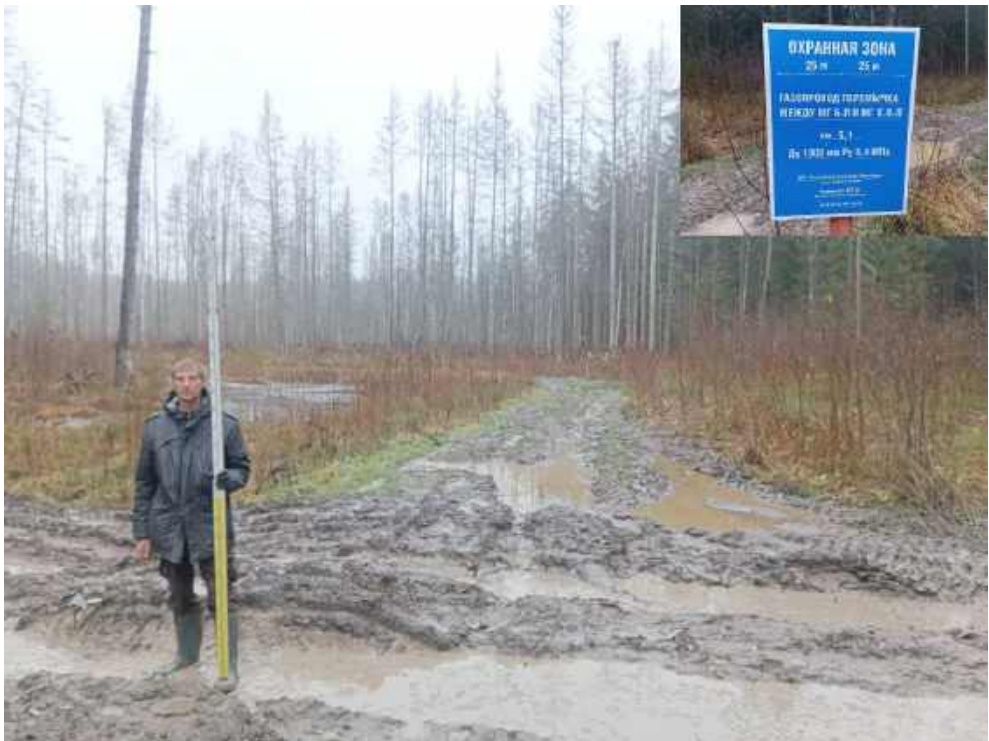
Илл. 93. Ленинградская область, Госненский район. 2024 г. «Создание высокоскоростной железнодорожной магистрали Санкт-Петербург – Москва (участок Крюково (Алабушево) – Обухово)». «1 этап - Строительство участка Обухово-2 (искл.) - Великий Новгород ВСМ (вкл.)». Общий вид участка обследования. Переход газопровода перемычки между магистральными газопроводами. Точка фотофиксации №ЛО-11. Вид с ЮЗ.
