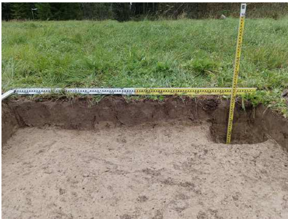
Илл. 408. Ленинградская область, Тосненский район. 2024 г. «Создание высокоскоростной железнодорожной магистрали Санкт-Петербург – Москва (участок Крюково (Алабушево) – Обухово)». «1 этап - Строительство участка Обухово-2 (искл.) - Великий Новгород ВСМ (вкл.)». Шурф №ЛО-42. Южная стенка и контрольный прокоп. Вид с С.
