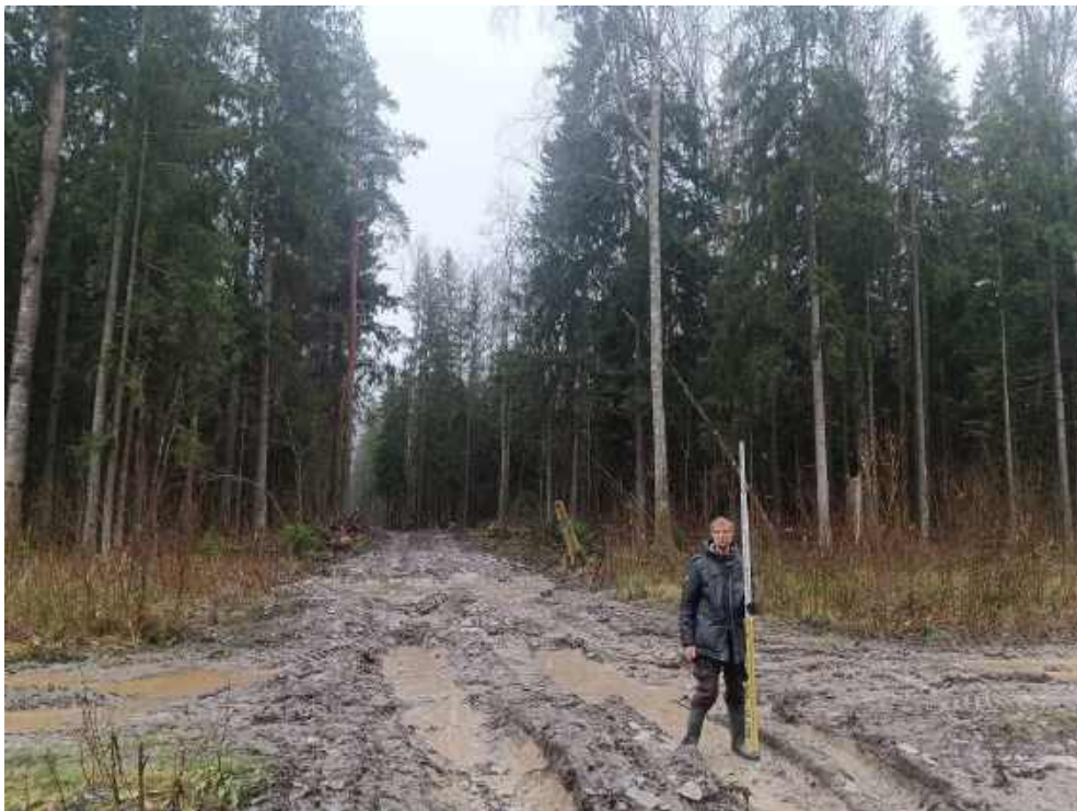
Илл. 95. Ленинградская область, Гosenский район. 2024 г. «Создание высокоскоростной железнодорожной магистрали Санкт-Петербург – Москва (участок Крюково (Алабушево) – Обухово)». «1 этап - Строительство участка Обухово-2 (искл.) - Великий Новгород ВСМ (вкл.)». Общий вид участка обследования. Переход газопровода перемычки между магистральными газопроводами. Точка фотофиксации №ЛО-11. Вид с ССЗ.
