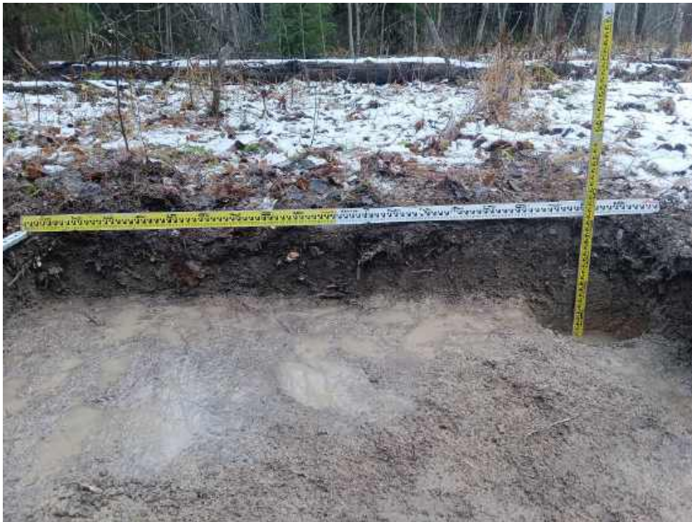
Илл. 478. Ленинградская область, Тосненский район. 2024 г. «Создание высокоскоростной железнодорожной магистрали Санкт-Петербург – Москва (участок Крюково (Алабушево) – Обухово)». «1 этап - Строительство участка Обухово-2 (искл.) - Великий Новгород ВСМ (вкл.)». Шурф №ЛО-49. Южная стенка и контрольный прокоп. Вид с С.
