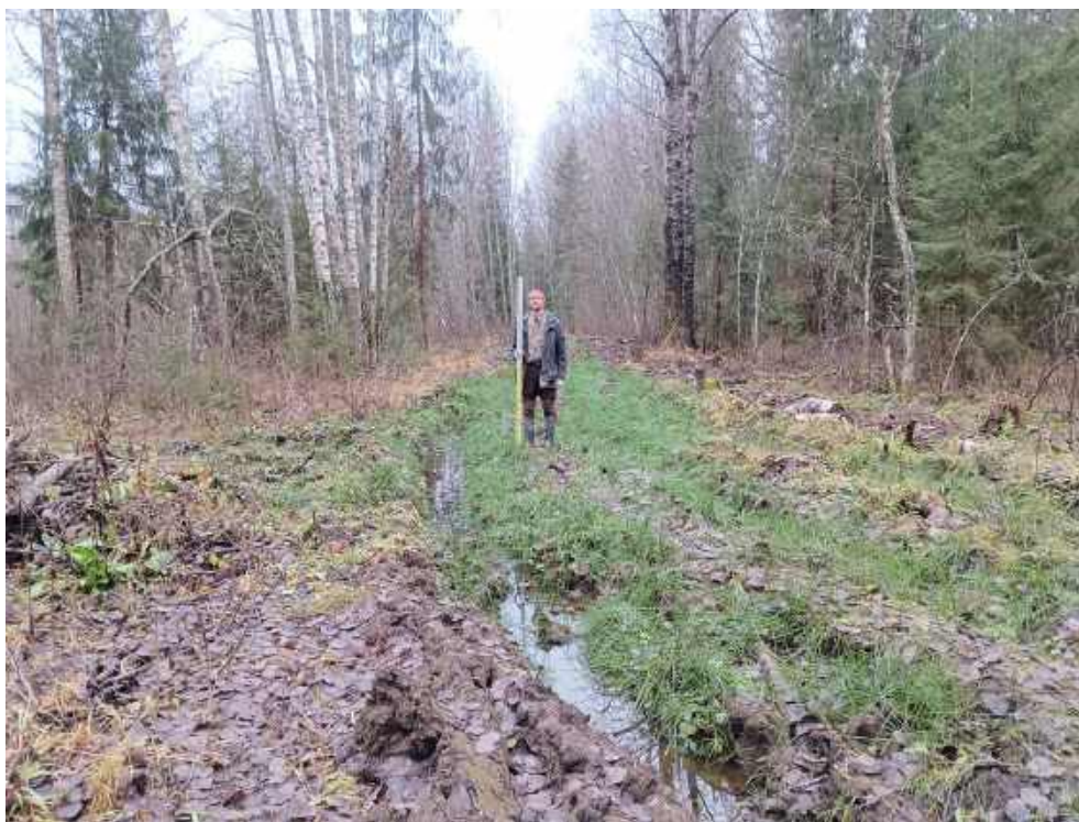
Илл. 299. Ленинградская область, Тосненский район. 2024 г. «Создание высокоскоростной железнодорожной магистрали Санкт-Петербург – Москва (участок Крюково (Алабушево) – Обухово)». «1 этап - Строительство участка Обухово-2 (искл.) - Великий Новгород ВСМ (вкл.)». Общий вид участка обследования. Точка фотофиксации №ЛО-38. Вид с ССЗ.
