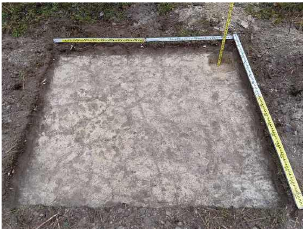
Илл. 160. Ленинградская область, Тосненский район. 2024 г. «Создание высокоскоростной железнодорожной магистрали Санкт-Петербург – Москва (участок Крюково (Алабушево) – Обухово)». «1 этап - Строительство участка Обухово-2 (искл.) - Великий Новгород ВСМ (вкл.)». Шурф №ЛО-19. Материк. Предметный вид с Ю.
