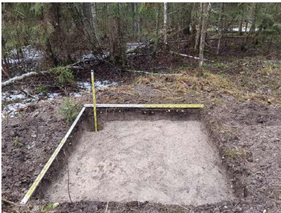
Илл. 293. Ленинградская область, Тосненский район. 2024 г. «Создание высокоскоростной железнодорожной магистрали Санкт-Петербург – Москва (участок Крюково (Алабушево) – Обухово)». «1 этап - Строительство участка Обухово-2 (искл.) - Великий Новгород ВСМ (вкл.)». Шурф №ЛО-31. Зачистка по материке. Общий вид с 3.
