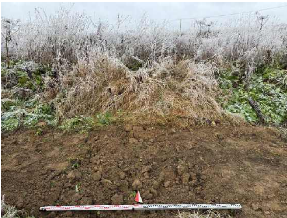
Илл. 47. Ленинградская область, Госненский район. 2024 г. «Создание высокоскоростной железнодорожной магистрали Санкт-Петербург – Москва (участок Крюково (Алабушево) – Обухово)». «1 этап - Строительство участка Обухово-2 (искл.) - Великий Новгород ВСМ (вкл.)». Шурф №ЛО-5. Рекультивация (засыпка). Вид с Ю.
