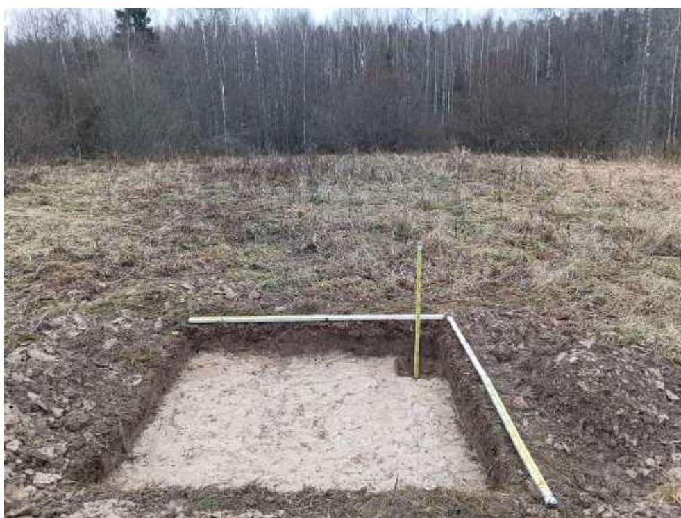
Илл. 451. Ленинградская область, Тосненский район. 2024 г. «Создание высокоскоростной железнодорожной магистрали Санкт-Петербург – Москва (участок Крюково (Алабушево) – Обухово)». «1 этап - Строительство участка Обухово-2 (искл.) - Великий Новгород ВСМ (вкл.)». Шурф №ЛО-46. Зачистка по материке. Общий вид с С.
