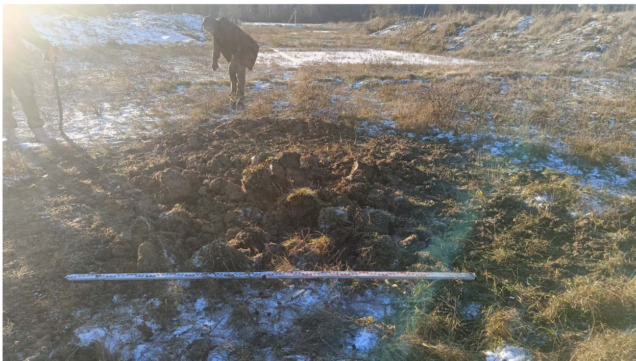
Рис. 46. ЛО-2024. Новосергиевка. КН: 47:07:1044001:81260. Шурф 3 после рекультивации, вид с востока.
