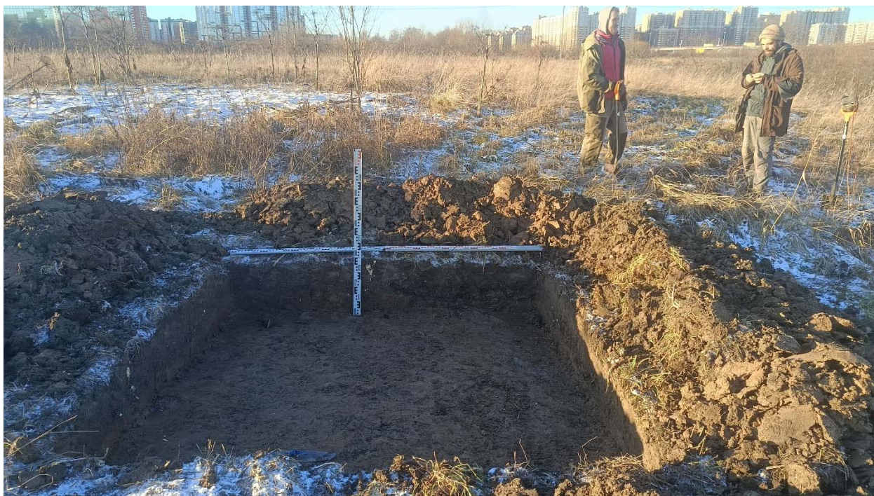
Рис. 54. ЛО-2024. Новосергиевка. КН: 47:07:1044001:81260. Шурф 5, фиксация по уровню окончания работ, вид с востока.
