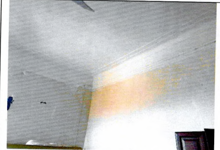
Плоское перекрытие (квартира, 3-ий этаж)
