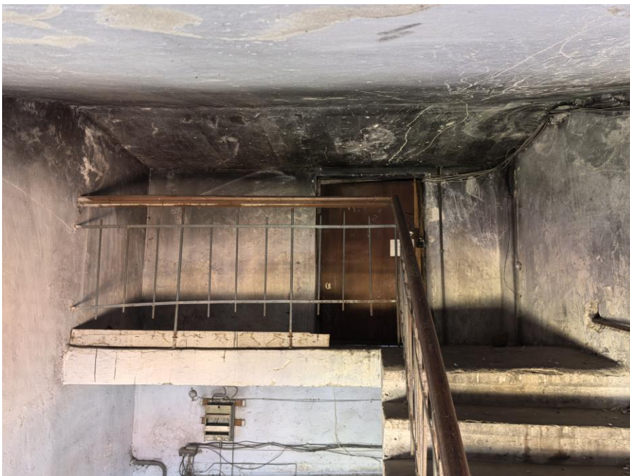
41. «Жилой дом», Ленинградская область, Выборгский муниципальный район, г. Выборг, ул. Сторожевой башни, д. 10А. Подъезд №1. Общий вид. Фото 05.11.2024г.
