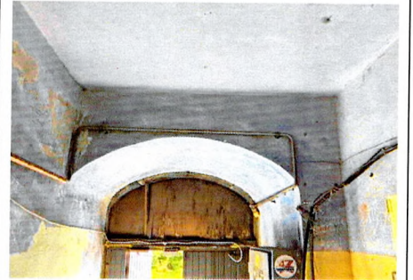
Существующее плоское перекрытие входной зоны
