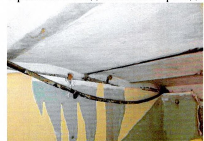
Своды «монье». Подвал
