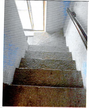
Промежуточный марш лестницы дворового крыла. Гранитные ступени
