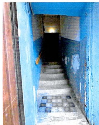
Нижний марш лестницы дворового крыла. Гранитные ступени
