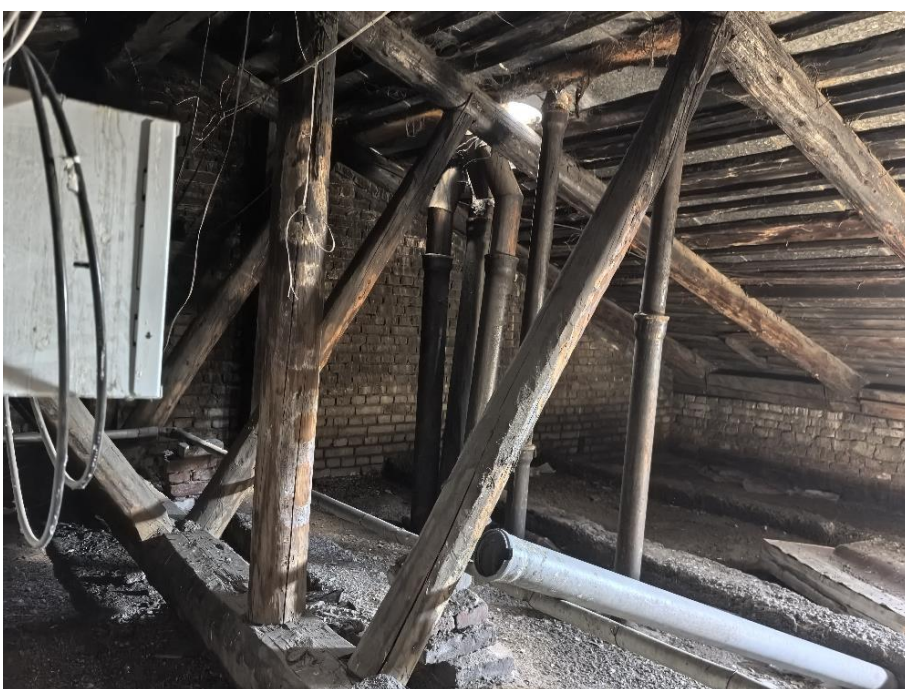
30. «Жилой дом», Ленинградская область, Выборгский муниципальный район, г. Выборг, ул. Сторожевой башни, д. 10А. Чердак. Общий вид. Фото 05.11.2024г.
