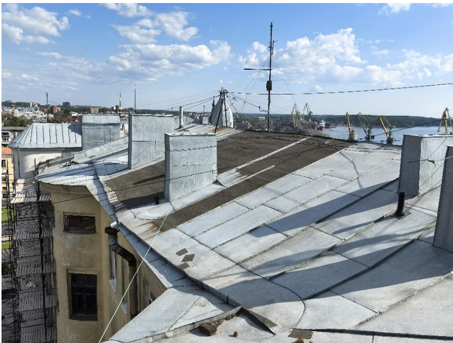
28. «Жилой дом», Ленинградская область, Выборгский муниципальный район, г. Выборг, ул. Сторожевой башни, д. 10А. Кровля. Общий вид. Фото 05.11.2024г.
