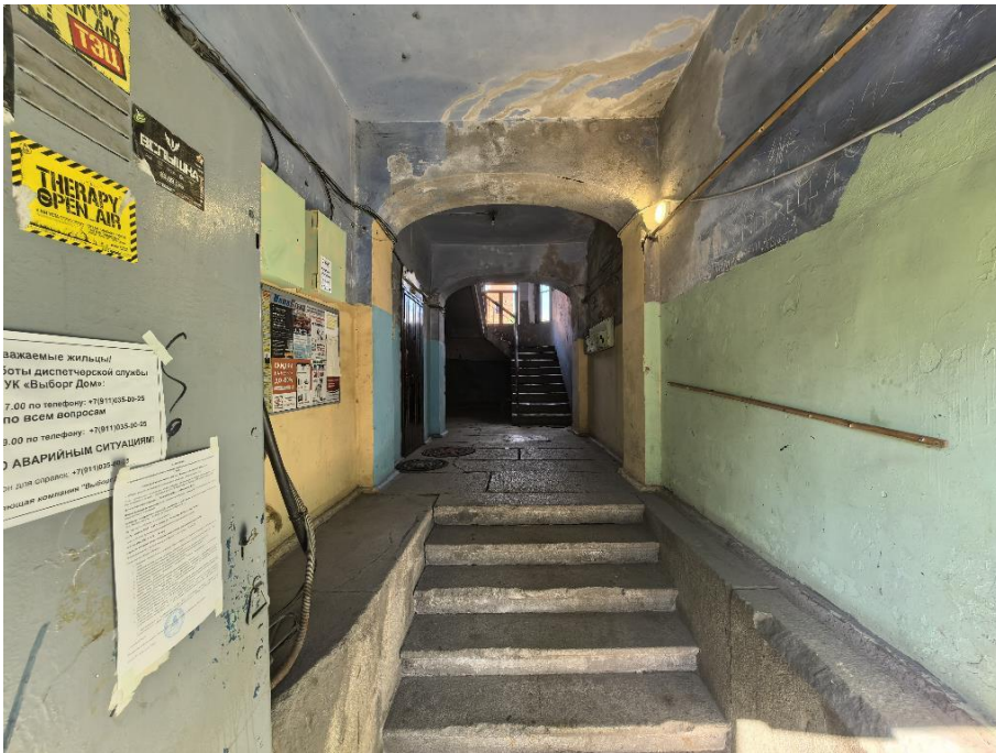
37. «Жилой дом», Ленинградская область, Выборгский муниципальный район, г. Выборг, ул. Сторожевой башни, д. 10А. Подъезд №1. Общий вид. Фото 05.11.2024г.
