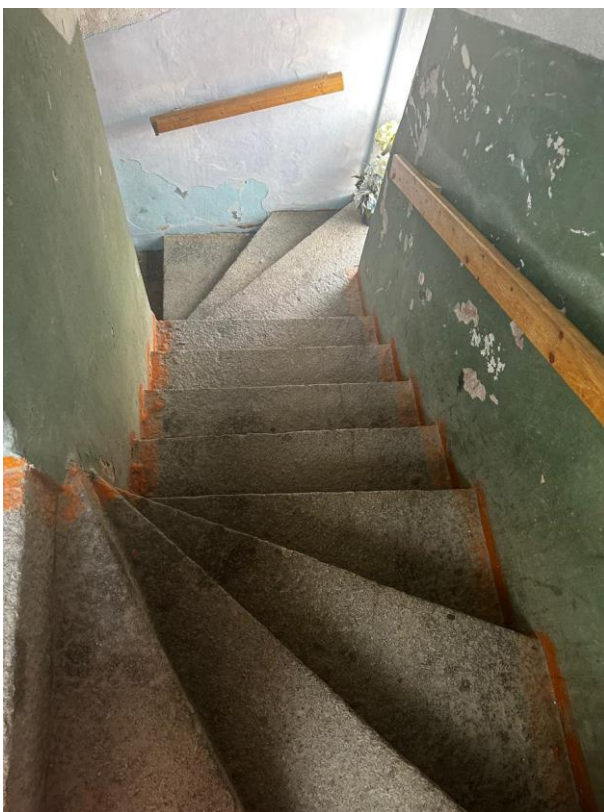
45. «Жилой дом», Ленинградская область, Выборгский муниципальный район, г. Выборг, ул. Сторожевой башни, д. 10А. Подъезд №2. Общий вид. Фото 05.11.2024г.
