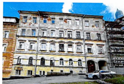
Лицевой Ю-З фасад
