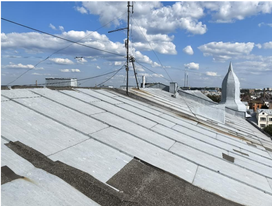
27. «Жилой дом», Ленинградская область, Выборгский муниципальный район, г. Выборг, ул. Сторожевой башни, д. 10А. Кровля. Общий вид. Фото 05.11.2024г.
