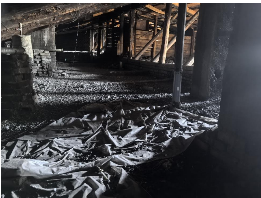
32. «Жилой дом», Ленинградская область, Выборгский муниципальный район, г. Выборг, ул. Сторожевой башни, д. 10А. Чердак. Общий вид. Фото 05.11.2024г.
