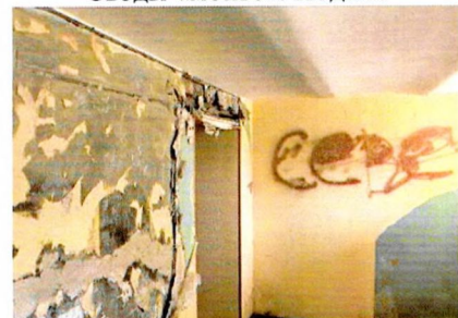
Своды «монье», подвал
