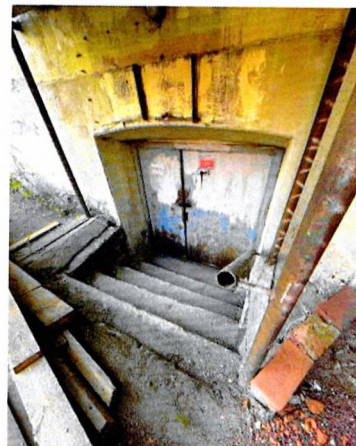
Спуск в подвал. С-В дворовый фасад
