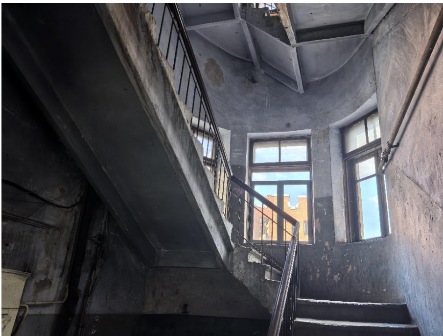
38. «Жилой дом», Ленинградская область, Выборгский муниципальный район, г. Выборг, ул. Сторожевой башни, д. 10А. Подъезд №1. Общий вид. Фото 05.11.2024г.
