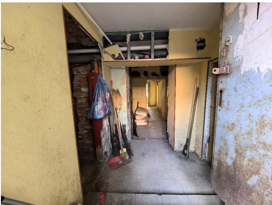
33. «Жилой дом», Ленинградская область, Выборгский муниципальный район, г. Выборг, ул. Сторожевой башни, д. 10А. Чердак. Общий вид. Фото 05.11.2024г.
