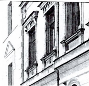
Проемы 2-го яруса боковых частей. Лицевой Ю-3 фасад. Фото (копия) 1940 г.
