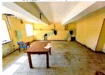
Плоское перекрытие по балкам. Подвал
