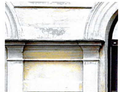
Тяга в простенках между проемами 1-го яруса. Лицевой Ю-3 фасад
