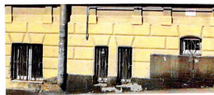
Проемы цокольного яруса и подвала. Лицевой Ю-З фасад
