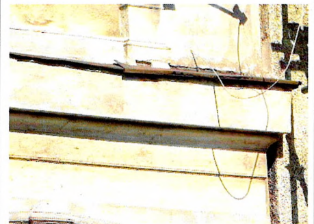
Карниз между 1-ым и 2-ым ярусами. Лицевой Ю-3 фасад
