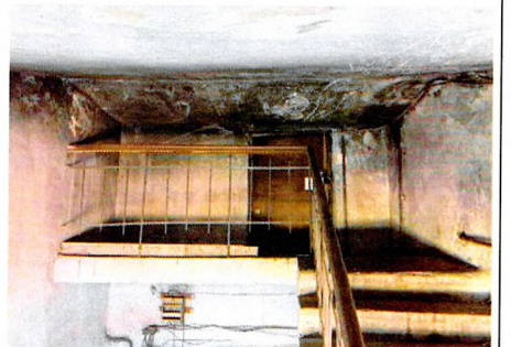
Существующее плоское перекрытие парадной лестницы
