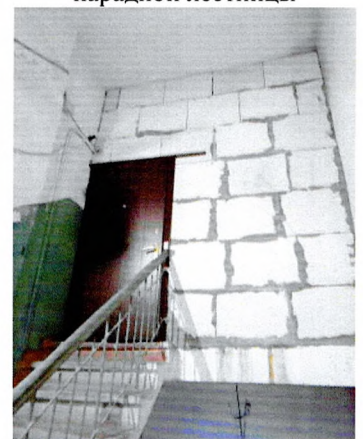
Существующее плоское перекрытие лестничной клетки дворового крыла
