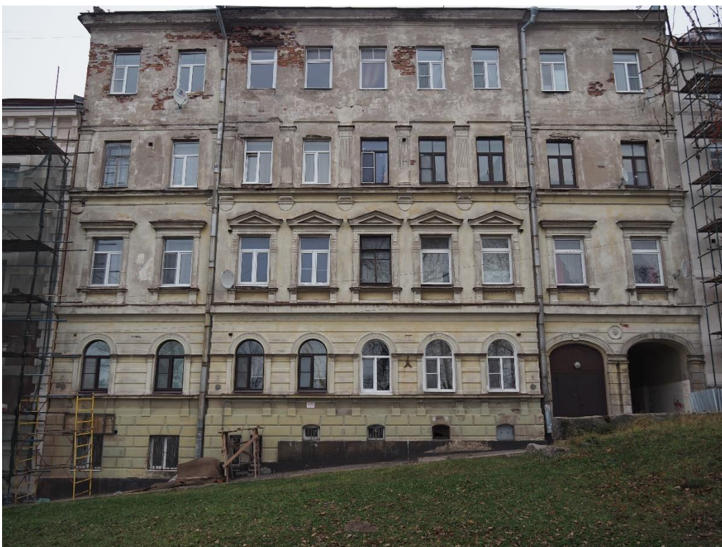
1. «Жилой дом», Ленинградская область, Выборгский муниципальный район, г. Выборг, ул. Сторожевой башни, д. 10А. Юго-западный фасад. Общий вид. Фото 05.11.2024г.
