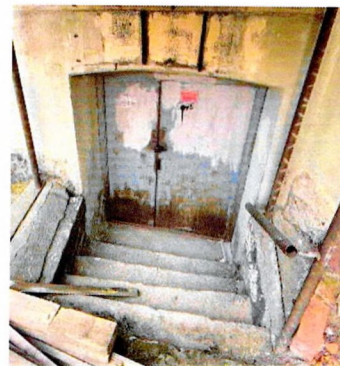
Вход в подвал. С-В дворовый фасад
