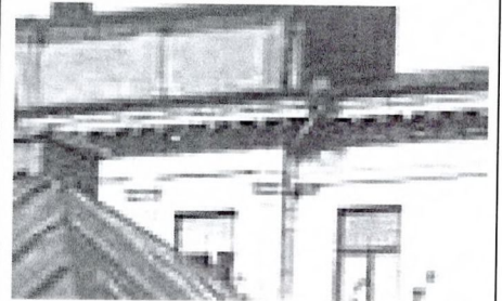
Венчающий карниз. Лицевой фасад. Фото (копия) 1930-х гг.
