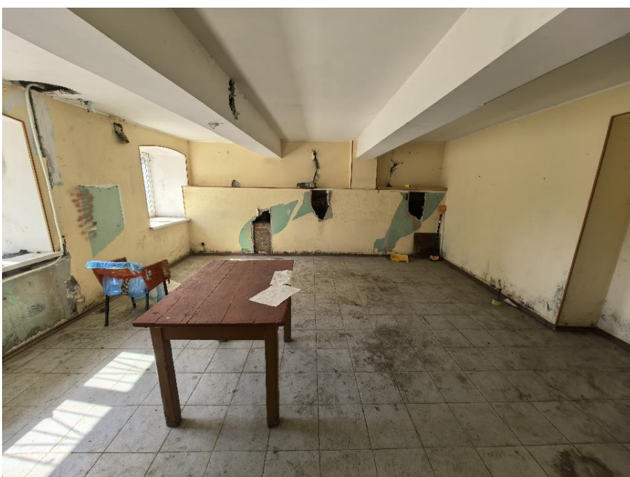
36. «Жилой дом», Ленинградская область, Выборгский муниципальный район, г. Выборг, ул. Сторожевой башни, д. 10А. Подвал. Общий вид. Фото 05.11.2024г.
