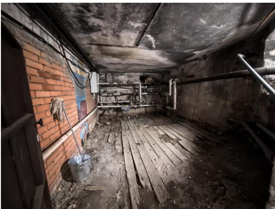
34. «Жилой дом», Ленинградская область, Выборгский муниципальный район, г. Выборг, ул. Сторожевой башни, д. 10А. Чердак. Общий вид. Фото 05.11.2024г.
