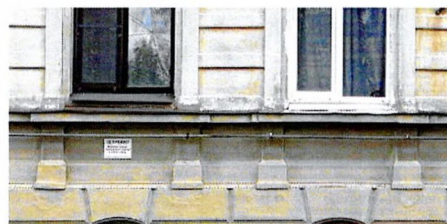
Фриз, совмещенный с карнизом между нижним ярусом и 1-ым ярусом. Лицевой Ю-3 фасад
