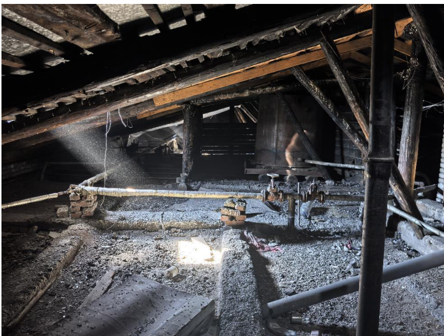
29. «Жилой дом», Ленинградская область, Выборгский муниципальный район, г. Выборг, ул. Сторожевой башни, д. 10А. Чердак. Общий вид. Фото 05.11.2024г.
