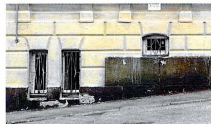
Оконные проемы цокольного яруса и подвала. Лицевой Ю-З фасад
