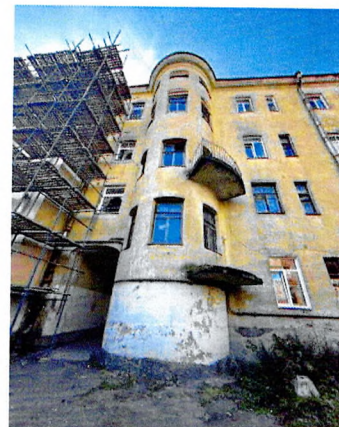
Фрагмент дворового С-В фасада. Левая часть
