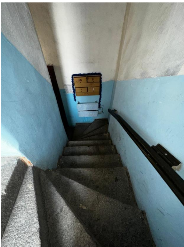
43. «Жилой дом», Ленинградская область, Выборгский муниципальный район, г. Выборг, ул. Сторожевой башни, д. 10А. Подъезд №2. Общий вид. Фото 05.11.2024г.
