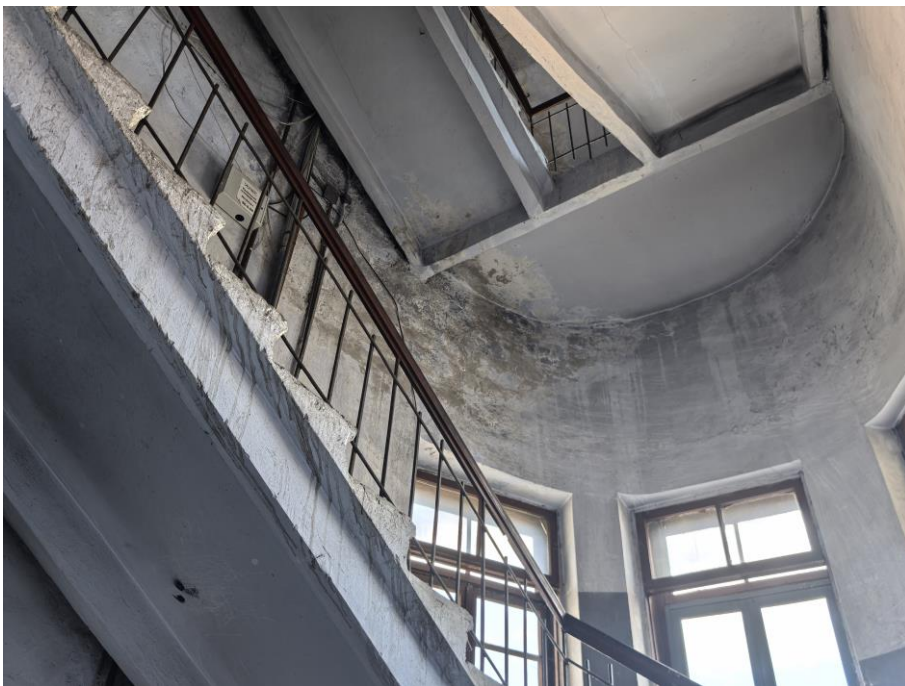
40. «Жилой дом», Ленинградская область, Выборгский муниципальный район, г. Выборг, ул. Сторожевой башни, д. 10А. Подъезд №1. Общий вид. Фото 05.11.2024г.
