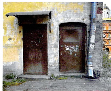
Дверные проемы. Ю-В фасад дворового крыла
