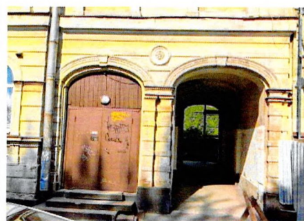
Арочные проемы парадного входа и сквозного проезда
