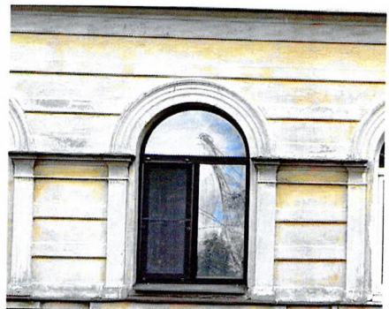
Рустовка 1-го яруса. Лицевой Ю-З фасад
