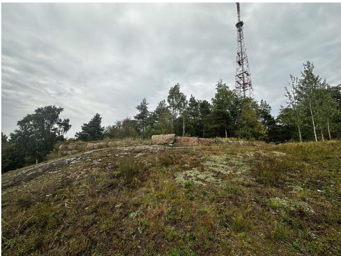
Фото 14. Западный склон горы Папула. Каменные подпорные стены площадки, расположенной перед рестораном. Фото с юго-запада. Дата съемки: 11.09.2024 г. Автор съемки: Куваева Ю.П.
