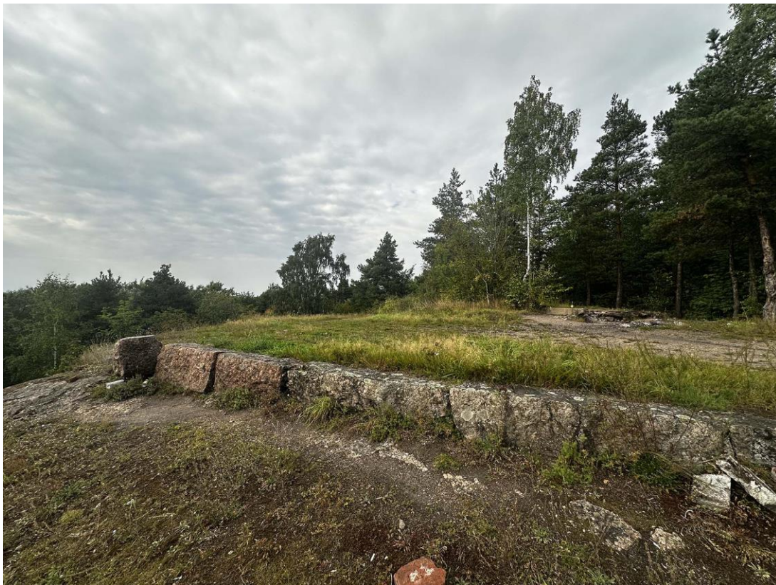
Фото 15. Западный склон горы Папула. Площадка ресторана с каменными подпорными стенами. Фото с юго-запада. Дата съемки: 11.09.2024 г. Автор съемки: Куваева Ю.П.
