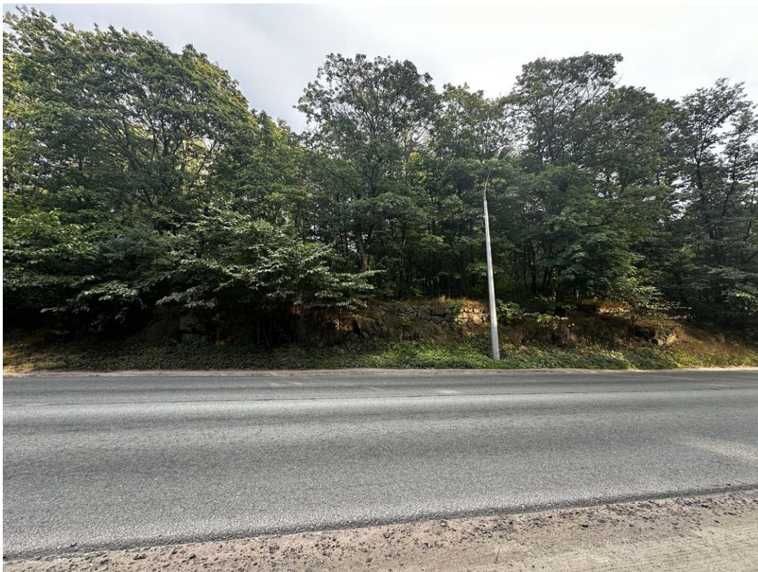
Фото 50. Северо-западный склон горы Папула. Каменная подпорная стена – участок западной границы объекта культурного наследия «Парк Папула». Фото с запада, со стороны Светогорского шоссе. Дата съемки: 11.09.2024 г. Автор съемки: Куваева Ю.П.
