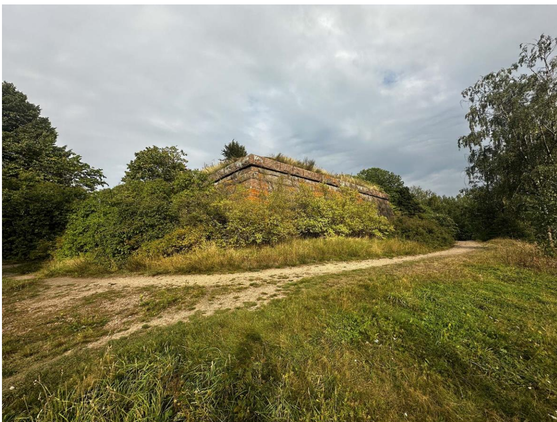
Фото 25. Южная часть возвышенности горы Папула. Общий вид Водонапорной башни с запада. Дата съемки: 11.09.2024 г. Автор съемки: Куваева Ю.П.
