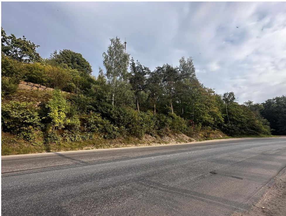
Фото 54. Западный склон горы Папула. Каменная подпорная стена - участок западной границы объекта культурного наследия «Парк Папула». Фото с северо-запада, со стороны Светогорского шоссе. Дата съемки: 11.09.2024 г. Автор съемки: Куваева Ю.П.
