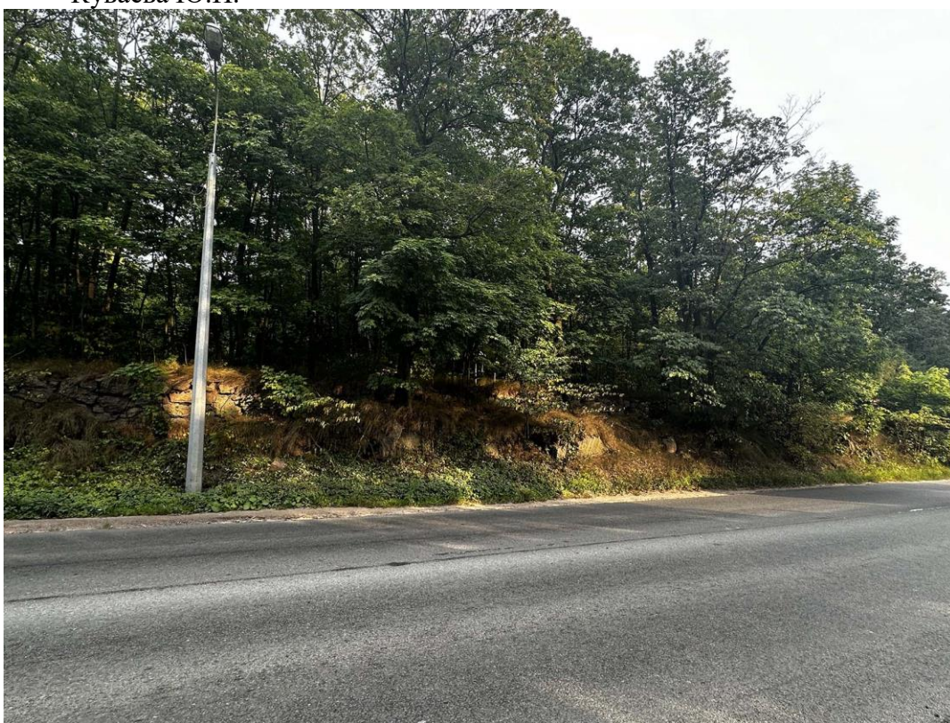
Фото 51. Северо-западный склон горы Папула. Каменная подпорная стена - участок западной границы объекта культурного наследия «Парк Папула». Фото с северо-запада, со стороны Светогорского шоссе. Дата съемки: 11.09.2024 г. Автор съемки: Куваева Ю.П.
