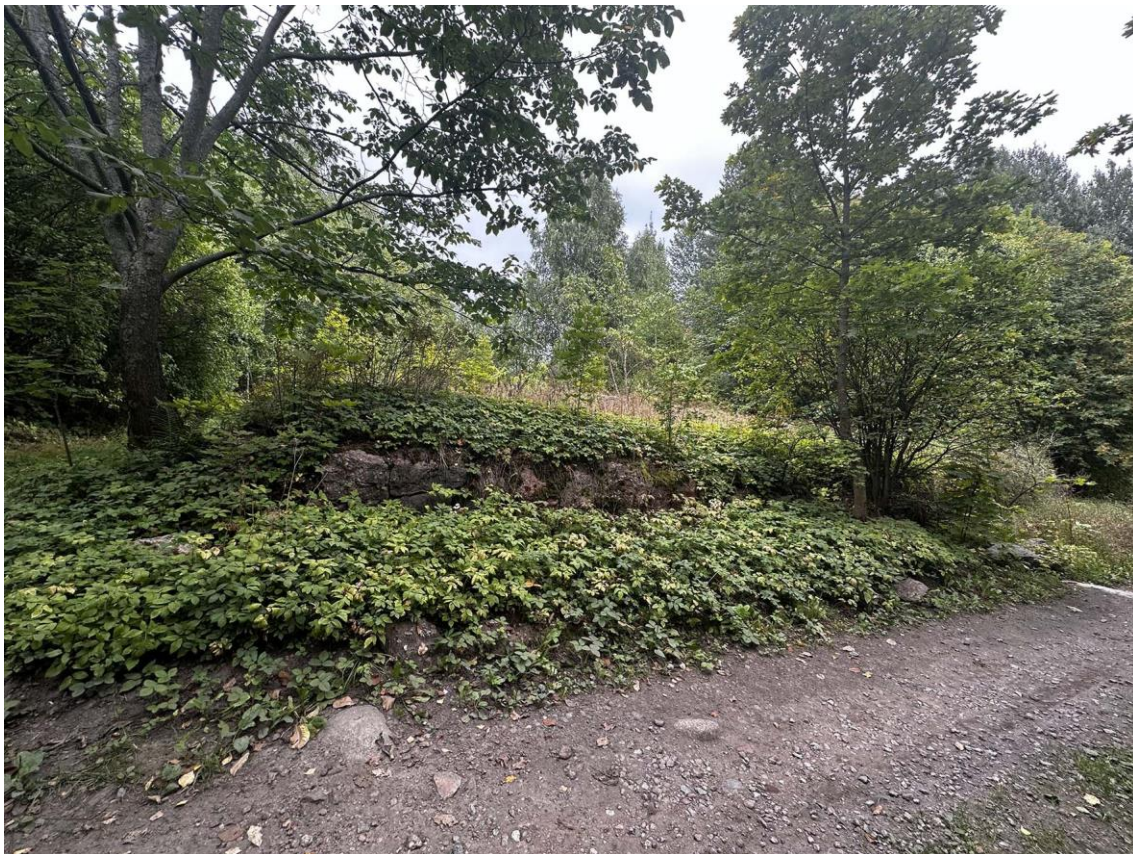
Фото 61. Подножие юго-западного склона горы Папула. Дорога вдоль западного берега. Подпорная каменная стена. Фото с северо-запада. Дата съемки: 11.09.2024 г. Автор съемки: Куваева Ю.П.
