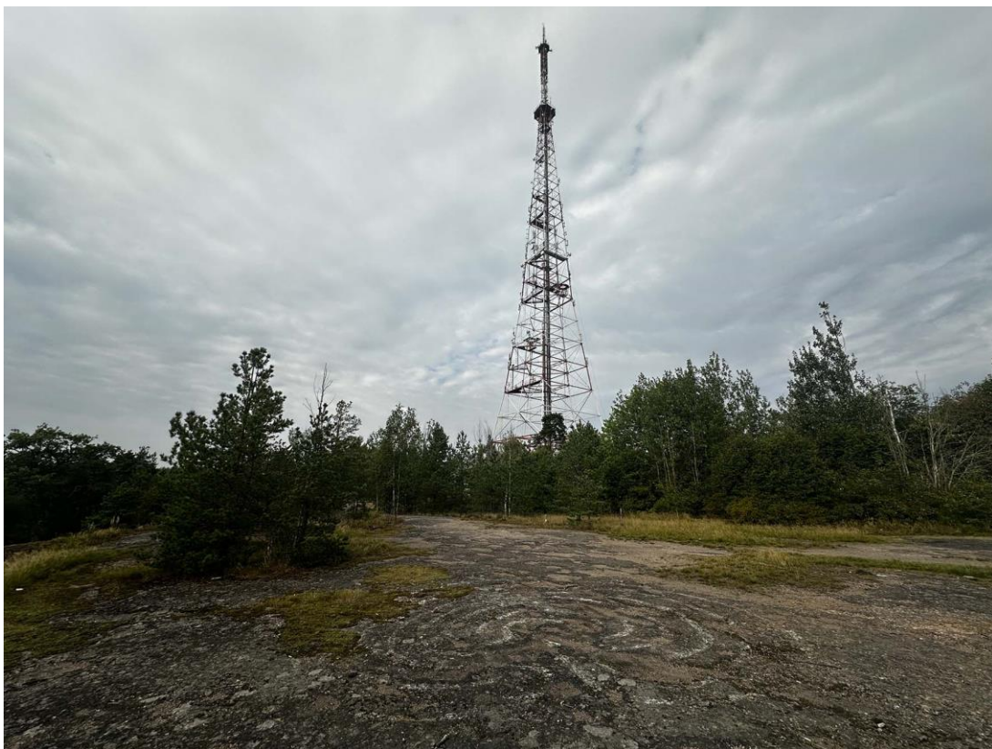
Фото 16. Скальное основание площадки, расположенной с южной стороны от ресторана. На заднем плане – телевизионная ретрансляционная башня г. Выборга с комплексом служебных построек. Фото с юга. Дата съемки: 11.09.2024 г. Автор съемки: Куваева Ю.П.
