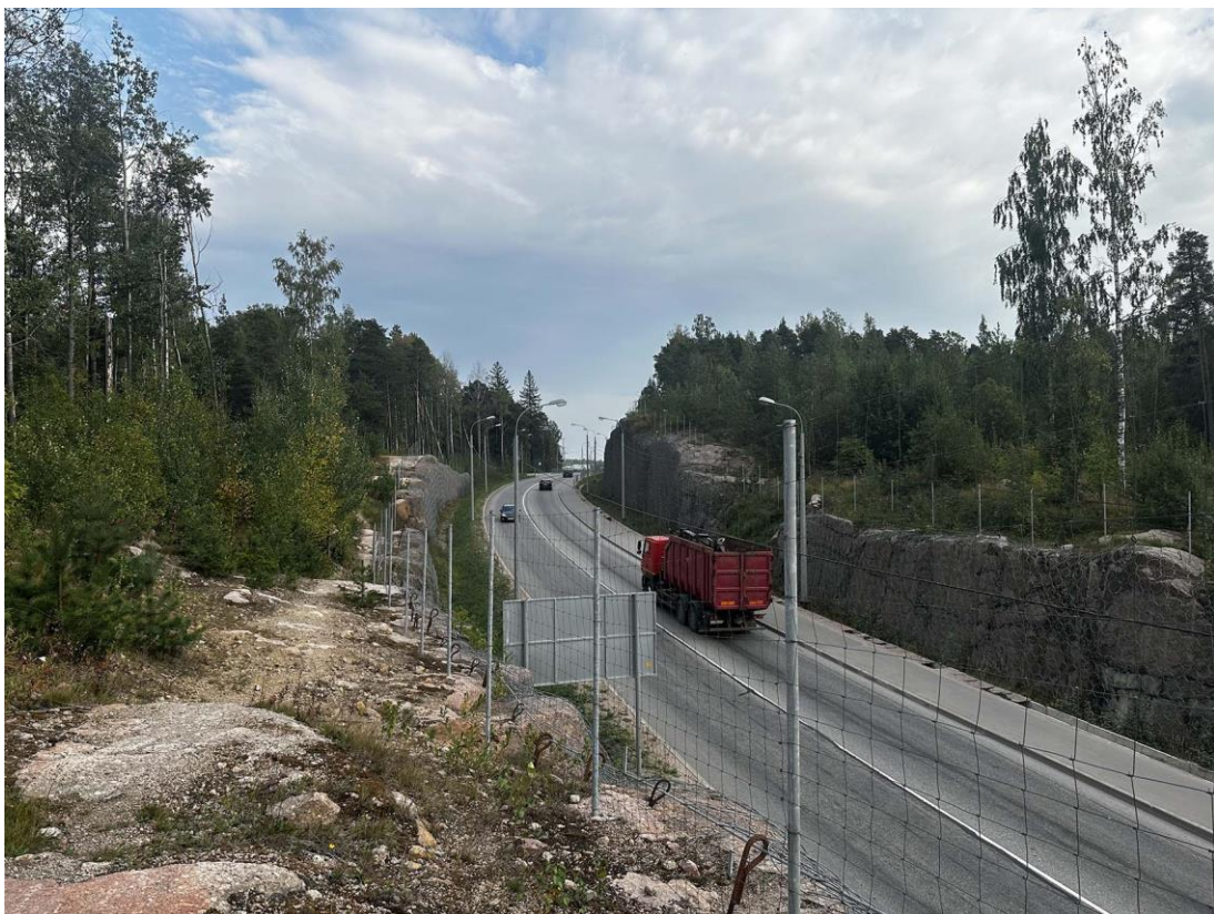
Фото 47. Северо-восточная часть горы Папула. Автомобильный путепровод между Смирновским и Светогорским шоссе. Фото с севера. Дата съемки: 11.09.2024 г. Автор съемки: Куваева Ю.П.
