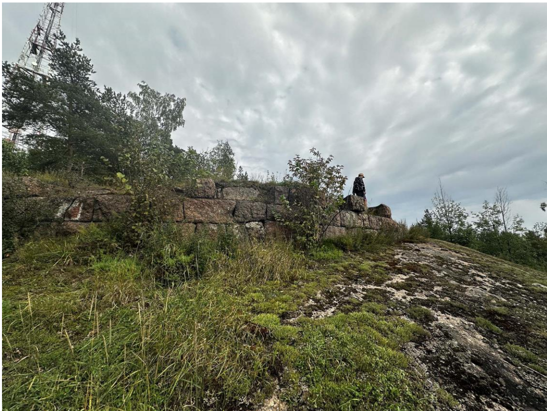
Фото 13. Западный склон горы Папула. Каменные подпорные стены площадки, расположенной перед рестораном. Фото с запада. Дата съемки: 11.09.2024 г. Автор съемки: Куваева Ю.П.
