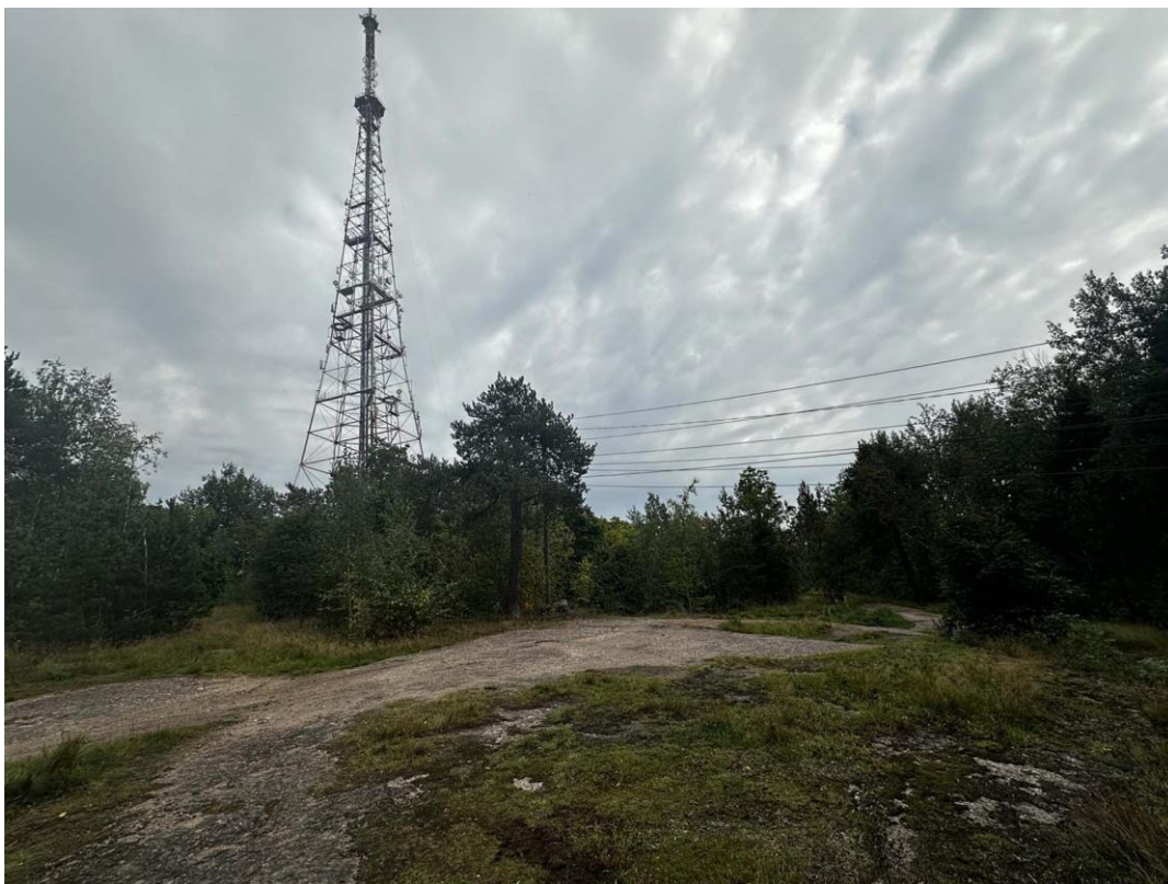
Фото 7. Вершина холма – горы Папула. Общий вид. Скальное основание. Телевизионная ретрансляционная башня г. Выборга. Фото с севера. Дата съемки: 11.09.2024 г. Автор съемки: Куваева Ю.П.
