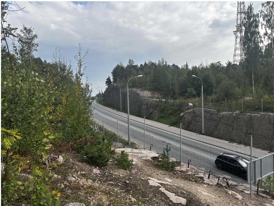
Фото 46. Северо-восточная часть горы Папула. Автомобильный путепровод между Смирновским и Светогорским шоссе. Фото с севера. Дата съемки: 11.09.2024 г. Автор съемки: Куваева Ю.П.
