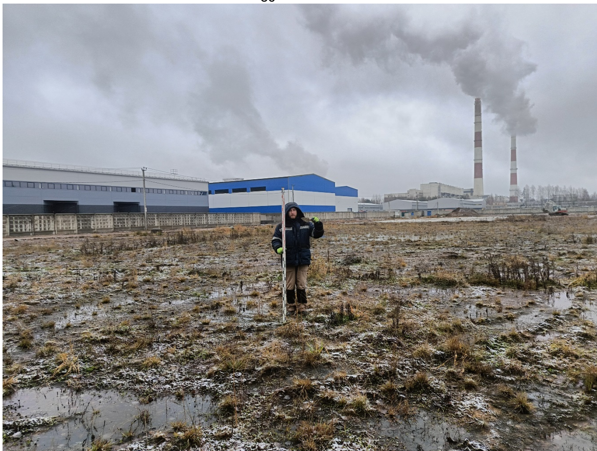
Рис. 21. ЛО-2024. Д. Новое Девяткино, КН: 47:07:0722001:123228; 123229; 123230; 123231. Точка фотофиксации 2, вид с запада.
