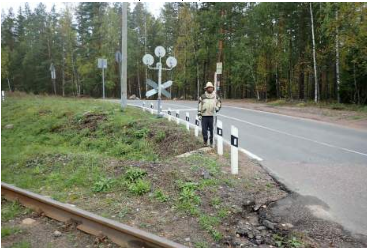
Рис. 20. Ленинградская область Выборгский район. Отвод проектируемого путепровода Октябрьской железной дороги. Точка фотофиксации 2, Вид с юга юго-запада.
