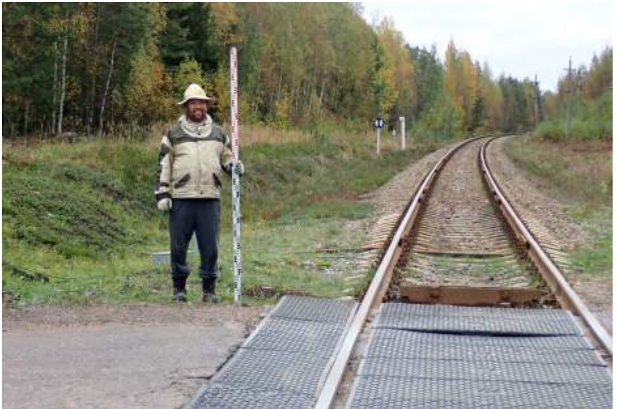
Рис. 21. Ленинградская область Выборгский район. Отвод проектируемого путепровода Октябрьской железной дороги. Точка фотофиксации 2, вид с юго-востока.
