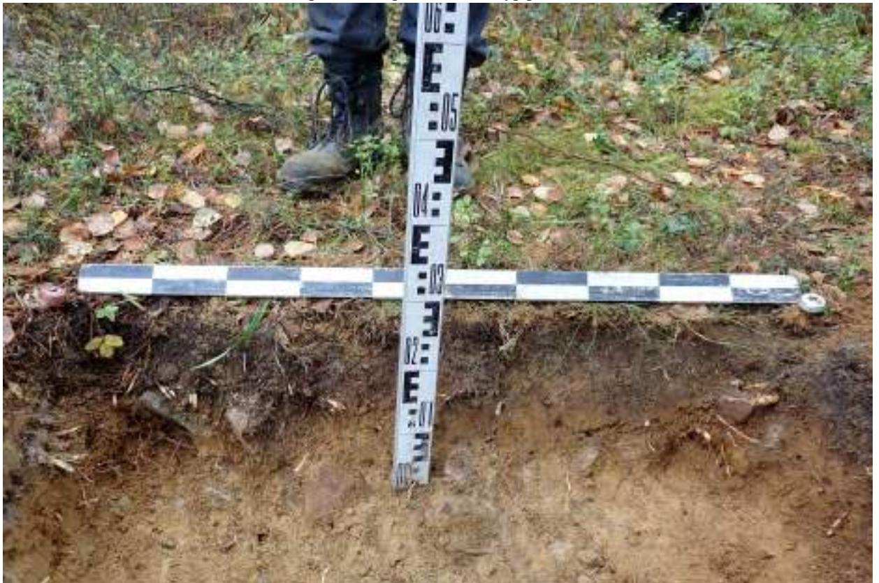
Рис. 46. Ленинградская область Выборгский район. Отвод проектируемого путепровода Октябрьской железной дороги. Северная стенка шурфа № 2 после прокопки, вид с юга
