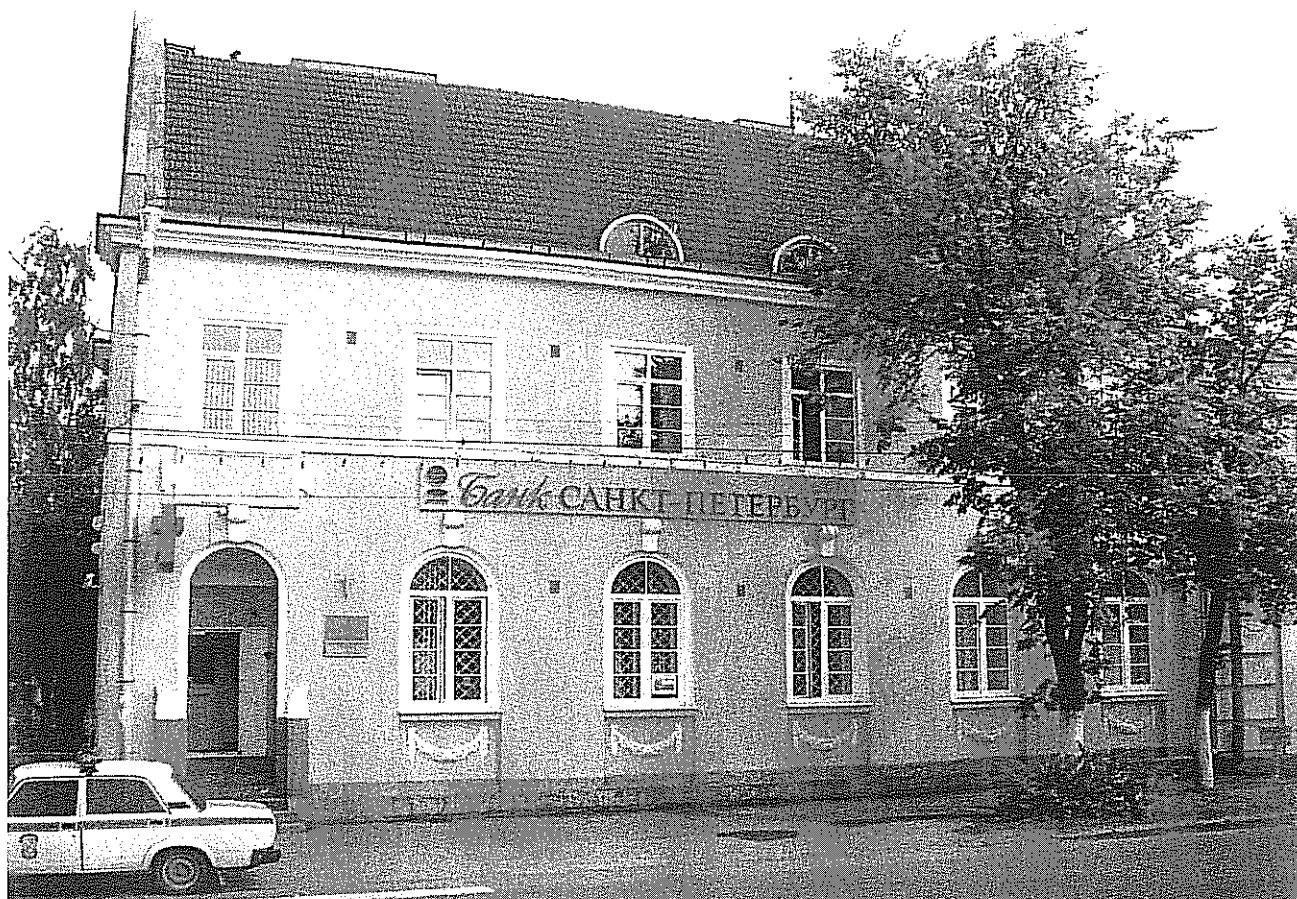
7. Южный фасад. Фото 2007г.
