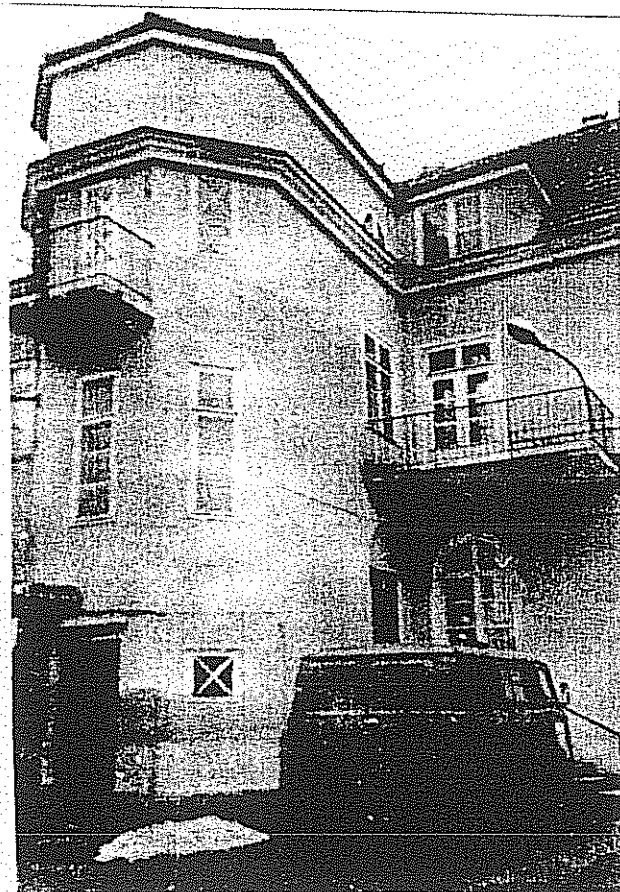
12. Фрагмент северного фасада. Лестничный объем Фото 1985г.
