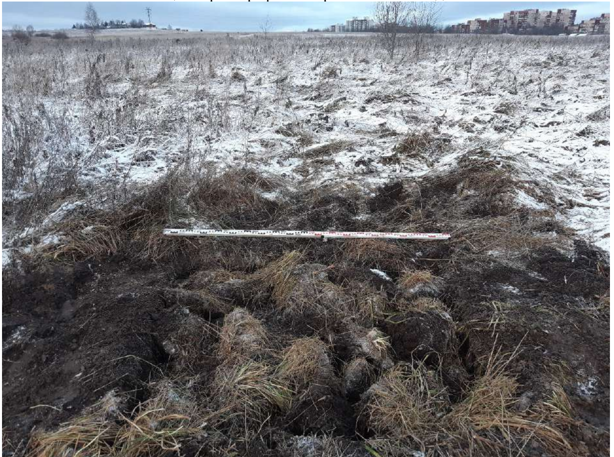
Рис. 91. ЛО-2024. Ломоносовский район. Низинское с.п., п. Троицкая Гора. Шурф 17. Общий вид. Рекультивация. Вид с юга
