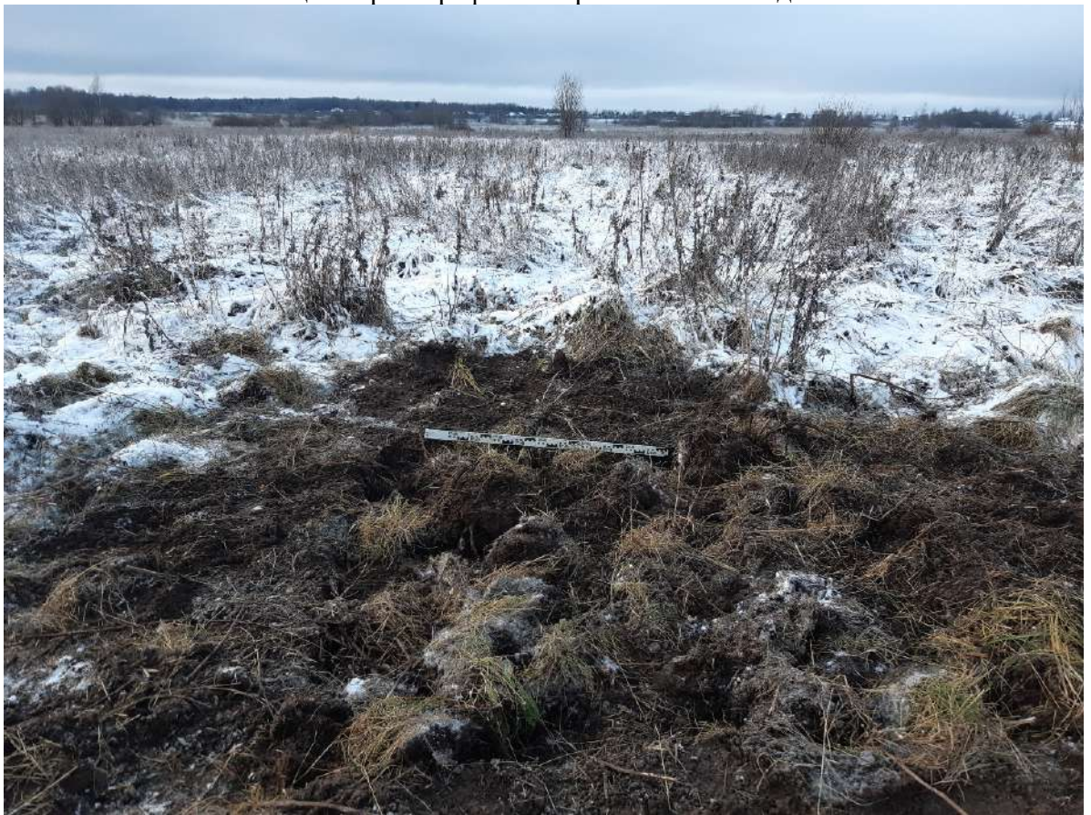
Рис. 63. ЛО-2024. Ломоносовский район. Низинское с.п., п. Троицкая Гора. Шурф 10. Общий вид. Рекультивация. Вид с юга
